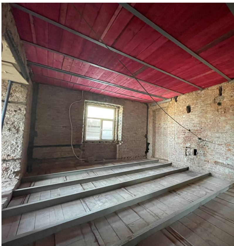
Фото 12. Интерьер квартиры № 13 объекта культурного наследия регионального значения объекта культурного наследия регионального значения «Доходный дом Р.Г. Веge»
