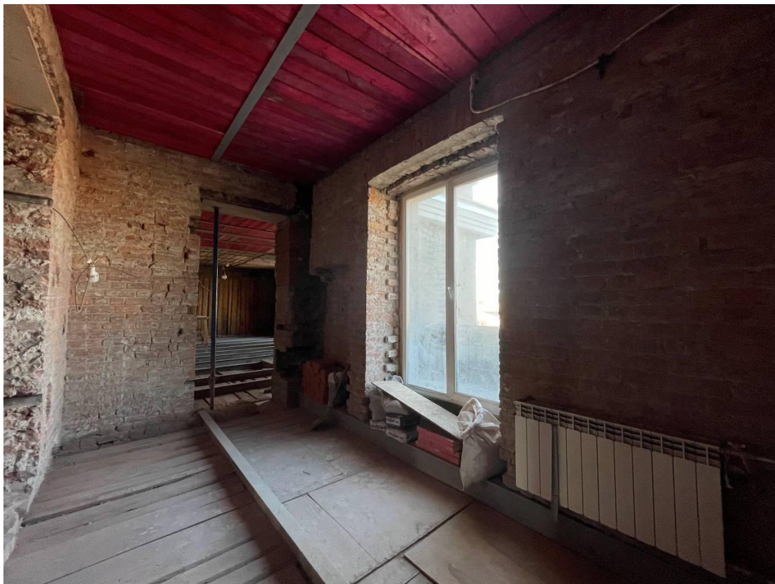
Фото 11. Интерьер квартиры № 13 объекта культурного наследия регионального значения объекта культурного наследия регионального значения «Доходный дом Р.Г. Веge»
