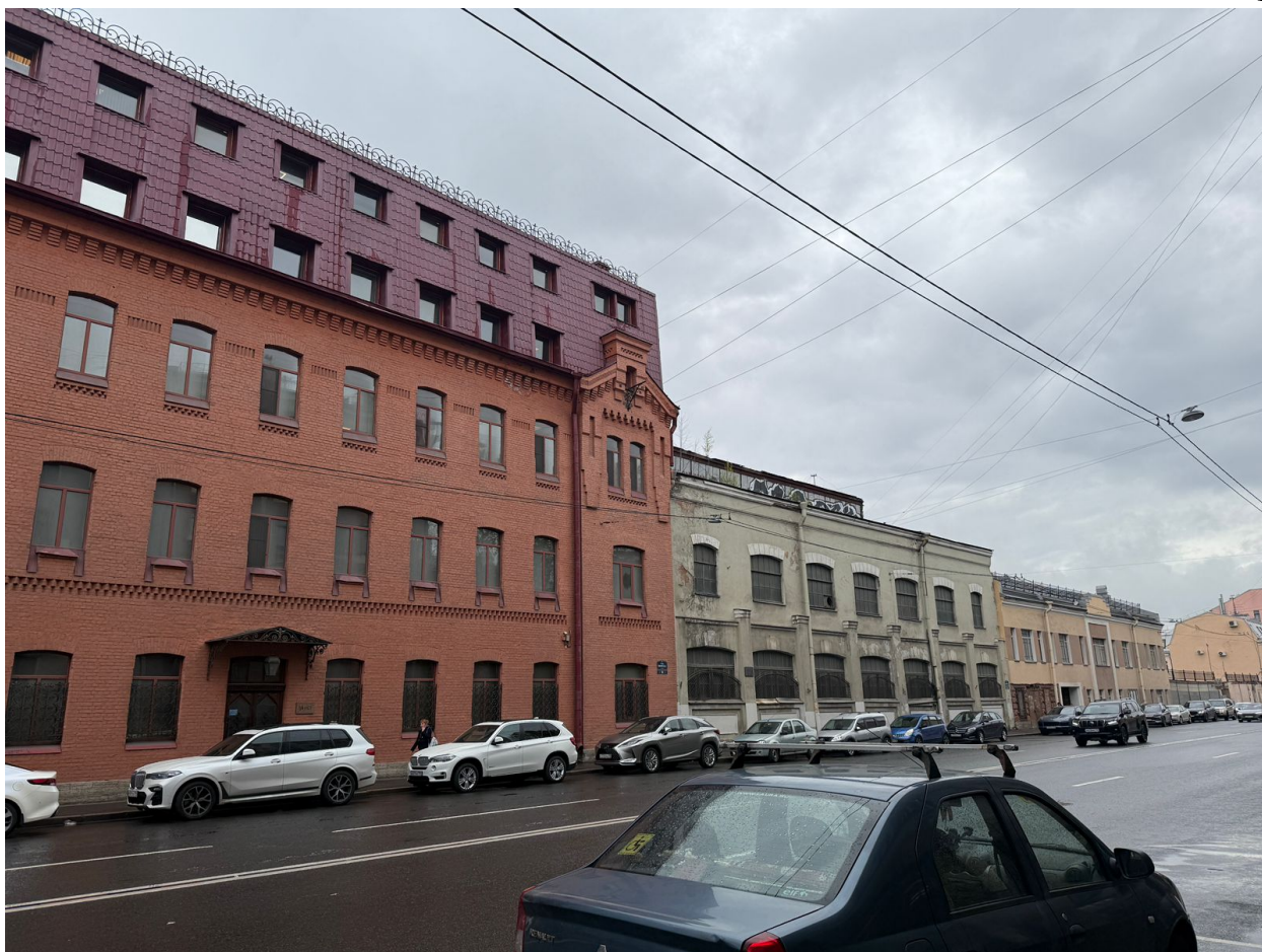
Фото 1. Общий вид со стороны улицы на ОКН «Комплекс построек Подковно-гвоздильного завода Э.Л. Поссея». Дата фотофиксации: 12.05.2025г.
