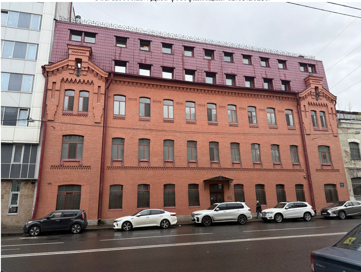
Фото 2. Общий вид со стороны улицы на ОКН «Комплекс построек Подковно-гвоздильного завода Э.Л. Поссея». Дата фотофиксации: 12.05.2025г.
