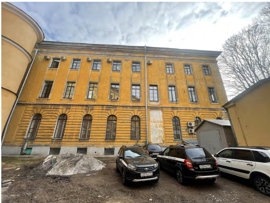
7. Вид на западный корпус и внутренний двор объекта культурного наследия федерального значения «Главное здание», расположенного по адресу: г. Санкт-Петербург, ул. Смольного, дом 3, литера А (Смоленого ул. 3), входящего в состав ансамбля «Институт Александровский» (Смольного ул.,3, Смольная наб.);
