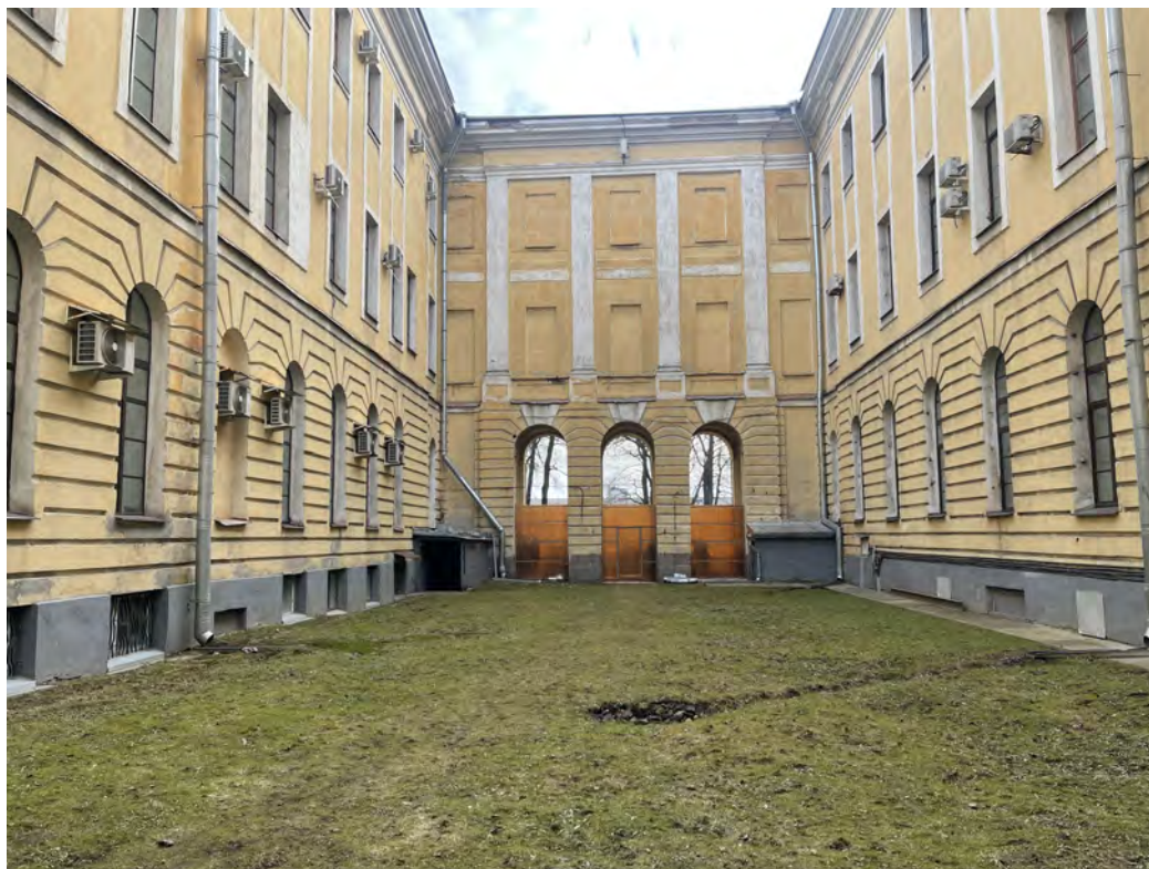
13. Вид на западный корпус и внутренний двор объекта культурного наследия федерального значения «Главное здание», расположенного по адресу: г. Санкт-Петербург, ул. Смольного, дом 3, литера А (Смоленого ул. 3), входящего в состав ансамбля «Институт Александровский» (Смольного ул.,3, Смольная наб.);
