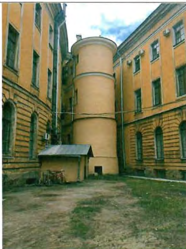
4. Фрагмент южного фасада
