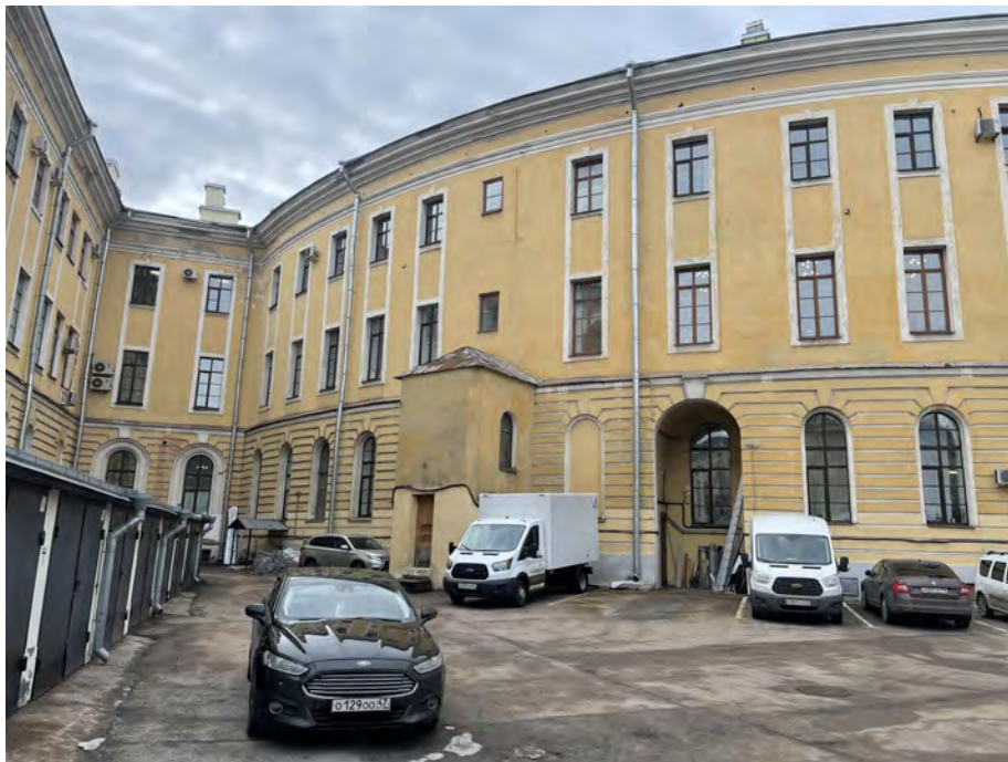
21. Вид на Главное здание, на западный корпус и внутренний двор объекта культурного наследия федерального значения «Главное здание», расположенного по адресу: г. Санкт-Петербург, ул. Смольного, дом 3, литера А(Смоленого ул. 3), входящего в состав ансамбля «Институт Александровский» (Смольного ул.,3, Смольная наб.;
