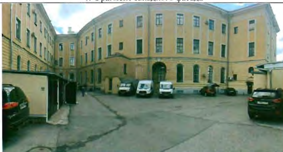
2. Фрагмент северного фасада
