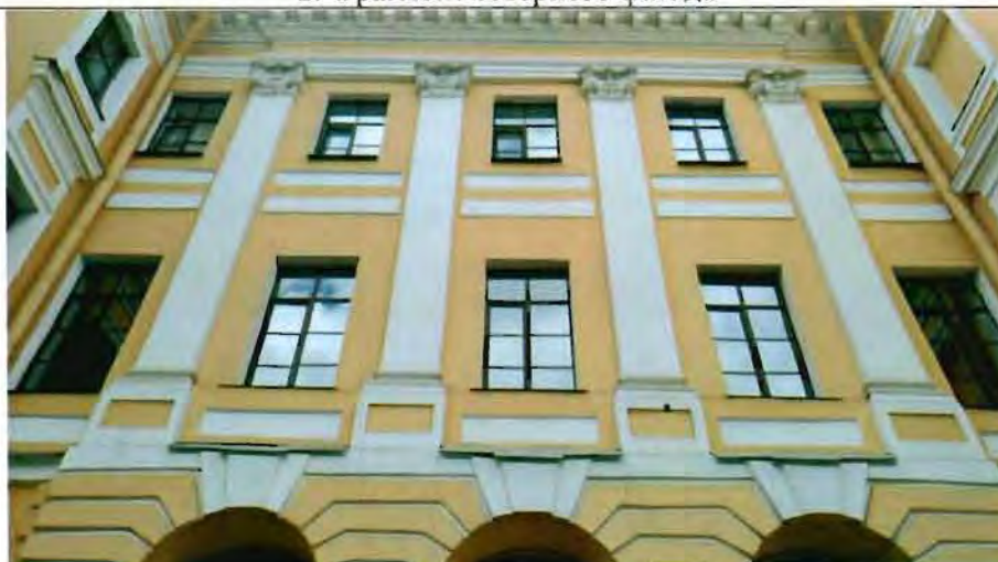
3. Фрагмент восточного фасада
