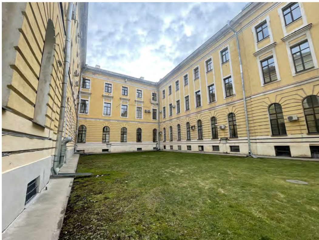
11. Вид на западный корпус и внутренний двор объекта культурного наследия федерального значения «Главное здание», расположенного по адресу: г. Санкт-Петербург, ул. Смольного, дом 3, литера А (Смоленого ул. 3), входящего в состав ансамбля «Институт Александровский» (Смольного ул.,3, Смольная наб.);
