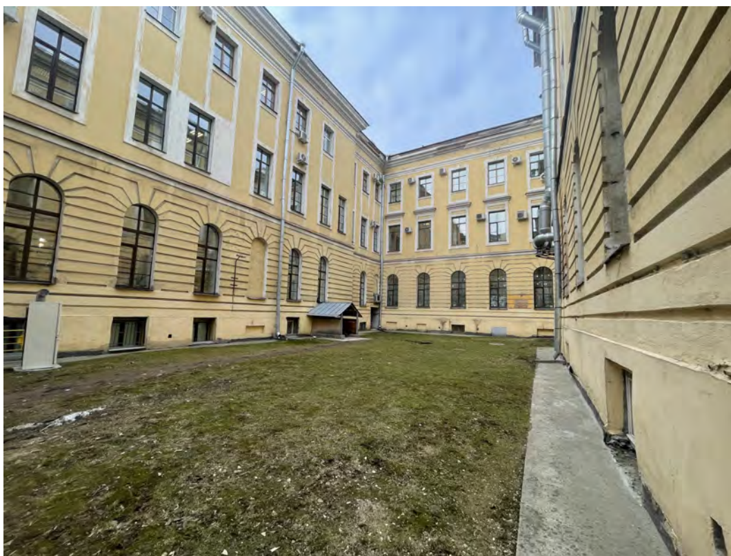
10. Вид на западный корпус и внутренний двор объекта культурного наследия федерального значения «Главное здание», расположенного по адресу: г. Санкт-Петербург, ул. Смольного, дом 3, литера А (Смоленого ул. 3), входящего в состав ансамбля «Институт Александровский» (Смольного ул.,3, Смольная наб.);
