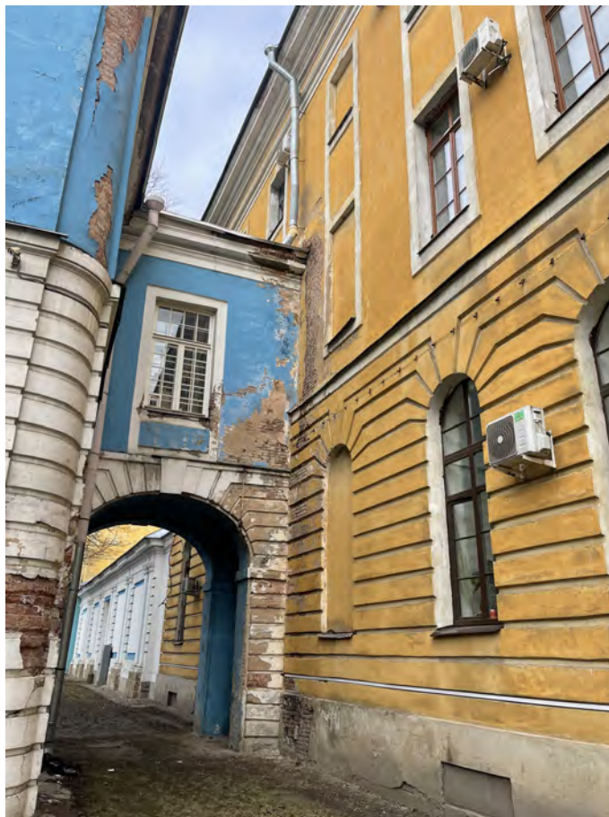
17. Вид на западный корпус и внутренний двор объекта культурного наследия федерального значения «Главное здание», расположенного по адресу: г. Санкт-Петербург, ул. Смольного, дом 3, литера А (Смоленого ул. 3), входящего в состав ансамбля «Институт Александровский» (Смольного ул.,3, Смольная наб.) и Смольный собор;
