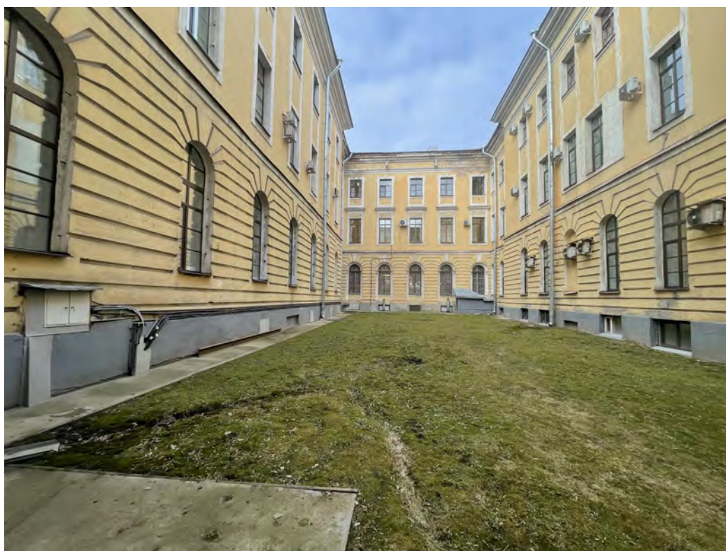
14. Вид на западный корпус и внутренний двор объекта культурного наследия федерального значения «Главное здание», расположенного по адресу: г. Санкт-Петербург, ул. Смольного, дом 3, литера А (Смоленого ул. 3), входящего в состав ансамбля «Институт Александровский» (Смольного ул.,3, Смольная наб.);
