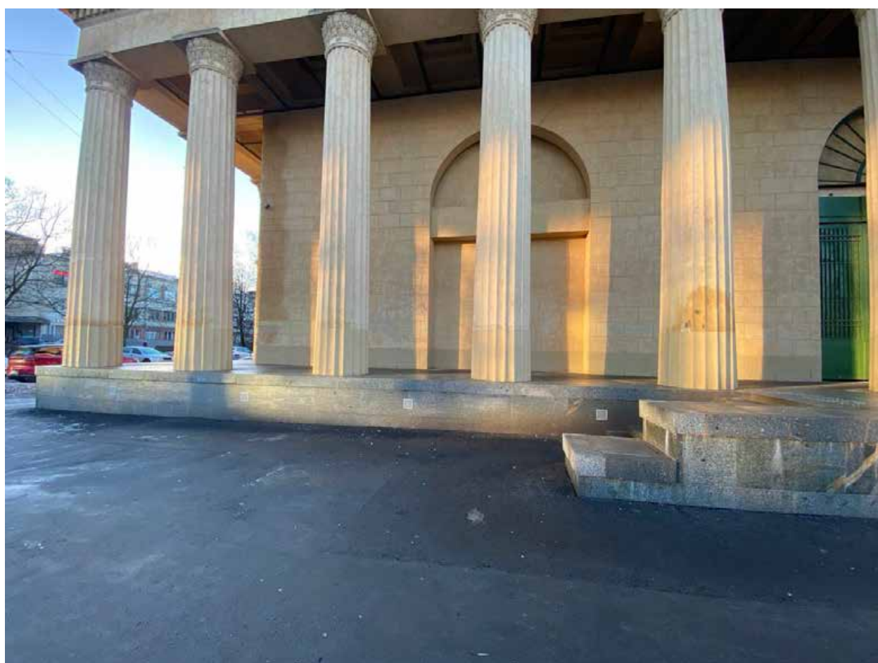
3. Северо- восточный фасад объекта культурного наследия регионального значения «Станция метро «Кировский завод» (с перронным залом)», расположенного по адресу: г. Санкт-Петербург, пр. Стачек, д. 70, литера А. 07.02.2025
