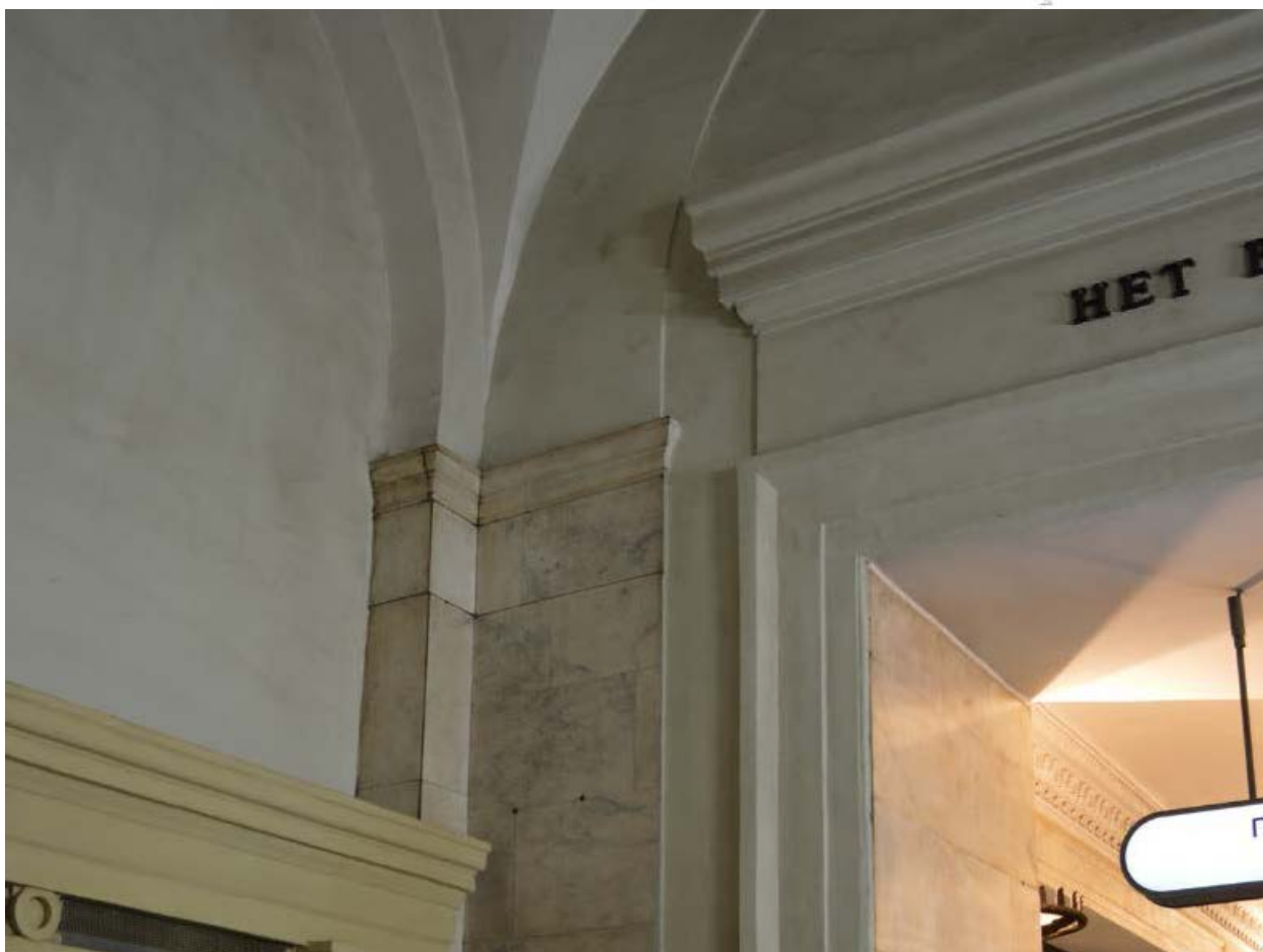
22. Зал для входа пассажиров объекта культурного наследия регионального значения «Станция метро «Кировский завод» (с перронным залом)», расположенного по адресу: г. Санкт-Петербург, пр. Стачек, д. 70, литера А. 07.02.2025
