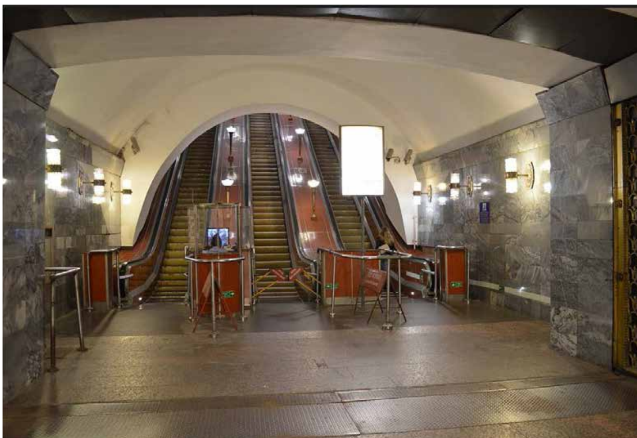
29. Подземная часть объекта культурного наследия регионального значения «Станция метро «Кировский завод» (с перронным залом)», расположенного по адресу: г. Санкт-Петербург, пр. Стачек, д. 70, литера А. 07.02.2025
