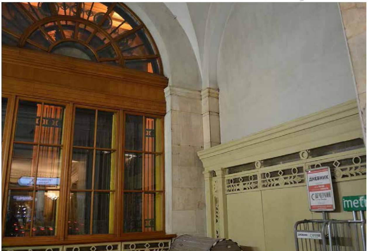
21. Зал для входа пассажиров объекта культурного наследия регионального значения «Станция метро «Кировский завод» (с перронным залом)», расположенного по адресу: г. Санкт-Петербург, пр. Стачек, д. 70, литера А. 07.02.2025
