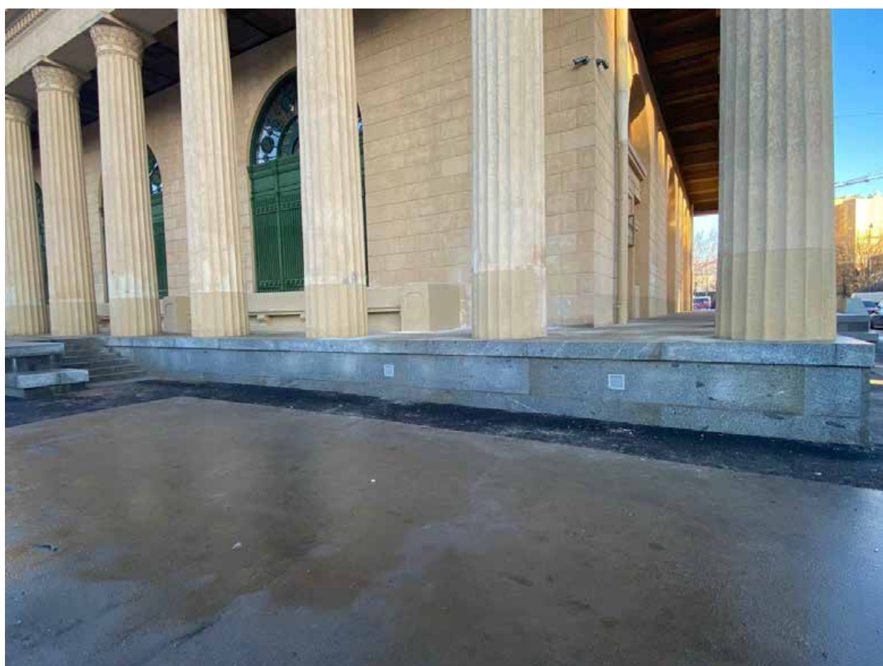
12. Юго-западный фасад объекта культурного наследия регионального значения «Станция метро «Кировский завод» (с перронным залом)», расположенного по адресу: г. Санкт-Петербург, пр. Стачек, д. 70, литера А. 07.02.2025
