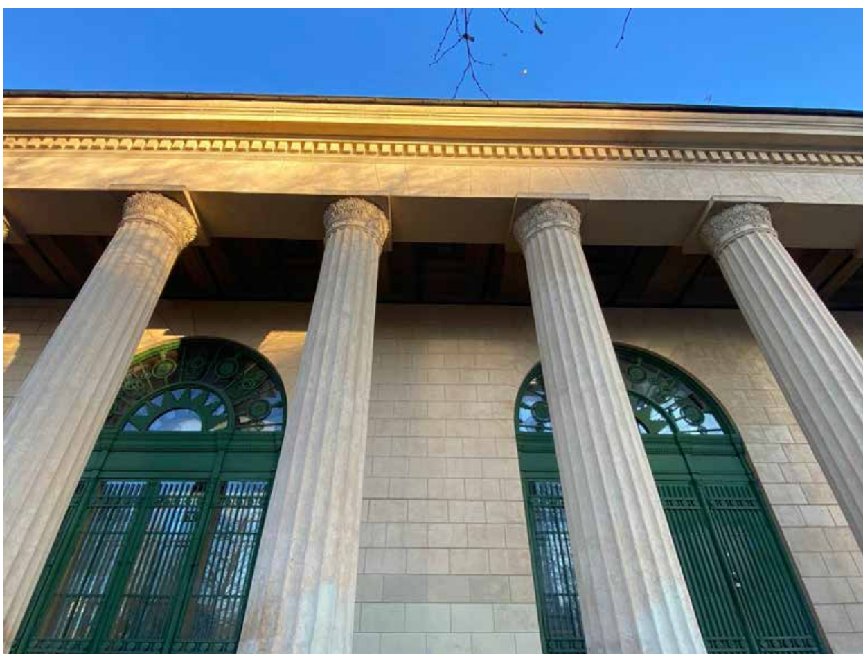
13. Юго-западный фасад объекта культурного наследия регионального значения «Станция метро «Кировский завод» (с перронным залом)», расположенного по адресу: г. Санкт-Петербург, пр. Стачек, д. 70, литера А. 07.02.2025
