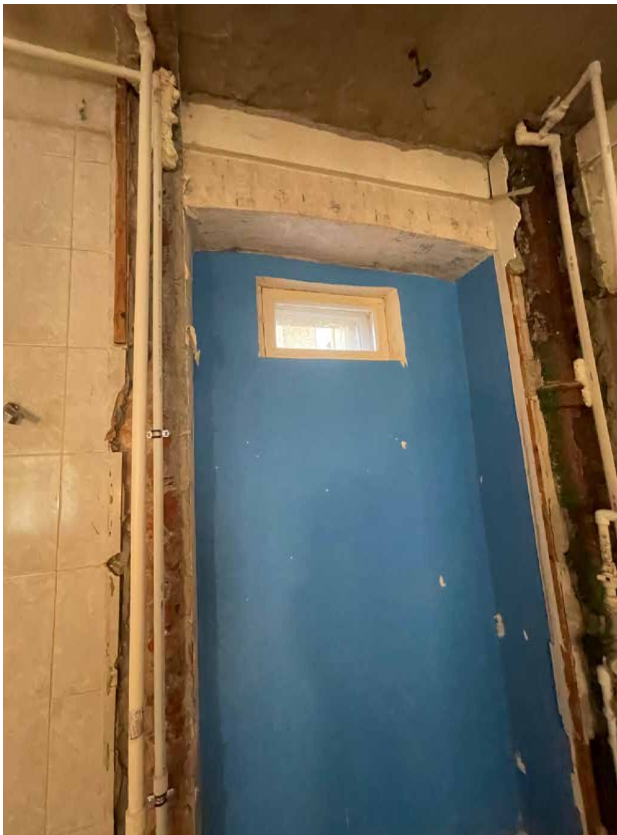
10. Оконный проем со стороны дворового фасада.
