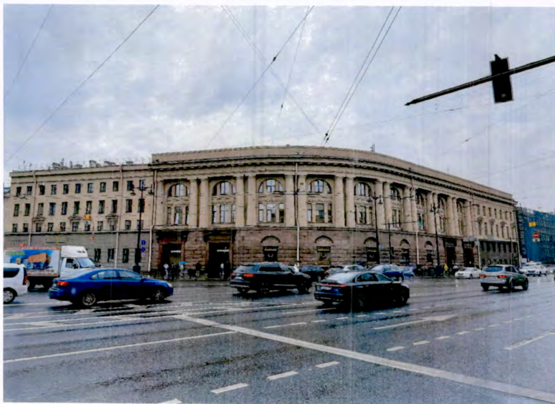
1. Общий вид на объект культурного наследия.
