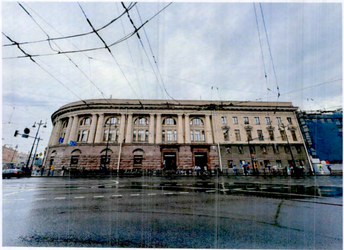
2. Общий вид на объект культурного наследия.
