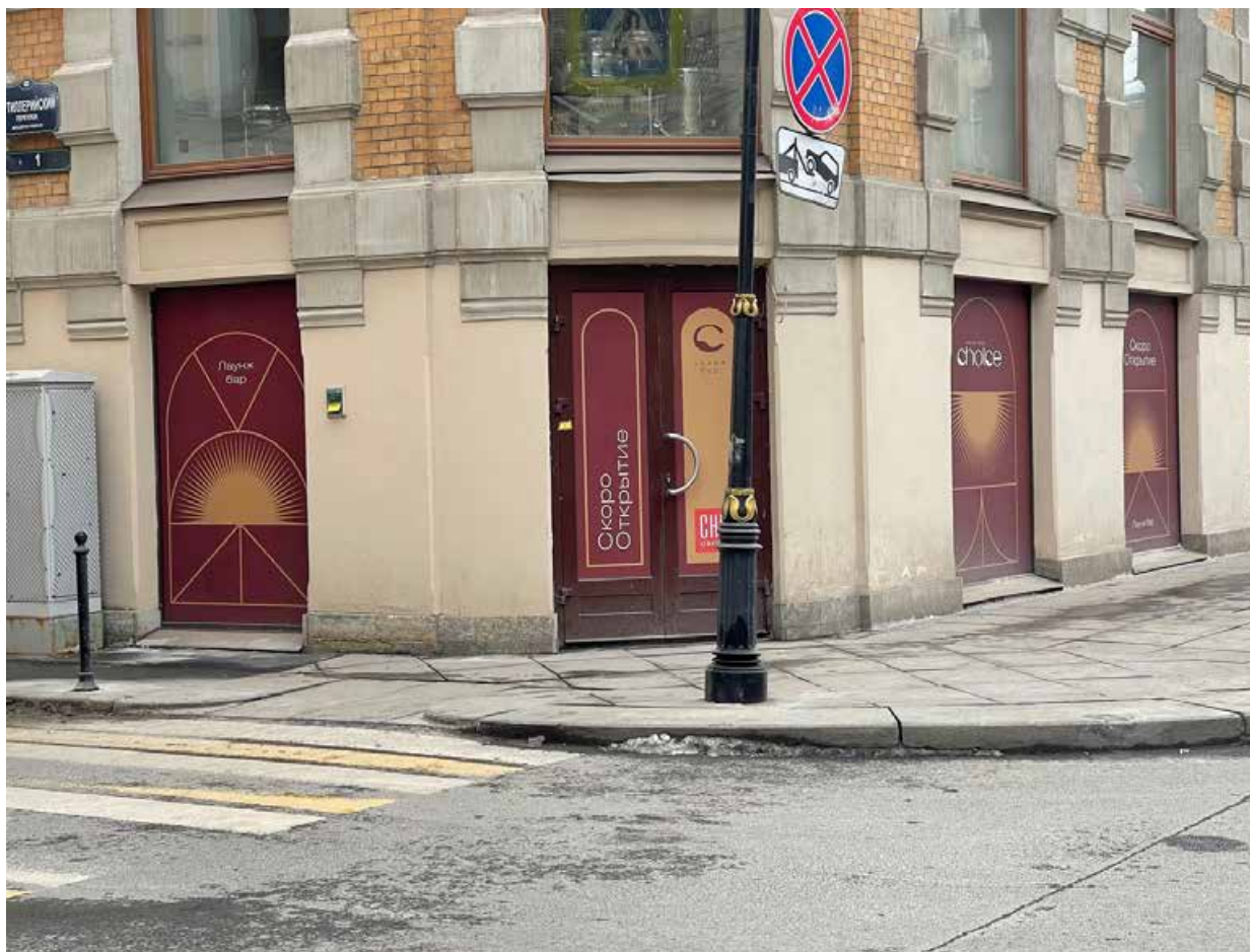
3. Вид на входную дверь в помещение 1-Н;
