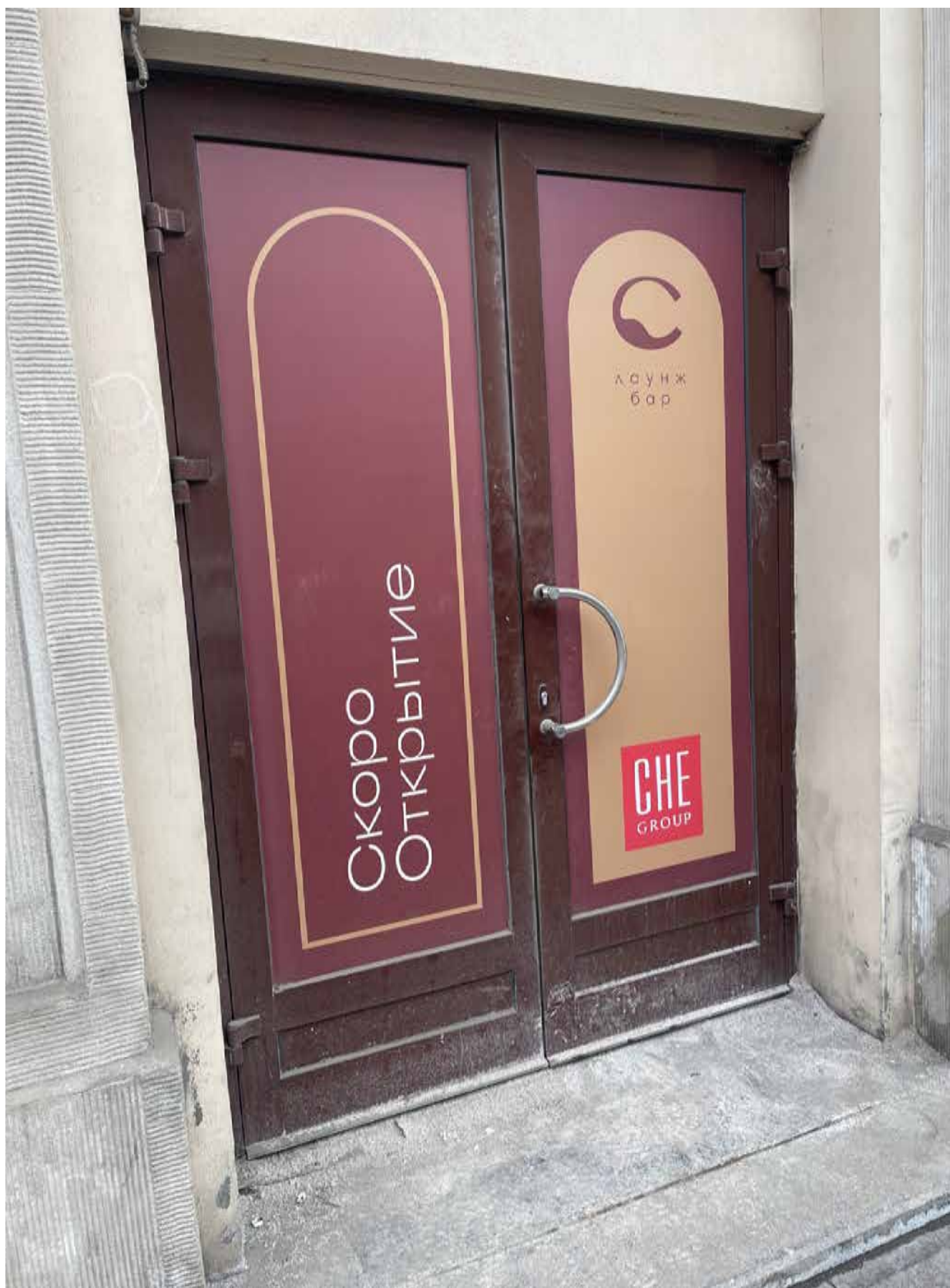
4. Вид на входную дверь в помещение 1-Н
