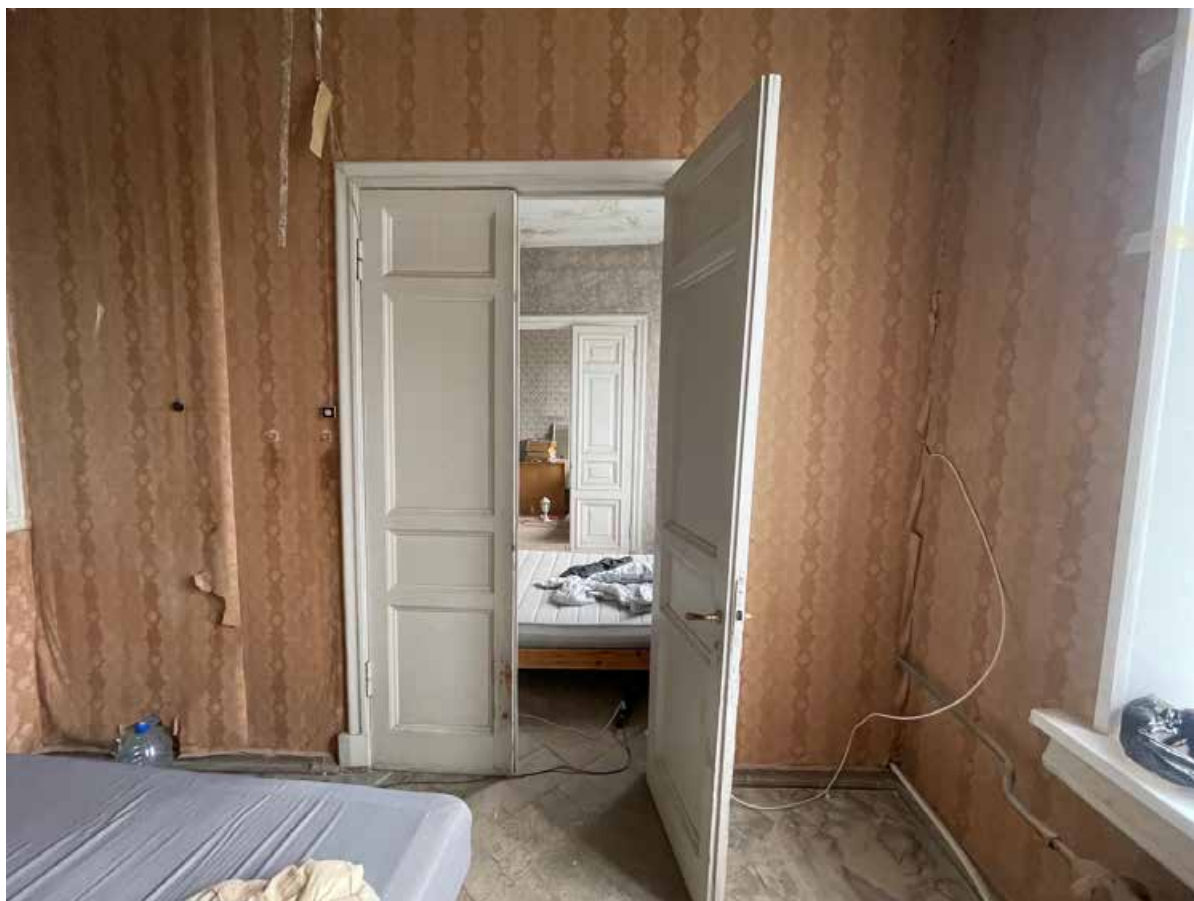
10. Помещение 4 (согласно техническому паспорту на квартиру).
