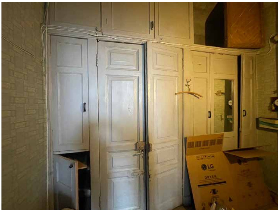
4. Встроенный шкаф и входная дверь тамбура. Помещение 1 (согласно техническому паспорту на квартиру).
