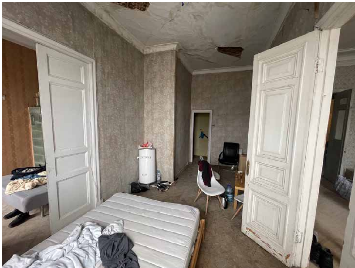
8. Помещение 3 (согласно техническому паспорту на квартиру).
