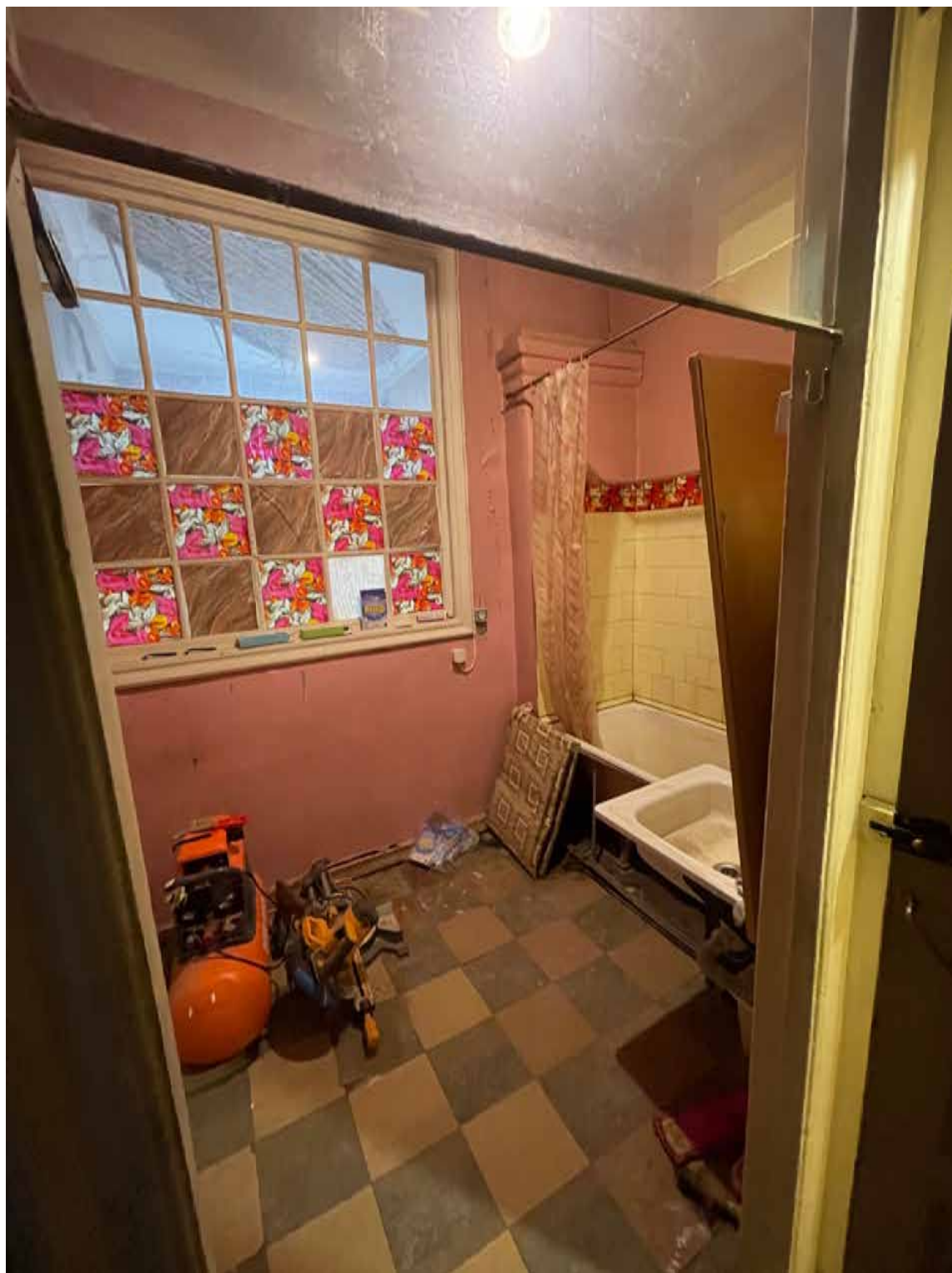
11. Помещение 5 (согласно техническому паспорту на квартиру).
