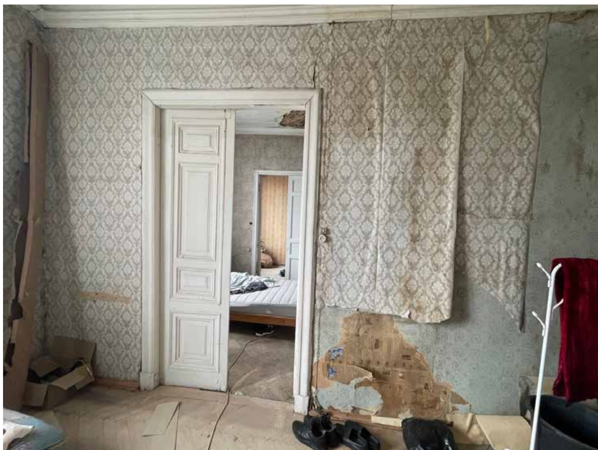
7. Помещение 2 (согласно техническому паспорту на квартиру).
