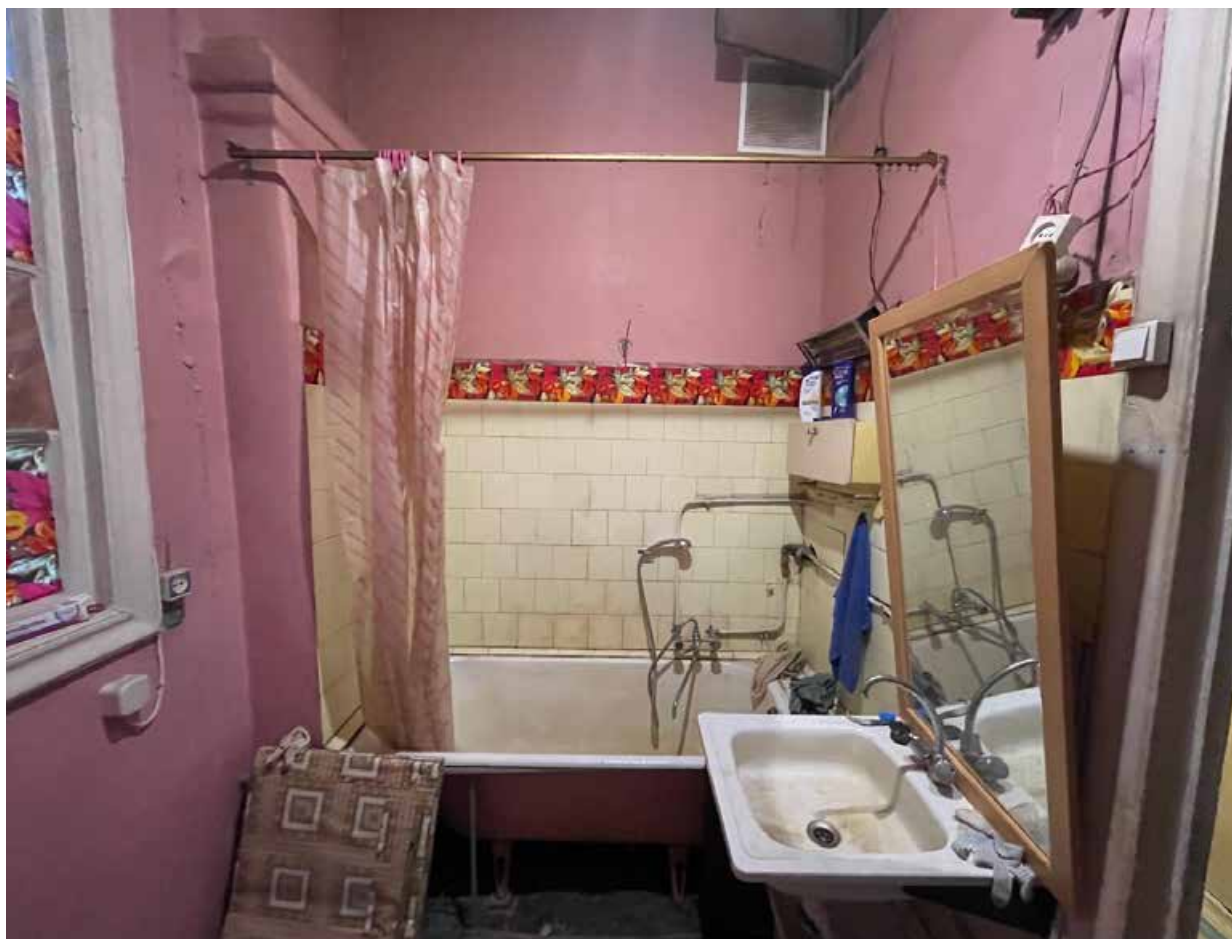
12. Помещение 5 (согласно техническому паспорту на квартиру).
