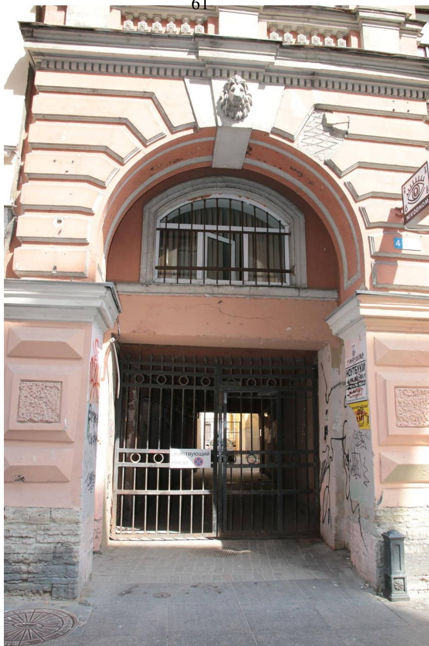
7. Вид арки здания с юга со стороны переулка Ульяны Громовой.
