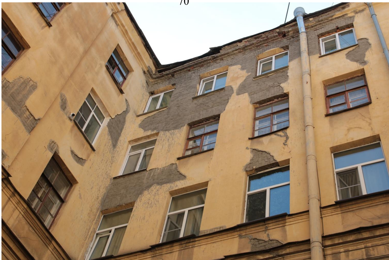
17. Фрагмент дворового фасада. Вид с северо-запада.
