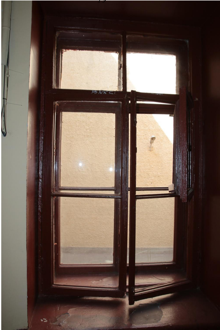
28. Оконные проемы лестничных клеток.
