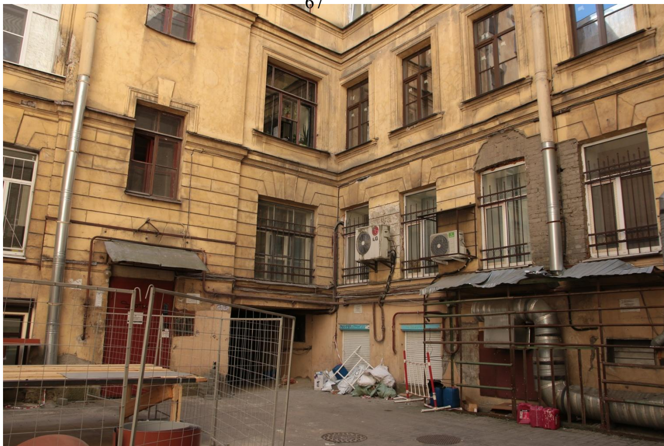
13. Фрагмент дворового фасада. Вид с северо-запада.
