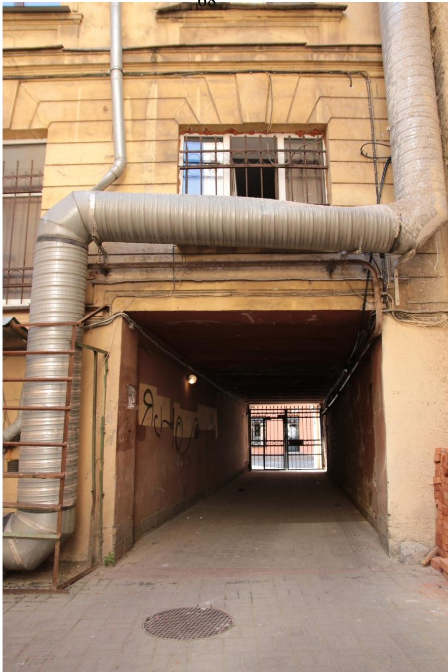
14. Арка дворового фасада. Вид с севера.
