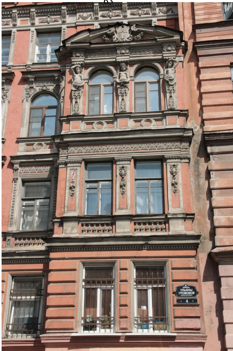
9. Часть фасада здания, вид с юга.
