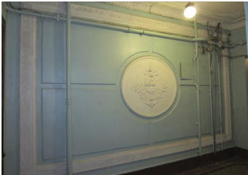
35. Оформление стен лестничной площадки
