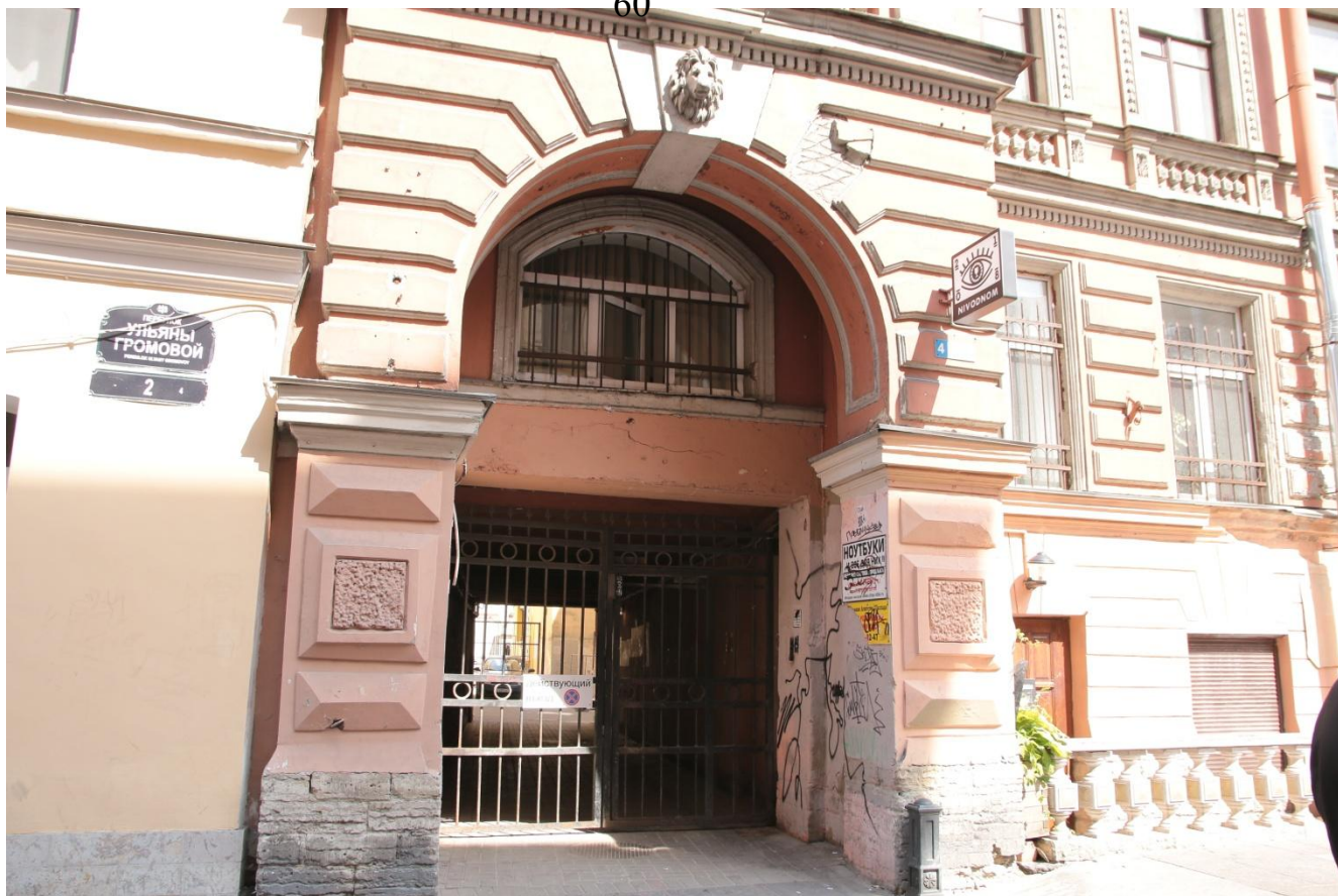
6. Вид арки здания с юга со стороны переулка Ульяны Громовой.
