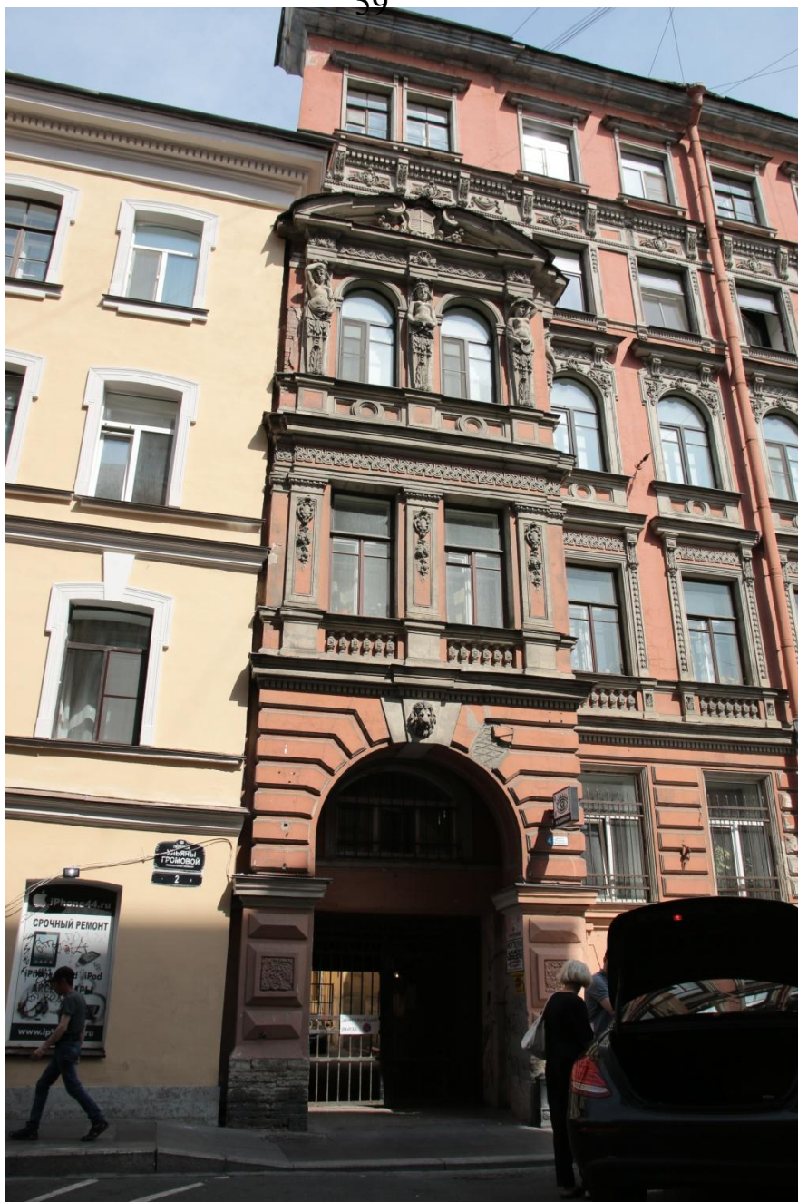
5. Вид арки здания с юга со стороны переулка Ульяны Громовой.
