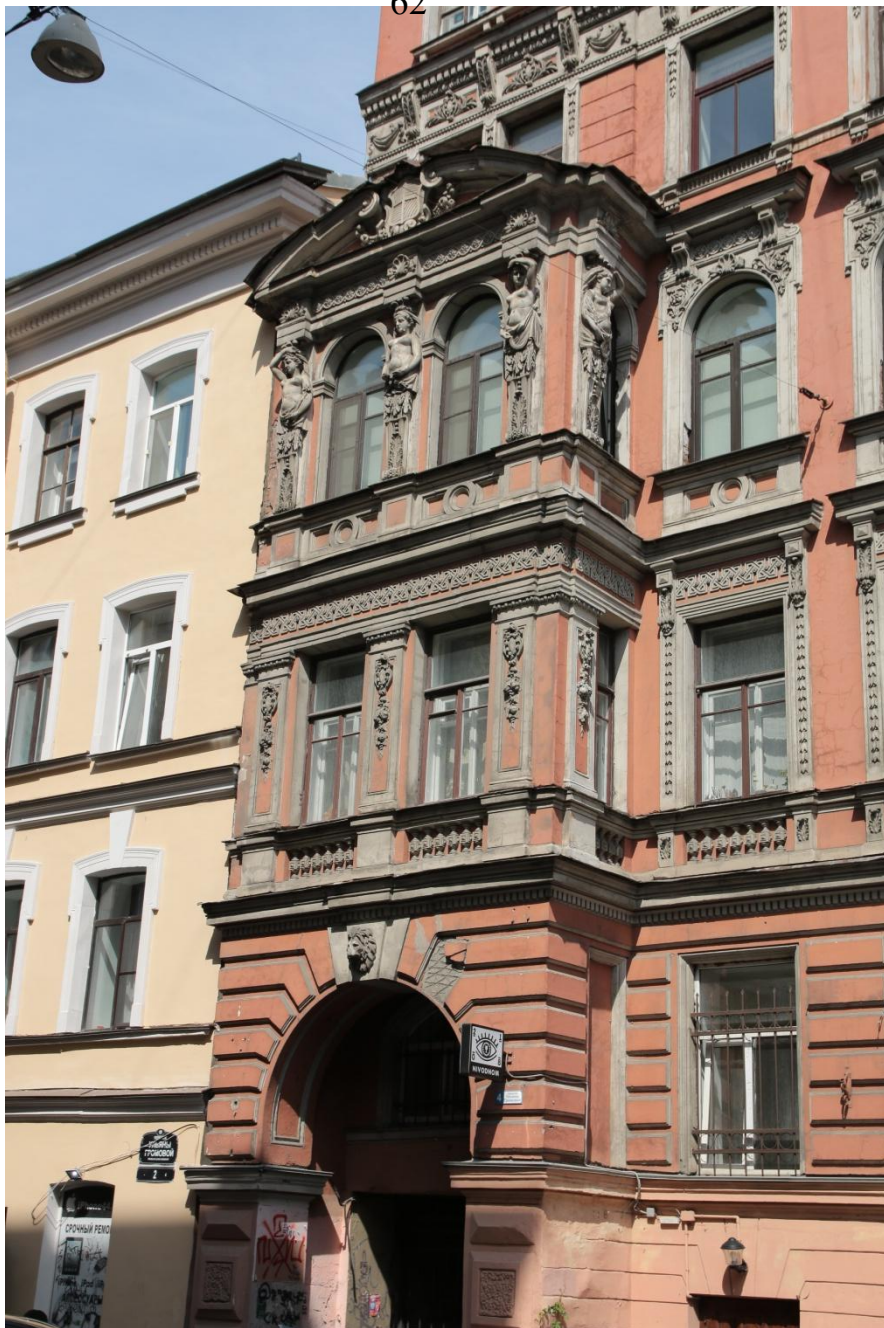
8. Часть фасада здания с юга со стороны переулка Ульяны Громовой.
