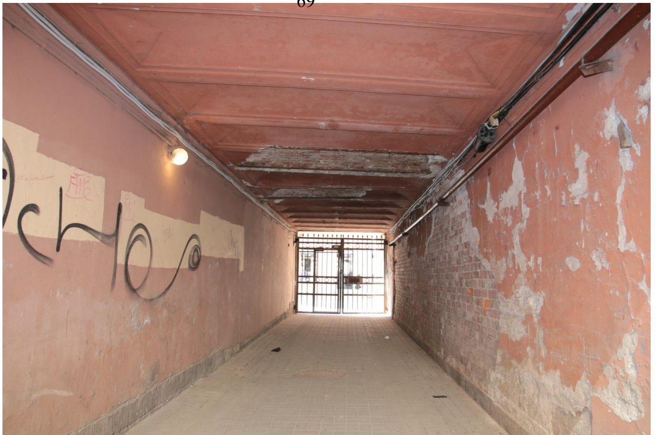
15. Арка Вид с севера.
