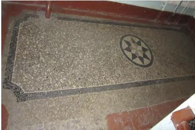
34. Фрагмент оформления пола лестничной площадки
