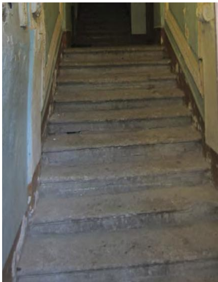
31. Фрагмент лестницы вестибюля парадной
