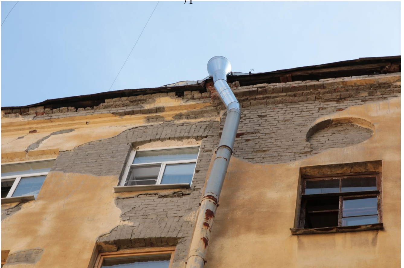
19. Фрагмент дворового фасада. Вид с севера.
