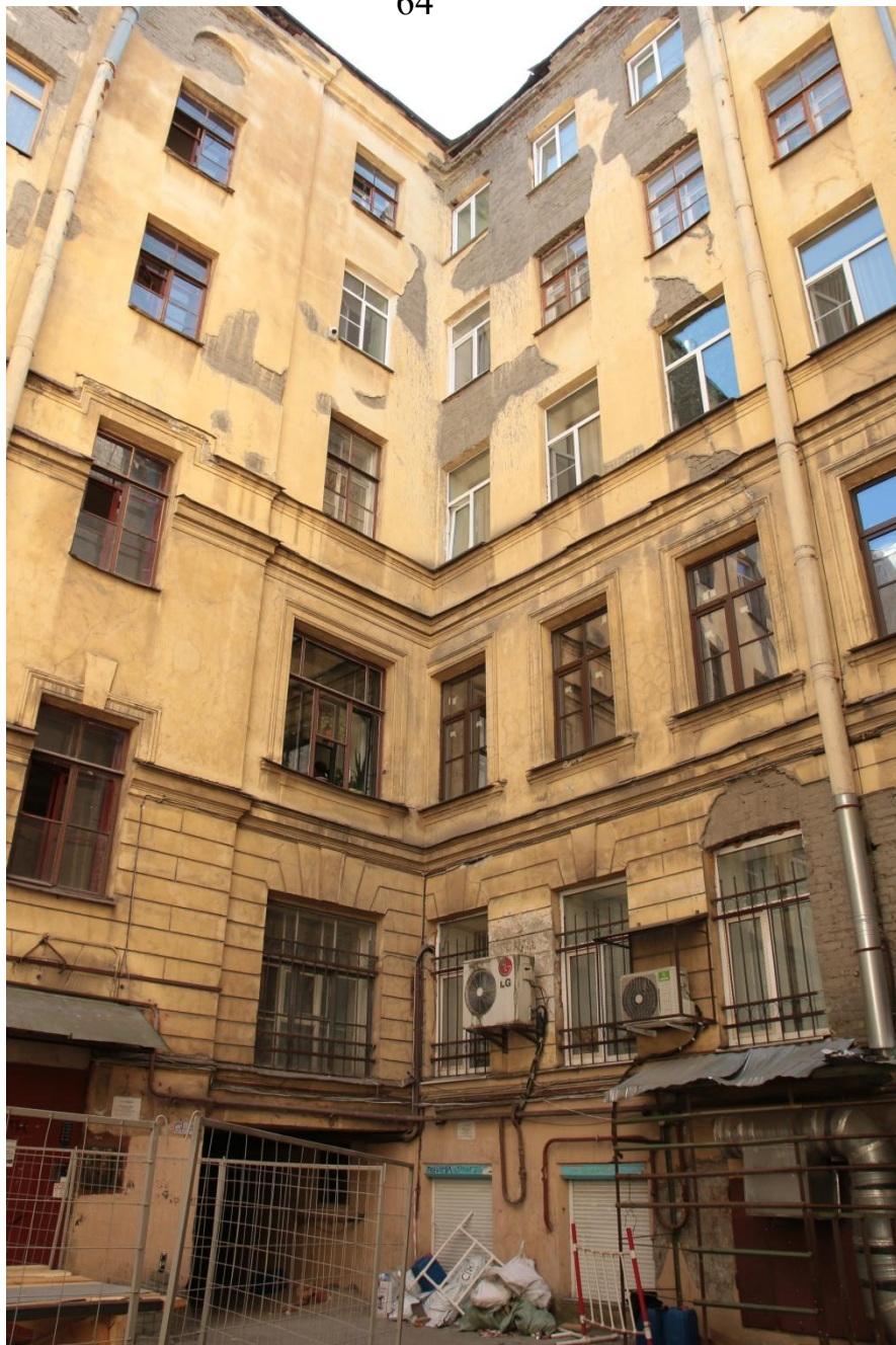
10. Фрагмент дворового фасада. Вид с северо-запада.
