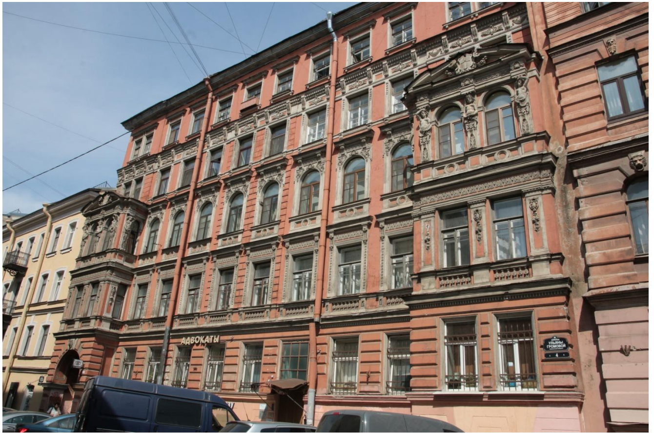
3. Вид здания с юго-востока со стороны переулка Ульяны Громовой.
