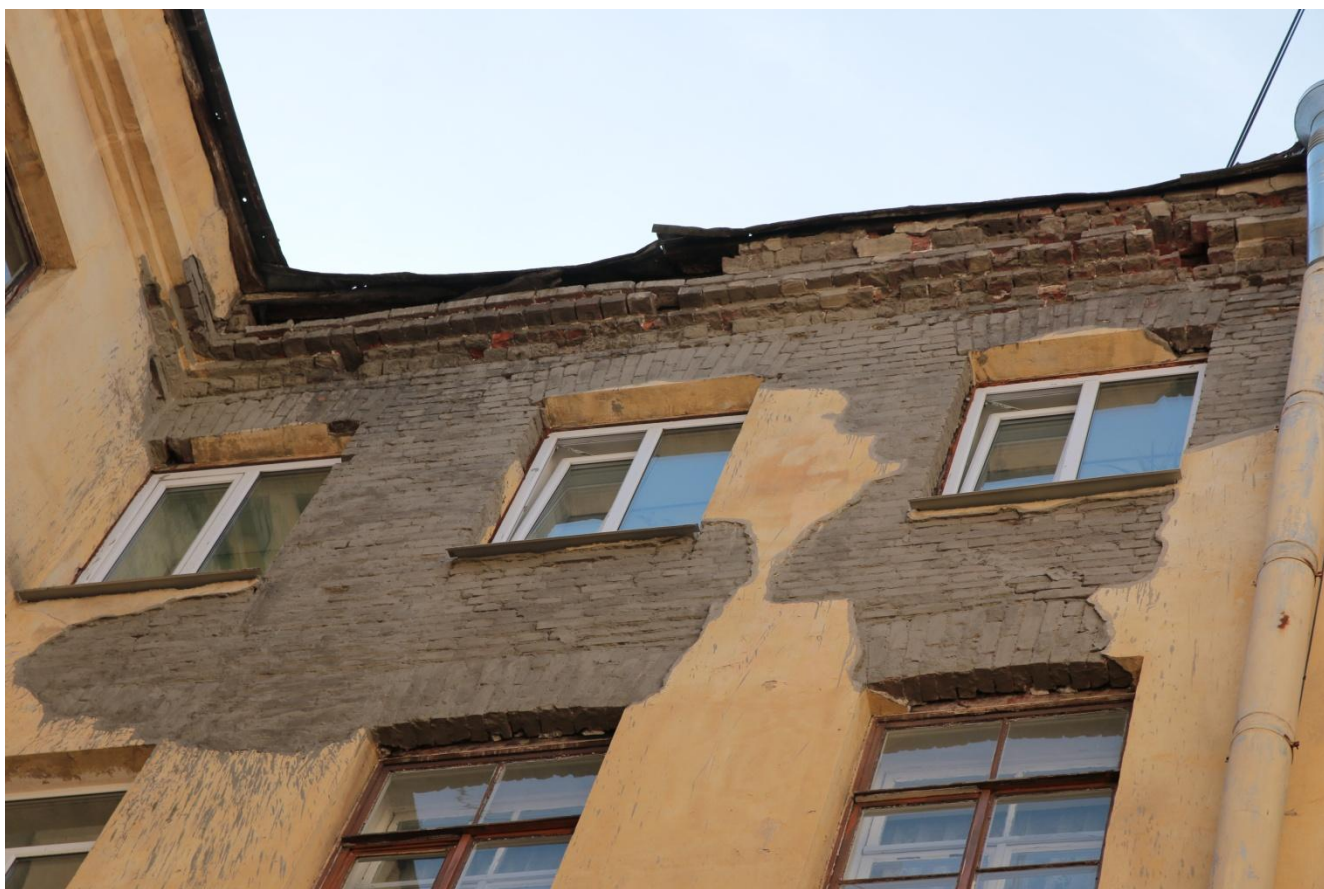
18. Фрагмент дворового фасада. Вид с северо-запада.
