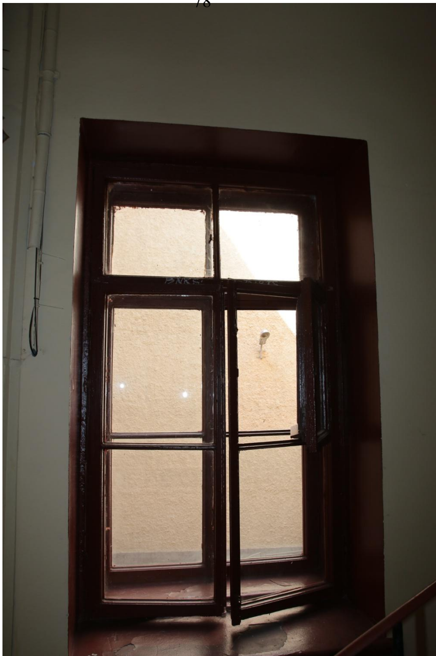
27. Оконные проемы лестничных клеток.
