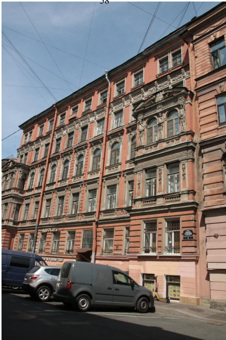
4. Вид здания с юго-востока со стороны переулка Ульяны Громовой.
