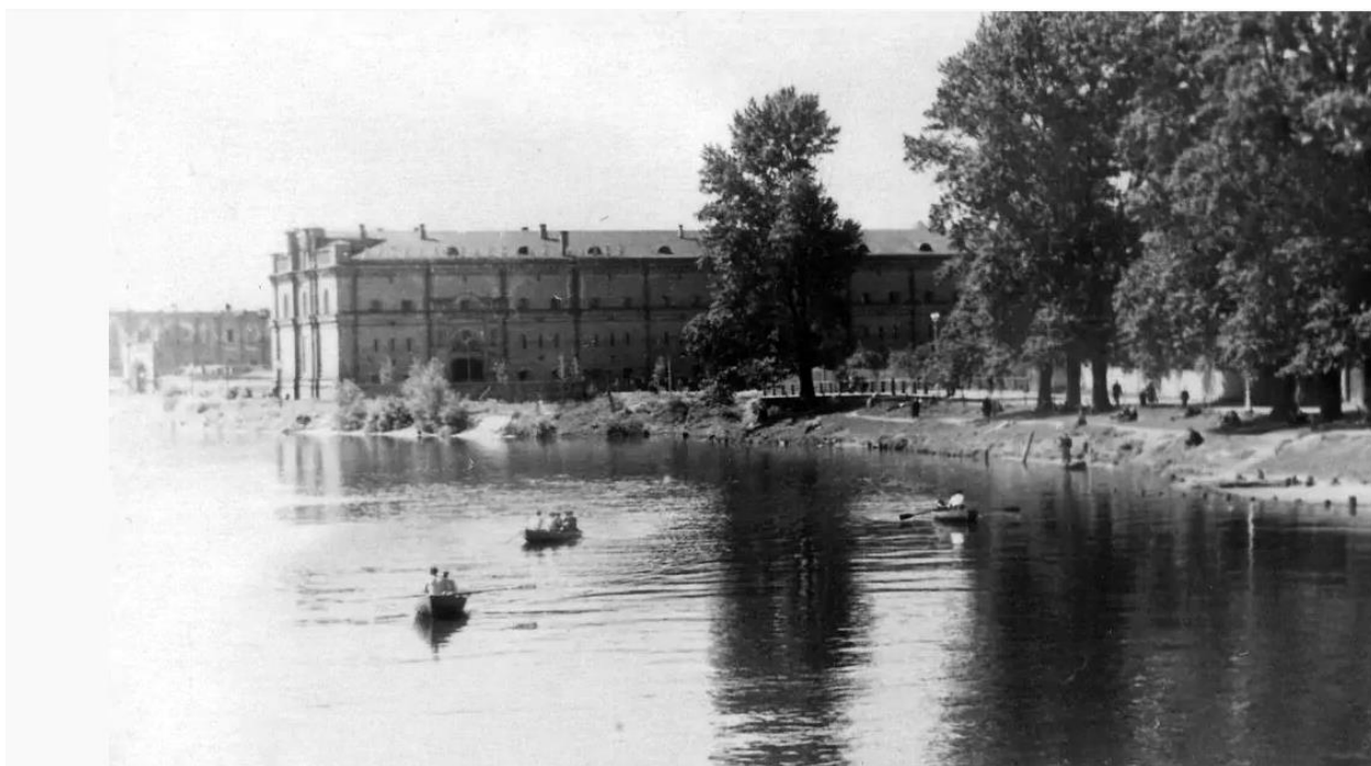
11. Кронверкская набережная, 1950 г. [Электронный ресурс] URL: https://pastvu.com/p/1790200
