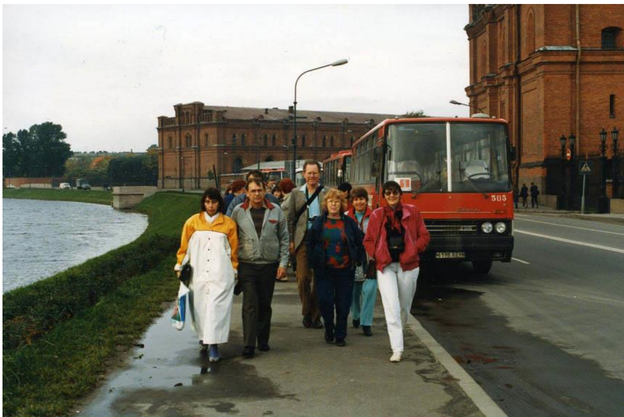
23. Кронверкская набережная, 1987 г. [Электронный ресурс] URL: https://pastvu.com/p/1431653
