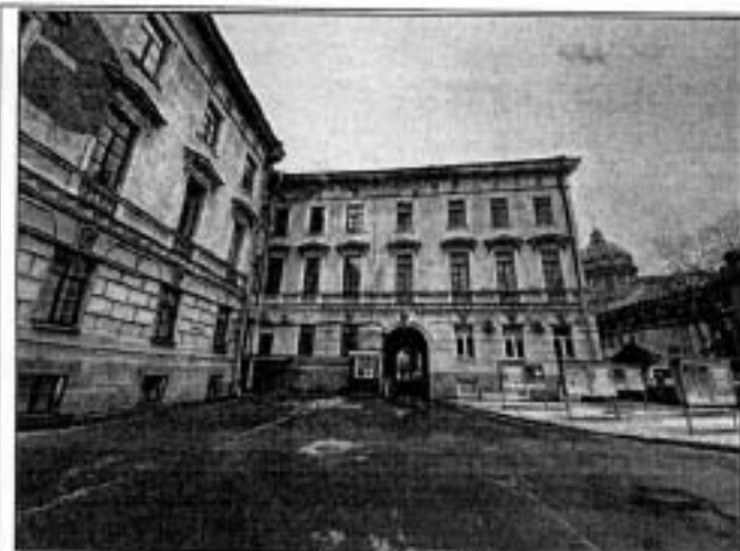
Фото 3. Восточный дворовой фасад и фрагмент северного дворового фасада объекта культурного наследия.
