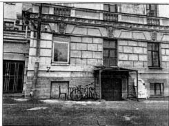
Фото 4. Фрагмент северного дворового фасада объекта культурного наследия.
