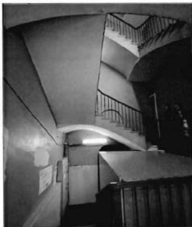
5. Лестница (Л-1) объекта культурного наследия.
