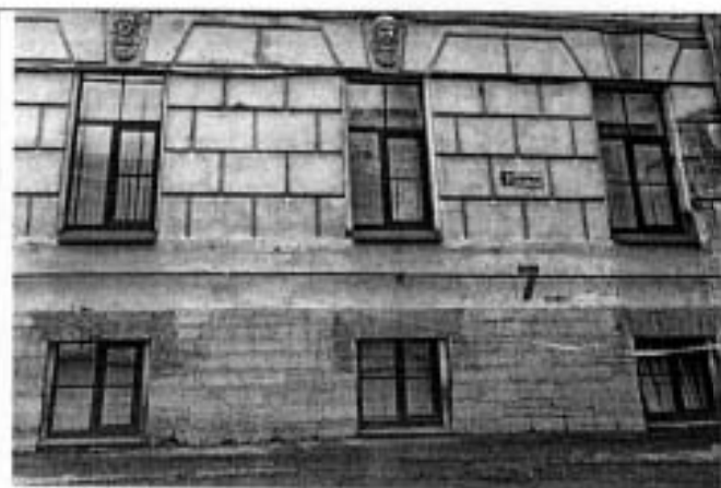
Фото 7. Фрагмент северного дворового фасада объекта культурного наследия.
