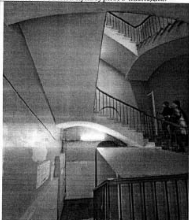
Фото 11. Лестница (Л-1) объекта культурного наследия.
