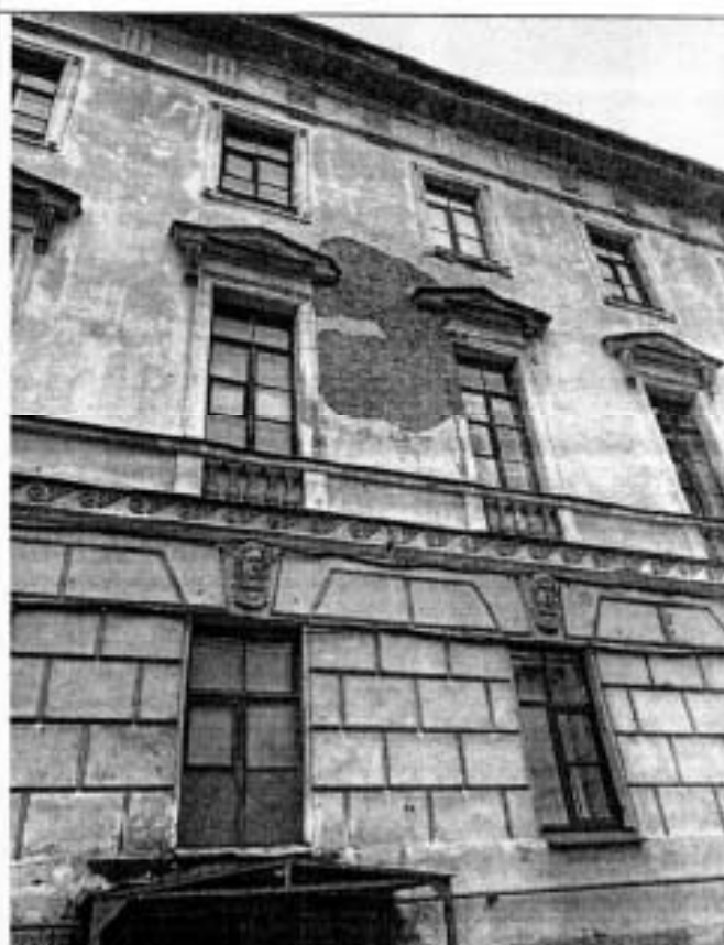
Фото 6. Фрагмент северного дворового фасада объекта культурного наследия.
