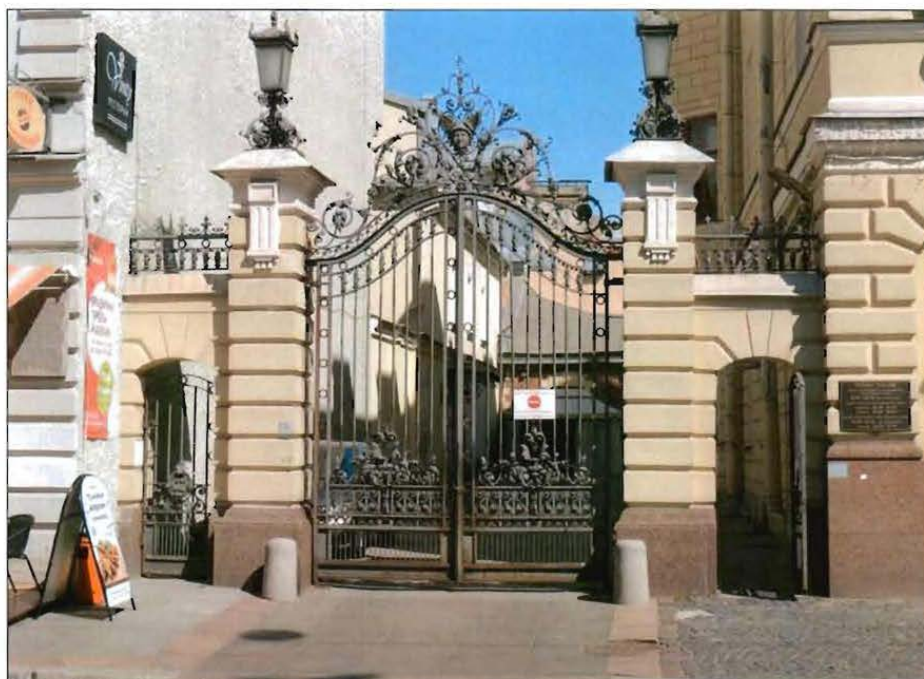
1. Лицевой фасад по Фурштатской улице.
