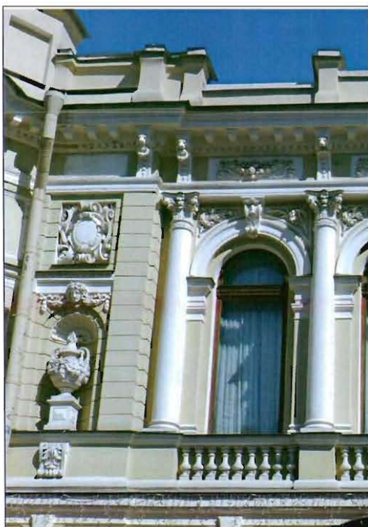
3. Лицевой фасад. Фрагмент. Архитектурно-художественная отделка.
