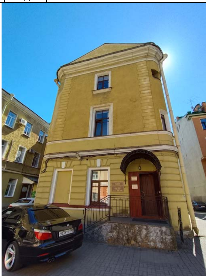
6. «Дом жилой с флигелями» (в составе «Дом Варгунина К.А.»). Дворовый фасад. Фрагмент.
