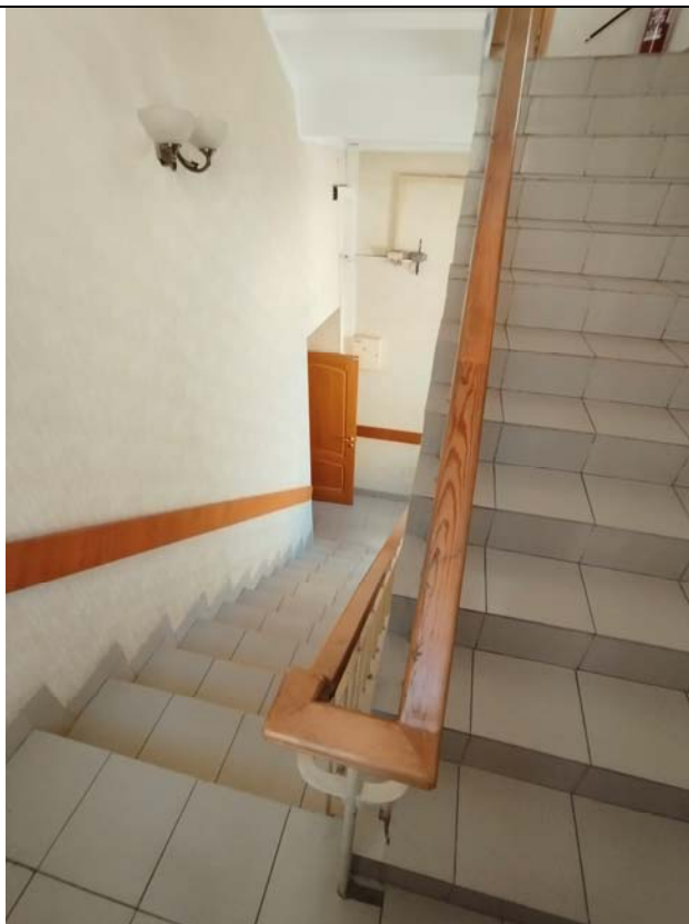
33. «Дом жилой с флигелями» (в составе «Дом Варгунина К.А.»). 2 этаж. Служебная лестница.
