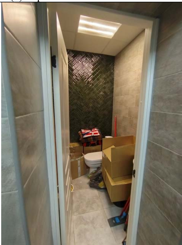
10. «Дом жилой с флигелями» (в составе «Дом Варгунина К.А.»). 1 этаж. Помещение санузла.
