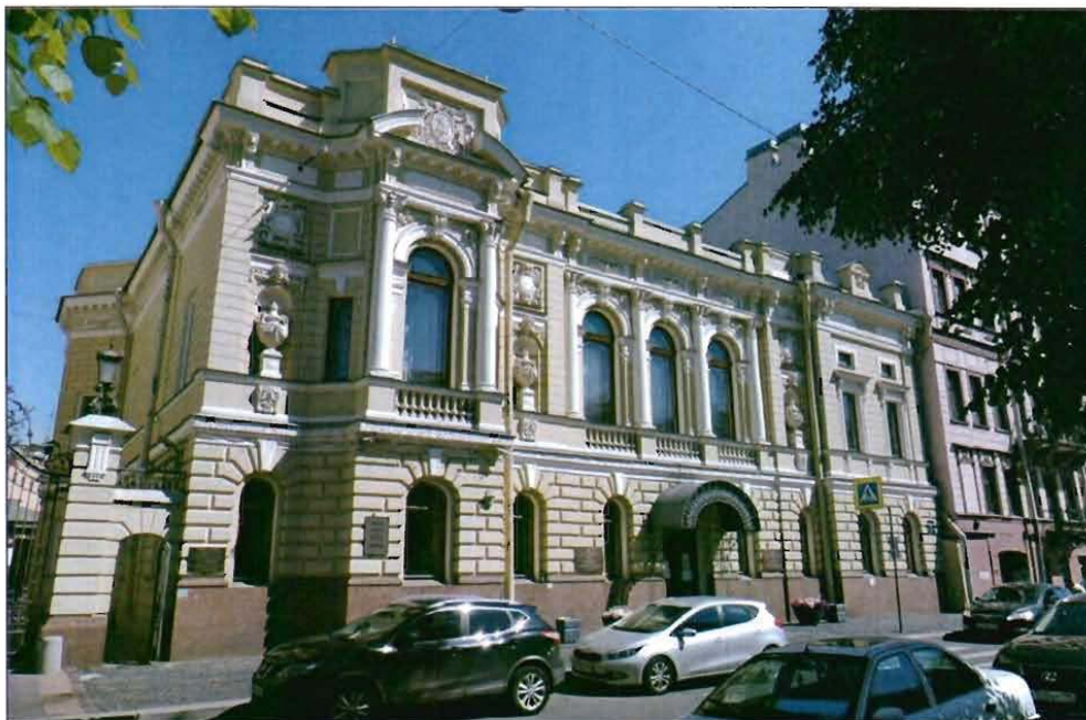
2. Лицевой фасад по Фурштатской улице.
