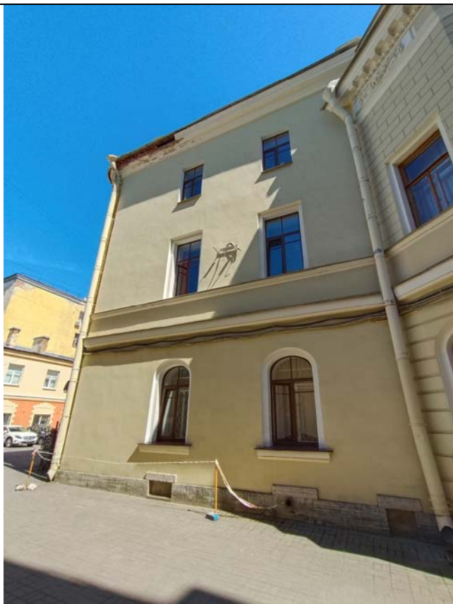
5. «Дом жилой с флигелями» (в составе «Дом Варгунина К.А.»). Дворовый фасад. Фрагмент.
