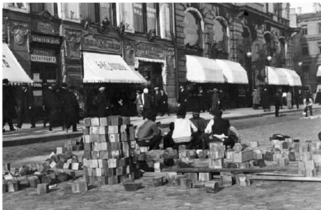
27. Ремонт торцовой мостовой у дома Зингера. 1907-1917 гг.
