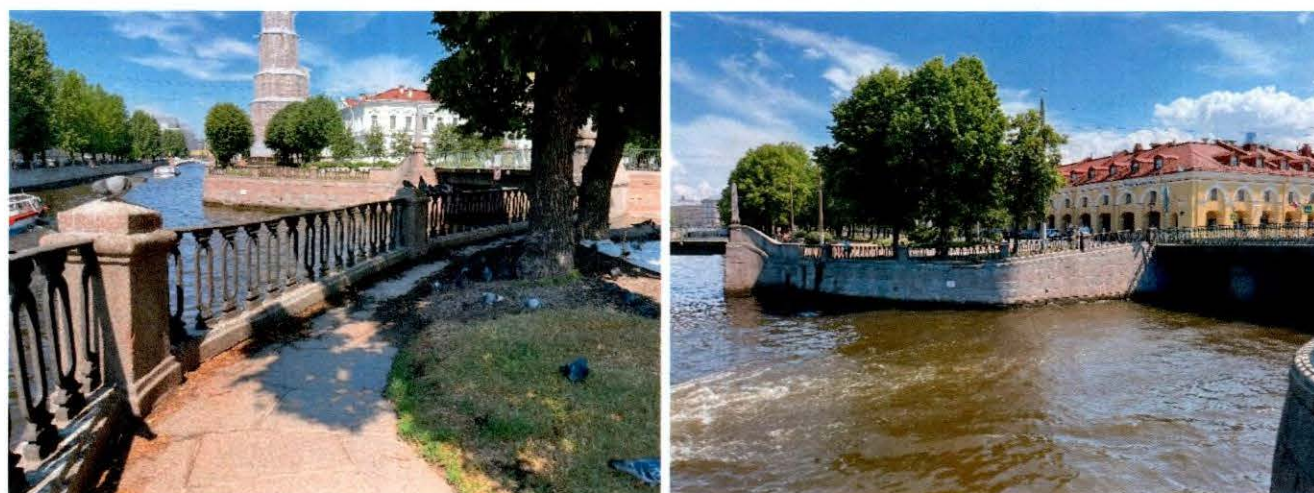
Фото 36, 37. Восточный участок набережной от Старо-Никольского моста до Красногвардейского моста.
