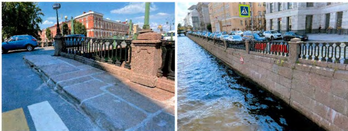
Фото 84, 85. Фрагмент западного берега набережной на участке от моста Декабристов до Матвеева моста.
