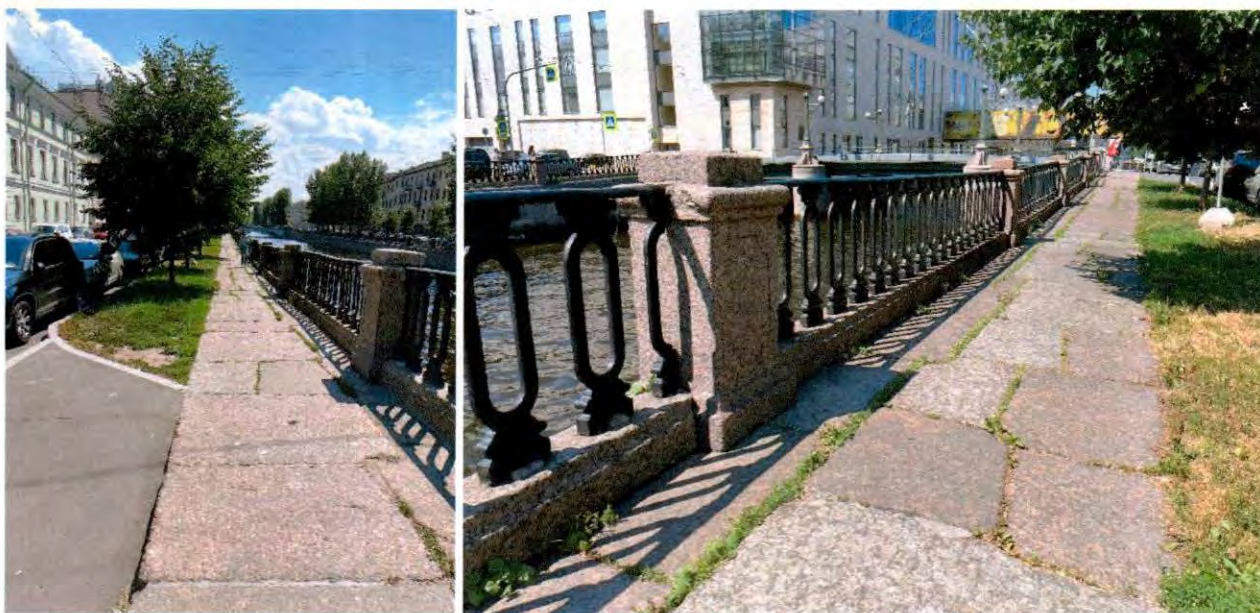
Фото 52, 53. Общий вид восточного берега набережной от Торгового моста до Кашина моста.
