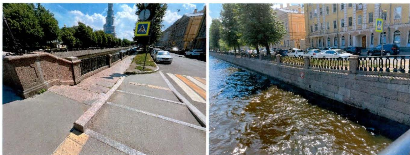
Фото 34, 35. Западный берег Крюкова канала возле Кашина моста.
