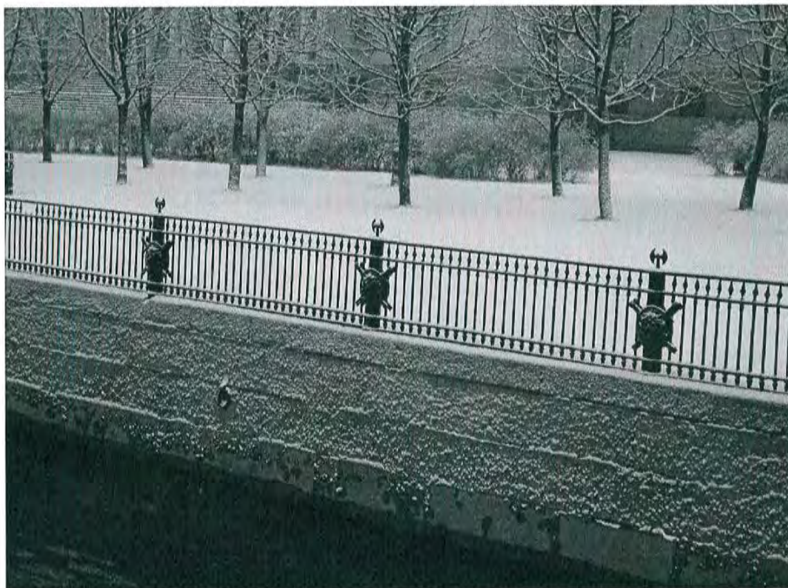
3. Ограждение набережной со стороны Михайловского (Инженерного) замка
