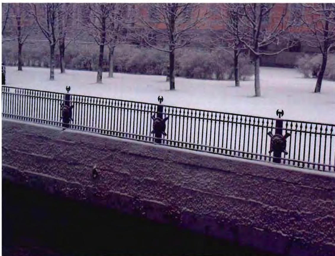
3. Ограждение набережной со стороны Михайловского (Инженерного) замка
