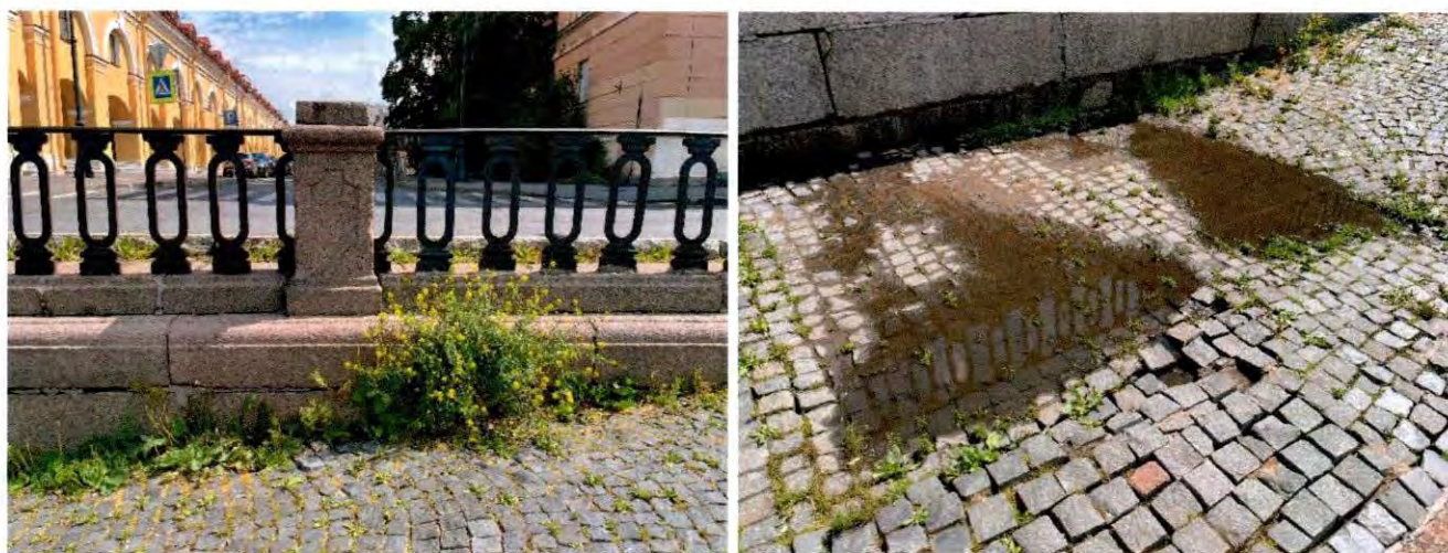
Фото 24, 25. Участок подпорной стенки северного конного спуска и фрагмент брусчатого покрытия спуска по восточному берегу набережной Крюкова канала на участке от Смежного моста до Старо-Никольского моста.
