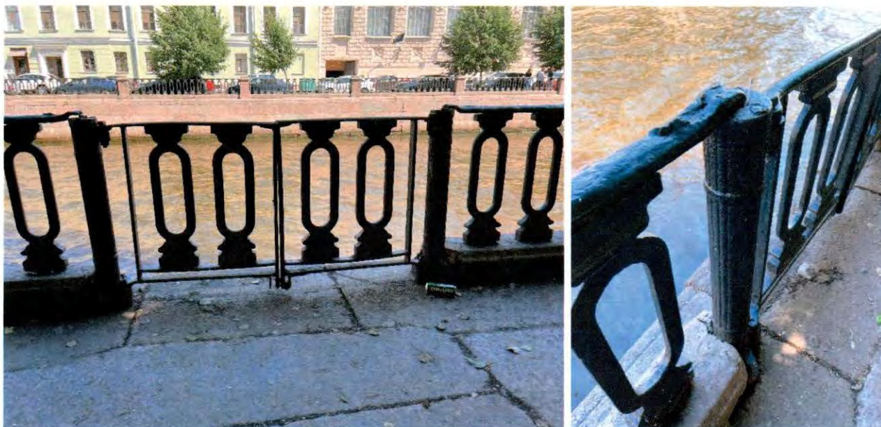
Фото 48, 49. Двустворчатая калитка в границах западной части ограждения набережной от Кашина моста до Торгового моста, северная.
