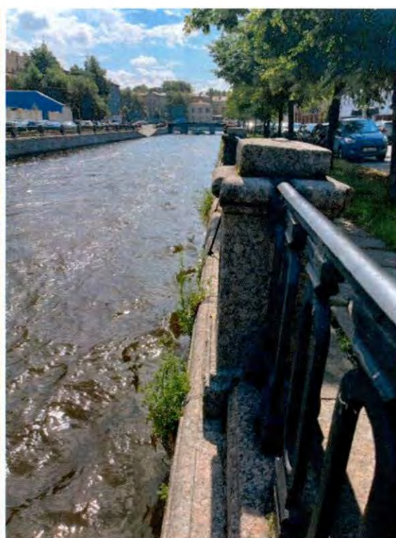
Фото 6, 7. Гранитные тумбы ограждения западного берега Крюкова канала
