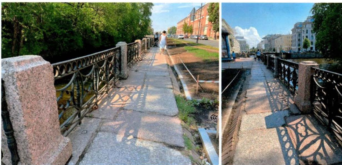
Фото 92, 93. Участок восточного берега набережной вдоль объекта культурного наследия «Ансамбль «Новая Голландия» от Кранснофлотского моста до Адмиралтейского канала.
