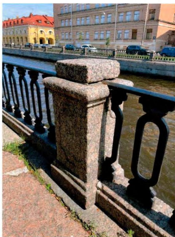
Фото 6, 7. Гранитные тумбы ограждения западного берега Крюкова канала
