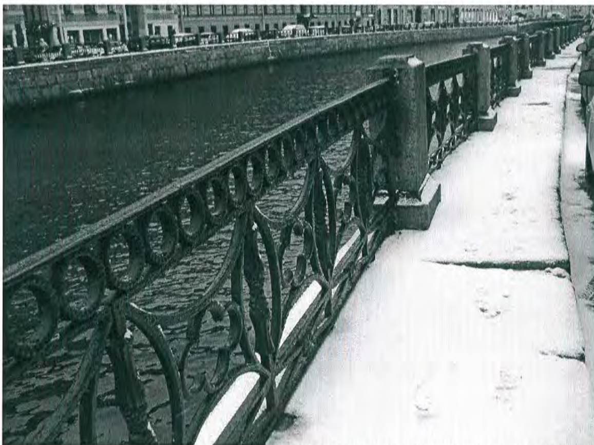
9. Перильное ограждение, тротуар. Биопоражение гранитных тумб, просадки тротуарных плит (правый берег, на участке между Певческим и Полицейским (Зелёным, Народным) мостами)
