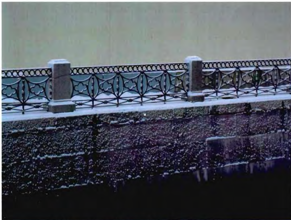
6. Ограждение набережной. Левобережная стенка
