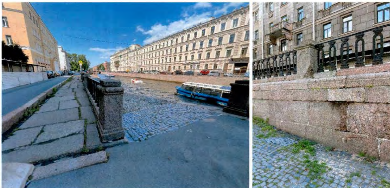
Фото 78. Общий вид конного спуска по западному берегу набережной на участке от моста Декабристов до Матвеева моста с южной стороны.
