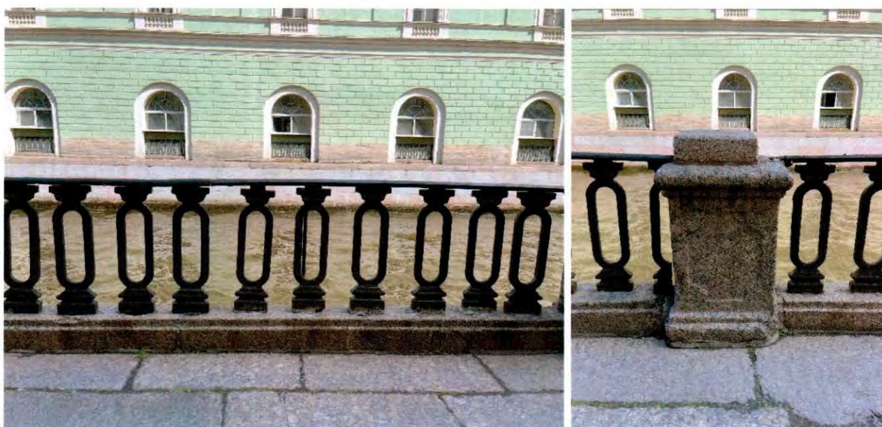
Фото 61, 62. Фрагменты ограждения и тумба ограждения западного берега набережной от Торгового моста до моста Декабристов.
