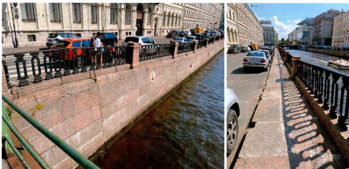
Фото 86, 87. Общий вид фрагмента восточного берега набережной на участке от Матвеева моста до моста Декабристов.
