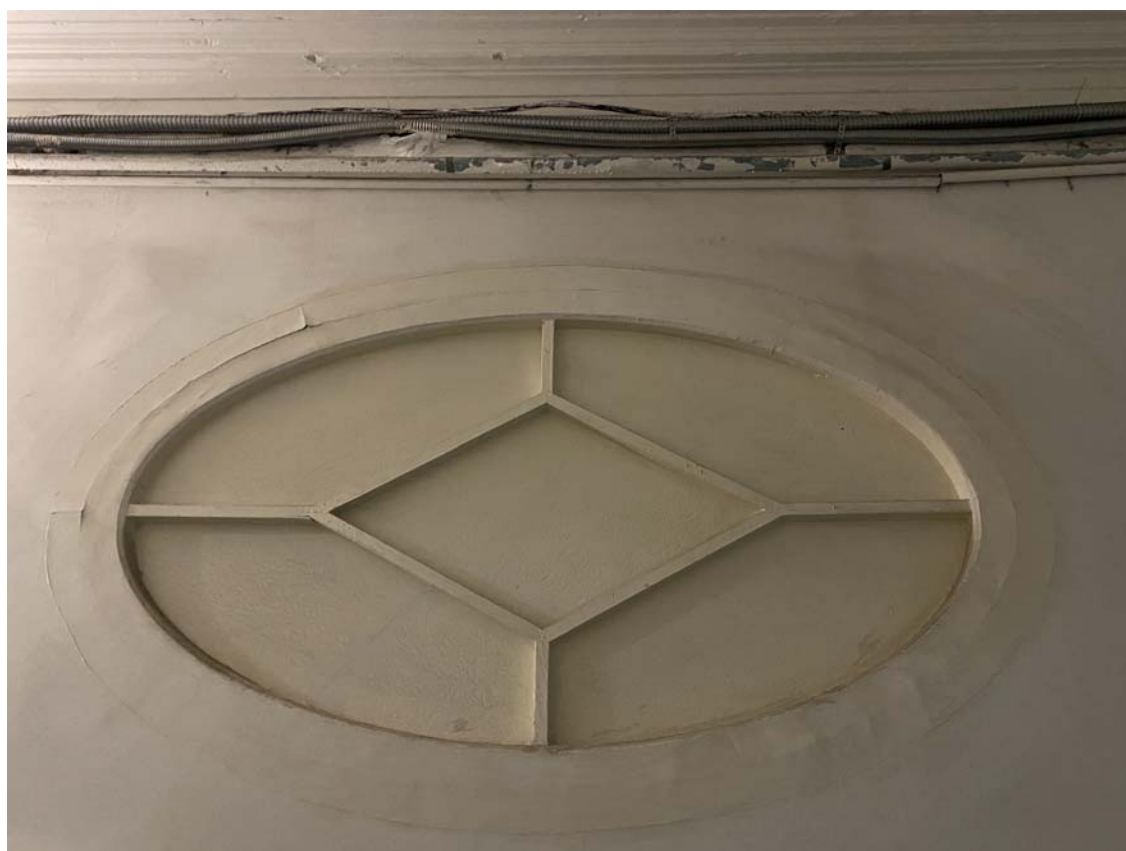
33. Оконный проем на лестничной площадке. ЛК 2
