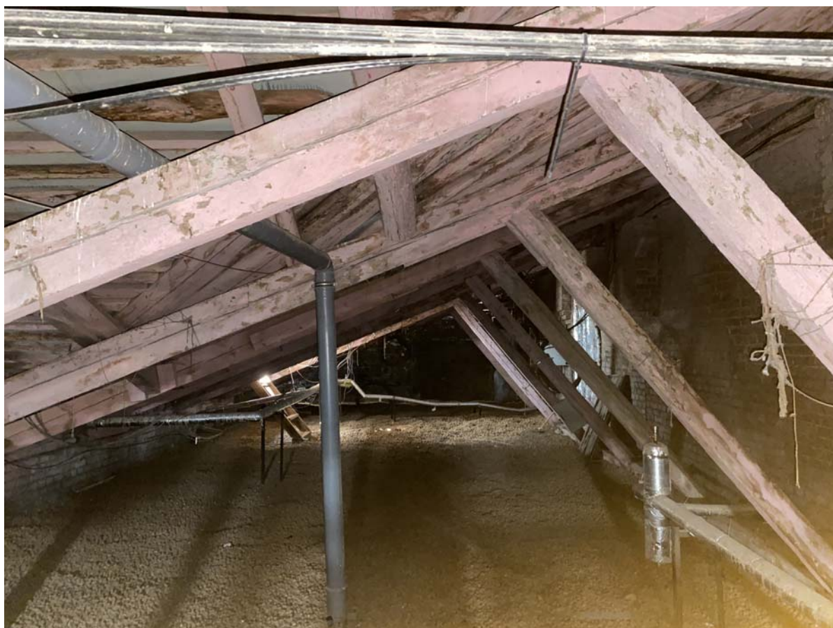
16. Стропильная система здания. Фрагмент.
