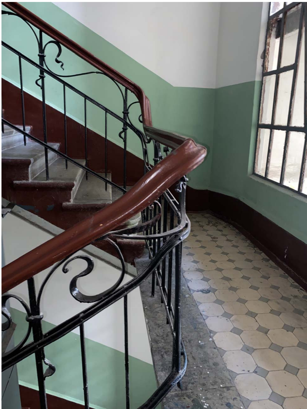
35. Междуетажная лестничная площадка ЛК2
