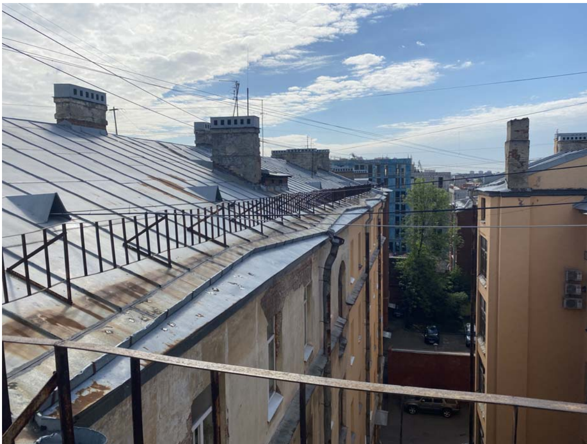
18. Окрытие кровли. Фрагмент
