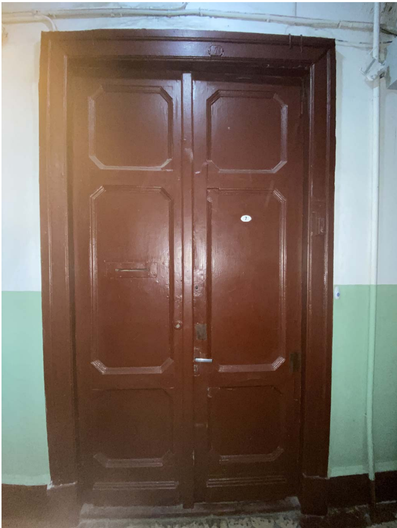
36. Историческое дверное заполнение. ЛК 2
