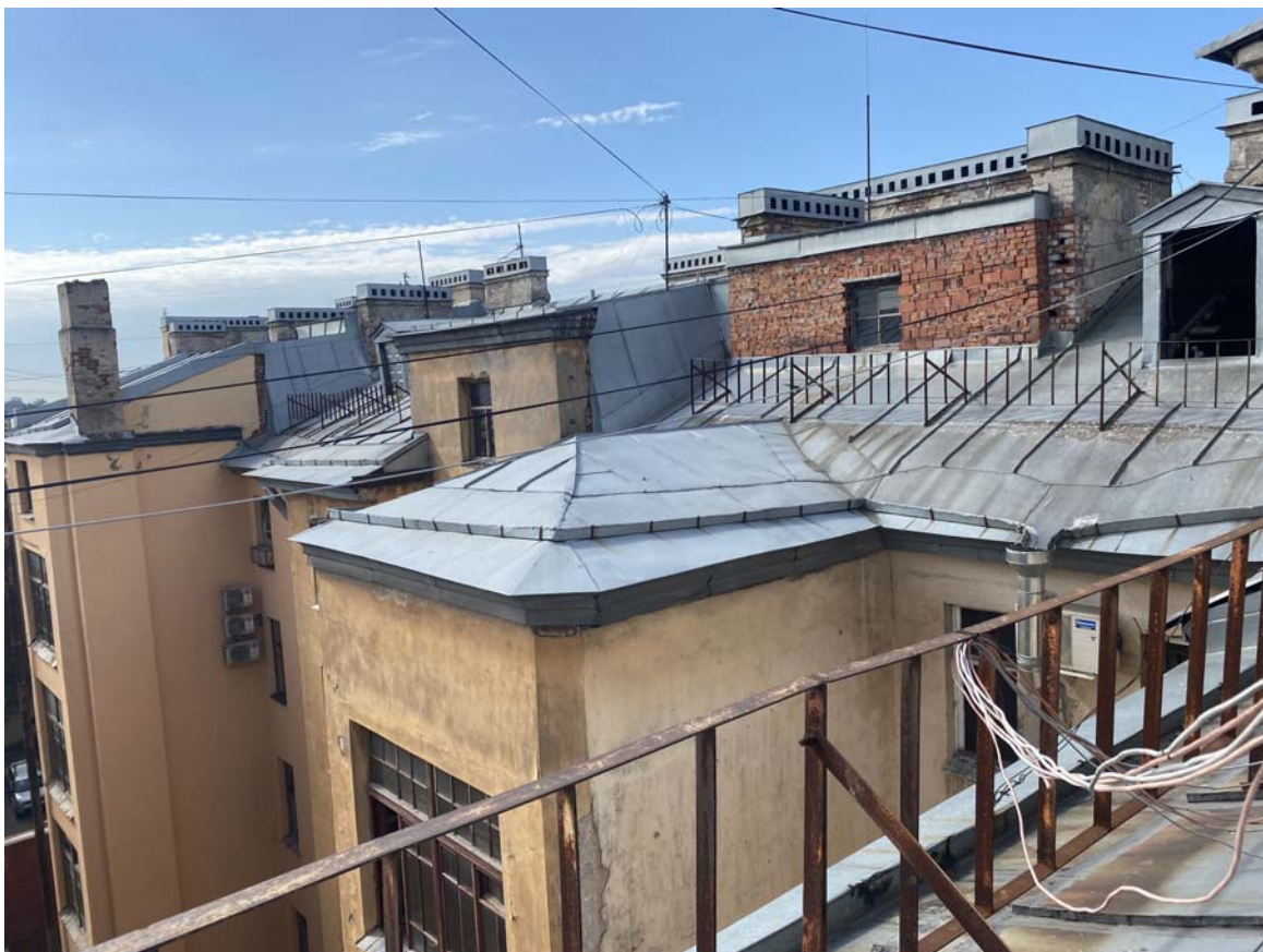
19. Окрытие кровли. Фрагмент
