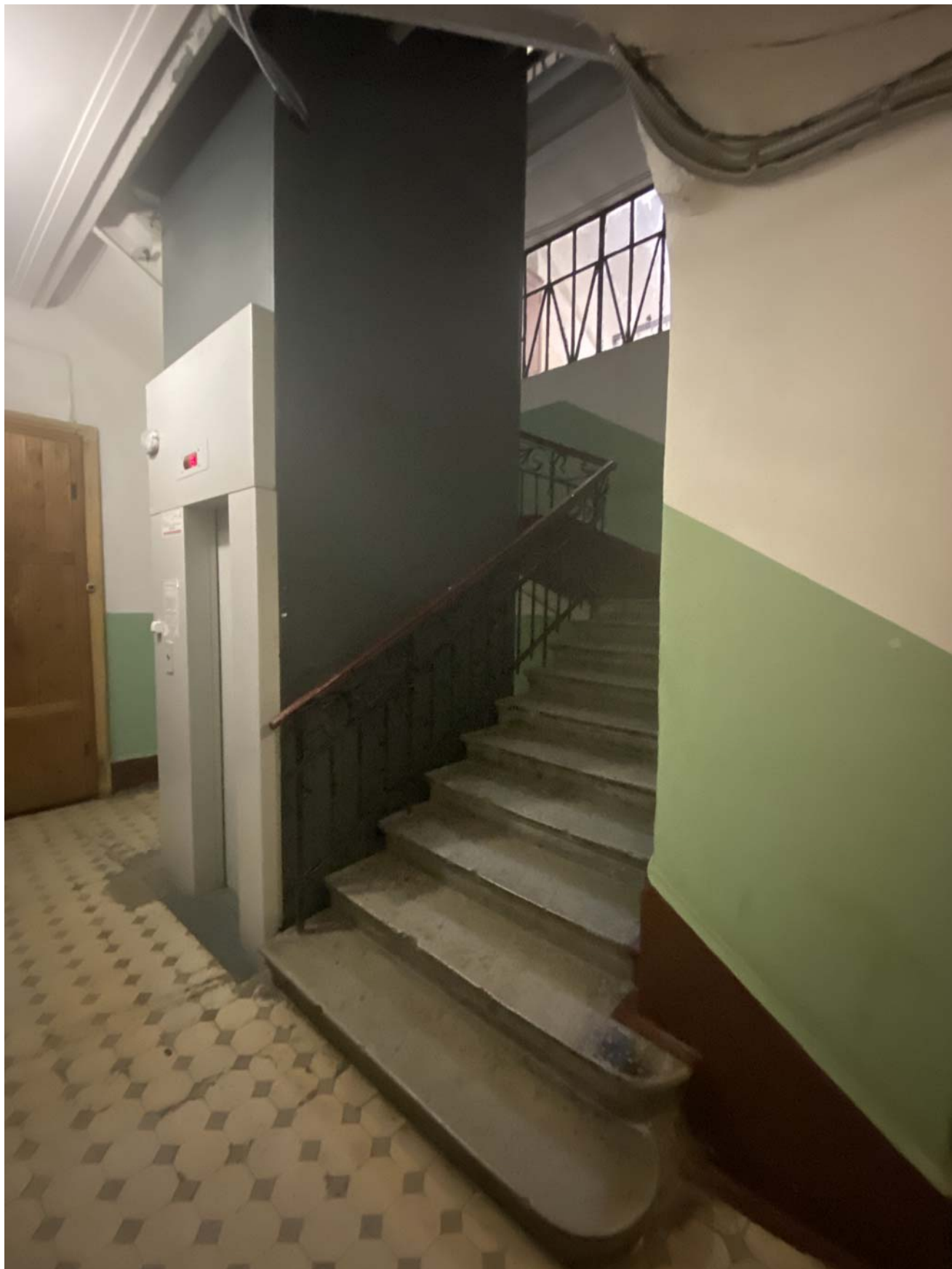
31.Площадка 1 этажа ЛК2
