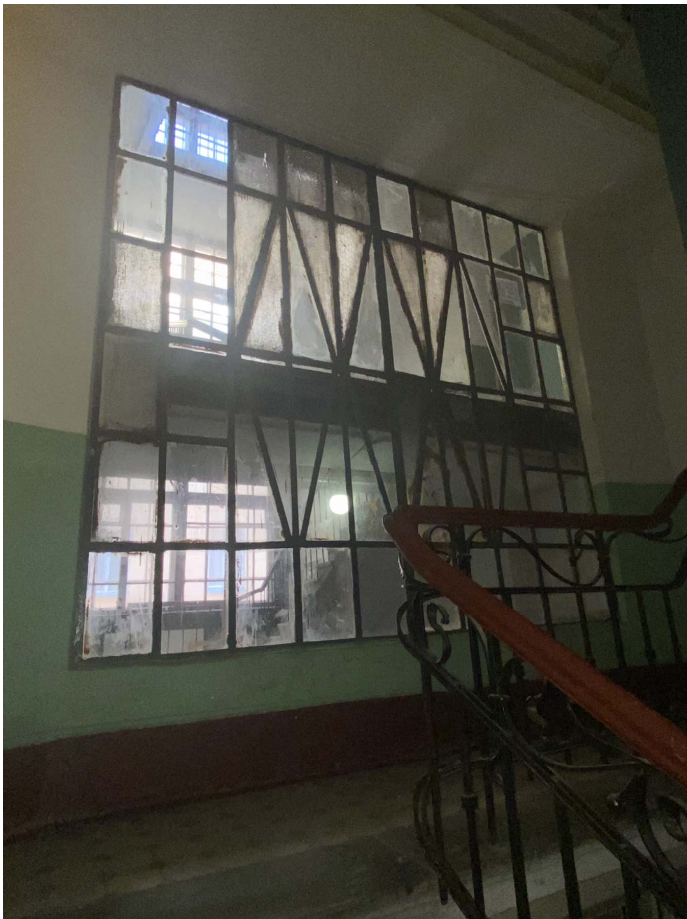
27. Междуэтажная площадка ЛК 1
