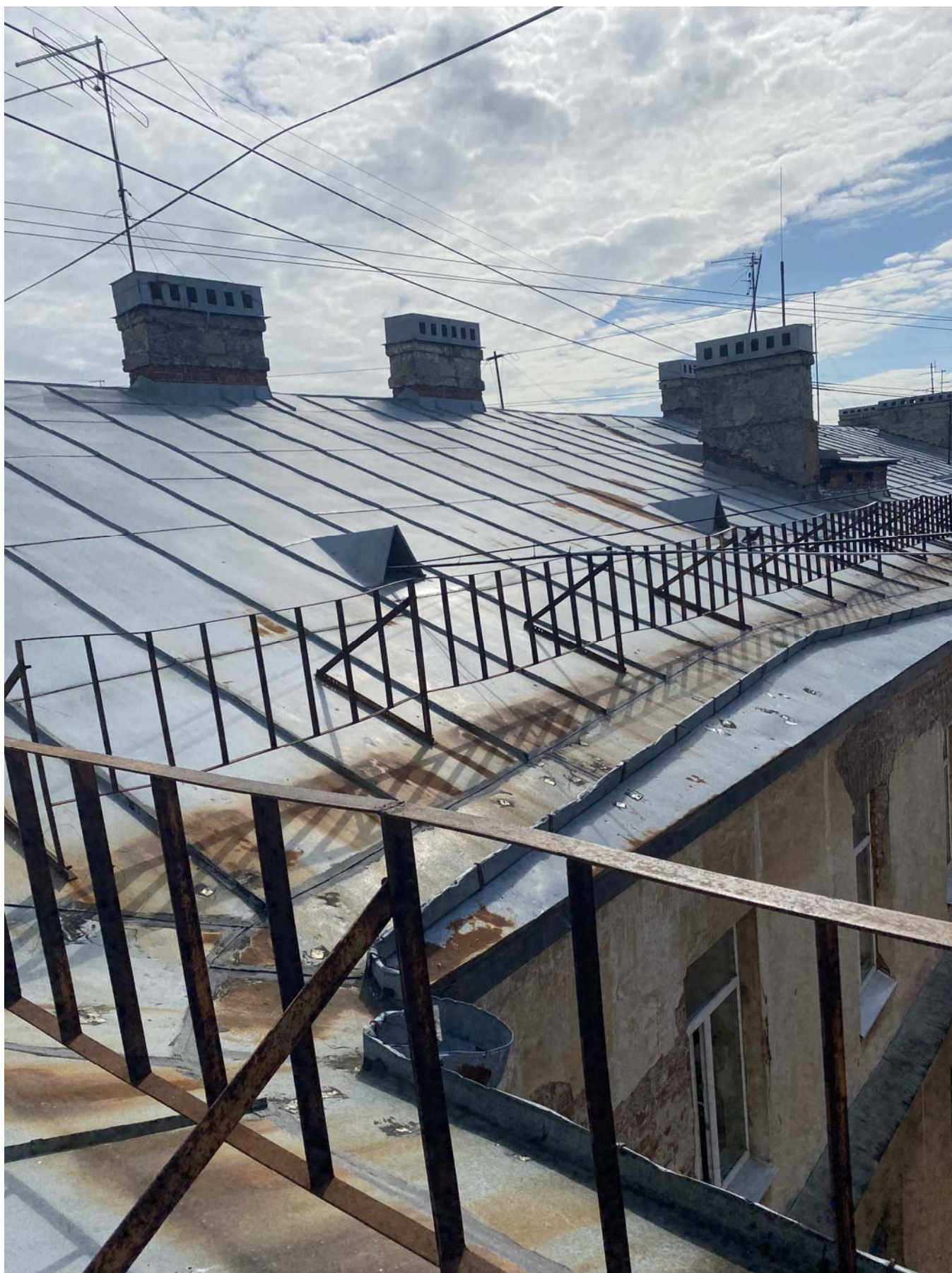
20. Окрытие кровли. Фрагмент
