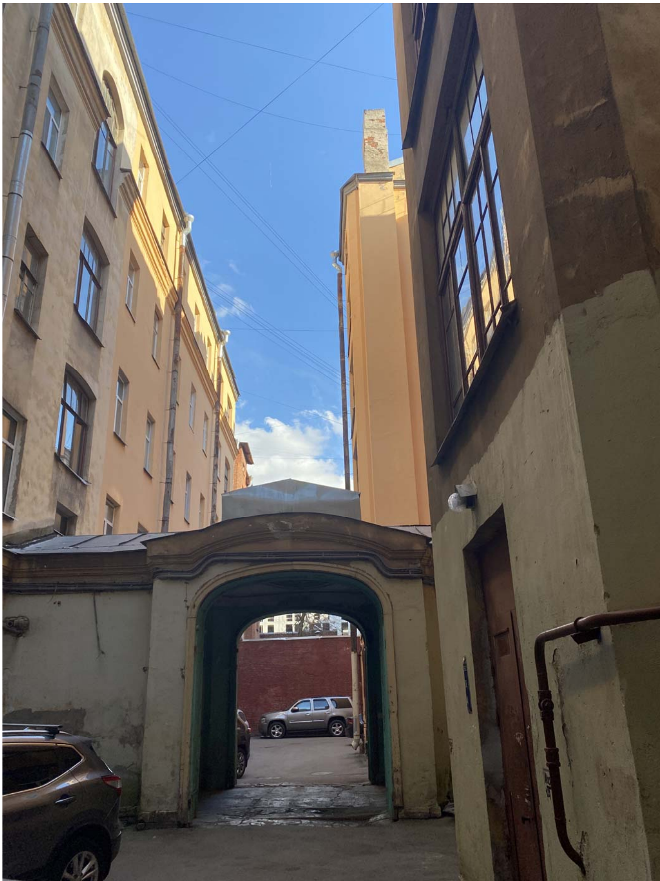
8. Переход от лицевого корпуса в дворовый.
