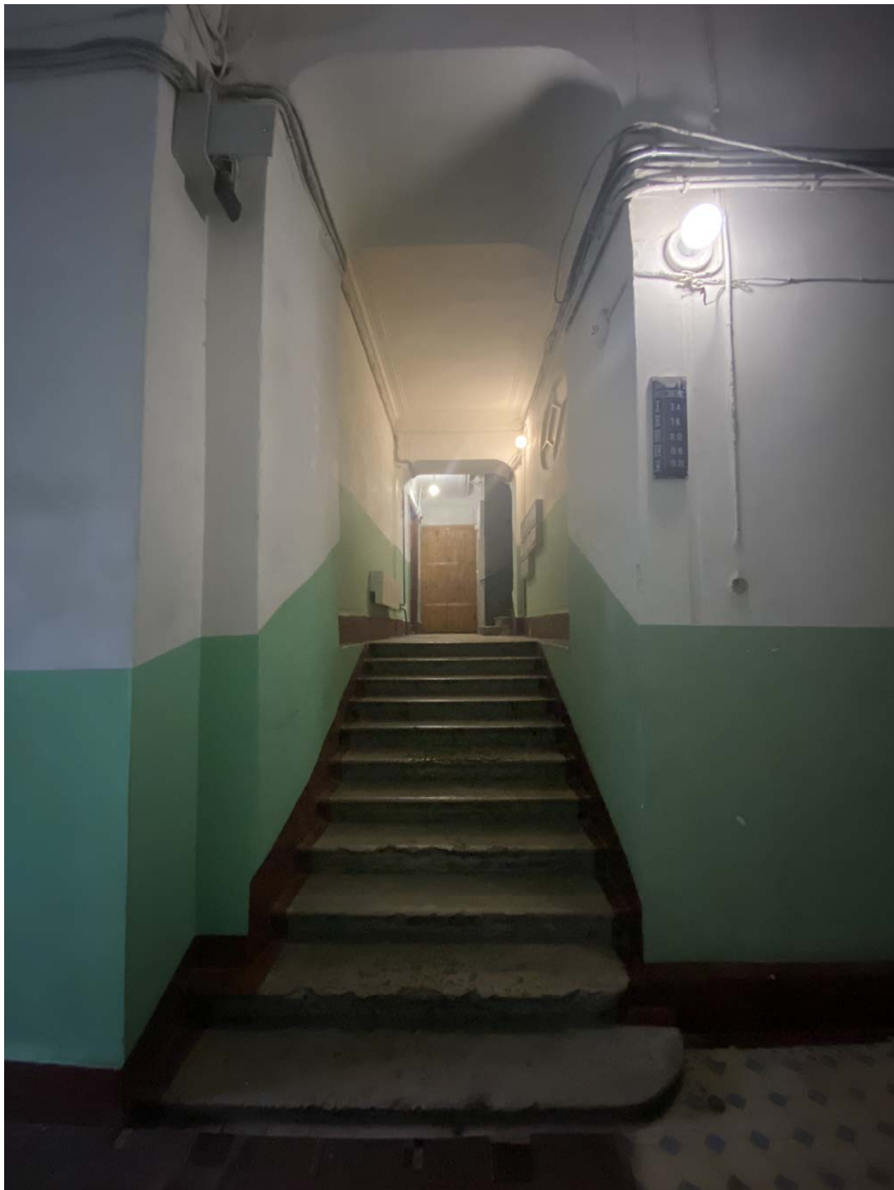
30.Средистенная лестница, вестибюль ЛК2
