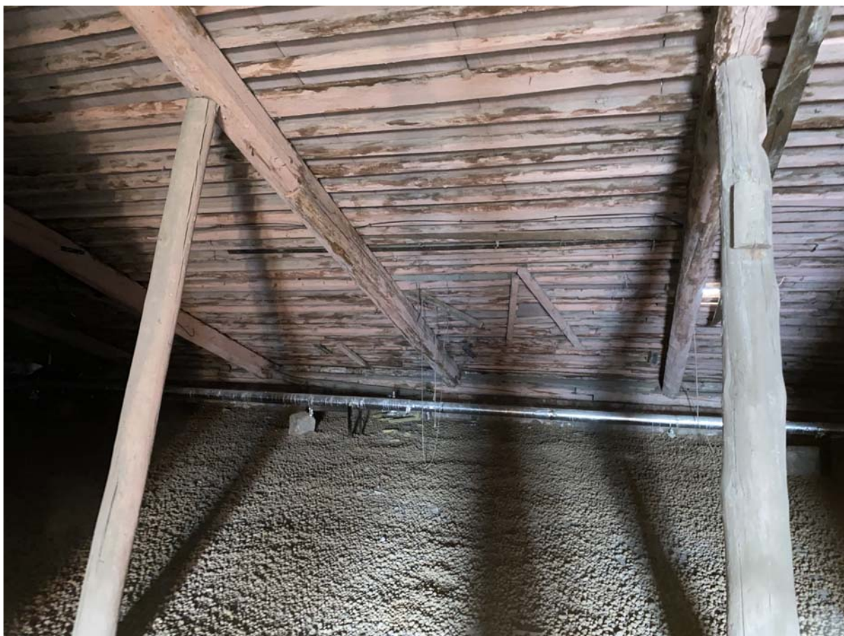
15. Стропильная система здания. Фрагмент.
