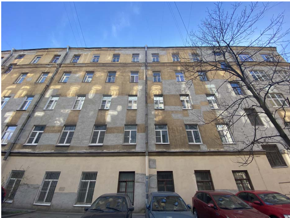
13. Фасад дворового корпуса.
