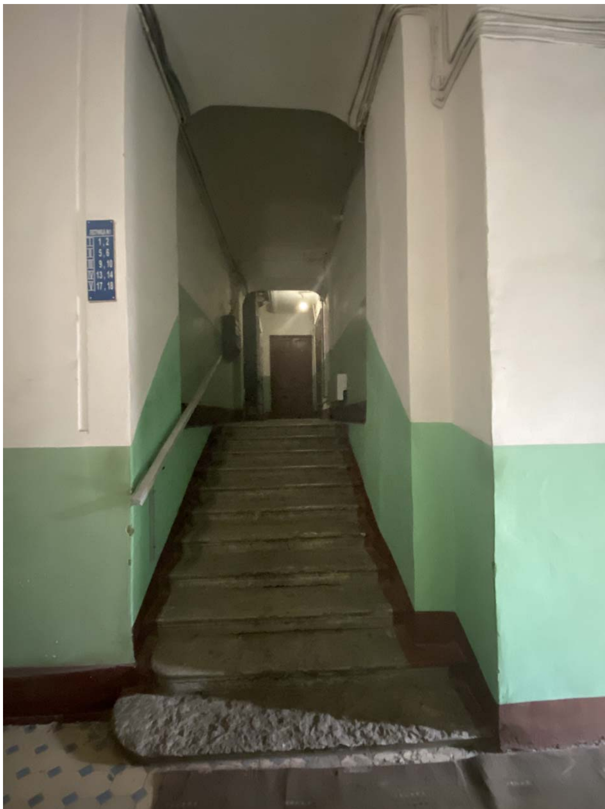
25. Средистенная лестница, вестибюль ЛК1
