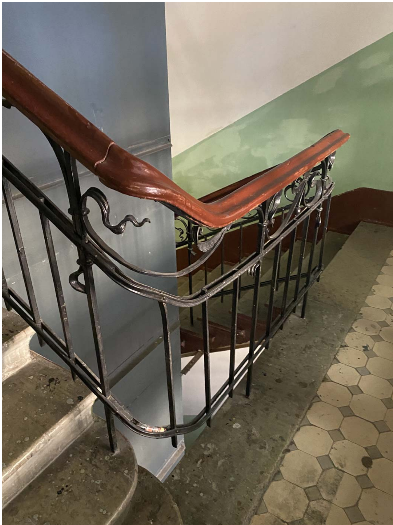
28. Междуэтажная площадка ЛК 1
