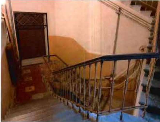
26-27. Лестничная клетка 2ЛК (17.11.2021).
