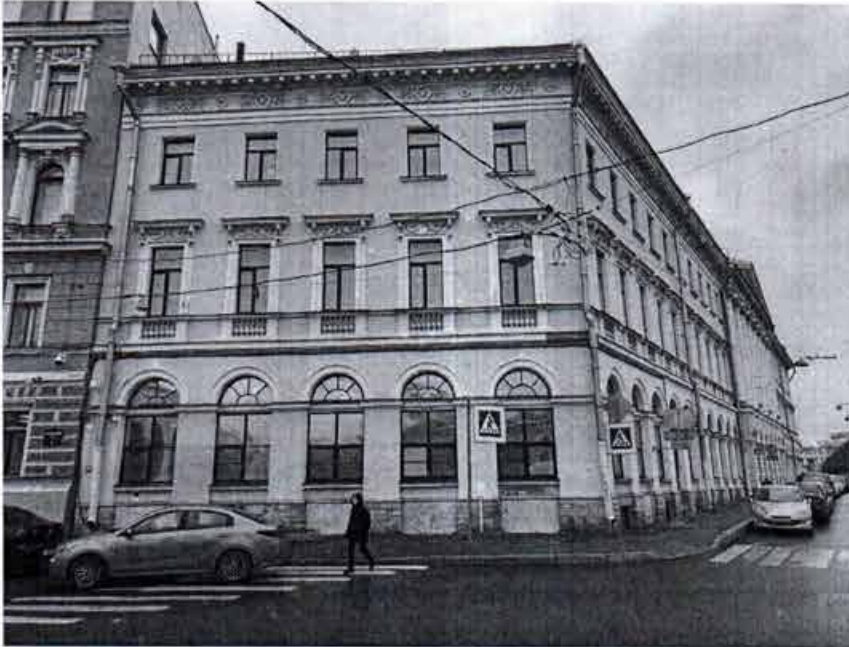
10. Западный лицевой фасад по Аптекарскому переулку (17.11.2021).
