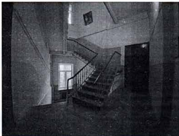
67-68. Лестничная клетка 2ЛК (17.11.2021).
