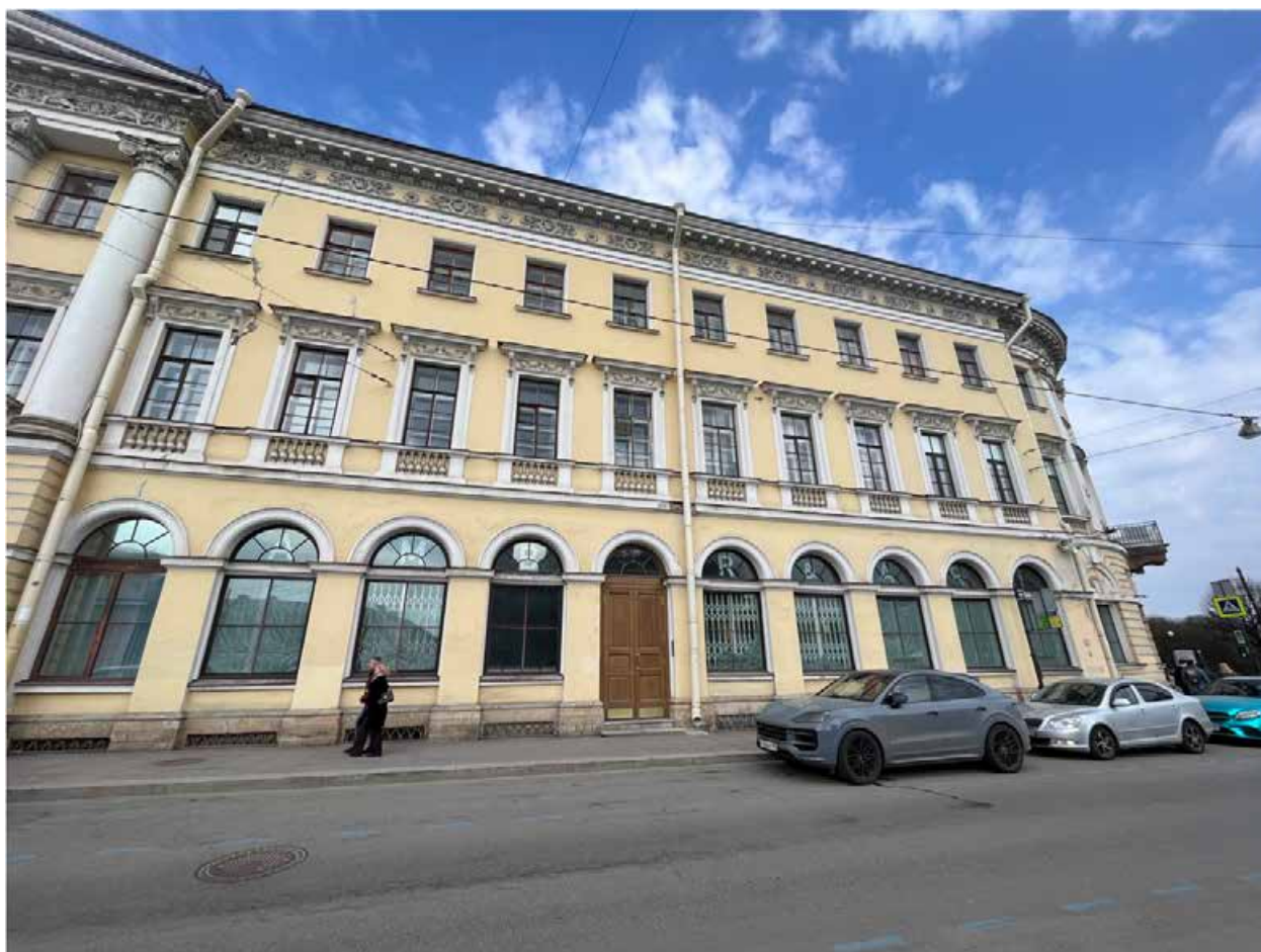
Фото №2. Юго-западный лицевой фасад.
