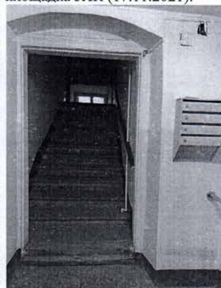
72. Промежуточная площадка 3ЛК (17.11.2021).
