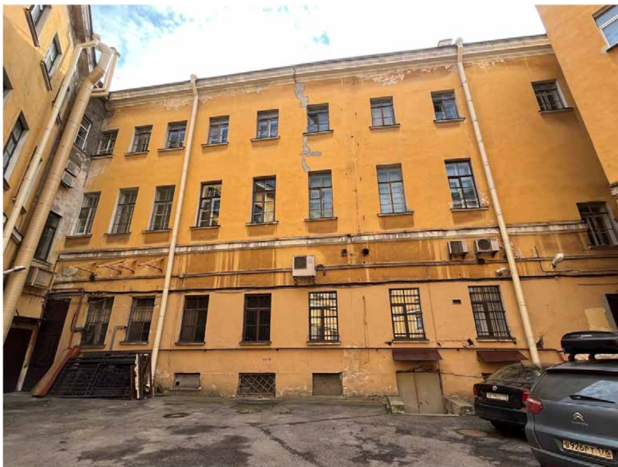
Фото №6. Северо-восточный дворовый фасад.
