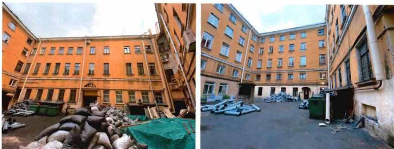
11-12. Общий вид на западный двор (17.11.2021).
