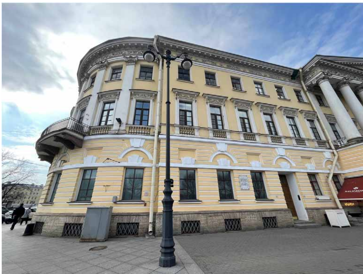
Фото №3. Северо-восточный лицевой фасад.
