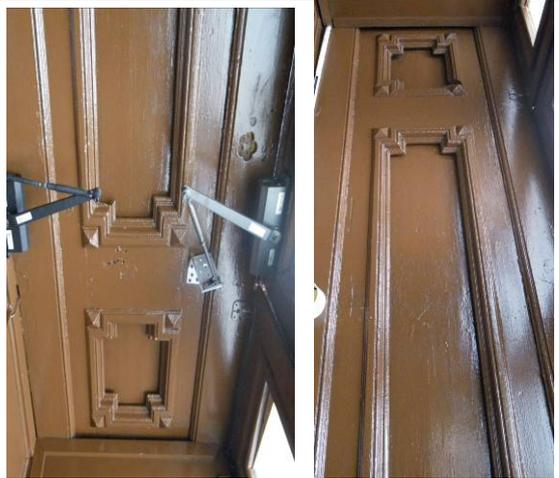
заполнение дверного проема – конструкция (двустворчатое, глухое, с двумя нестворными частями, с прямоугольной остекленной фрамугой), материал (дерево), оформление (профилированные филенки, заклепки), цвет (темно-коричневый);
