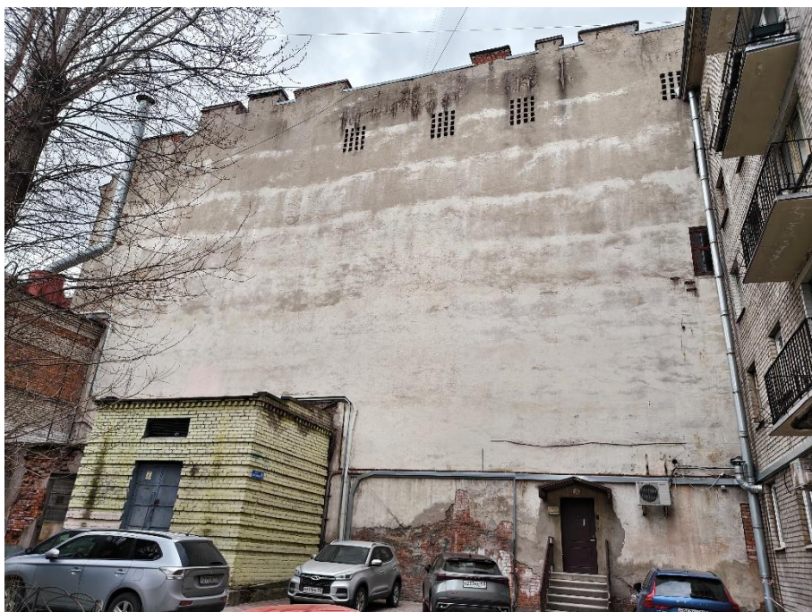
51. «Дом С. Д. Катеринич», пр. Добролюбова, д.3, литера А. Дворовый фасад. Фрагмент. Фото 01.04.2025г.
