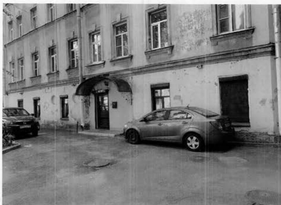
11. Фрагмент дворового фасада и территории объекта культурного наследия с восточной стороны. Дополнительное оборудование. Дефекты (фото от 06.06.2024)
