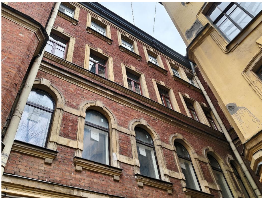
49. «Дом С. Д. Катеринич», пр. Добролюбова, д.3, литера А. Дворовый фасад. Фрагмент. Фото 01.04.2025г.
