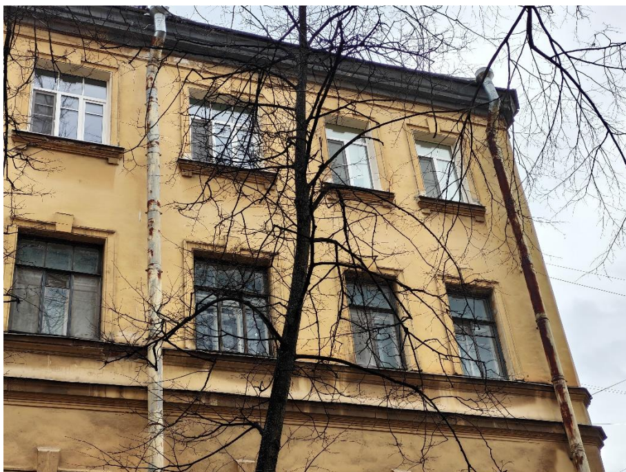
39. «Дом С. Д. Катеринич», пр. Добролюбова, д.3, литера А. Дворовый фасад. Фрагмент. Фото 01.04.2025г.
