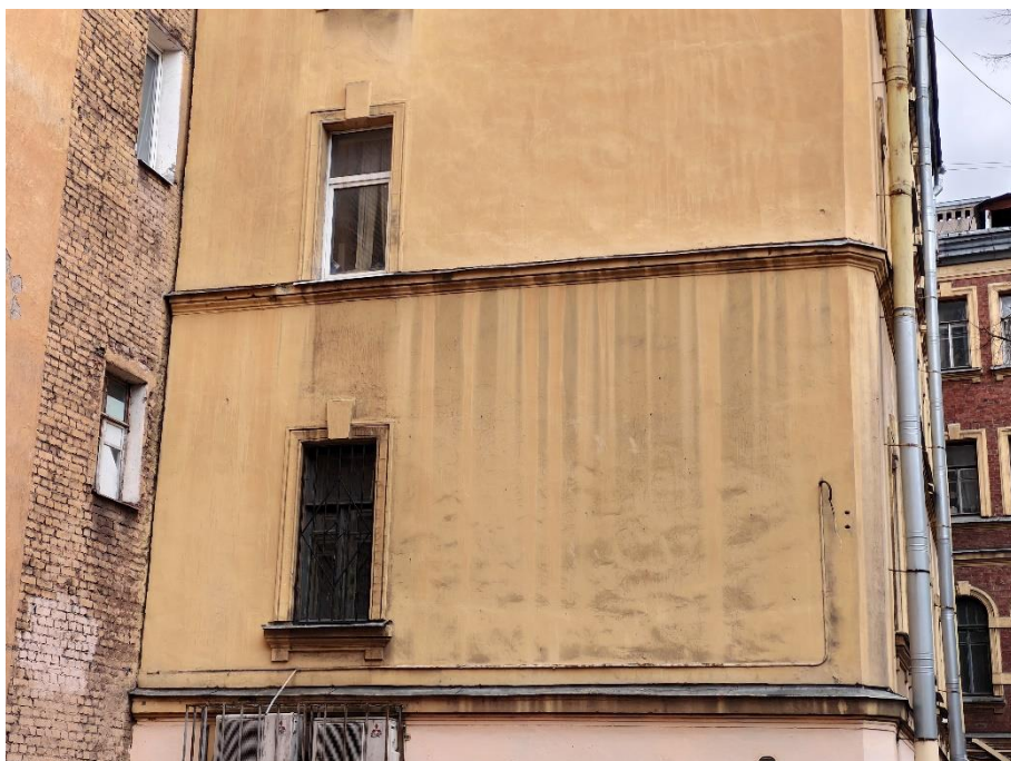
21. «Дом С. Д. Катеринич», пр. Добролюбова, д.3, литера А. Дворовый фасад. Фрагмент. Фото 01.04.2025г.
