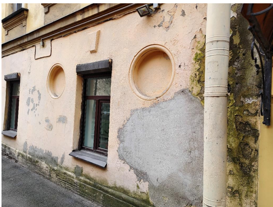
32. «Дом С. Д. Катеринич», пр. Добролюбова, д.3, литера А. Дворовый фасад. Фрагмент. Фото 01.04.2025г.
