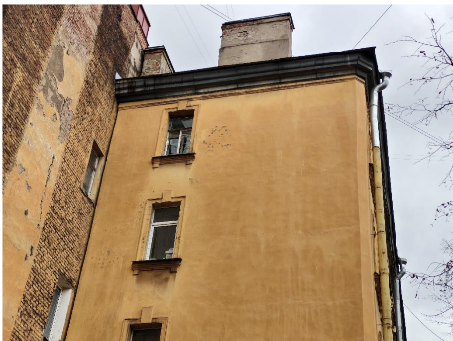
20. «Дом С. Д. Катеринич», пр. Добролюбова, д.3, литера А. Дворовый фасад. Фрагмент. Фото 01.04.2025г.
