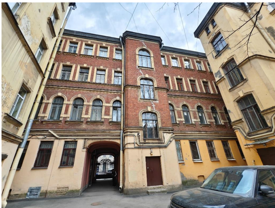
41. «Дом С. Д. Катеринич», пр. Добролюбова, д.3, литера А. Дворовый фасад. Фрагмент. Фото 01.04.2025г.
