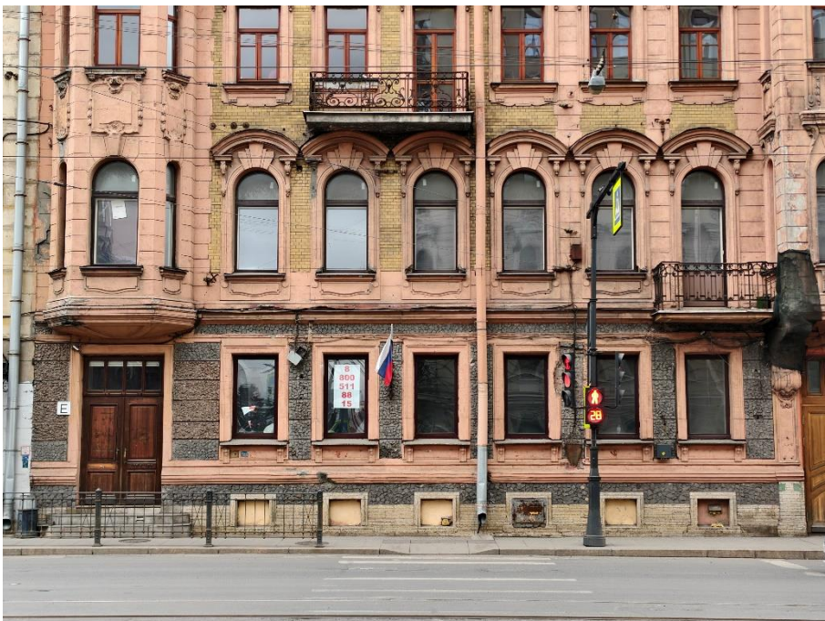
4. «Дом С. Д. Катеринич», пр. Добролюбова, д.3, литера А. Южный фасад. Фрагмент. Фото 01.04.2025г.
