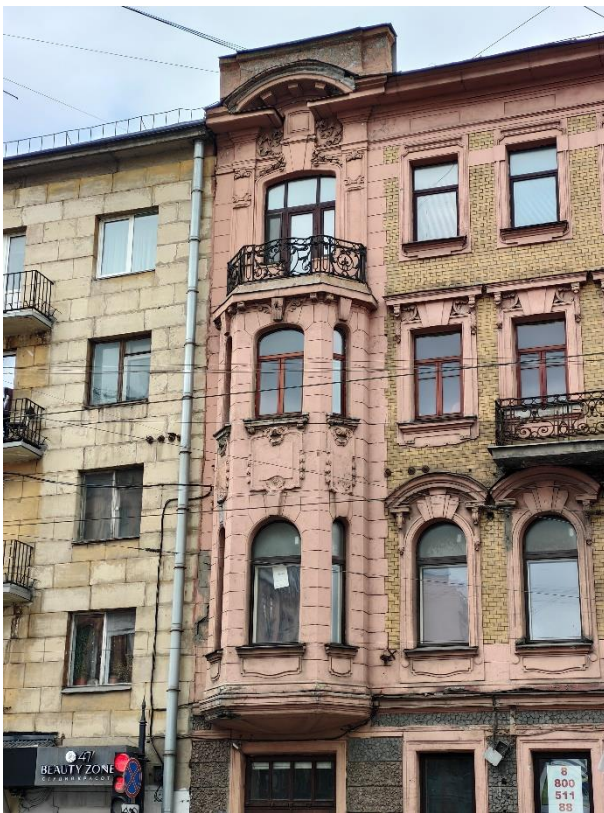
14. «Дом С. Д. Катеринич», пр. Добролюбова, д.3, литера А. Южный фасад. Фрагмент. Фото 01.04.2025г.
