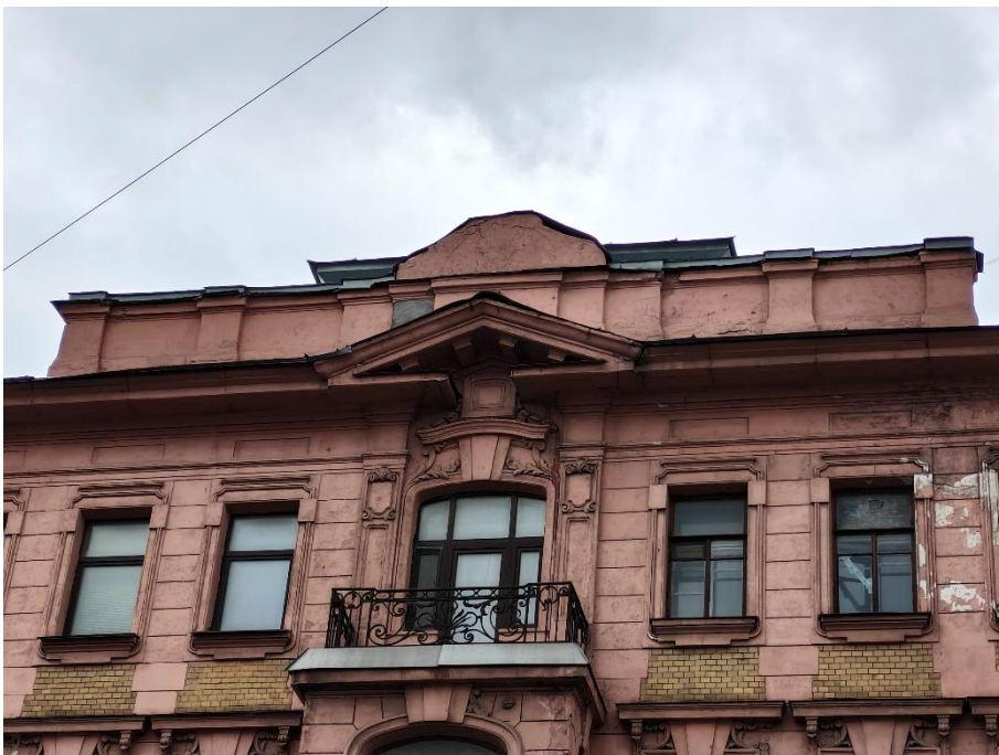
7. «Дом С. Д. Катеринич», пр. Добролюбова, д.3, литера А. Южный фасад. Фрагмент. Фото 01.04.2025г.
