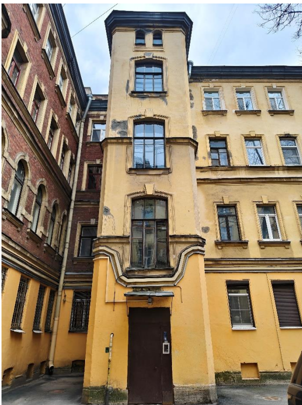
34. «Дом С. Д. Катеринич», пр. Добролюбова, д.3, литера А. Дворовый фасад. Фрагмент. Фото 01.04.2025г.
