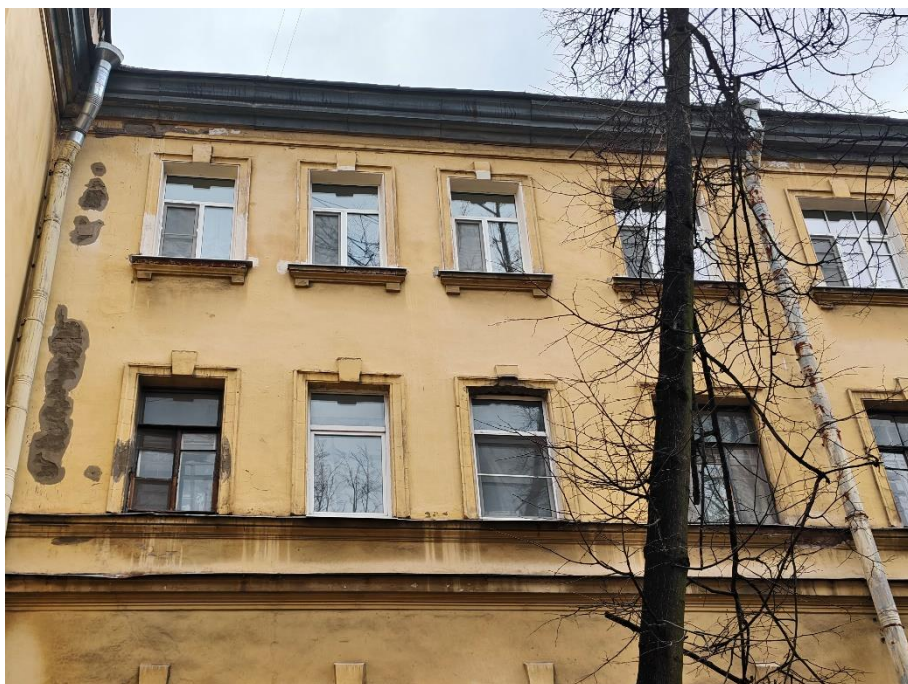
37. «Дом С. Д. Катеринич», пр. Добролюбова, д.3, литера А. Дворовый фасад. Фрагмент. Фото 01.04.2025г.
