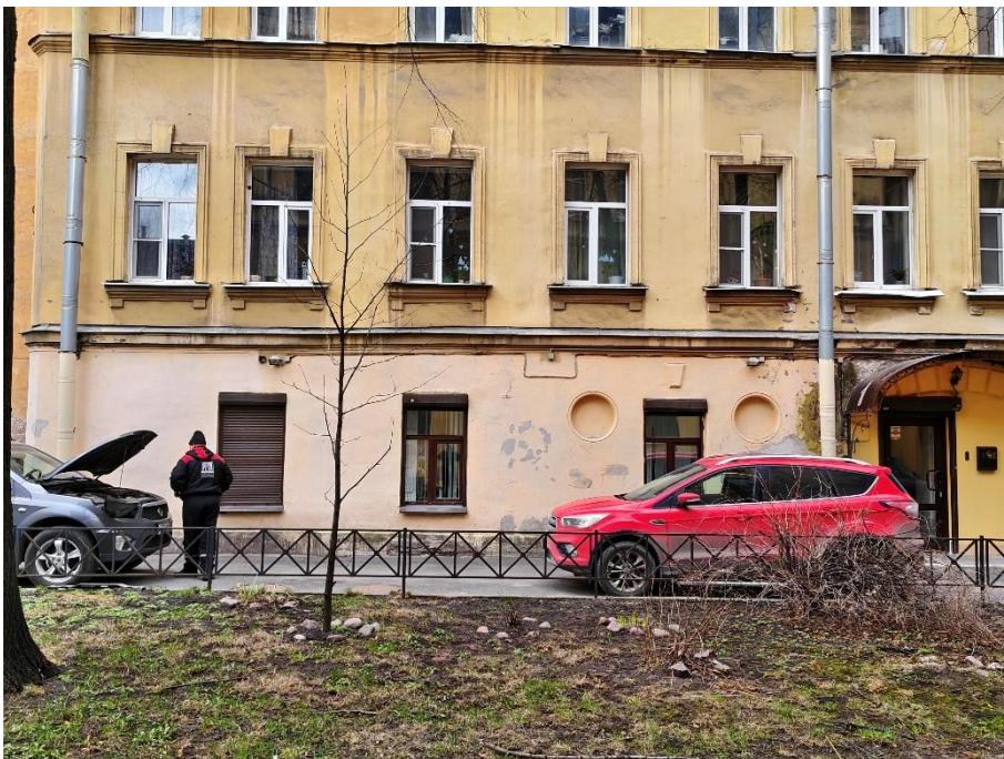
29. «Дом С. Д. Катеринич», пр. Добролюбова, д.3, литера А. Дворовый фасад. Фрагмент. Фото 01.04.2025г.
