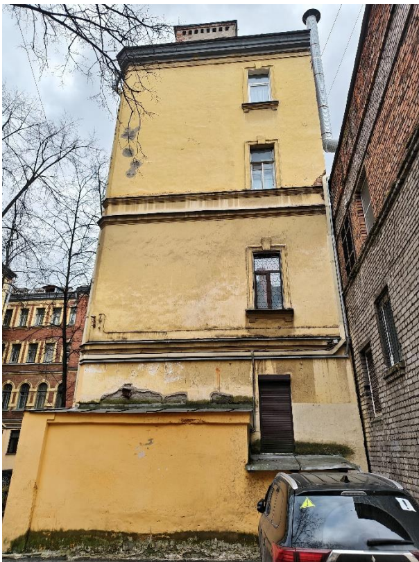
23. «Дом С. Д. Катеринич», пр. Добролюбова, д.3, литера А. Дворовый фасад. Фрагмент. Фото 01.04.2025г.
