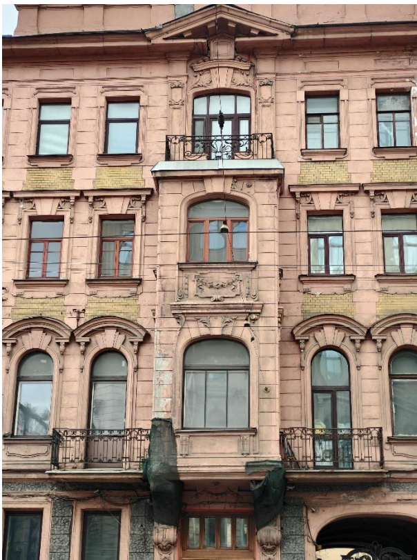
13. «Дом С. Д. Катеринич», пр. Добролюбова, д.3, литера А. Южный фасад. Фрагмент. Фото 01.04.2025г.
