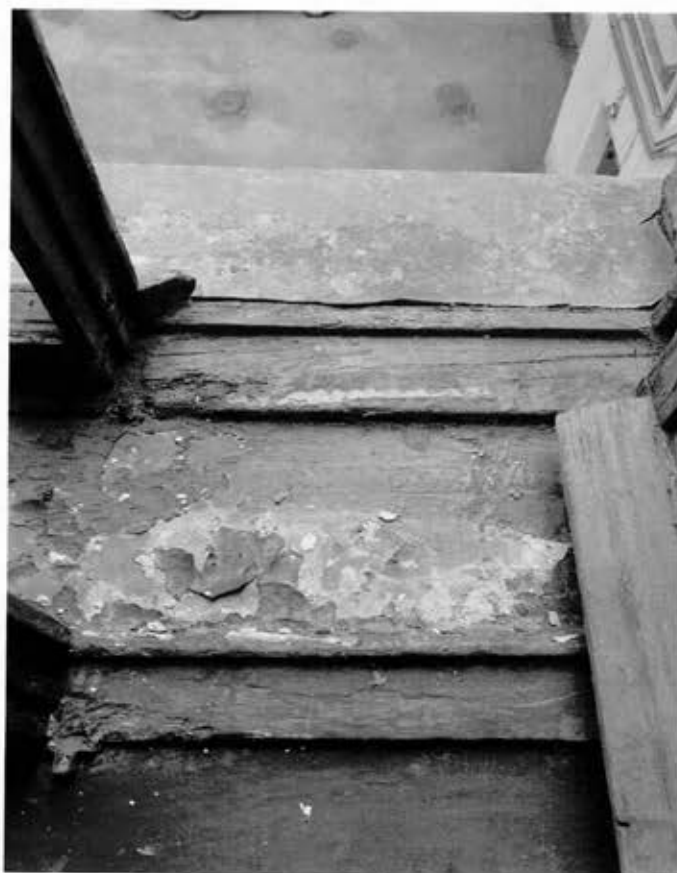
37. Интерьеры. Окна на лестнице 3ЛК (фото от 06.06.2024)
