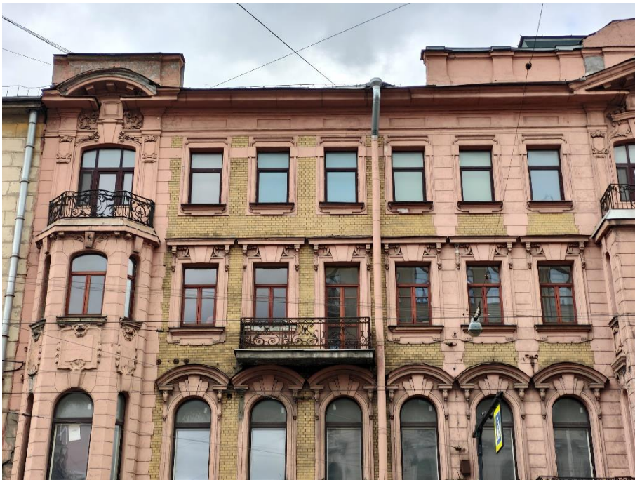
3. «Дом С. Д. Катеринич», пр. Добролюбова, д.3, литера А. Южный фасад. Фрагмент. Фото 01.04.2025г.
