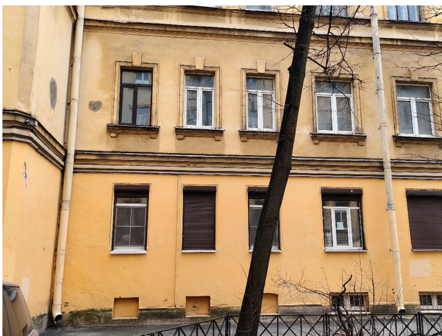
38. «Дом С. Д. Катеринич», пр. Добролюбова, д.3, литера А. Дворовый фасад. Фрагмент. Фото 01.04.2025г.
