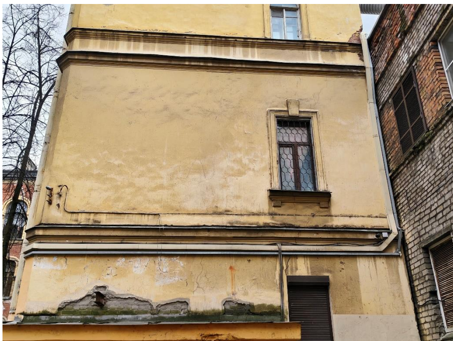
25. «Дом С. Д. Катеринич», пр. Добролюбова, д.3, литера А. Дворовый фасад. Фрагмент. Фото 01.04.2025г.
