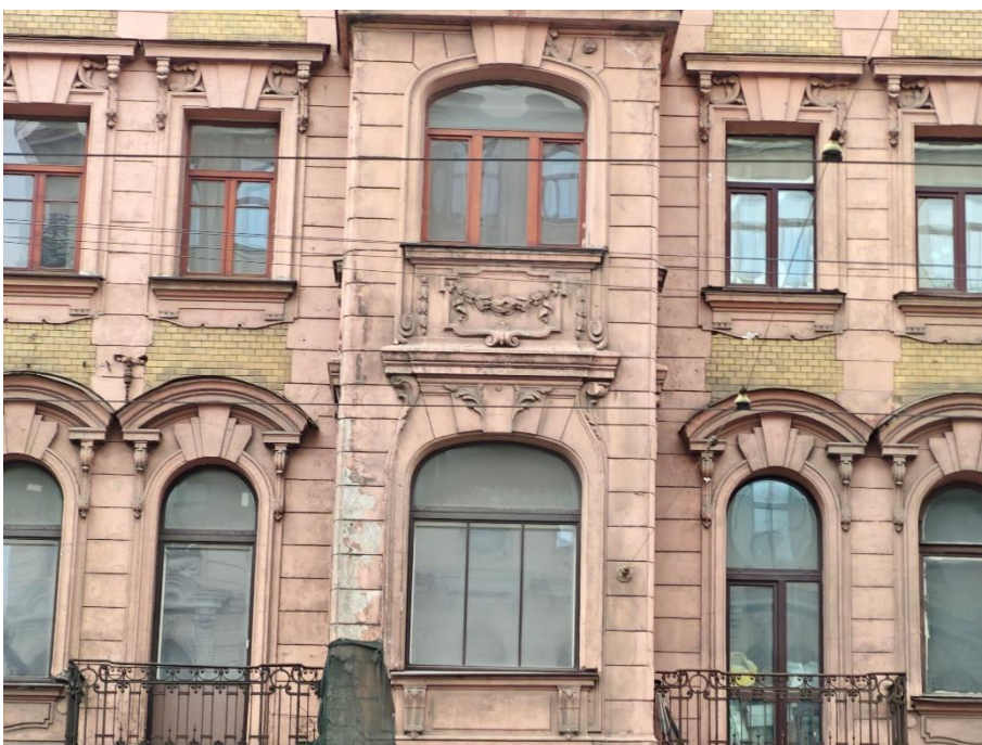
8. «Дом С. Д. Катеринич», пр. Добролюбова, д.3, литера А. Южный фасад. Фрагмент. Фото 01.04.2025г.
