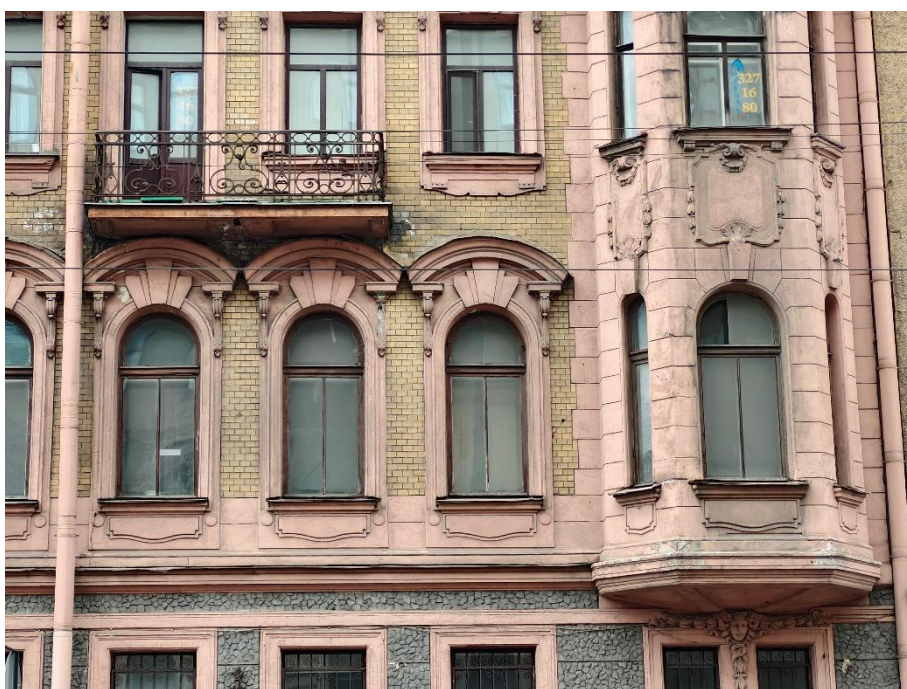
10. «Дом С. Д. Катеринич», пр. Добролюбова, д.3, литера А. Южный фасад. Фрагмент. Фото 01.04.2025г.
