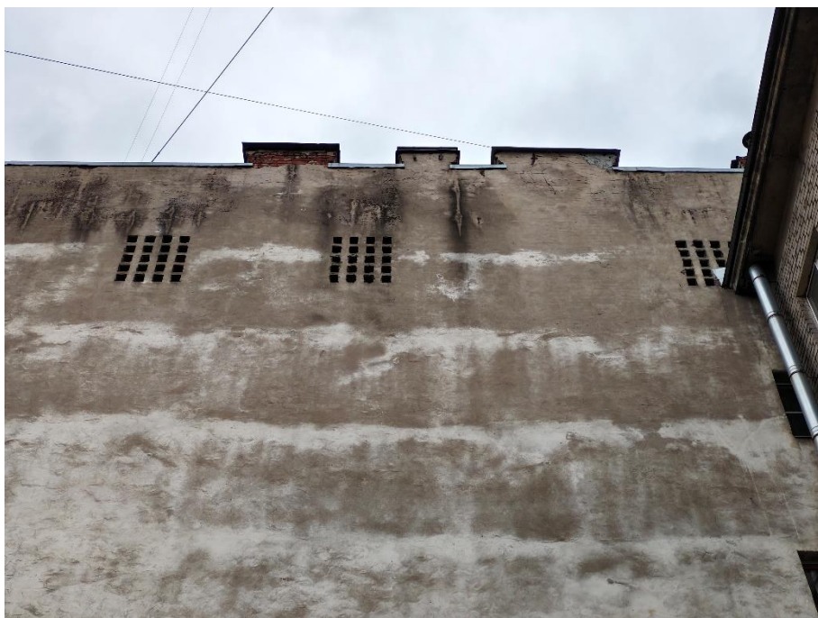
53. «Дом С. Д. Катеринич», пр. Добролюбова, д.3, литера А. Дворовый фасад. Фрагмент. Фото 01.04.2025г.
