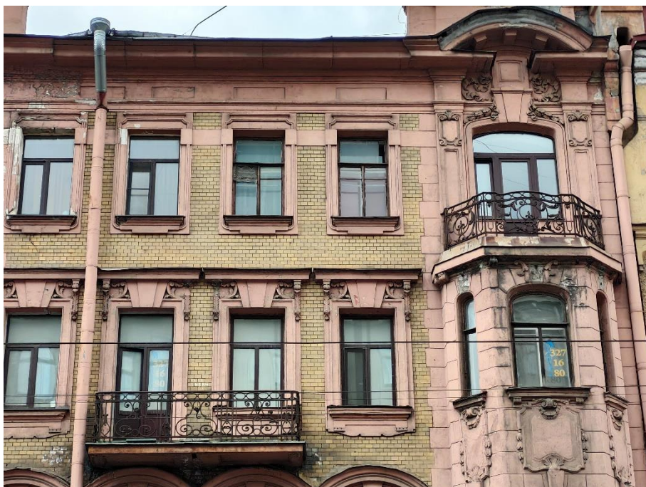
9. «Дом С. Д. Катеринич», пр. Добролюбова, д.3, литера А. Южный фасад. Фрагмент. Фото 01.04.2025г.
