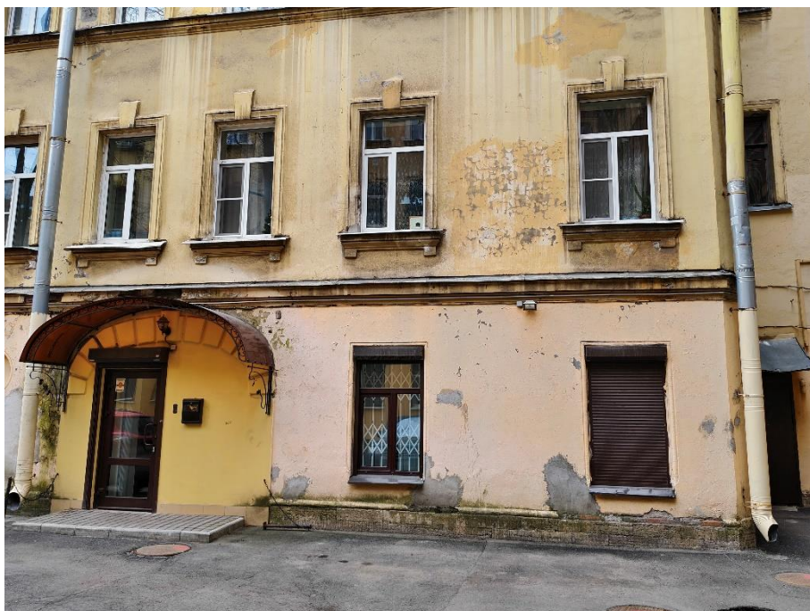
31. «Дом С. Д. Катеринич», пр. Добролюбова, д.3, литера А. Дворовый фасад. Фрагмент. Фото 01.04.2025г.
