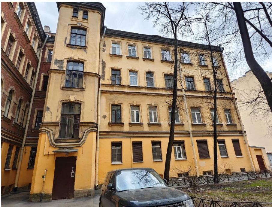
33. «Дом С. Д. Катеринич», пр. Добролюбова, д.3, литера А. Дворовый фасад. Фрагмент. Фото 01.04.2025г.
