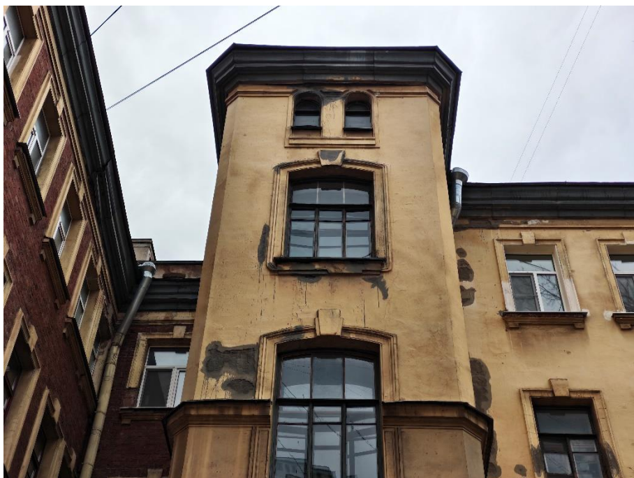
35. «Дом С. Д. Катеринич», пр. Добролюбова, д.3, литера А. Дворовый фасад. Фрагмент. Фото 01.04.2025г.
