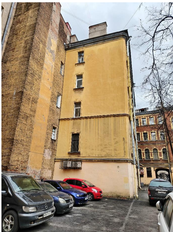
19. «Дом С. Д. Катеринич», пр. Добролюбова, д.3, литера А. Дворовый фасад. Фрагмент. Фото 01.04.2025г.
