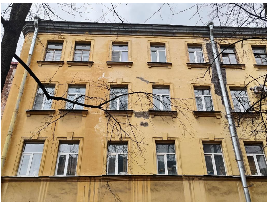
28. «Дом С. Д. Катеринич», пр. Добролюбова, д.3, литера А. Дворовый фасад. Фрагмент. Фото 01.04.2025г.
