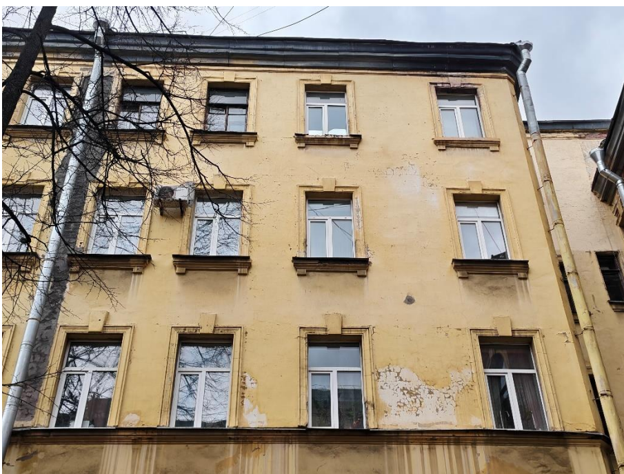
30. «Дом С. Д. Катеринич», пр. Добролюбова, д.3, литера А. Дворовый фасад. Фрагмент. Фото 01.04.2025г.
