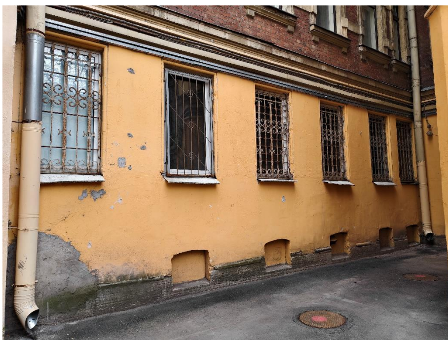
50. «Дом С. Д. Катеринич», пр. Добролюбова, д.3, литера А. Дворовый фасад. Фрагмент. Фото 01.04.2025г.
