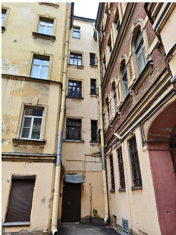
43. «Дом С. Д. Катеринич», пр. Добролюбова, д.3, литера А. Дворовый фасад. Фрагмент. Фото 01.04.2025г.
