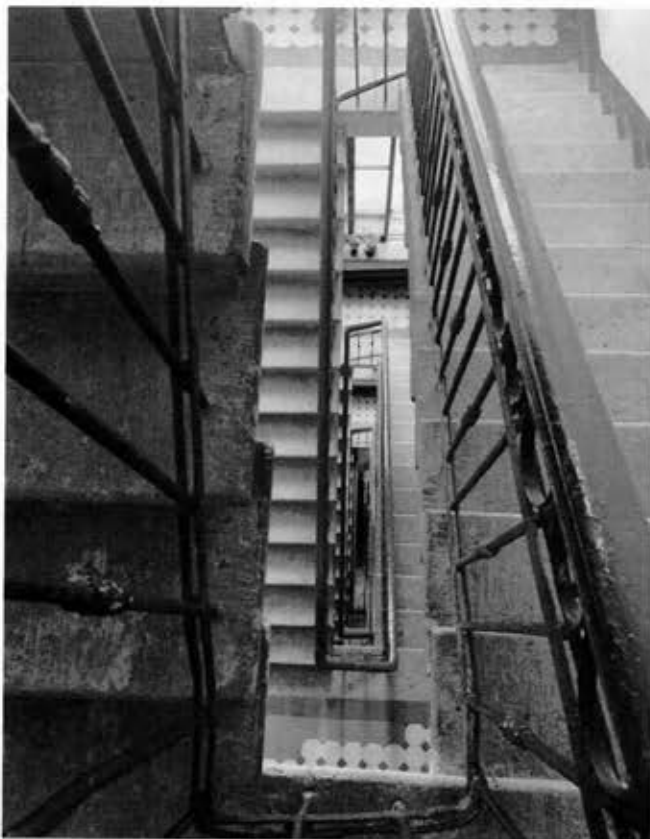
36. Интерьеры. Лестница 3ЛК (фото от 06.06.2024)
