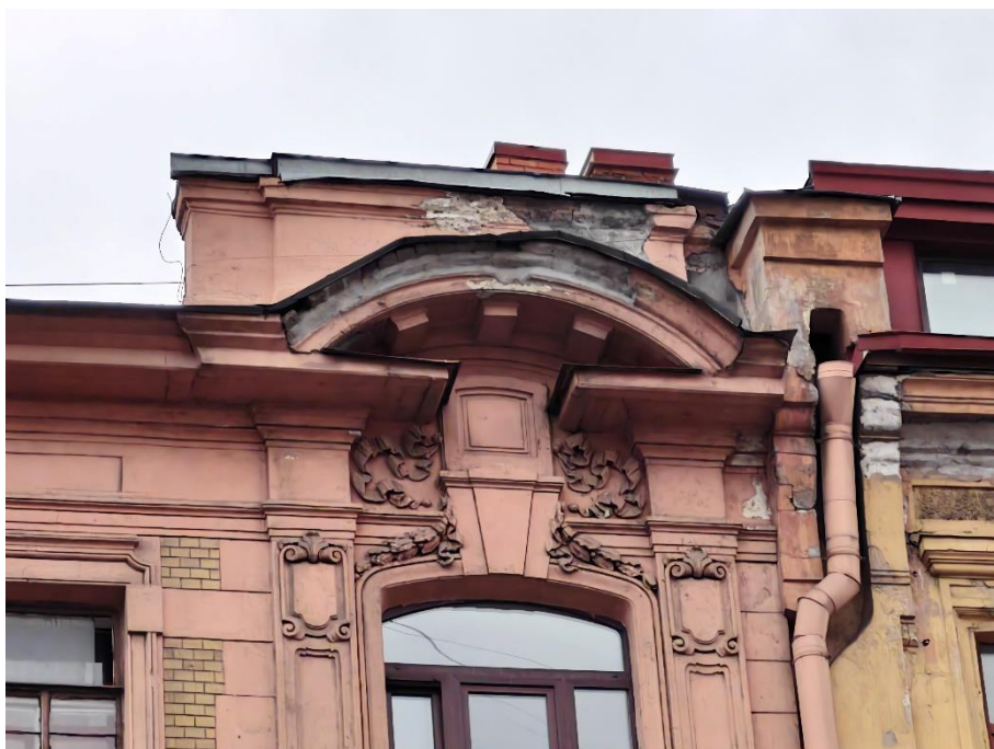
11. «Дом С. Д. Катеринич», пр. Добролюбова, д.3, литера А. Южный фасад. Фрагмент. Фото 01.04.2025г.
