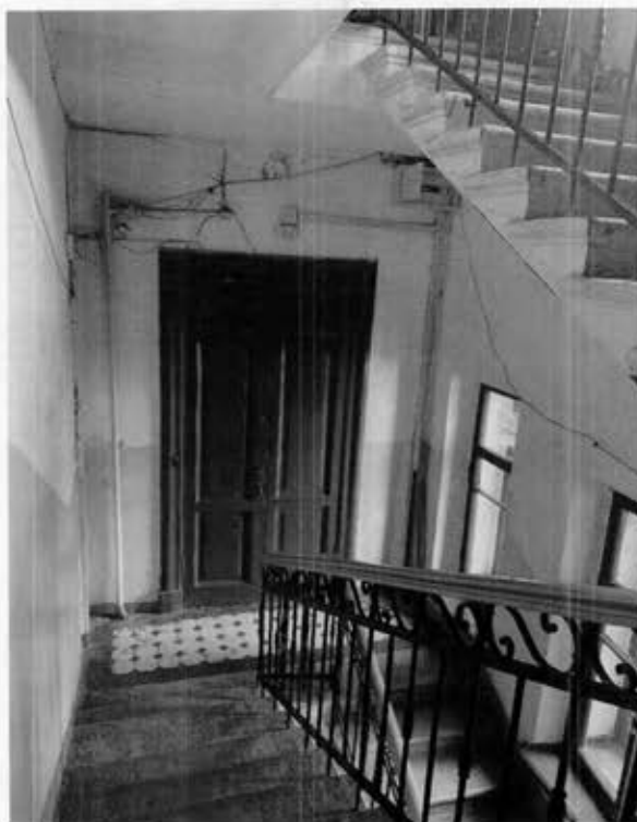
30. Интерьеры. Лестница 2ЛК. (фото от 06.06.2024)
