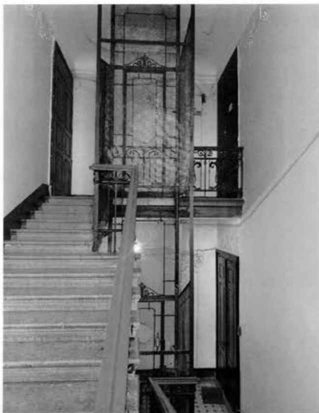
25. Интерьеры. Лестница 1ЛК (фото от 06.06.2024)
