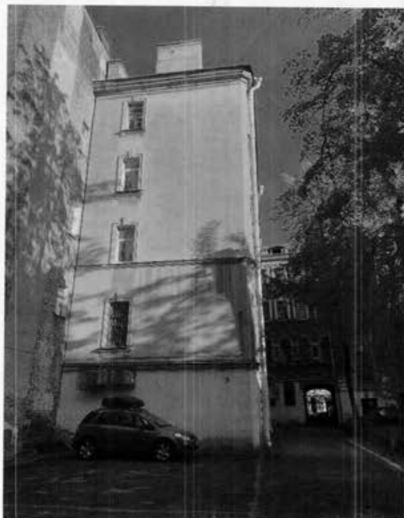
10. Фрагмент дворового фасада и территории объекта культурного наследия с северо-восточной стороны. Дополнительное оборудование (фото от 23.05.2024)
