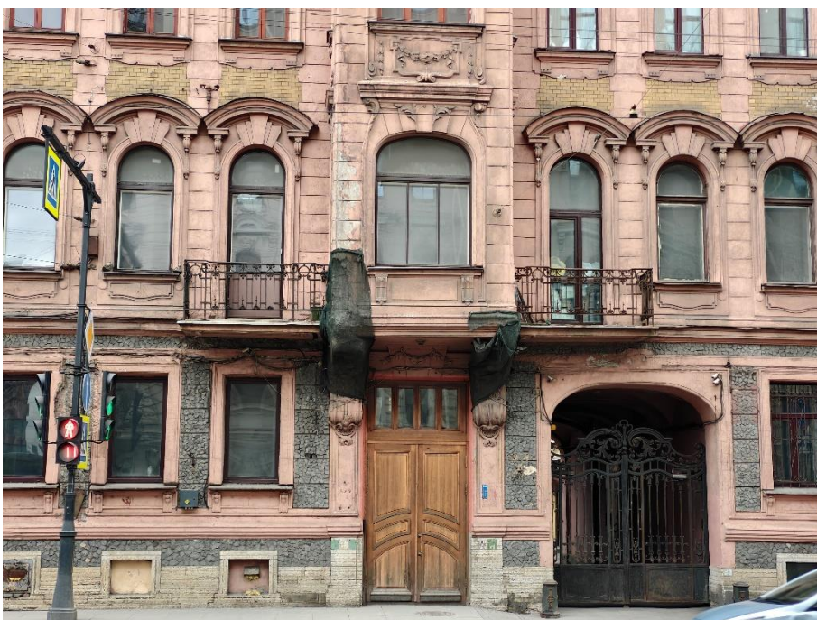
6. «Дом С. Д. Катеринич», пр. Добролюбова, д.3, литера А. Южный фасад. Фрагмент. Фото 01.04.2025г.
