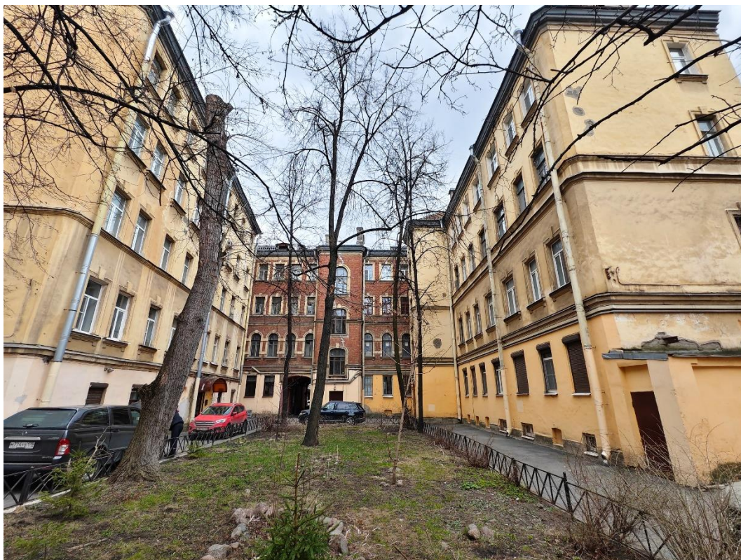
2. «Дом С. Д. Катеринич», пр. Добролюбова, д.3, литера А. Дворовый фасад. Общий вид. Фото 01.04.2025г.
