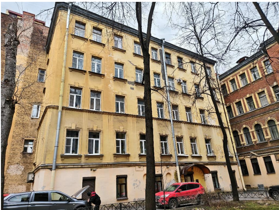
27. «Дом С. Д. Катеринич», пр. Добролюбова, д.3, литера А. Дворовый фасад. Фрагмент. Фото 01.04.2025г.
