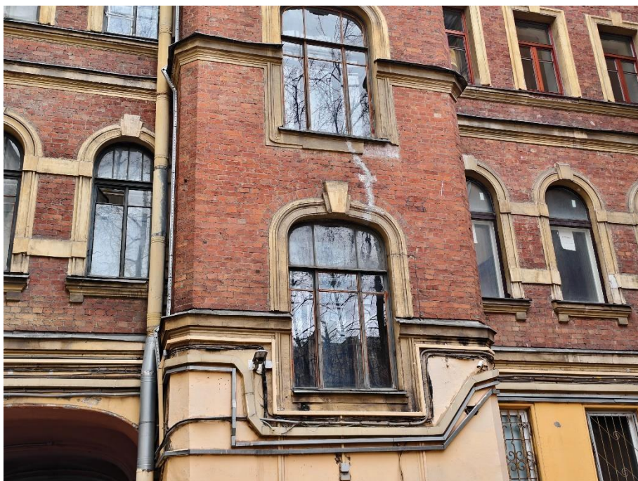
45. «Дом С. Д. Катеринич», пр. Добролюбова, д.3, литера А. Дворовый фасад. Фрагмент. Фото 01.04.2025г.
