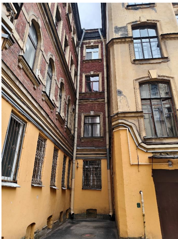
42. «Дом С. Д. Катеринич», пр. Добролюбова, д.3, литера А. Дворовый фасад. Фрагмент. Фото 01.04.2025г.
