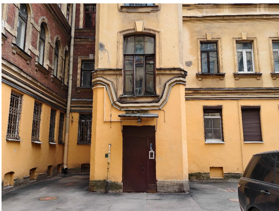
36. «Дом С. Д. Катеринич», пр. Добролюбова, д.3, литера А. Дворовый фасад. Фрагмент. Фото 01.04.2025г.
