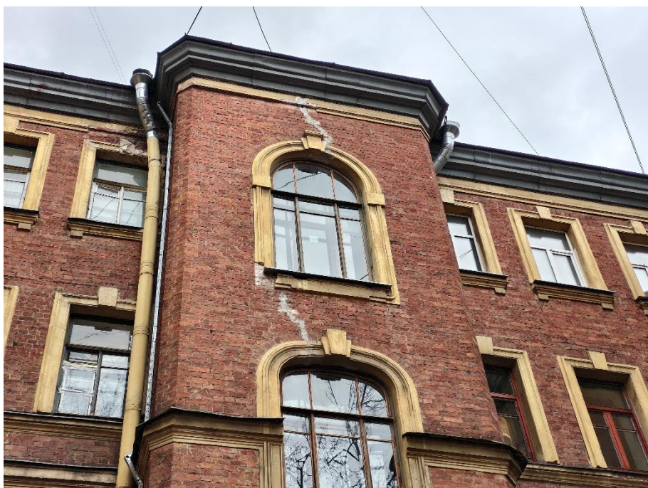
44. «Дом С. Д. Катеринич», пр. Добролюбова, д.3, литера А. Дворовый фасад. Фрагмент. Фото 01.04.2025г.
