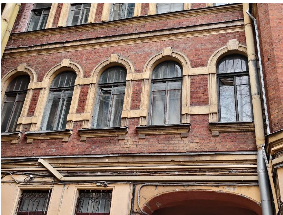
48. «Дом С. Д. Катеринич», пр. Добролюбова, д.3, литера А. Дворовый фасад. Фрагмент. Фото 01.04.2025г.
