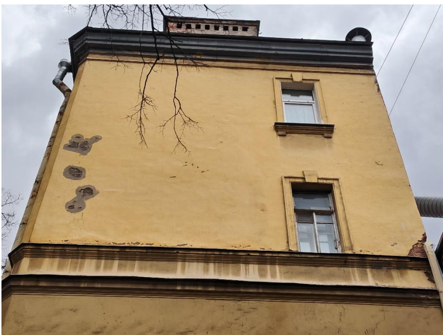
24. «Дом С. Д. Катеринич», пр. Добролюбова, д.3, литера А. Дворовый фасад. Фрагмент. Фото 01.04.2025г.
