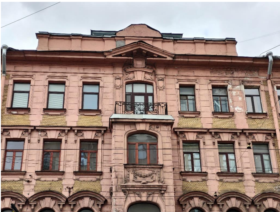
5. «Дом С. Д. Катеринич», пр. Добролюбова, д.3, литера А. Южный фасад. Фрагмент. Фото 01.04.2025г.
