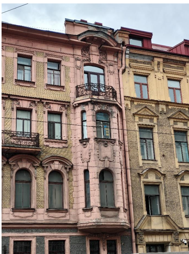
12. «Дом С. Д. Катеринич», пр. Добролюбова, д.3, литера А. Южный фасад. Фрагмент. Фото 01.04.2025г.
