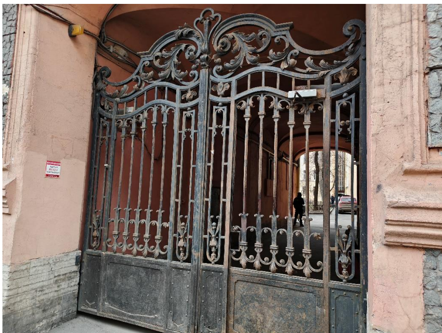
15. «Дом С. Д. Катеринич», пр. Добролюбова, д.3, литера А. Южный фасад. Фрагмент. Фото 01.04.2025г.
