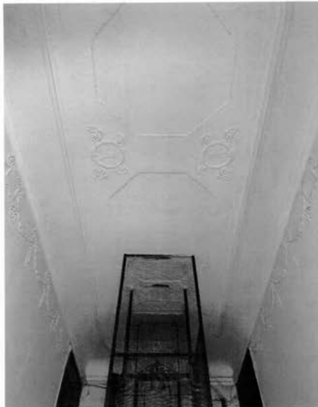
24. Интерьеры. Лестница 1ЛК (фото от 06.06.2024)
