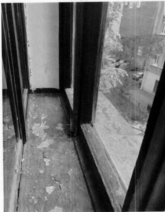
38. Интерьеры. Окна на лестнице 3ЛК (фото от 06.06.2024)
