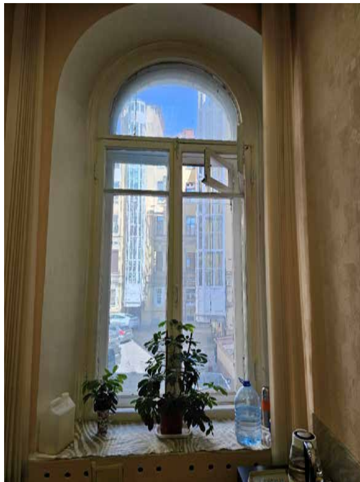
35. Объект культурного наследия федерального значения «Усадьба Демидовых» по адресу: г. Санкт-Петербург, пер. Гривцова, д. 1/64, лит. А, д. 5, лит. А. Главный дом. Заполнение оконного проема в пом. (21-Н) 58 в уровне 2-го этажа (2(Г)-13).
