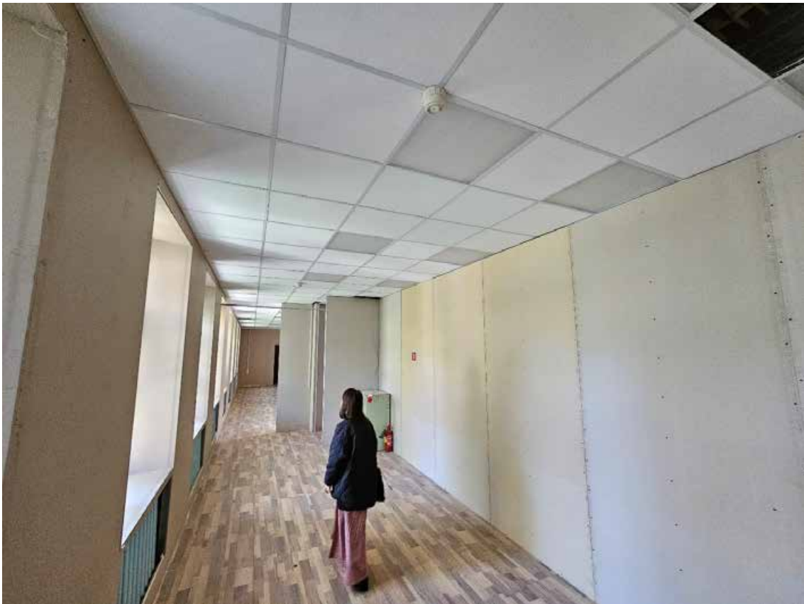
97. Объект культурного наследия федерального значения «Усадьба Демидовых» по адресу: г. Санкт-Петербург, пер. Гривцова, д. 1/64, лит. А, д. 5, лит. А. Кегельбан. Общий вид пом. (21-Н) 11 в уровне 1-го этажа (1(К)-6).
