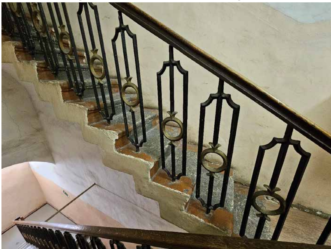
70. Объект культурного наследия федерального значения «Усадьба Демидовых» по адресу: г. Санкт-Петербург, пер. Гривцова, д. 1/64, лит. А, д. 5, лит. А. Главный дом. Фрагмент ограждения консольно-защемлённой лестницы ЛК-3 в пом. (21-Н) 107 в уровне 3-го этажа (З(Г)-36). В соответствии с Распоряжением КГИОП от 21.10.2024 г. № 1294-рп – лестница Л-3.
