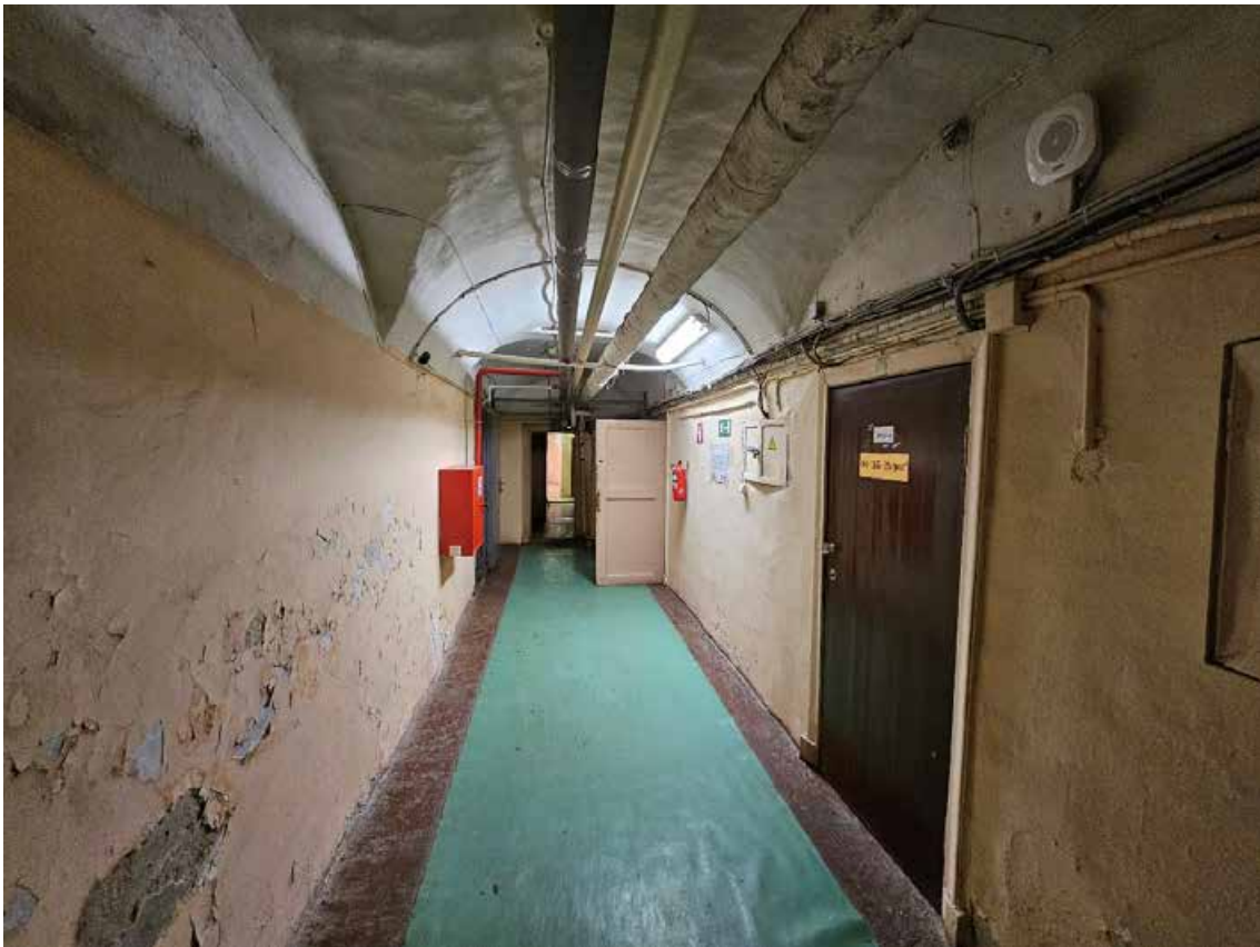
21. Объект культурного наследия федерального значения «Усадьба Демидовых» по адресу: г. Санкт-Петербург, пер. Гривцова, д. 1/64, лит. А, д. 5, лит. А. Главный дом. Общий вид пом. (2-Н) 15 в уровне 1-го этажа (1(Г)-37).
