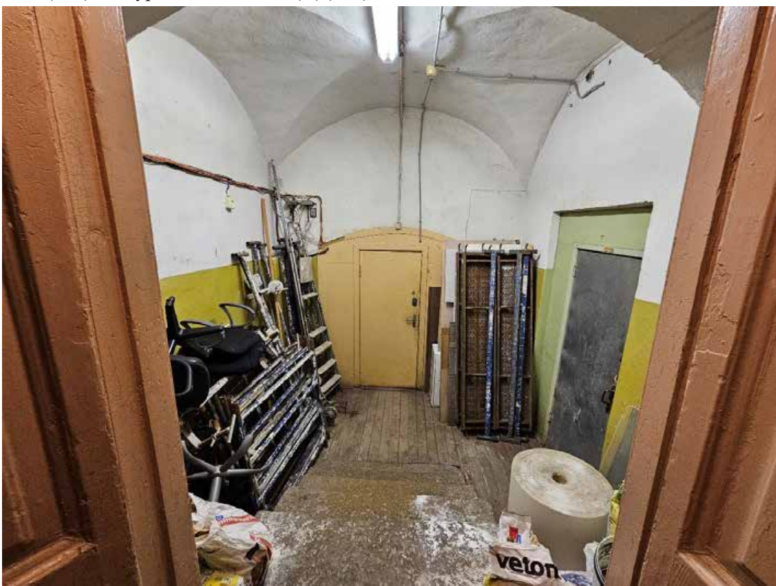
22. Объект культурного наследия федерального значения «Усадьба Демидовых» по адресу: г. Санкт-Петербург, пер. Гривцова, д. 1/64, лит. А, д. 5, лит. А. Главный дом. Общий вид одномаршевой лестницы ЛК-10 в пом. (2-Н) 22 в уровне 1-го этажа (1(Г)-49). В соответствии с Распоряжением КГИОП от 21.10.2024 г. № 1294-рп – лестница Л-4.
