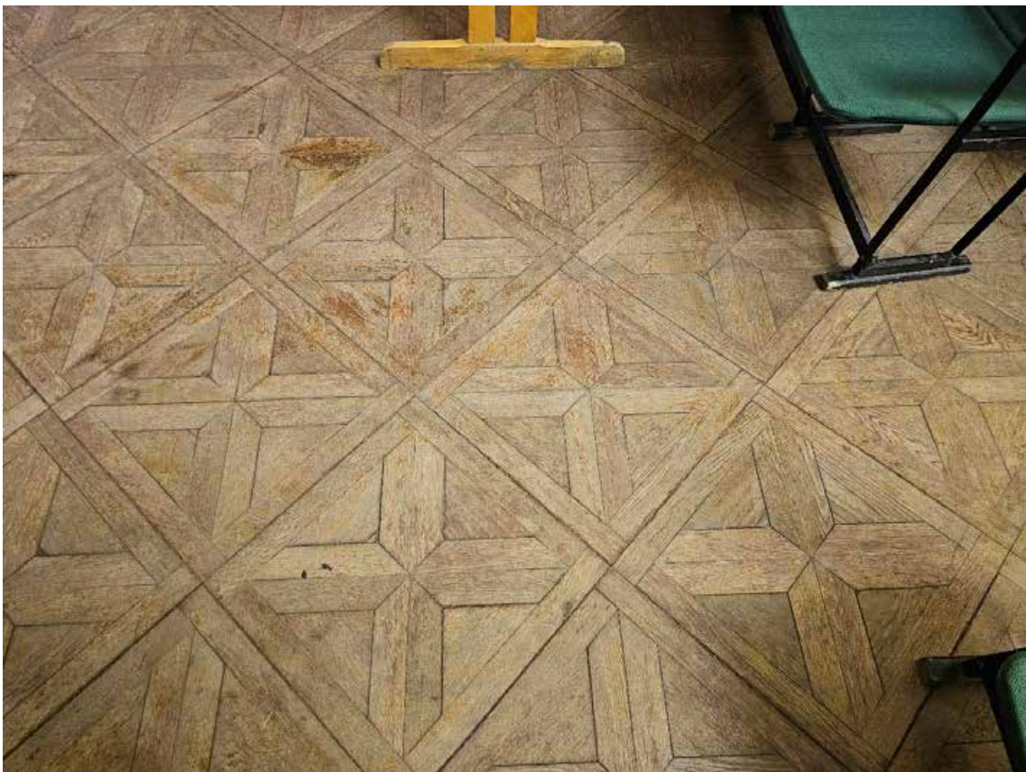
50. Объект культурного наследия федерального значения «Усадьба Демидовых» по адресу: г. Санкт-Петербург, пер. Гривцова, д. 1/64, лит. А, д. 5, лит. А. Главный дом. Фрагмент напольного покрытия (паркет) в пом. (21-Н) 50 в уровне 2-го этажа (2(Г)-23). Парадный зал.
