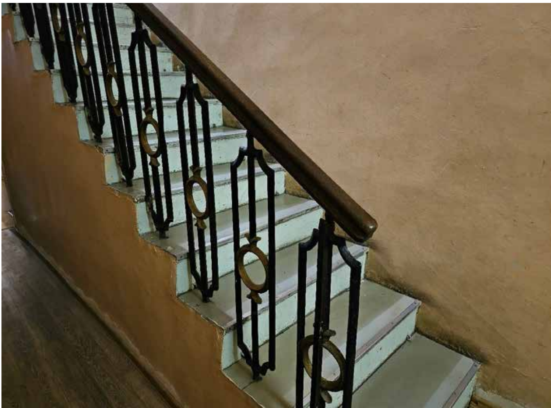
39. Объект культурного наследия федерального значения «Усадьба Демидовых» по адресу: г. Санкт-Петербург, пер. Гривцова, д. 1/64, лит. А, д. 5, лит. А. Главный дом. Фрагмент ограждения консольно-защемлённой лестницы ЛК-3 в пом. (21-Н) 35 в уровне 2-го этажа (2(Г)-18). В соответствии с Распоряжением КГИОП от 21.10.2024 г. № 1294-рп – лестница Л-3.
