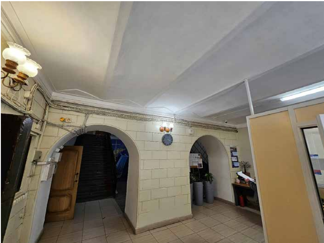
15. Объект культурного наследия федерального значения «Усадьба Демидовых» по адресу: г. Санкт-Петербург, пер. Гривцова, д. 1/64, лит. А, д. 5, лит. А. Главный дом. Общий вид пом. (10ЛК) 5 в уровне 1-го этажа (1Г)-5).
