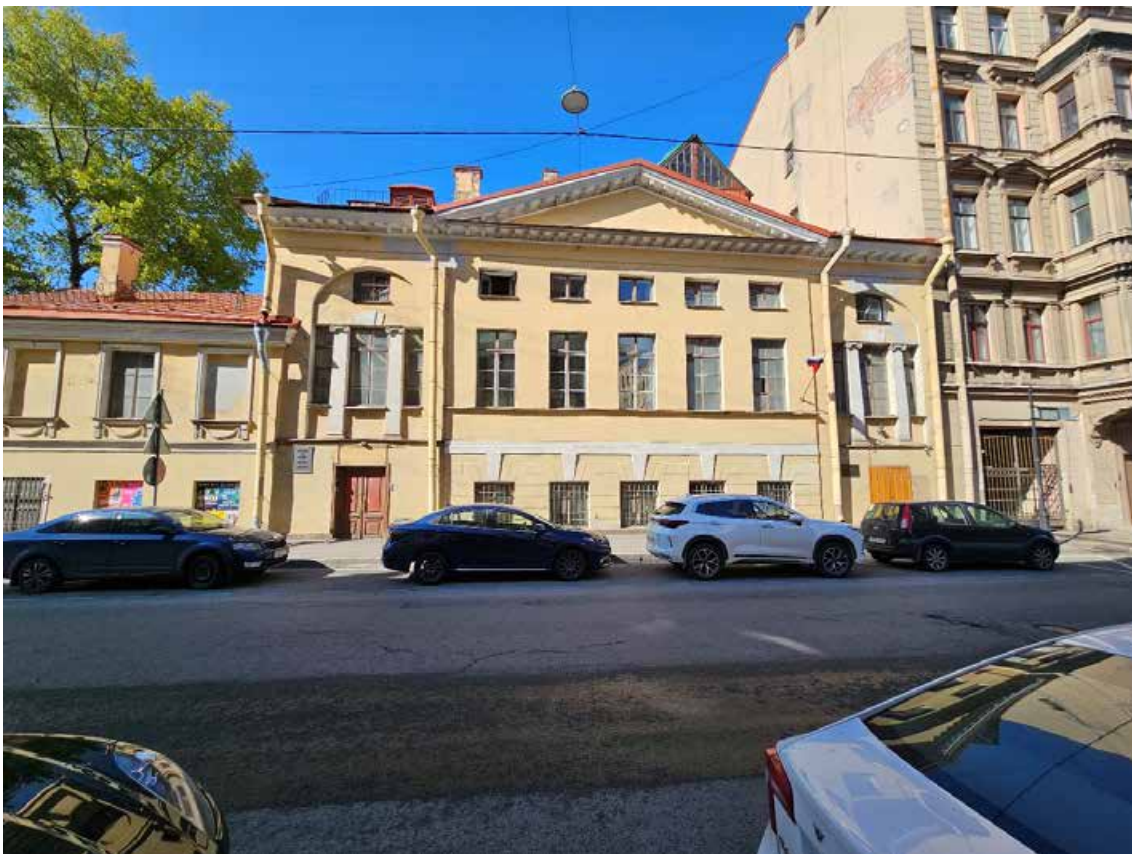
1. Объект культурного наследия федерального значения «Усадьба Демидовых» по адресу: г. Санкт-Петербург, пер. Гривцова, д. 1/64, лит. А, д. 5, лит. А. Главный дом. Общий вид фасада по переулку Гривцова.
