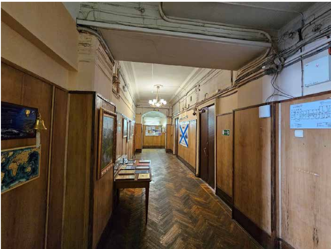
71. Объект культурного наследия федерального значения «Усадьба Демидовых» по адресу: г. Санкт-Петербург, пер. Гривцова, д. 1/64, лит. А, д. 5, лит. А. Главный дом. Общий вид пом. (21-Н) 77 в уровне 3-го этажа (3Г)-23).
