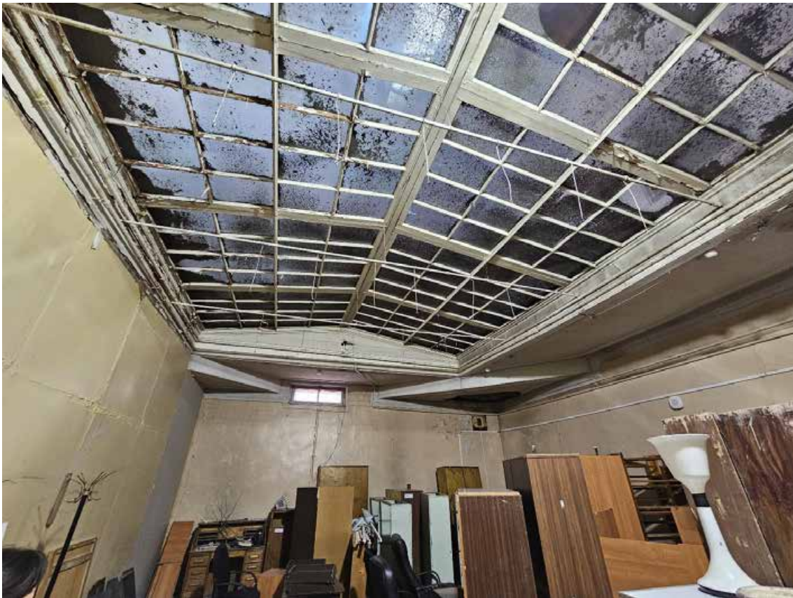
81. Объект культурного наследия федерального значения «Усадьба Демидовых» по адресу: г. Санкт-Петербург, пер. Гривцова, д. 1/64, лит. А, д. 5, лит. А. Главный дом. Световой фонарь в пом. (21-Н) 76 в уровне 3-го этажа (3(Г)-9). Помещение библиотеки.
