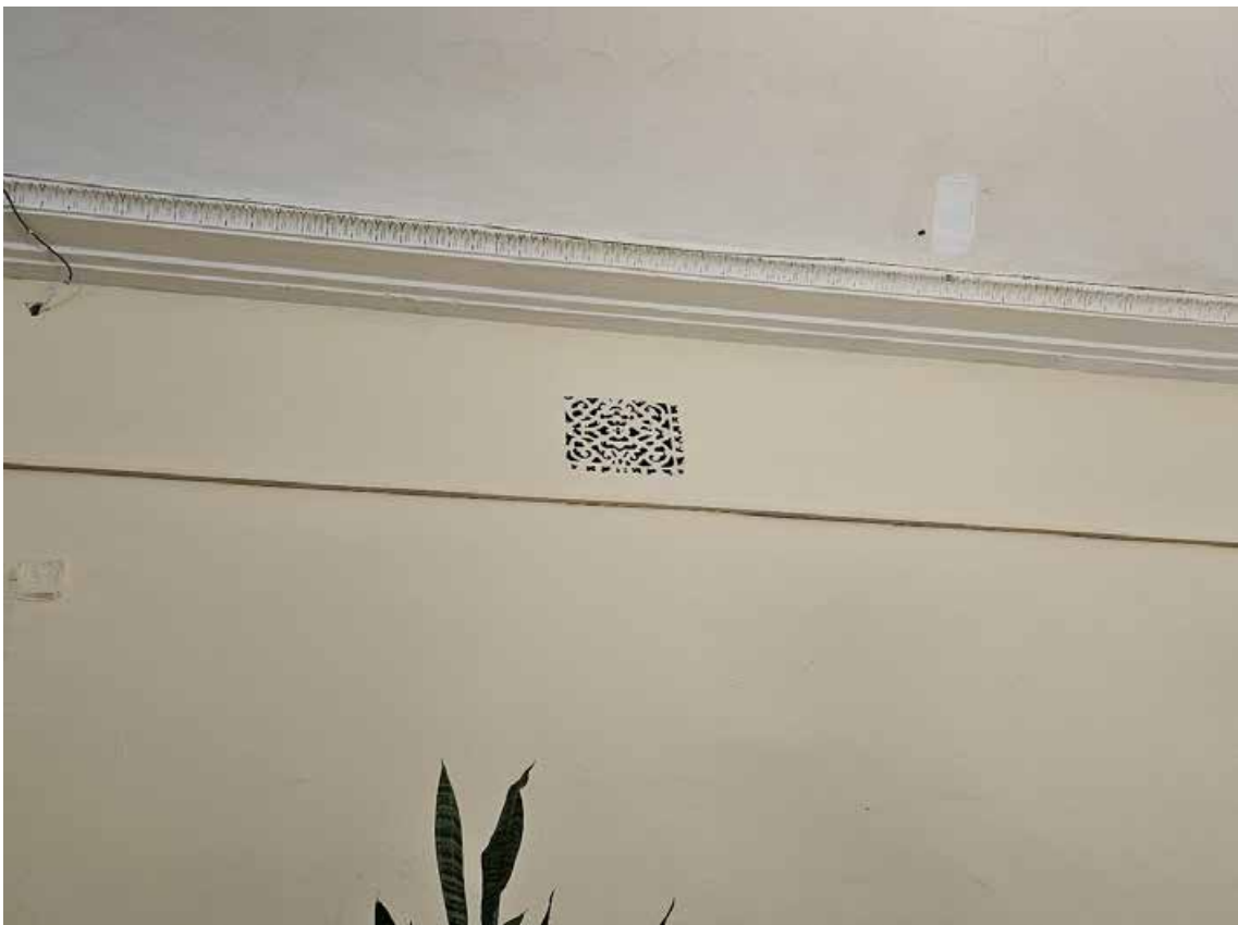
30. Объект культурного наследия федерального значения «Усадьба Демидовых» по адресу: г. Санкт-Петербург, пер. Гривцова, д. 1/64, лит. А, д. 5, лит. А. Главный дом. Вентиляционная решетка в пом. (21-Н) 37 в уровне 2-го этажа (2Г)-6).
