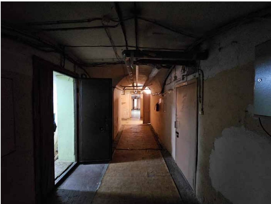
24. Объект культурного наследия федерального значения «Усадьба Демидовых» по адресу: г. Санкт-Петербург, пер. Гривцова, д. 1/64, лит. А, д. 5, лит. А. Главный дом. Общий вид пом. (2-Н) 18 в уровне 1-го этажа (1Г)-50).
