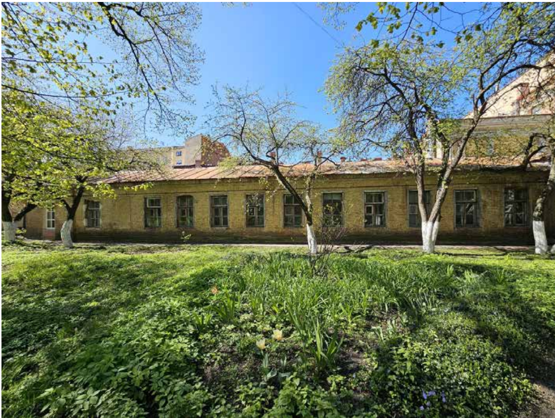
9. Объект культурного наследия федерального значения «Усадьба Демидовых» по адресу: г. Санкт-Петербург, пер. Гривцова, д. 1/64, лит. А, д. 5, лит. А. Кегельбан. Общий вид восточного фасада.
