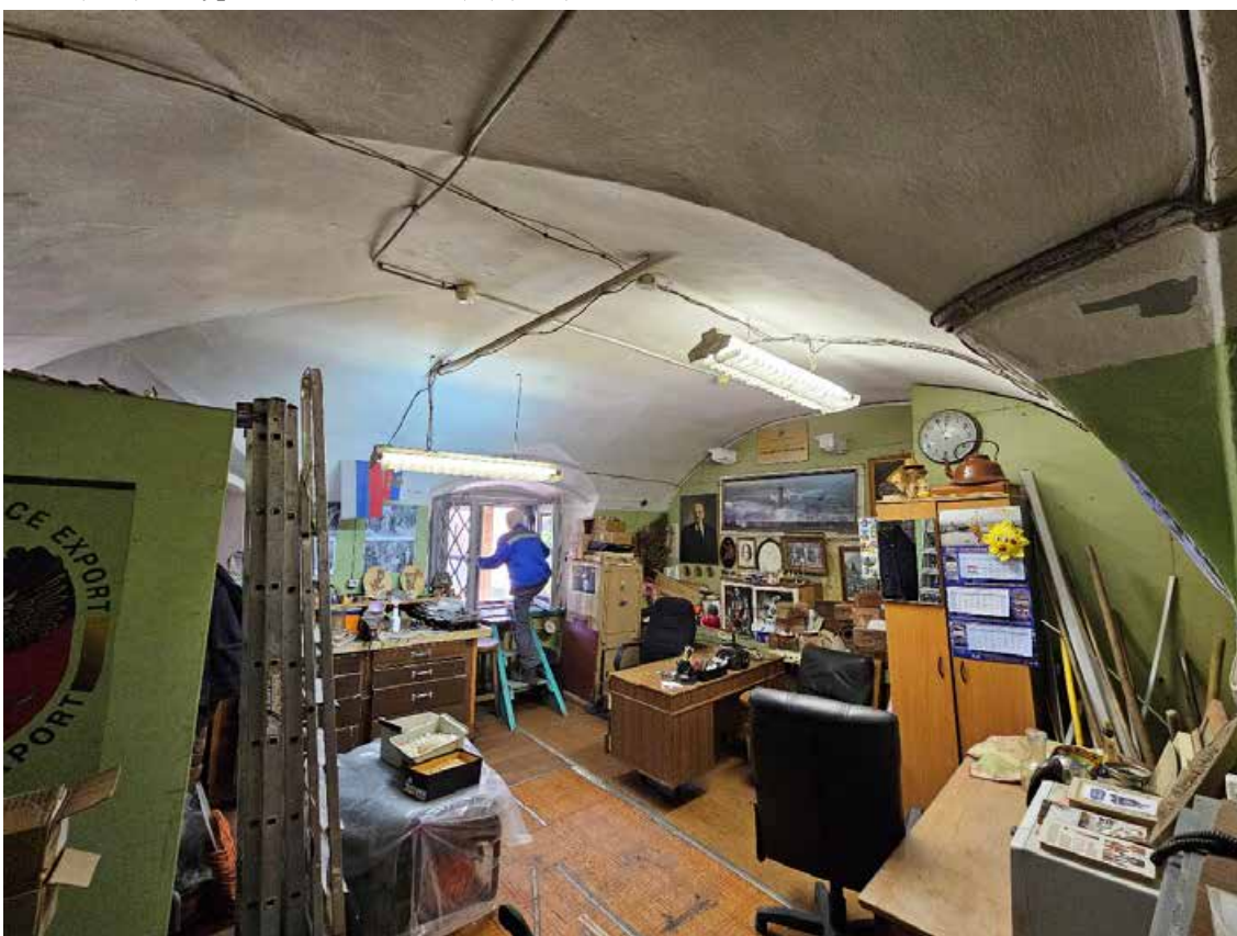
20. Объект культурного наследия федерального значения «Усадьба Демидовых» по адресу: г. Санкт-Петербург, пер. Гривцова, д. 1/64, лит. А, д. 5, лит. А. Главный дом. Общий вид пом. (2-Н) 17 в уровне 1-го этажа (1(Г)-34).
