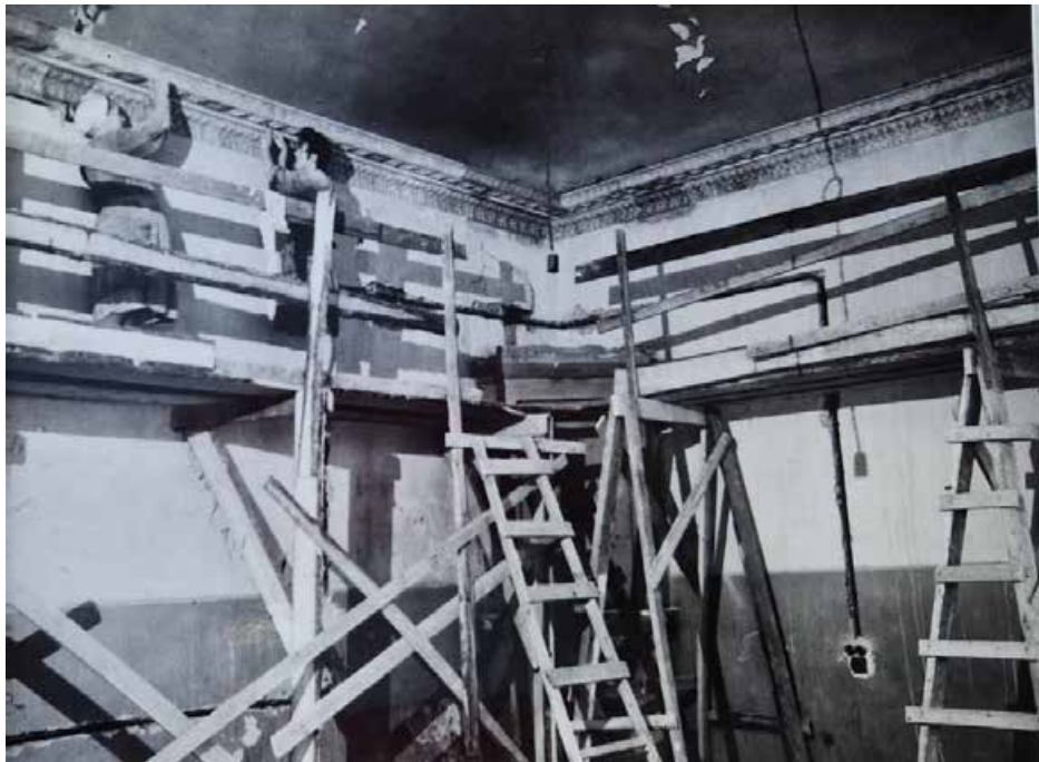
32. Усадьба Демидовых. Главный дом. Рабочий момент реставрации 1948 г. Фотография. ЦГА НТД СПб. Ф. 488. Оп. 3-1. Д. 115. Л. 17.
