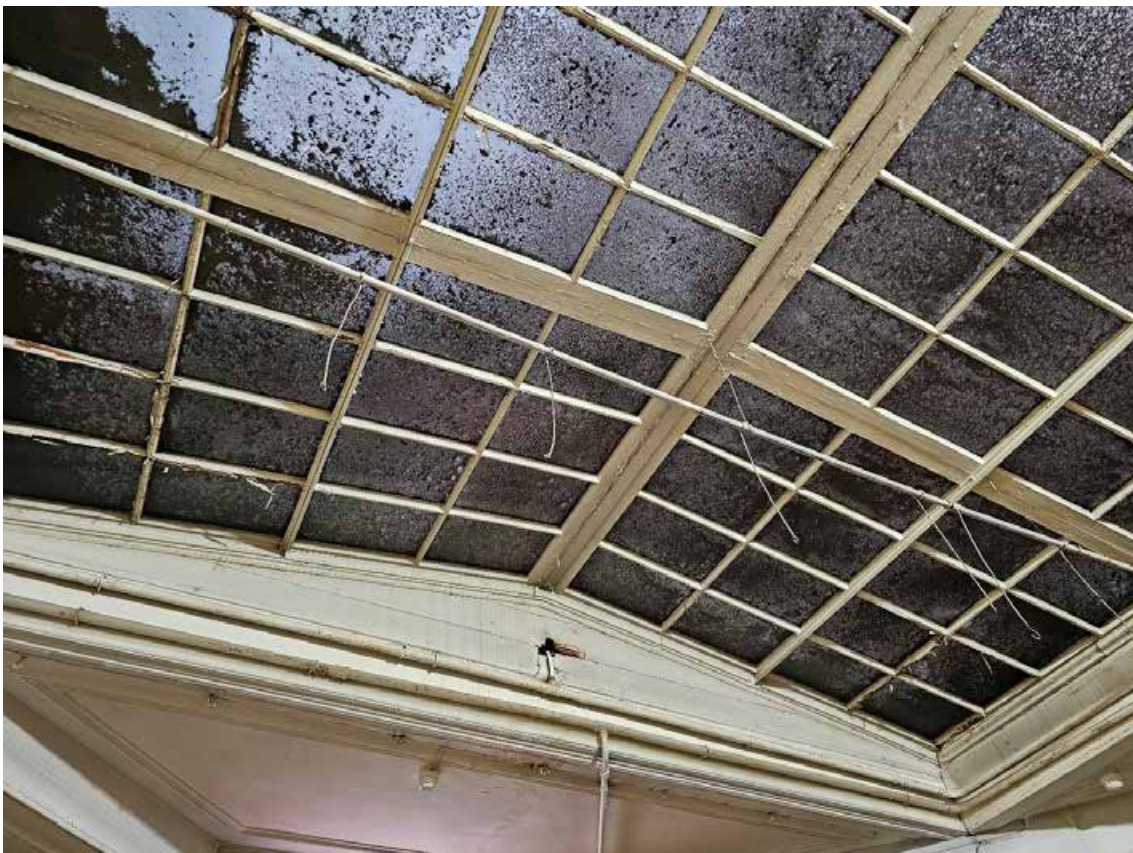
82. Объект культурного наследия федерального значения «Усадьба Демидовых» по адресу: г. Санкт-Петербург, пер. Гривцова, д. 1/64, лит. А, д. 5, лит. А. Главный дом. Перекрытие и световой фонарь в пом. (21-Н) 76 в уровне 3-го этажа (3(Г)-9). Помещение библиотеки.
