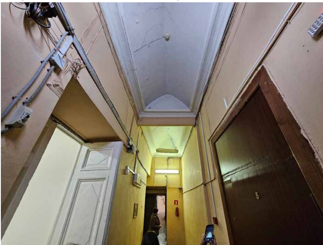
26. Объект культурного наследия федерального значения «Усадьба Демидовых» по адресу: г. Санкт-Петербург, пер. Гривцова, д. 1/64, лит. А, д. 5, лит. А. Главный дом. Общий вид пом. (21-Н) 35 в уровне 2-го этажа (2Г)-19).
