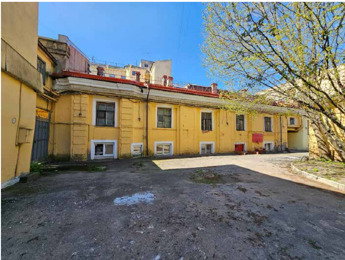
10. Объект культурного наследия федерального значения «Усадьба Демидовых» по адресу: г. Санкт-Петербург, пер. Гривцова, д. 1/64, лит. А, д. 5, лит. А. Западный флигель. Фрагмент восточного фасада.
