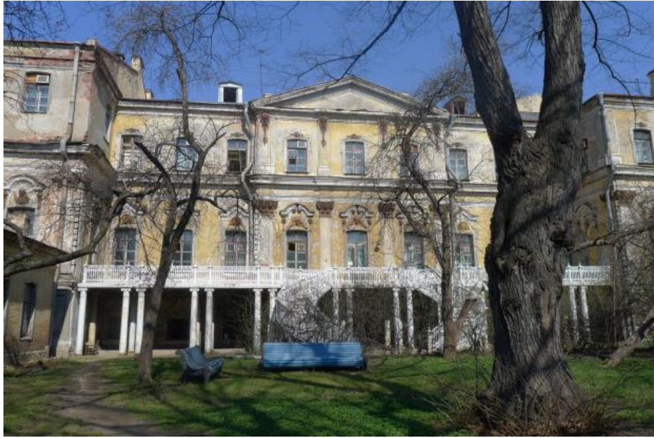
49. Усадьба Демидовых. Вид на главный (усадебный) дом из сада. Фотография. 2000-е гг. http://www.citywalls.ru .
