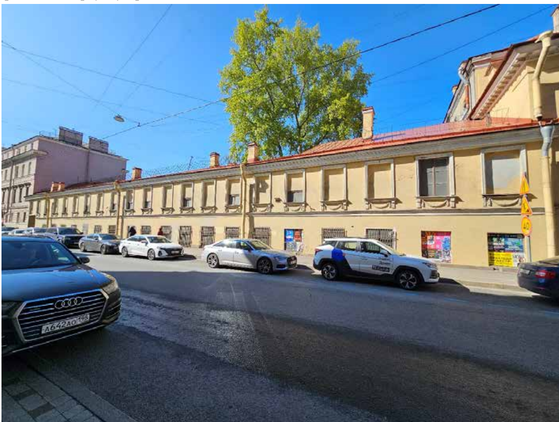
2. Объект культурного наследия федерального значения «Усадьба Демидовых» по адресу: г. Санкт-Петербург, пер. Гривцова, д. 1/64, лит. А, д. 5, лит. А. Восточный флигель. Общий вид лицевого фасада по переулку Гривцова.
