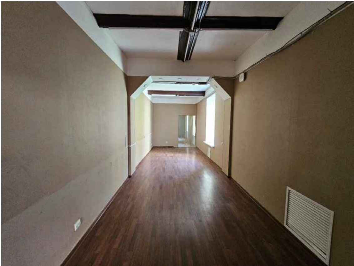
95. Объект культурного наследия федерального значения «Усадьба Демидовых» по адресу: г. Санкт-Петербург, пер. Гривцова, д. 1/64, лит. А, д. 5, лит. А. Кегельбан. Общий вид пом. (21-Н) 7 в уровне 1-го этажа (1(К)-4).
