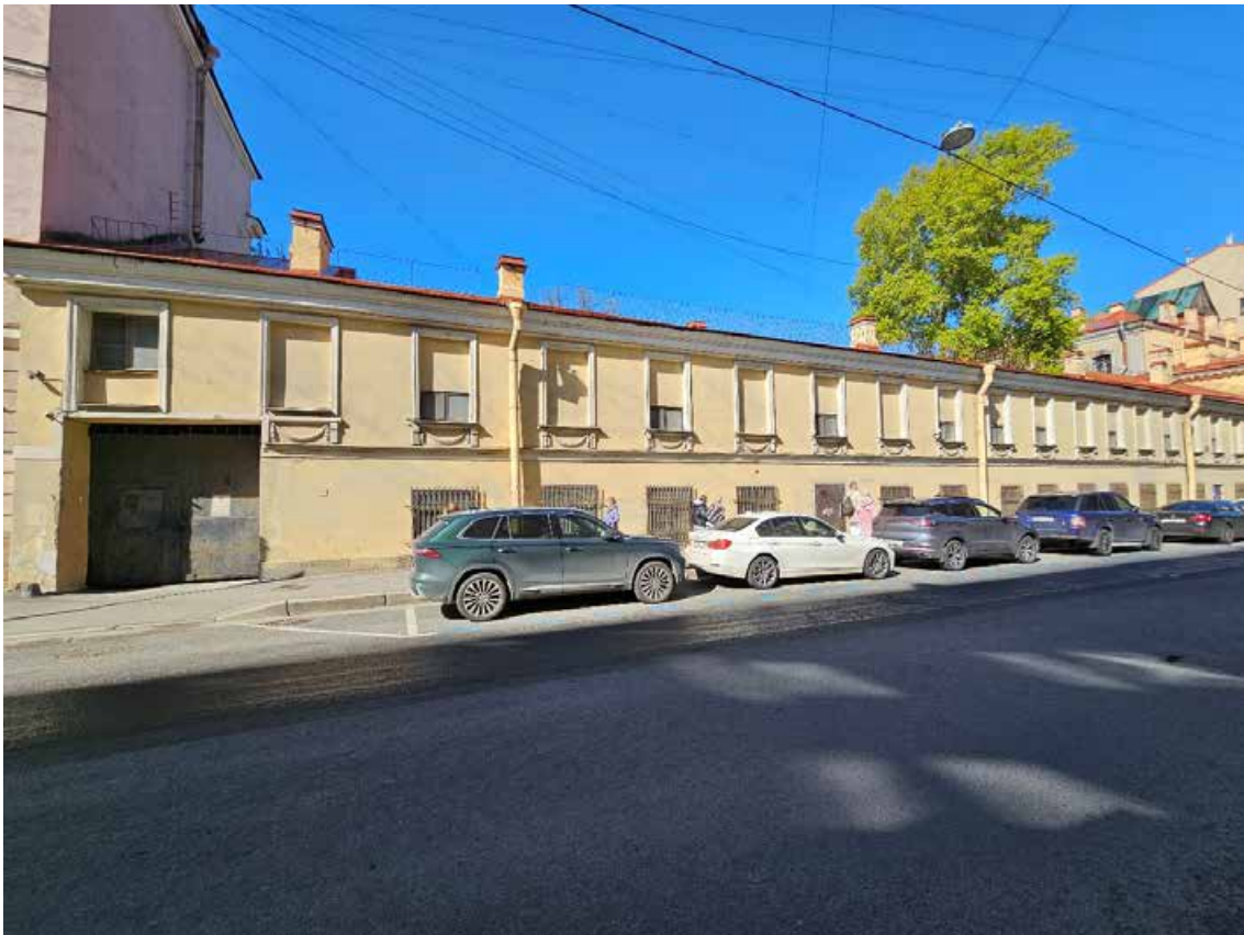
3. Объект культурного наследия федерального значения «Усадьба Демидовых» по адресу: г. Санкт-Петербург, пер. Гривцова, д. 1/64, лит. А, д. 5, лит. А. Восточный флигель. Общий вид восточного лицевого фасада по переулку Гривцова.
