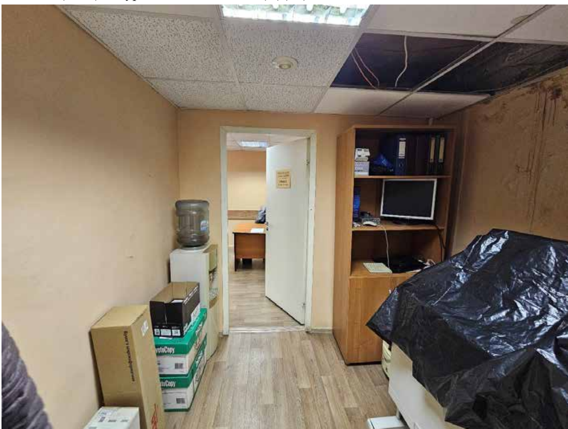
92. Объект культурного наследия федерального значения «Усадьба Демидовых» по адресу: г. Санкт-Петербург, пер. Гривцова, д. 1/64, лит. А, д. 5, лит. А. Западный флигель. Общий вид пом. (68-Н) 1 в уровне 1-го этажа (2(3)-4).
