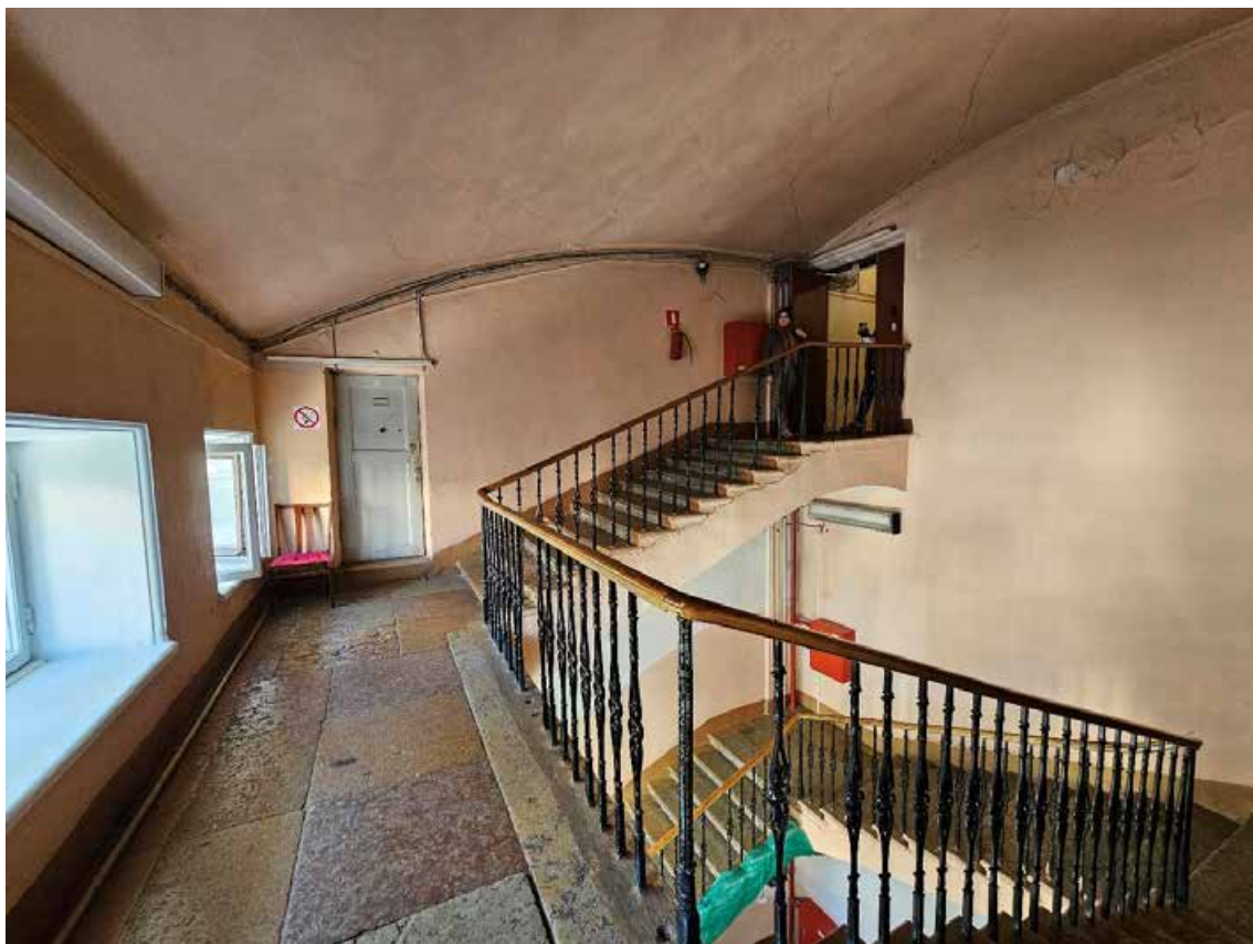
86. Объект культурного наследия федерального значения «Усадьба Демидовых» по адресу: г. Санкт-Петербург, пер. Гривцова, д. 1/64, лит. А, д. 5, лит. А. Главный дом. Общий вид лестницы ЛК-2 в пом. (10ЛК) 17 в уровне 3-го этажа (З(Г)-7). В соответствии с Распоряжением КГИОП от 21.10.2024 г. № 1294-рп – лестница Л-2.
