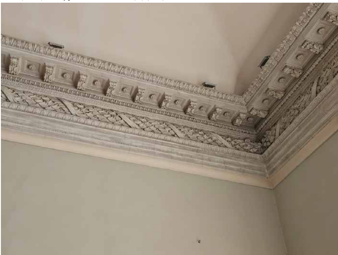
52. Объект культурного наследия федерального значения «Усадьба Демидовых» по адресу: г. Санкт-Петербург, пер. Гривцова, д. 1/64, лит. А, д. 5, лит. А. Главный дом. Фрагмент выносного карниза в пом. (21-Н) 49 в уровне 2-го этажа (2(Г)-25). Столовая.
