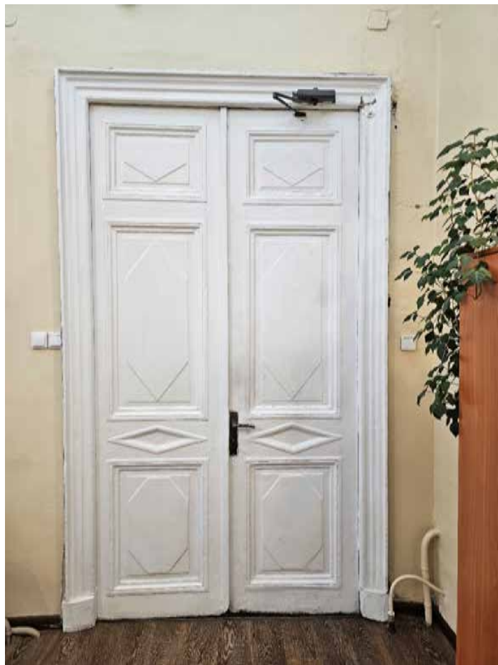
28. Объект культурного наследия федерального значения «Усадьба Демидовых» по адресу: г. Санкт-Петербург, пер. Гривцова, д. 1/64, лит. А, д. 5, лит. А. Главный дом. Историческое дверное деревянное заполнение в пом. (21-Н) 38 в уровне 2-го этажа (2Г)-8).
