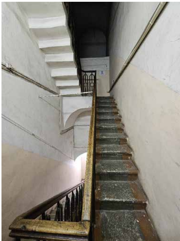
69. Объект культурного наследия федерального значения «Усадьба Демидовых» по адресу: г. Санкт-Петербург, пер. Гривцова, д. 1/64, лит. А, д. 5, лит. А. Главный дом. Общий вид консольно-защемлённой лестницы ЛК-3 в пом. (21-Н) 107 в уровне 3-го этажа (З(Г)-36). В соответствии с Распоряжением КГИОП от 21.10.2024 г. № 1294-рп – лестница Л-3.
