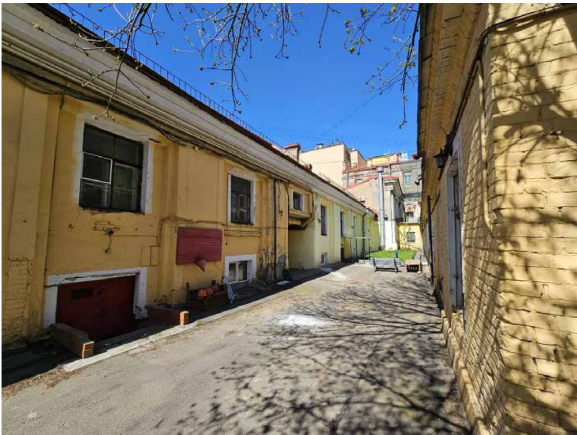
11. Объект культурного наследия федерального значения «Усадьба Демидовых» по адресу: г. Санкт-Петербург, пер. Гривцова, д. 1/64, лит. А, д. 5, лит. А. Западный флигель. Общий вид восточного фасада.
