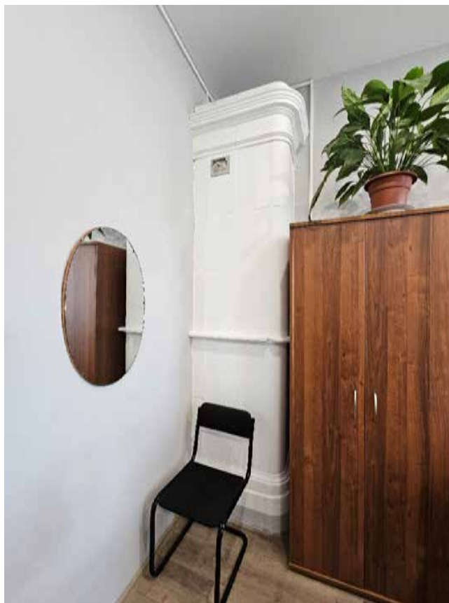
79. Объект культурного наследия федерального значения «Усадьба Демидовых» по адресу: г. Санкт-Петербург, пер. Гривцова, д. 1/64, лит. А, д. 5, лит. А. Главный дом. Угловая двухъярусная печь в пом. (21-Н) 80 в уровне 3-го этажа (3(Г)-32).
