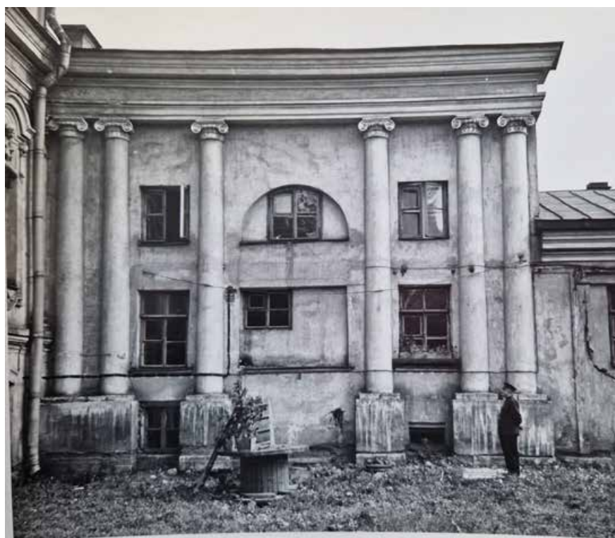
42. Усадьба Демидовых. Восточный флигель со стороны двора. Северный ризалит, примыкающий к главному зданию. Фотография. 1964 г. ЦГА НТД СПб. Ф. 488. Оп. 3-1. Д. 115. Л. 24.
