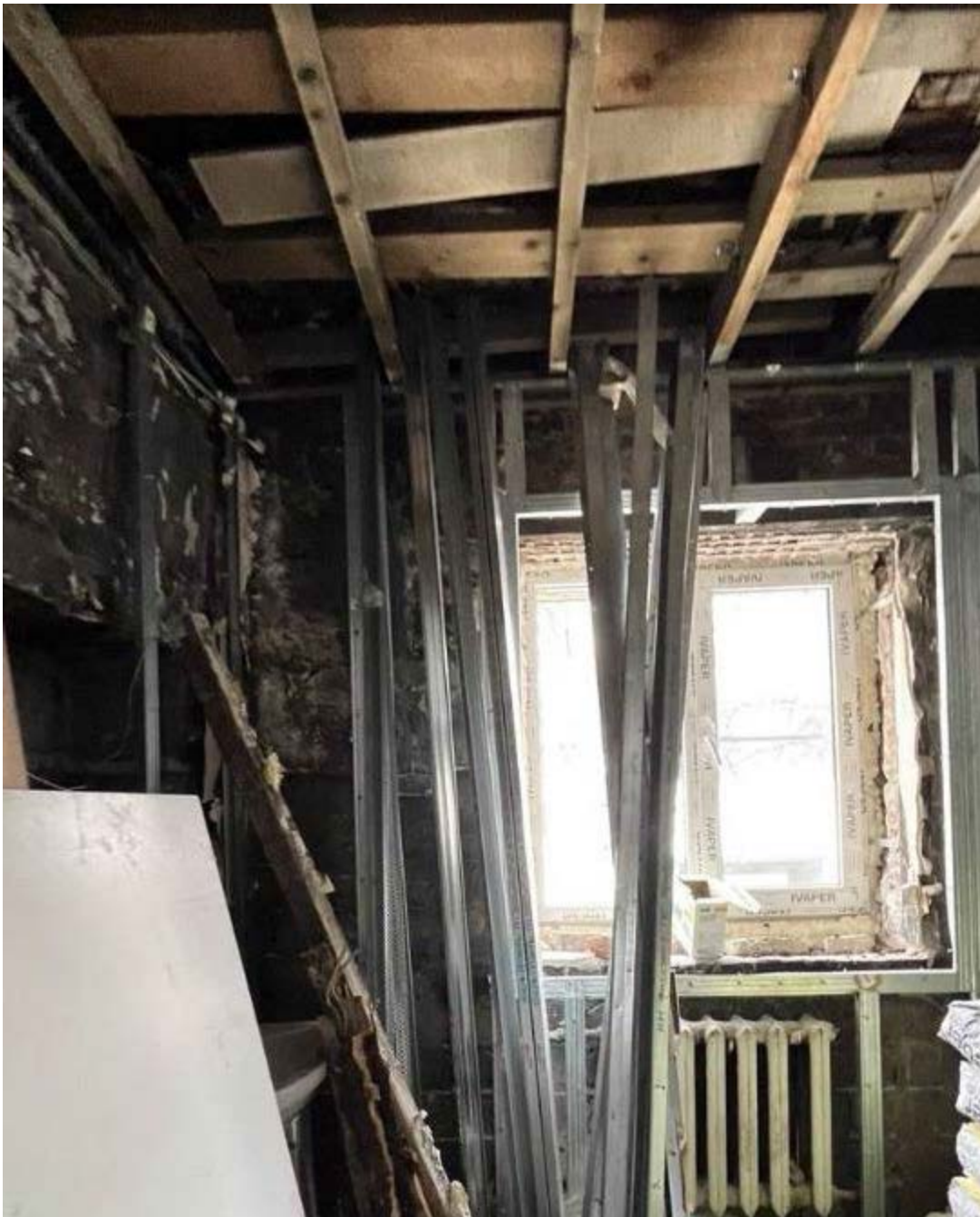
90. Объект культурного наследия федерального значения «Усадьба Демидовых» по адресу: г. Санкт-Петербург, пер. Гривцова, д. 1/64, лит. А, д. 5, лит. А. Восточный флигель. Фрагмент пом. (23-Н) 5 в уровне цокольного этажа (0(В)-14). Фотография предоставлена заказчиком.
