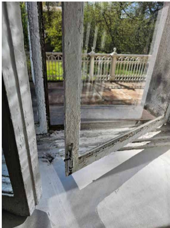
33. Объект культурного наследия федерального значения «Усадьба Демидовых» по адресу: г. Санкт-Петербург, пер. Гривцова, д. 1/64, лит. А, д. 5, лит. А. Главный дом. Металлическое заполнение оконного проема в пом. (21-Н) 39 в уровне 2-го этажа (2(Г)-10).
