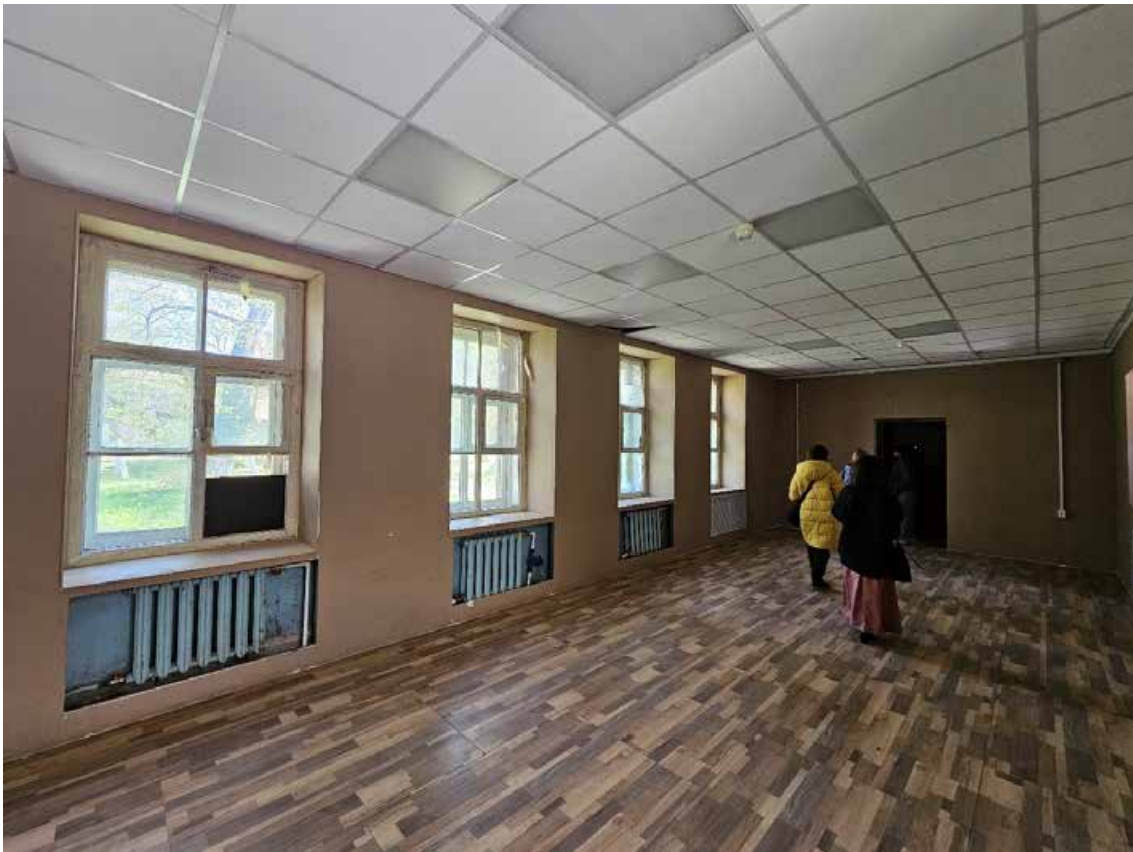
99. Объект культурного наследия федерального значения «Усадьба Демидовых» по адресу: г. Санкт-Петербург, пер. Гривцова, д. 1/64, лит. А, д. 5, лит. А. Кегельбан. Общий вид пом. (21-Н) 13 в уровне 1-го этажа (1(К)-8).
