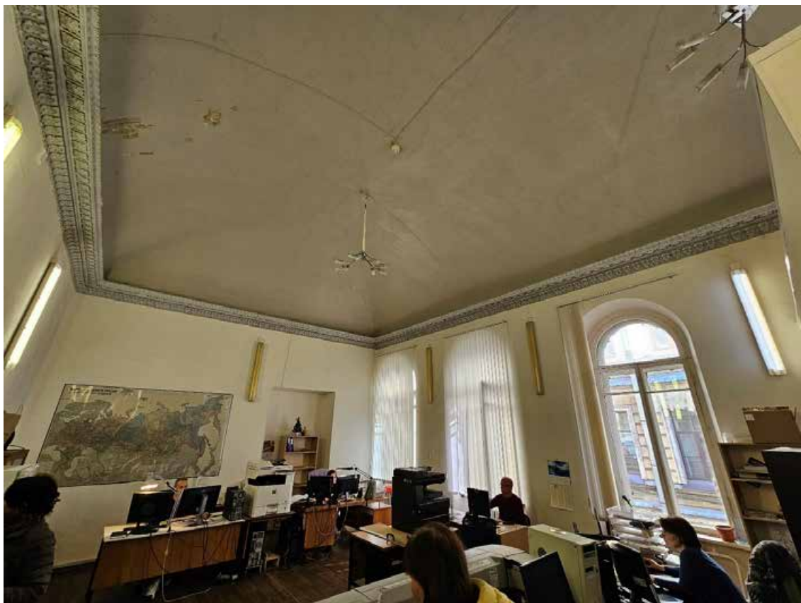
36. Объект культурного наследия федерального значения «Усадьба Демидовых» по адресу: г. Санкт-Петербург, пер. Гривцова, д. 1/64, лит. А, д. 5, лит. А. Главный дом. Общий вид пом. (21-Н) 55 в уровне 2-го этажа (2(Г)-20).
