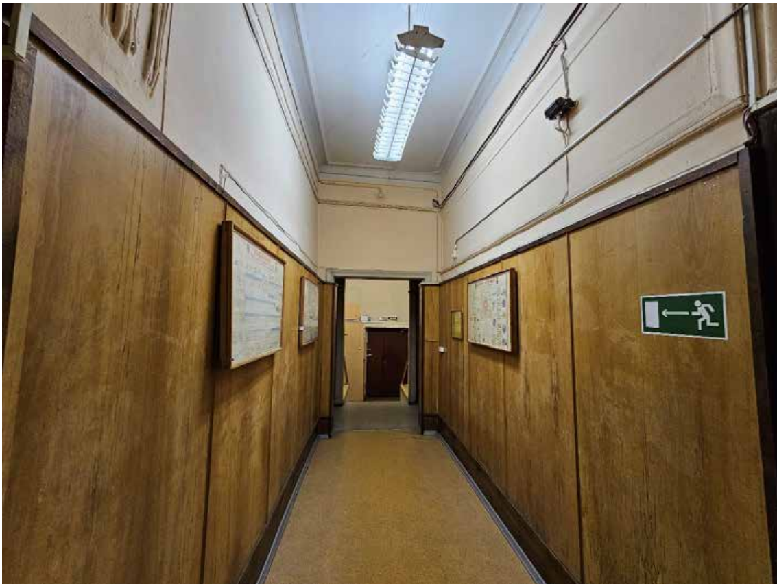
83. Объект культурного наследия федерального значения «Усадьба Демидовых» по адресу: г. Санкт-Петербург, пер. Гривцова, д. 1/64, лит. А, д. 5, лит. А. Главный дом. Общий вид пом. (21-Н) 68 в уровне 3-го этажа (3(Г)-15).
