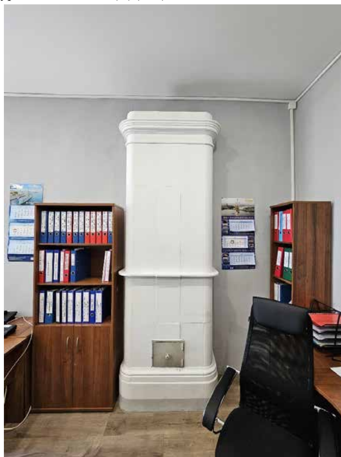
78. Объект культурного наследия федерального значения «Усадьба Демидовых» по адресу: г. Санкт-Петербург, пер. Гривцова, д. 1/64, лит. А, д. 5, лит. А. Главный дом. Средистенная двухъярусная печь в пом. (21-Н) 80 в уровне 3-го этажа (3Г)-32).
