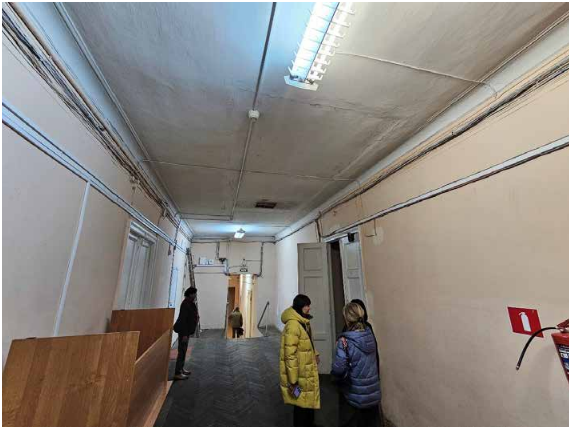
57. Объект культурного наследия федерального значения «Усадьба Демидовых» по адресу: г. Санкт-Петербург, пер. Гривцова, д. 1/64, лит. А, д. 5, лит. А. Главный дом. Общий вид пом. (21-Н) 99 в уровне 3-го этажа (3(Г)-44).
