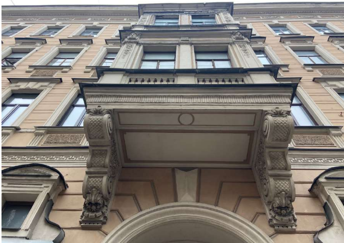
6. Фрагмент фасада с эркером
