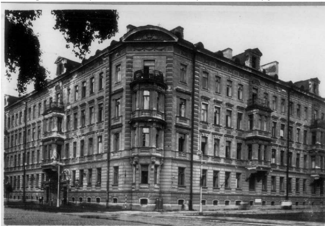
61. Угловой фасад дома № 5/15. 1960 г. ЦГАКФФД СПб. Фотодокументы. Оп.1ГР-48. Ед.хр.74562
