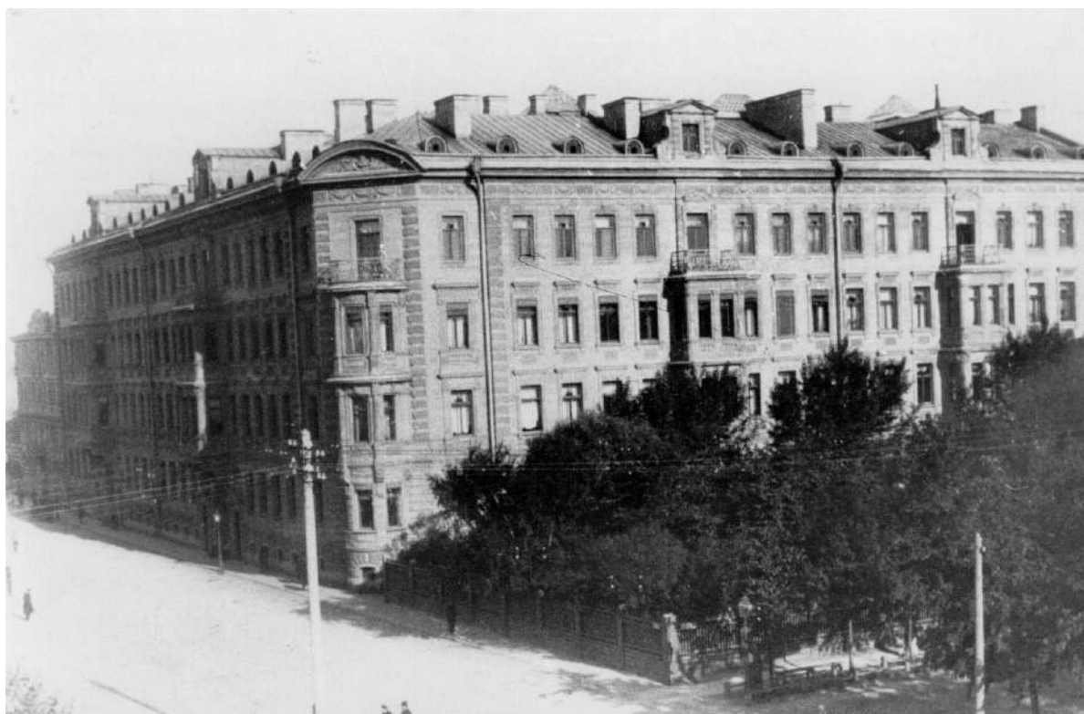
58. Общий вид дома №15 по Большому проспекту (угол 4 линии, дом №5) - дом Л.Е.Кёнига. Начало 1900-х гг. ЦГАКФФД СПб. Фотодокументы. Оп.1А-3. Ед.хр.3994
