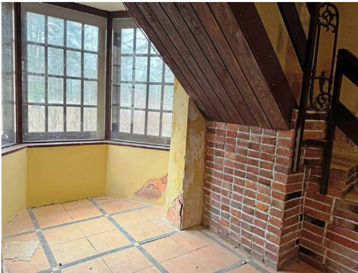
19. Вид в интерьере основного объема здания «Караульни». 1-й этаж.
