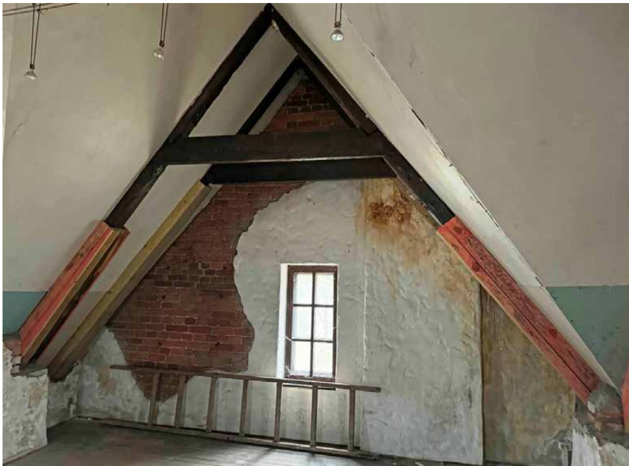
23. Вид в интерьере основного объема здания «Караульни». Мансардный этаж.
