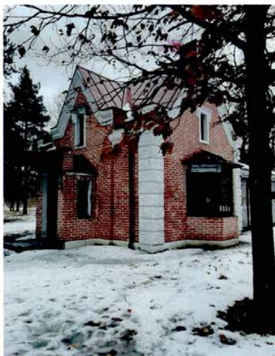
1. Вид на объект культурного наследия северо-западной стороны.
