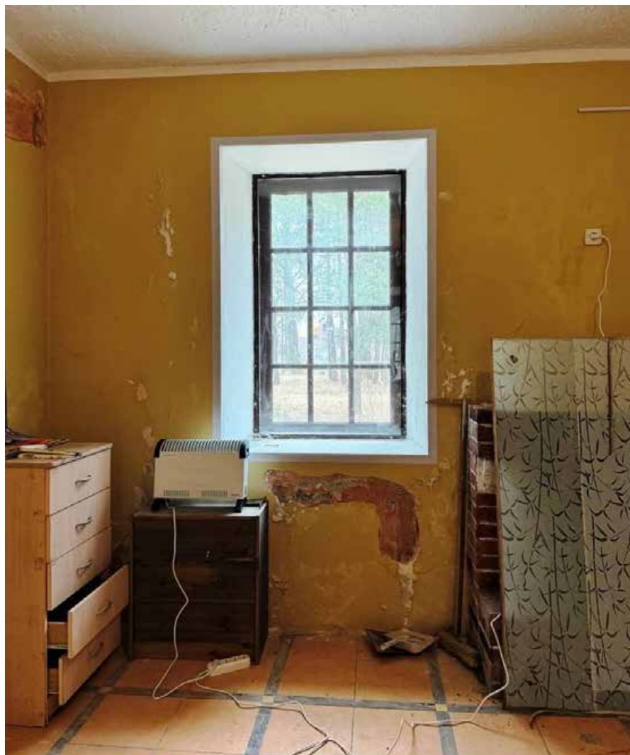
20. Вид в интерьере основного объема здания «Караульни». 1-й этаж.
