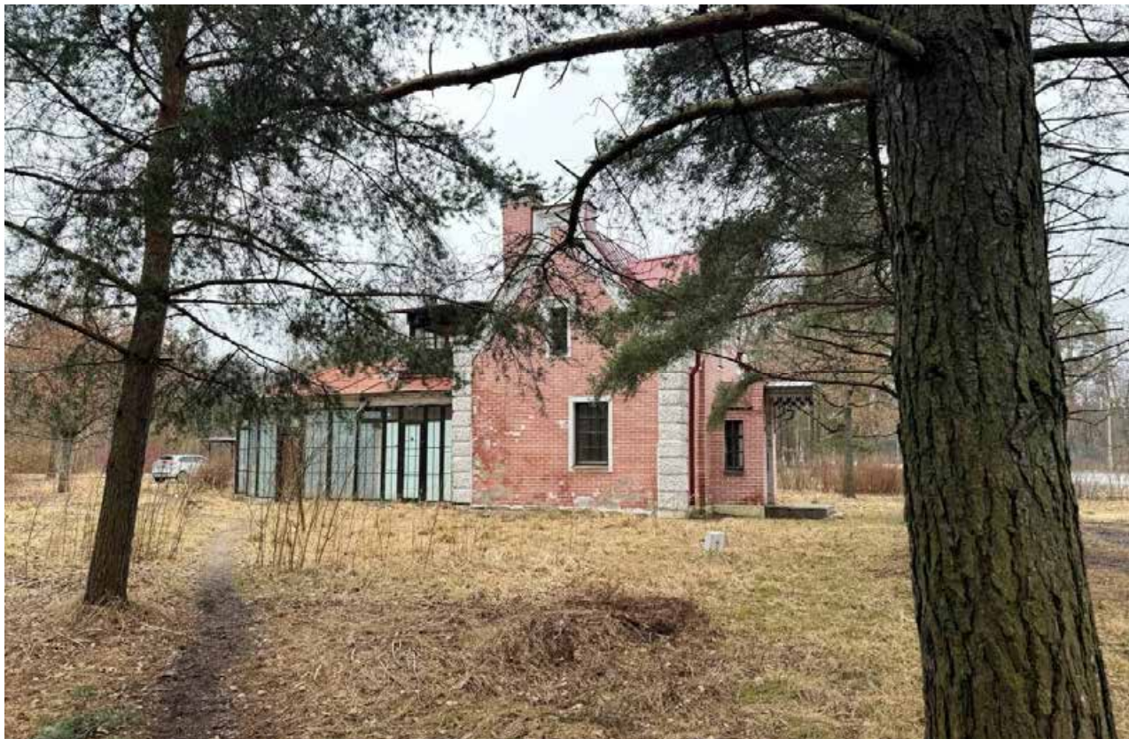
6. Вид с северо-востока на восточный фасад «Караульни» (с пристройкой).
