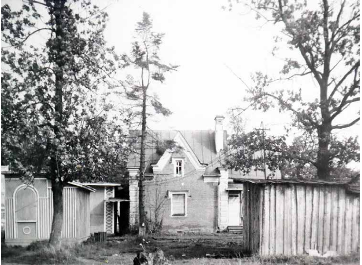
Илл.21. Вид здания с прилегающей территорией с южной стороны. 1957-1958 гг. Архив КГИОП (Альбом, № Пр-24).
