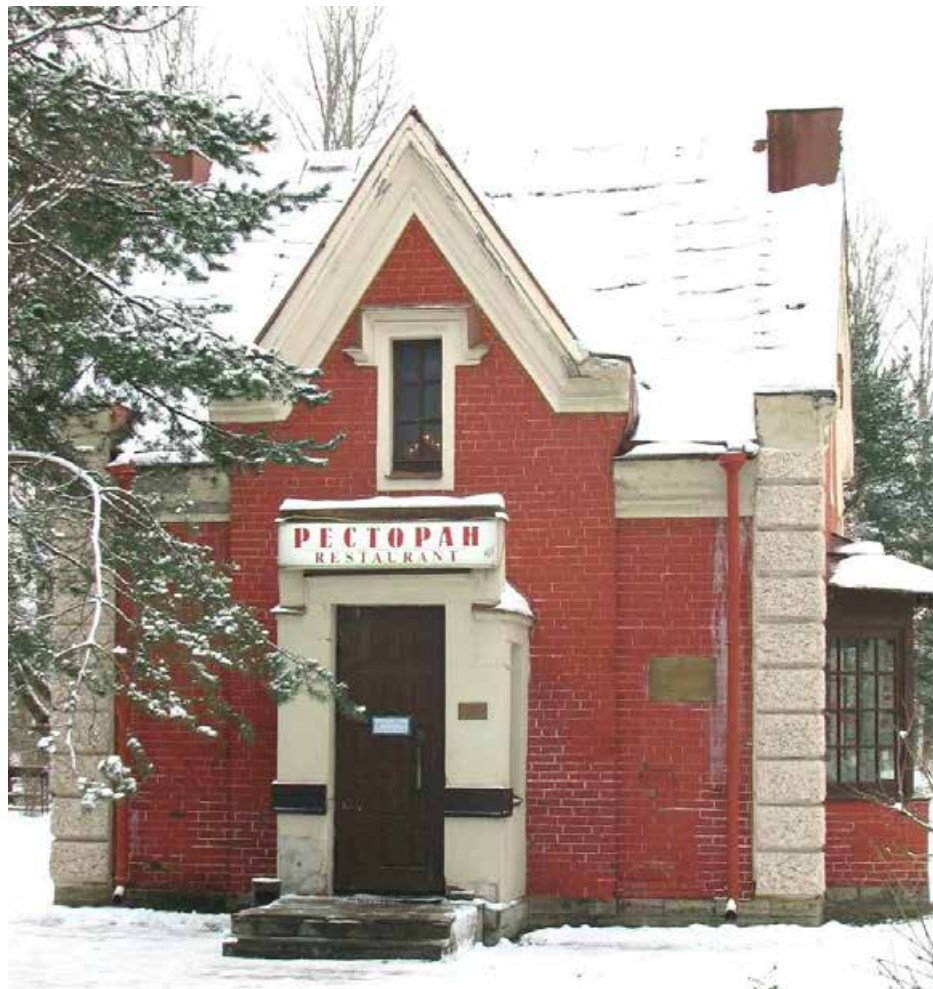
Илл.33. Главный вход в здание по северному фасаду. 2012 г. Источник – сайт citywalls.ru .
