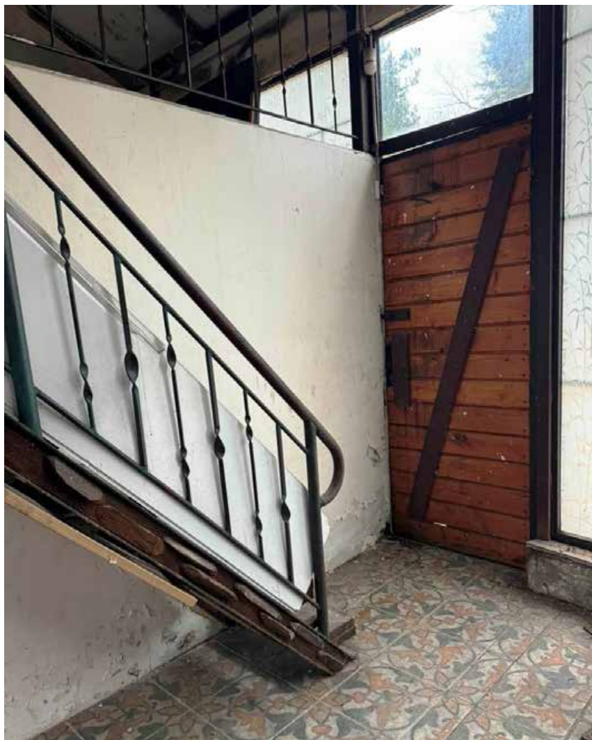
10. Вид в интерьере временной остекленной пристройки. Лестница №2 на мансардный этаж.
