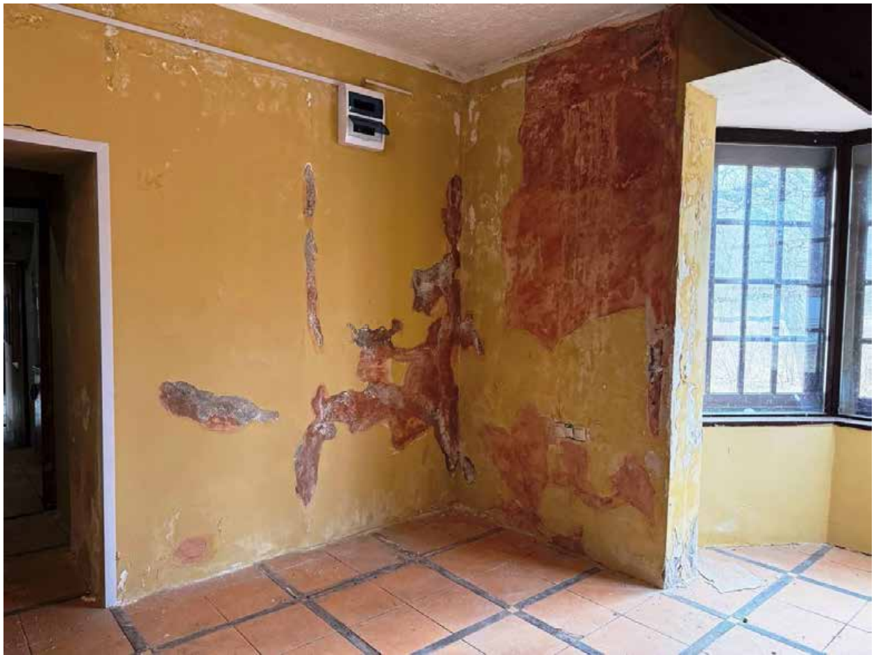
18. Вид в интерьере основного объема здания «Караульни». 1-й этаж.
