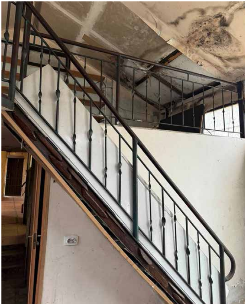
11. Вид в интерьере временной остекленной пристройки. Лестница №2 на мансардный этаж.
