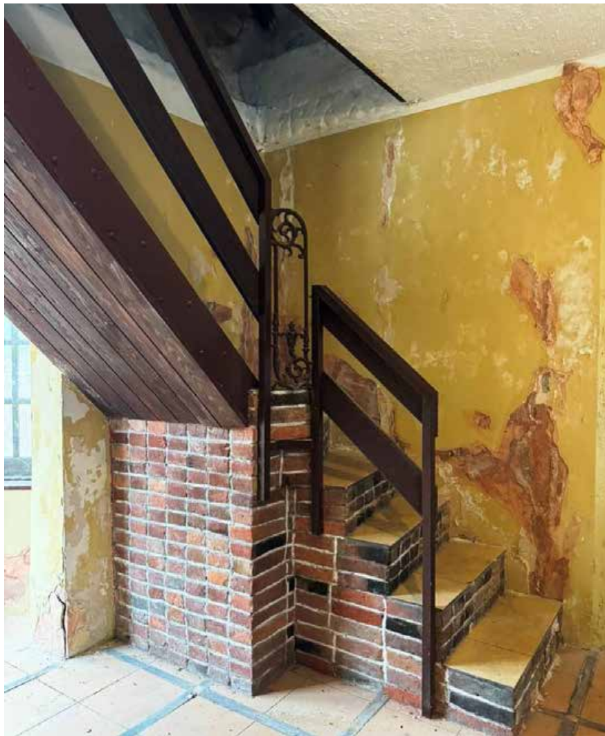
21. Вид в интерьере основного объема здания «Караульни» (Лестница №1). 1-й этаж.
