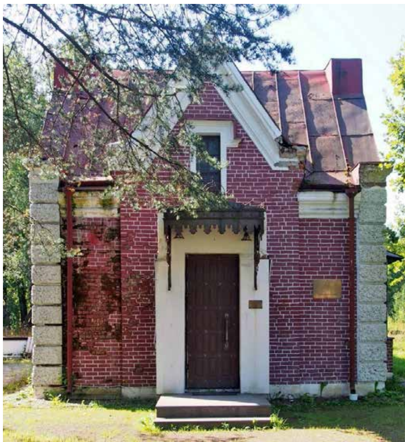
Илл.38. Главный вход в здание по северному фасаду. 2019 г. Источник – сайт citywalls.ru .
