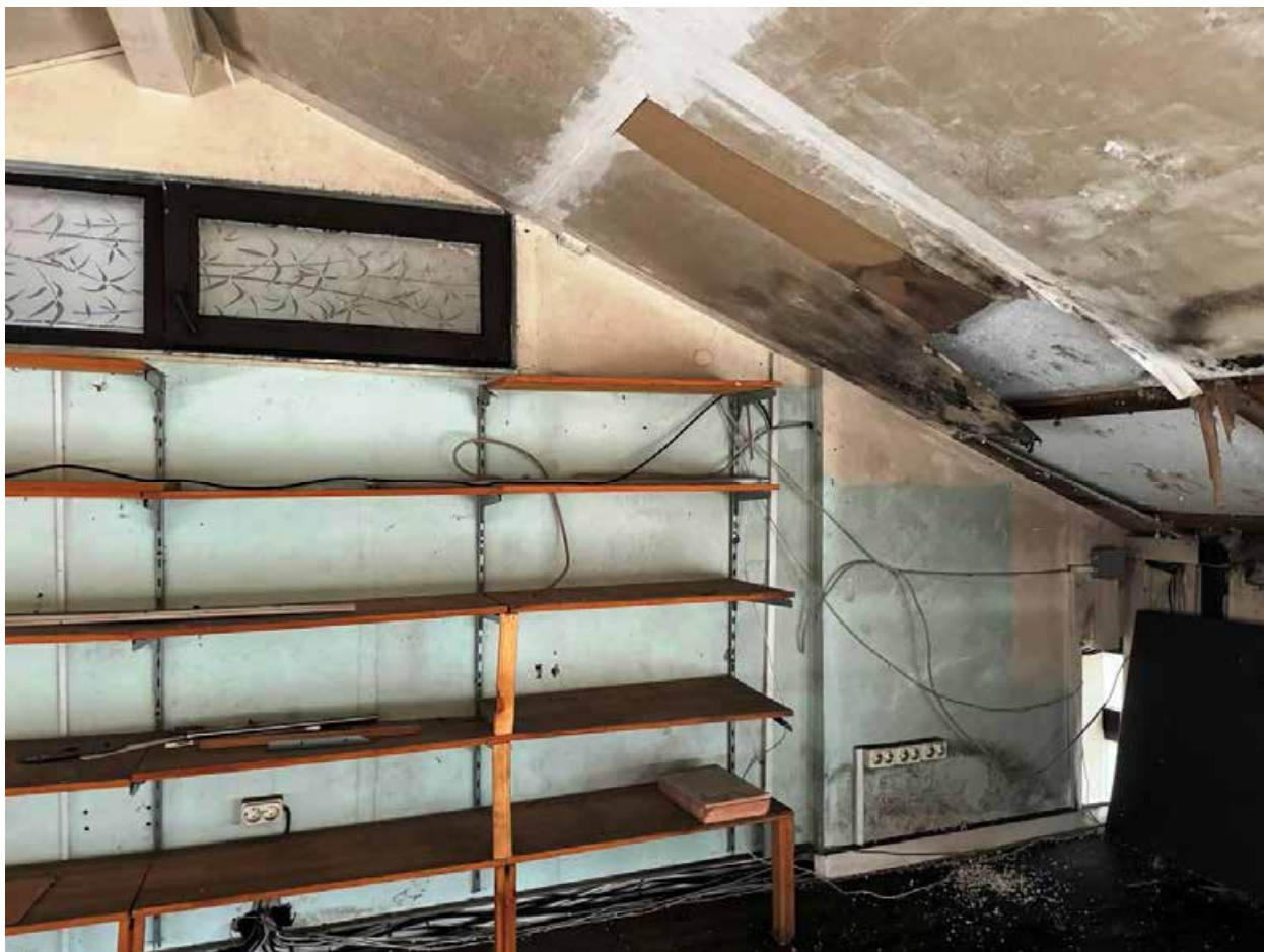
14. Вид в уровне мансарды временной остекленной пристройки.
