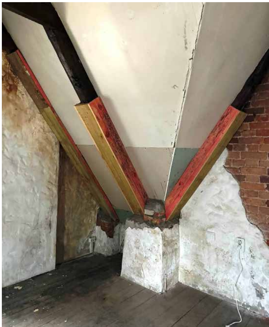
25. Вид в интерьере основного объема здания «Караульни». Мансардный этаж.
