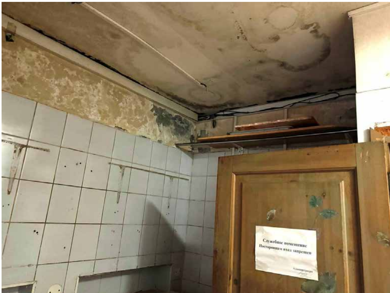
17. Вид в интерьере поздней южной кирпичной пристройки.
