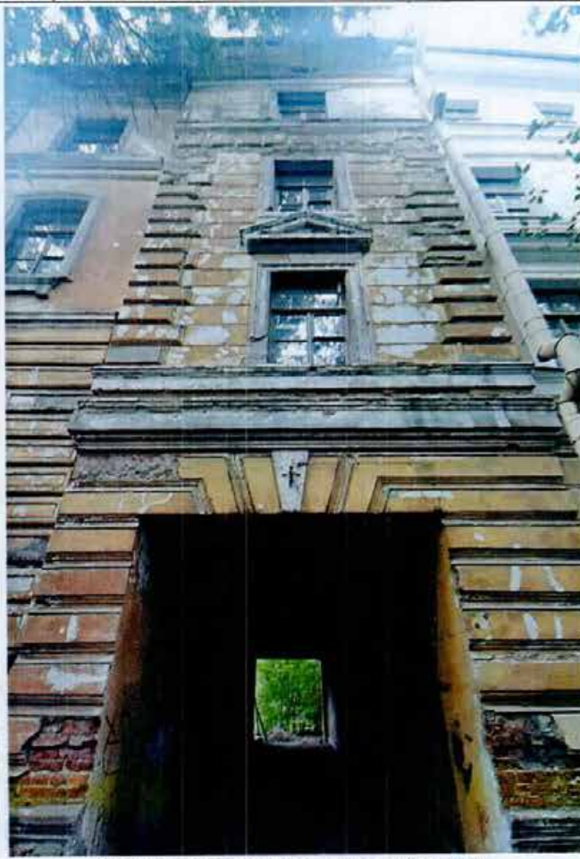
3. Фрагмент восточного фасада
