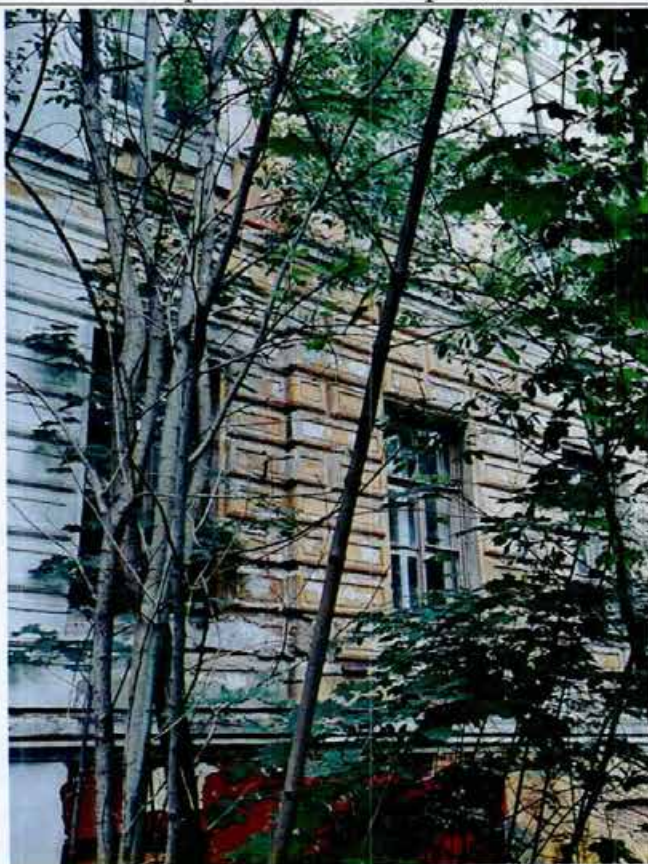
3. Фрагмент восточного фасада
