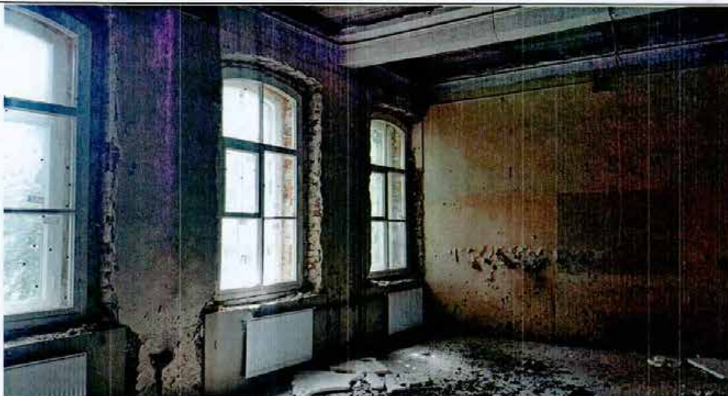
10. Помещение в уровне 2-го этажа
