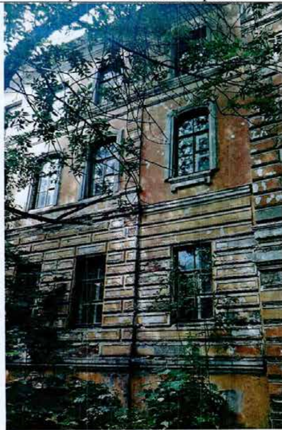
4. Фрагмент восточного фасада
