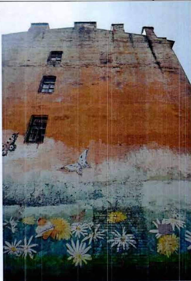
2. Северный фасад здания
