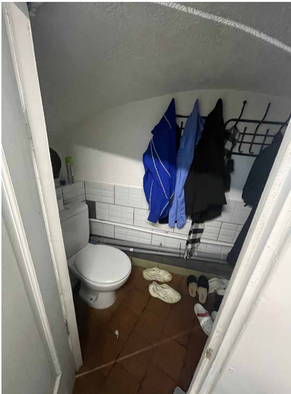
12.Фрагмент интерьера туалета (помещение 10/7);
