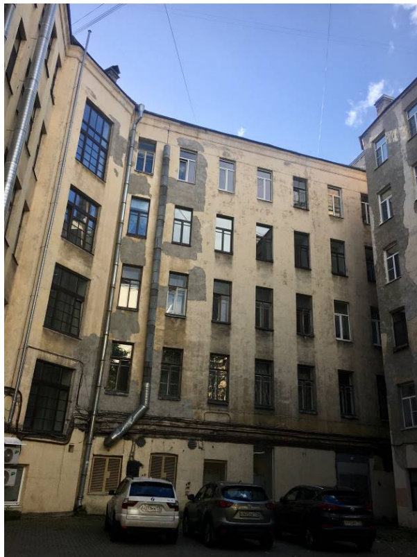
5. Вид дворового фасада. Направление съемки северо-запад. Фото 12.08.2020
