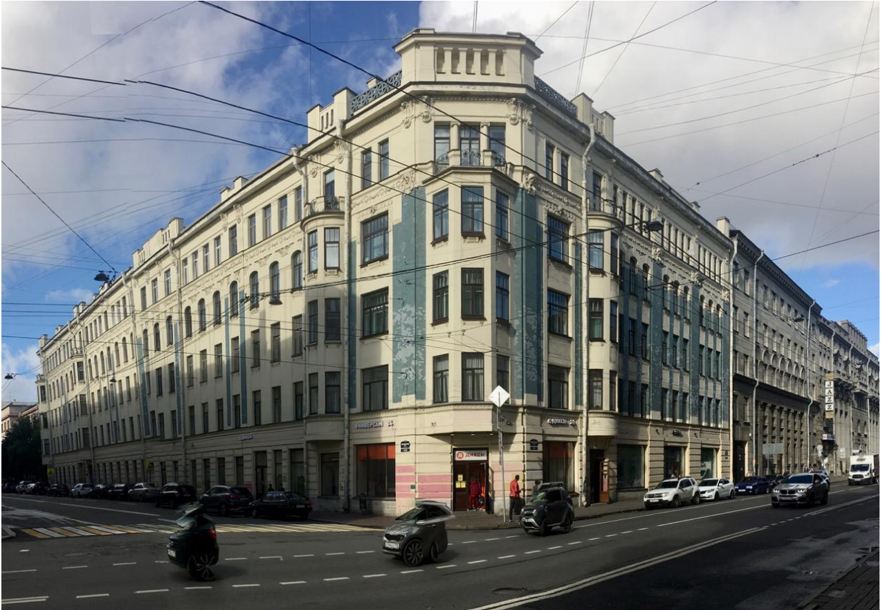
1. Вид лицевого фасада с перекрестка пр. Загородного и ул. Бородинской.
