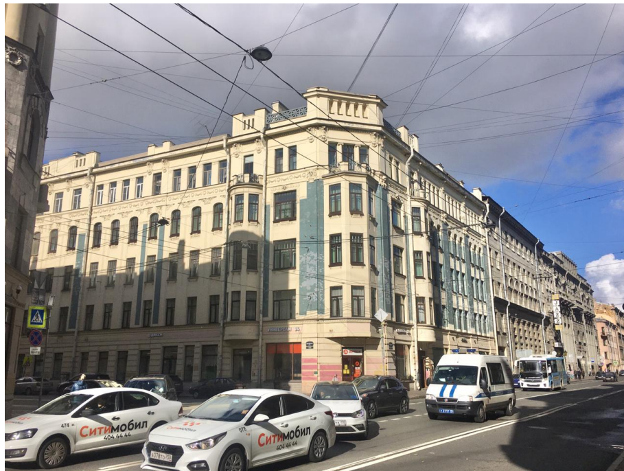
3. Вид лицевого фасада с перекрестка пр. Загородного и ул. Бородинской по стороне пр. Загородного.
