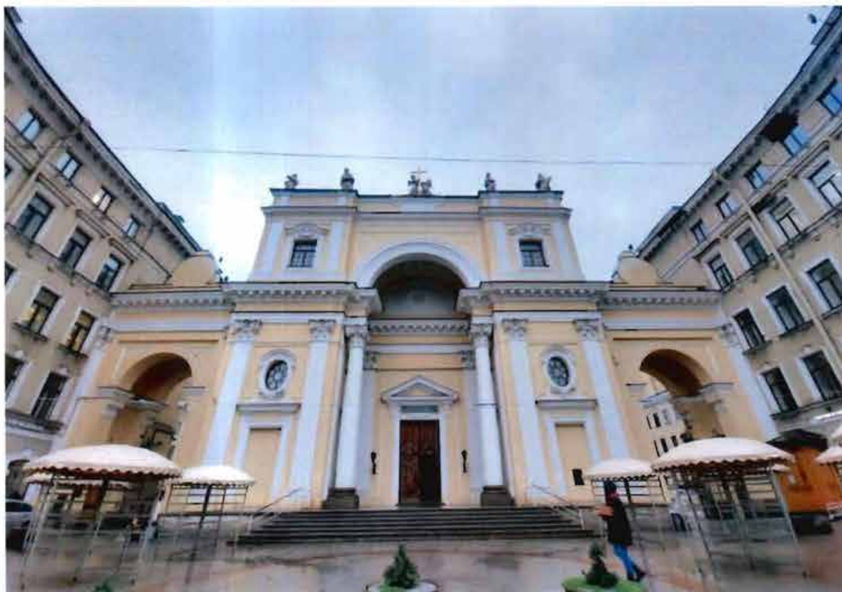
1. Общий вид на южный фасад объекта культурного наследия (17.02.2022)
