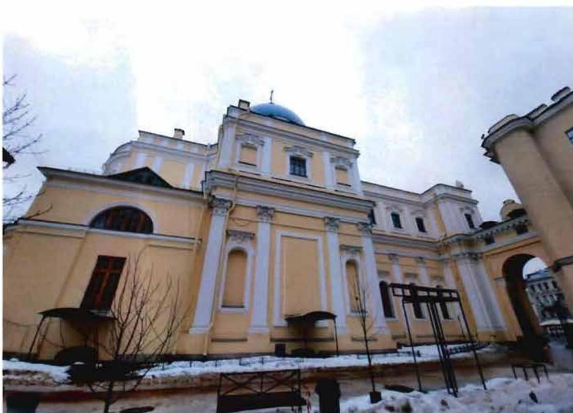
3. Общий вид на западный фасады объекта культурного наследия (17.02.2022)
