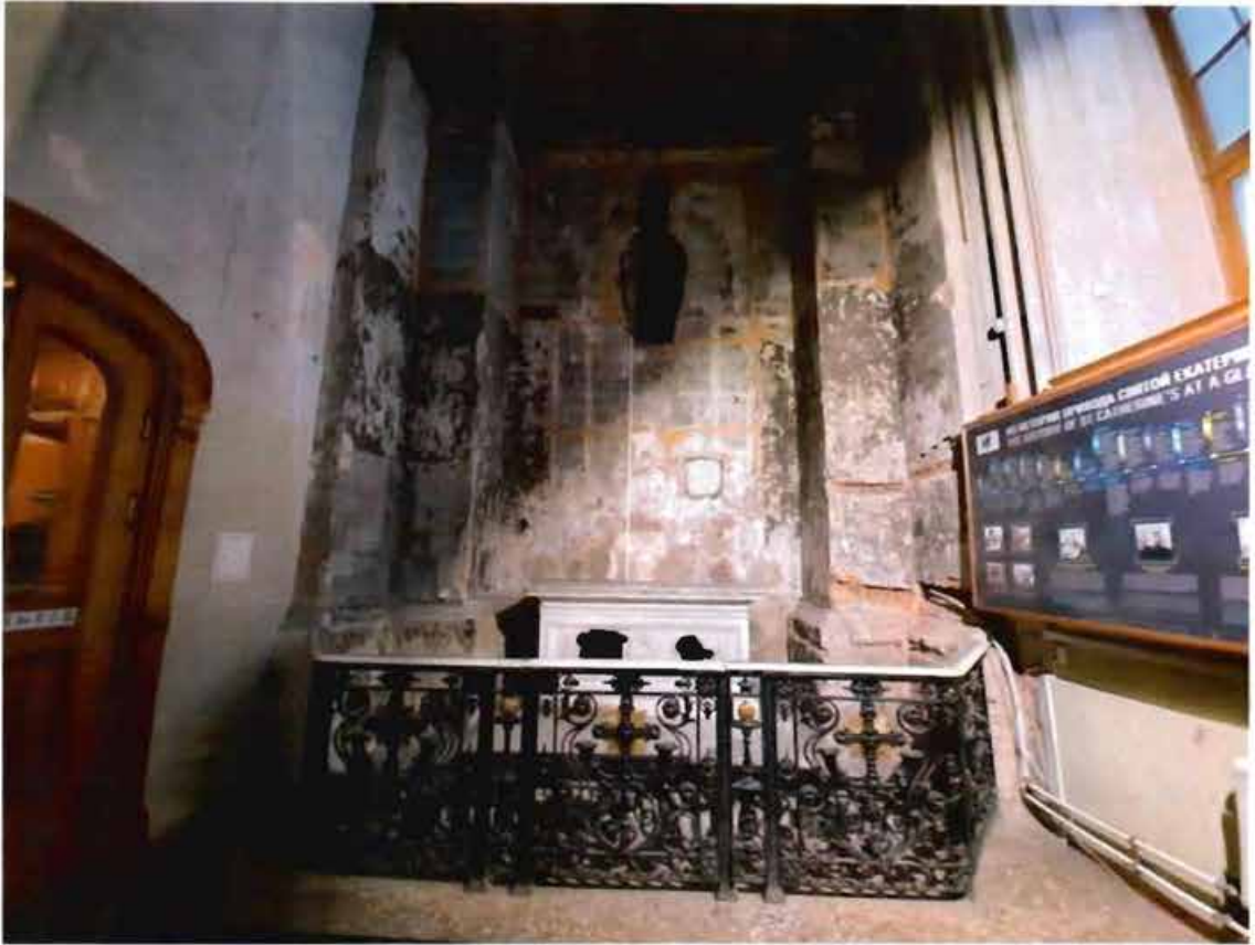
6. Интерьеры объекта культурного наследия. Пом. 95-Н (3) (09.02.2022)
