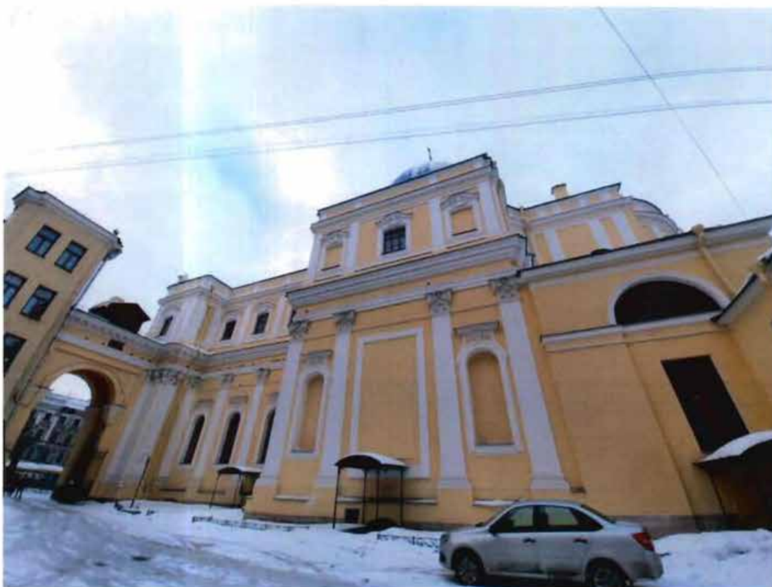
2. Общий вид на восточный фасад объекта культурного наследия (09.02.2022)
