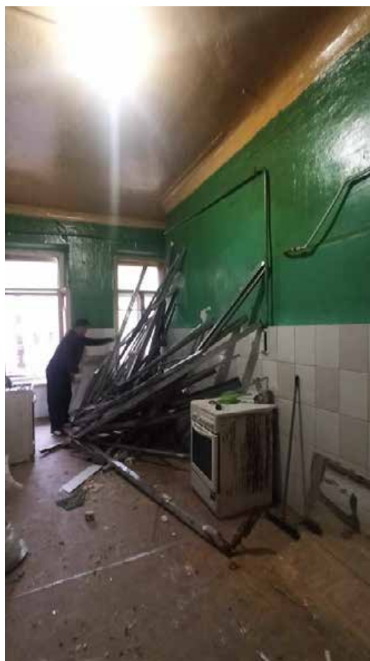
Фото 8. Интерьер квартиры № 2 выявленного объекта культурного наследия «Дом И.Д. Агафонова»
