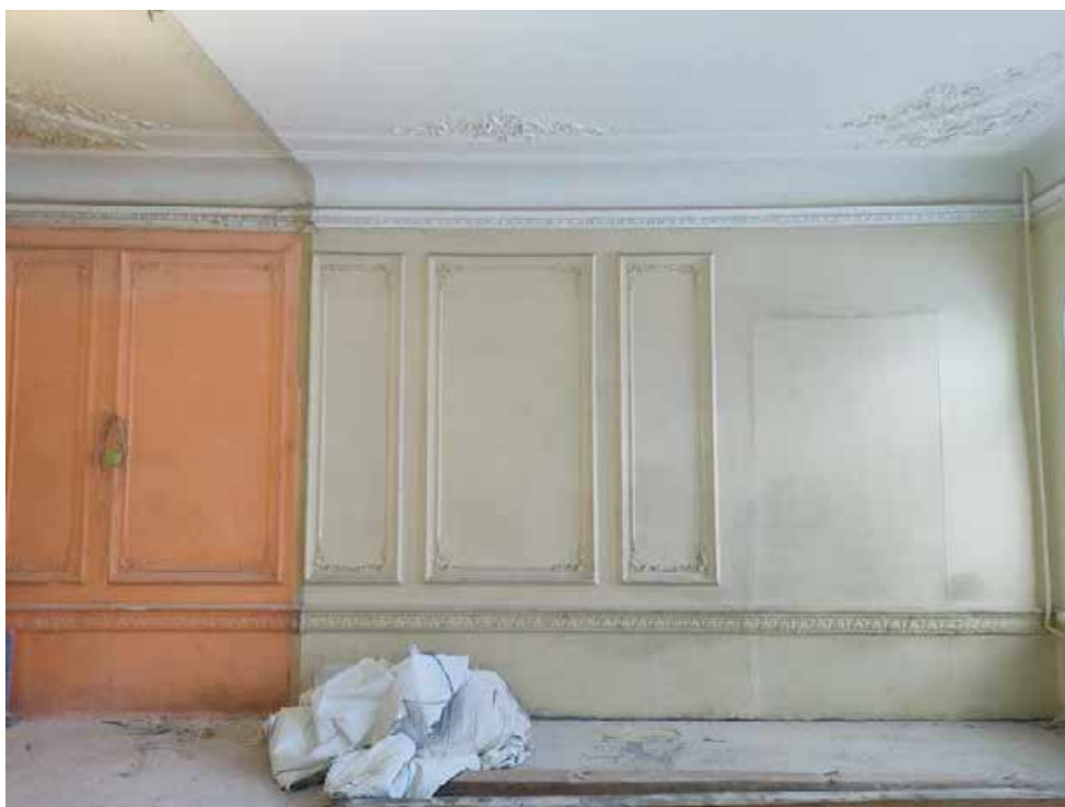
Фото 16. Интерьер квартиры № 2 выявленного объекта культурного наследия «Дом И.Д. Агафонова»
