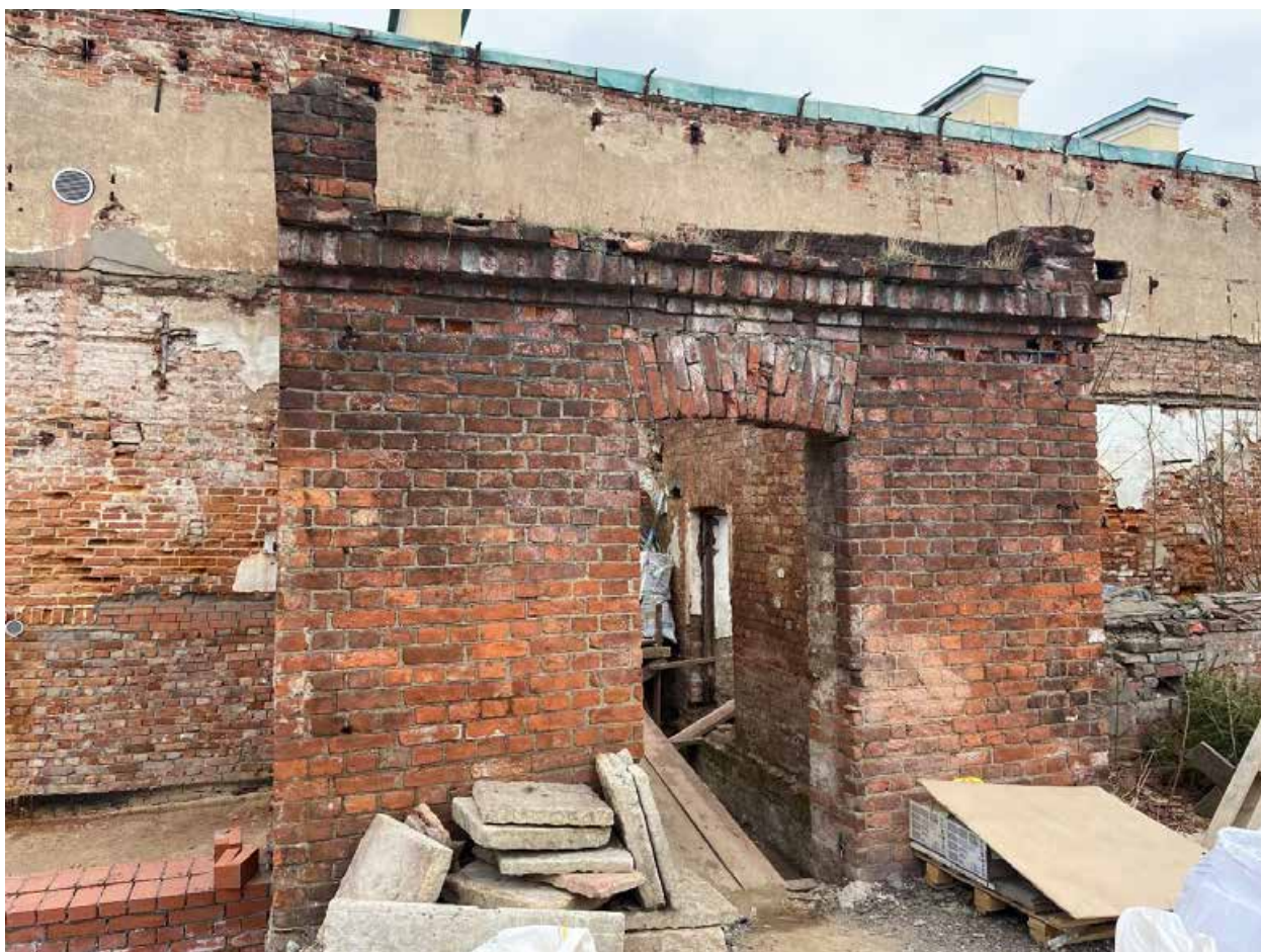
Фото 5. Вид на частъ обьекта с юга.
