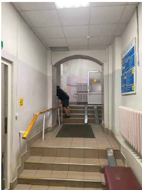
Фото 42. Помещение входной группы.
