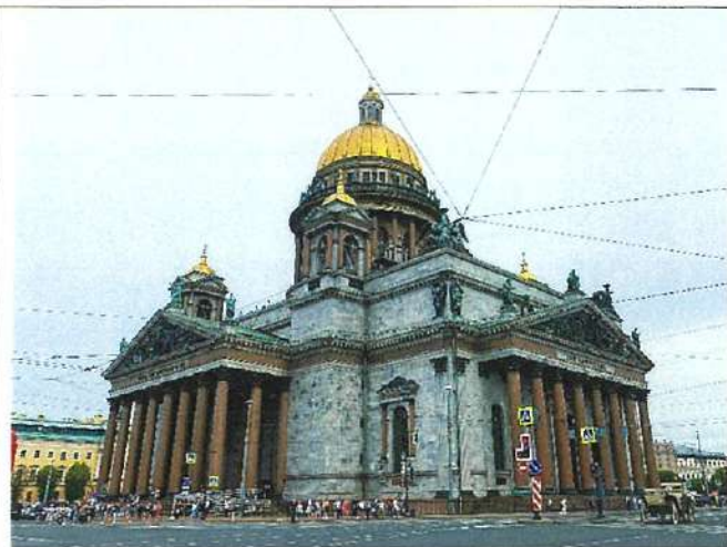
Вид на объект с запада.
