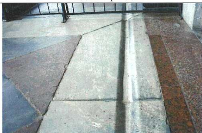
Покрытие пола портика.
