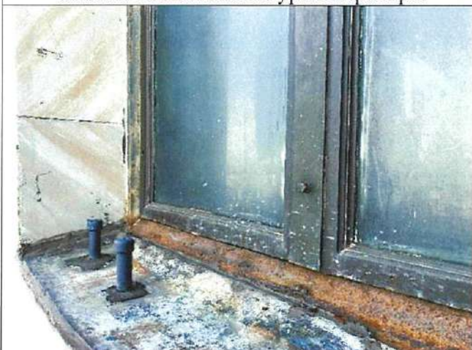
Оконное заполнение в уровне балюстрады.
