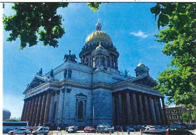
Вид на объект с севера.
