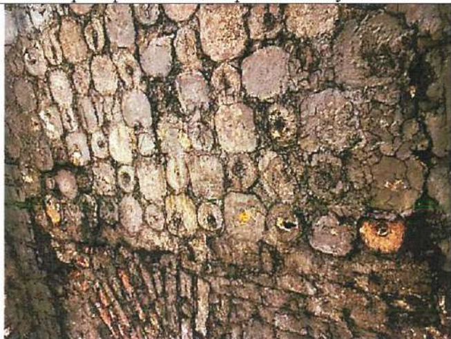
Заполнение конической части купола.
