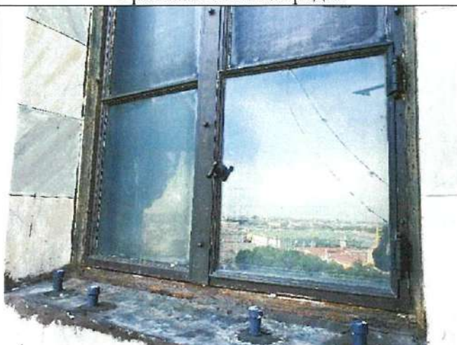
Оконное заполнение в уровне балюстрады.
