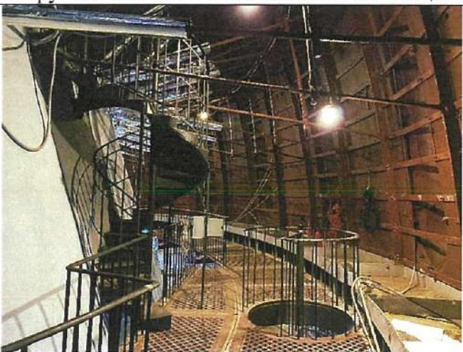
Конструкция центрального купола. Винтовые металлические лестницы.
