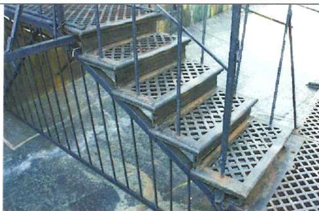
Кровля. Металлическая лестница восхода.
