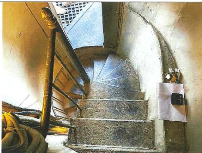
Винтовая металлическая лестница.
