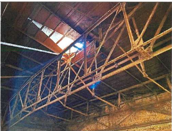
Мезонин-надстройка. Фрагмент конструкции крыши.
