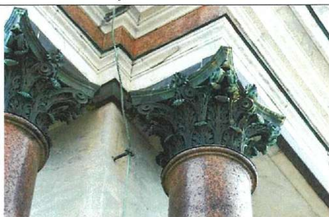
Фрагмент фасада звонницы.
