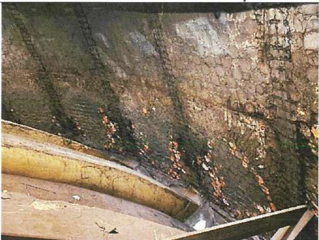
Заполнение конической части купола.
