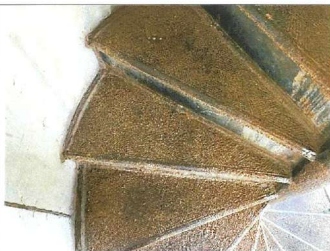
Наружная винтовая металлическая лестница.
