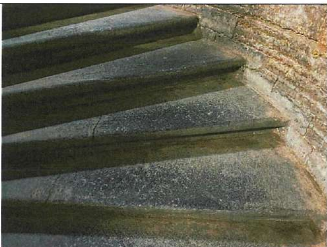
Винтовая лестница с гранитными ступенями.
