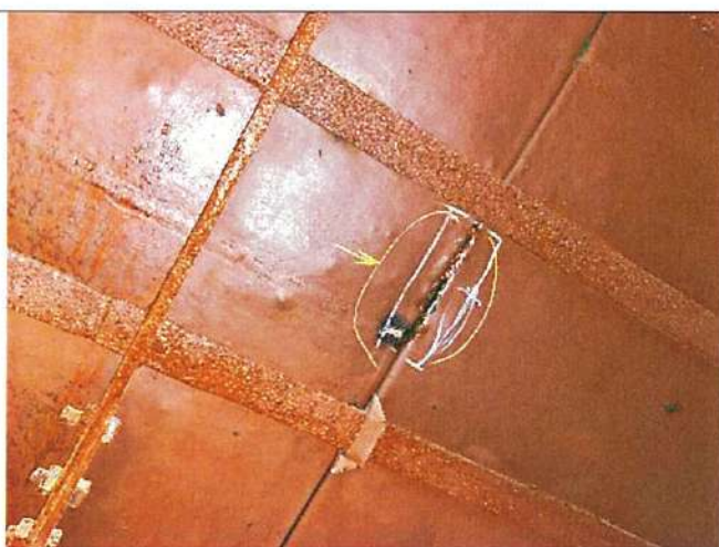
Мезонин-надстройка. Фрагмент конструкции крыши.
