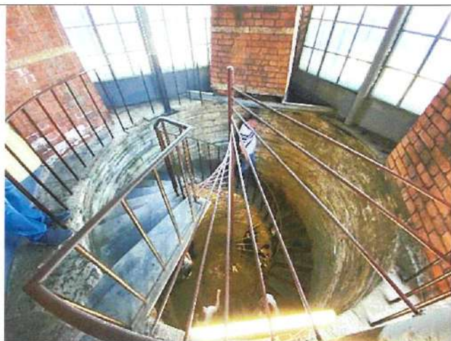
Винтовая лестница с гранитными ступенями в западной части собора.
