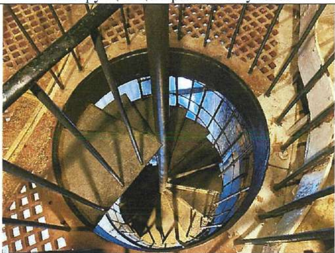
Винтовая металлическая лестница. Центральный купол.
