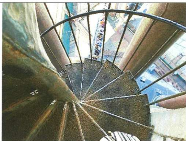
Наружная винтовая металлическая лестница.
