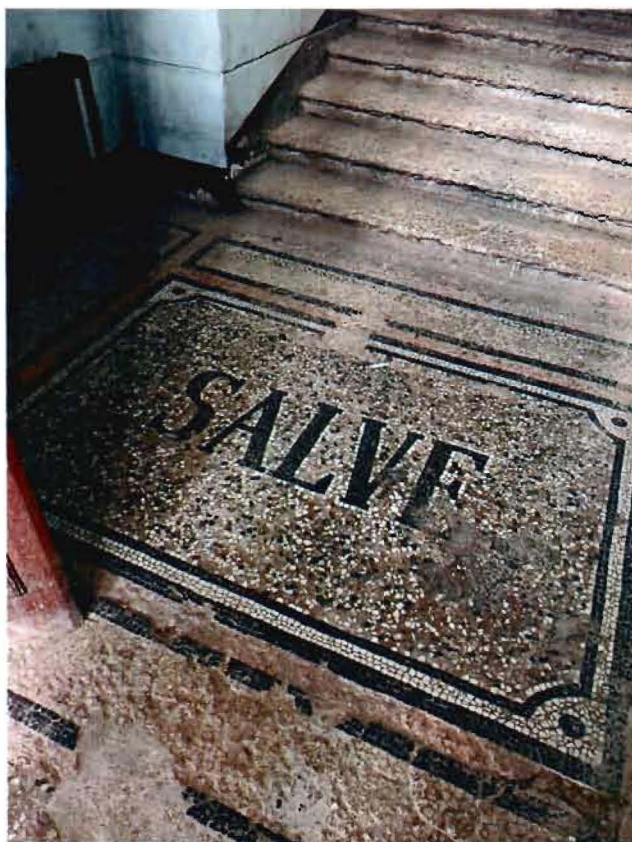
23. 2ЛК. Вестибюль. Отделка пола.
