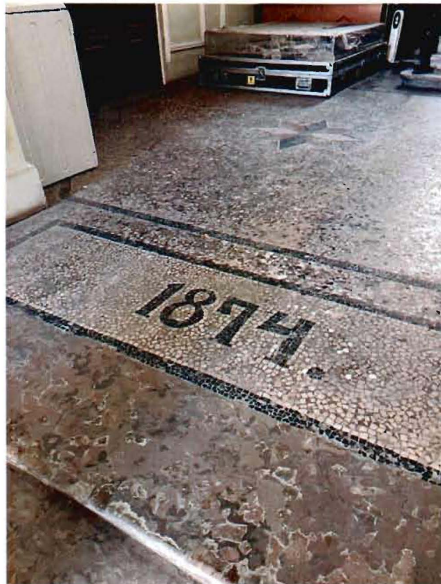
20. 1ЛК в уровне 1-го этажа. Отделка пола.
