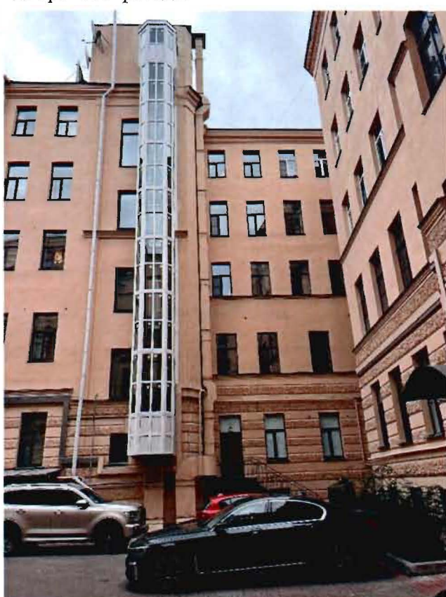
9. Северная часть восточного дворового фасада.
