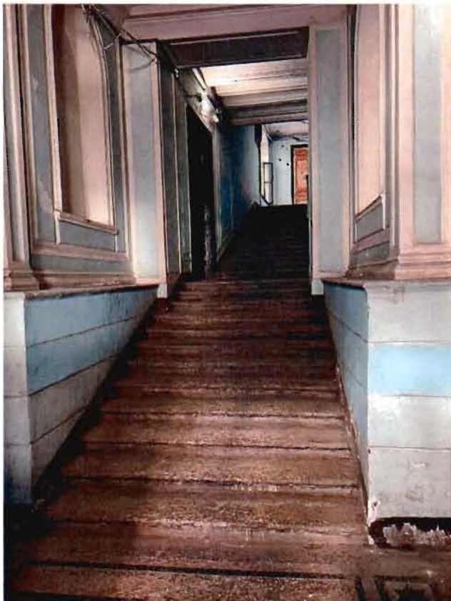
22. 2ЛК. Вестибюль. Оформление стен. Прусские своды.
