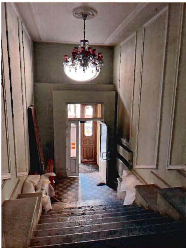
19. 1ЛК. Вестибюль. Отделка пола.
