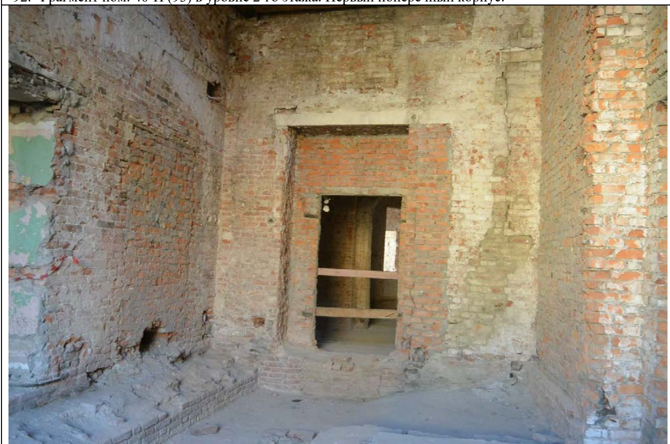
93. Общий вид пом. 40-Н (93) в уровне 2-го этажа. Первый поперечный корпус.
