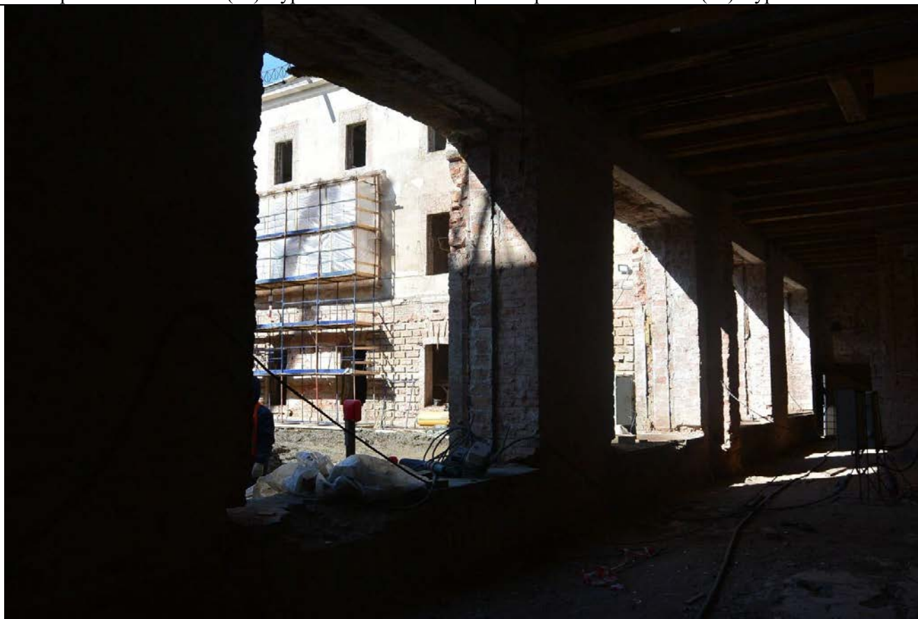
45. Общий вид пом. 37-Н (59) в уровне 1-го этажа. Вестибюль в центральной части восточного лицевого корпуса.
