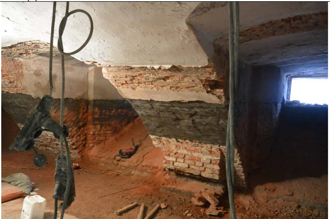
32. Фрагмент пом. 7-Н (39-42) в уровне подвального этажа. Центральная часть восточного лицевого корпуса.
