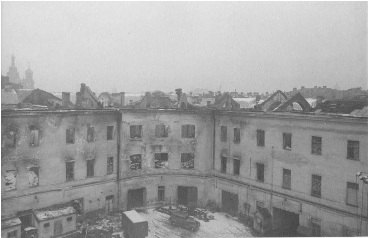
Илл. 75. Ленэнерго. Бывшие Павловские казармы. Разрушение дворового корпуса от пожара, вызванного разрывом артиллерийского снаряда 4-го марта 1942 г. Научно-методический отдел КГИОП. Фототека отд. охраны памятников. № 11848/1. 19 февраля 1944 г.
