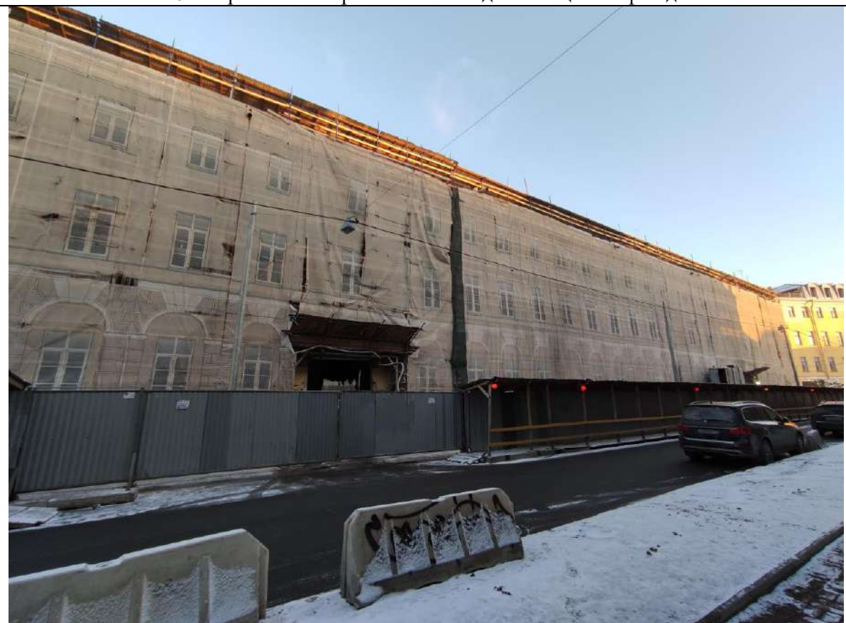
10. Общий вид западного лицевого фасада по Аптекарскому переулку.
