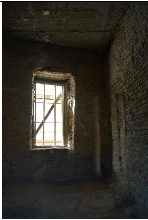
102. Фрагмент пом. 40-Н (61) в уровне 2-го этажа. Центральная часть западного лицевого корпуса.
