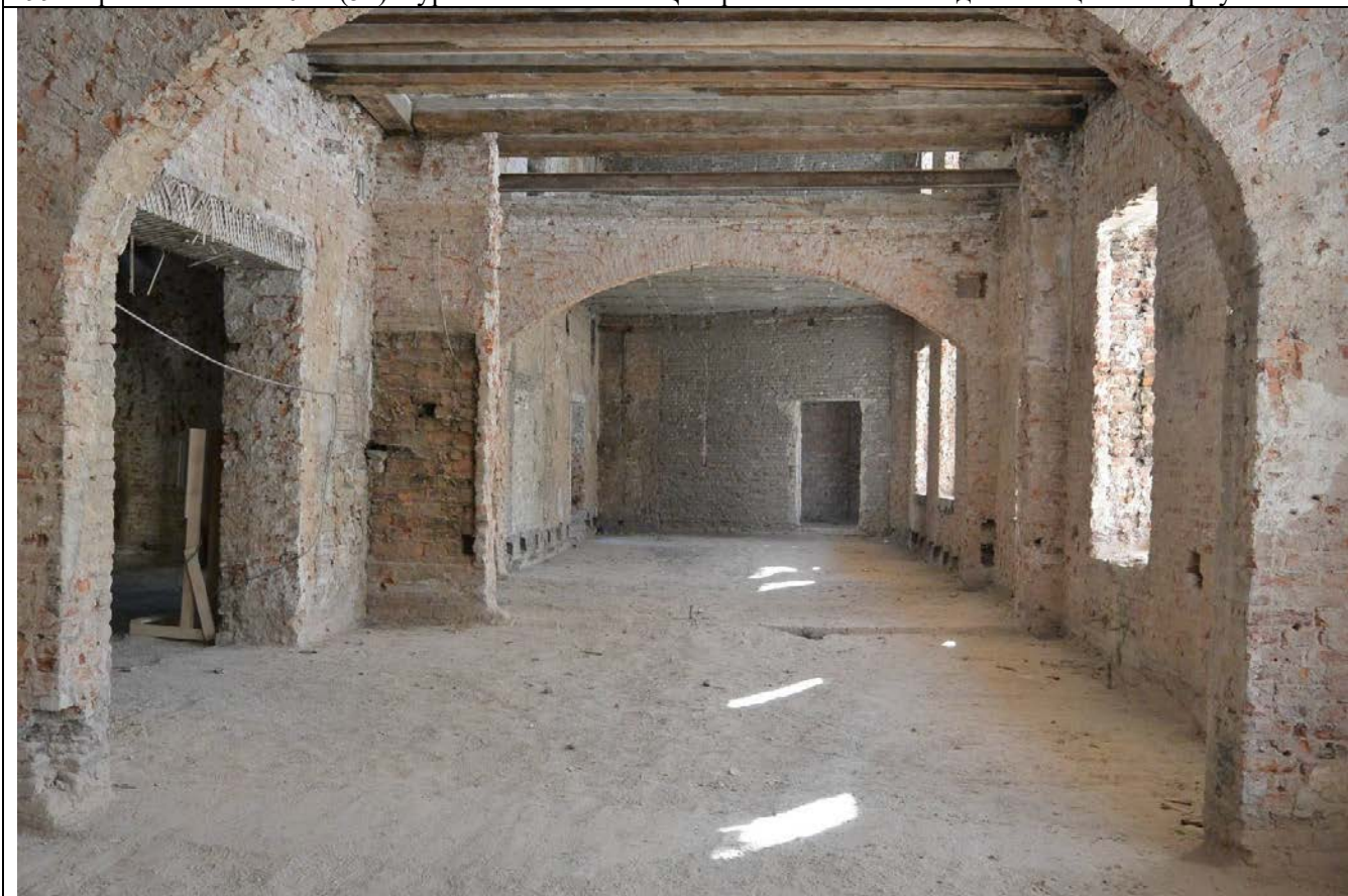
100. Общий вид пом. 40-Н (55, 56, 57) в уровне 2-го этажа. Центральная часть западного лицевого корпуса.
