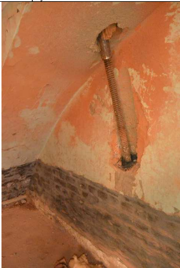
22. Фрагмент пом. 19-Н (10) в уровне подвального этажа. Северная часть восточного лицевого корпуса.
