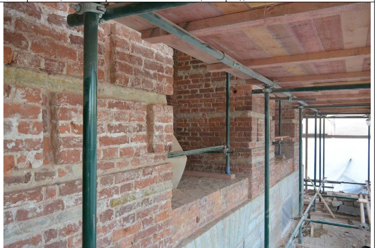
4. Фрагмент северной части восточного лицевого фасада в уровне 1-го этажа.
