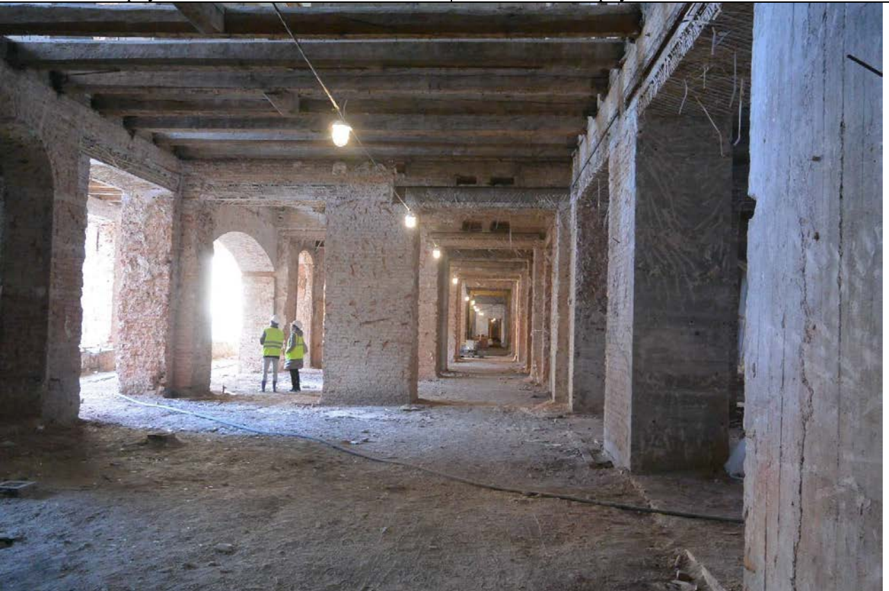
42. Общий вид пом. 37-Н (44, 45, 46, 53) в уровне 1-го этажа. Вестибюль в центральной части восточного лицевого корпуса.
