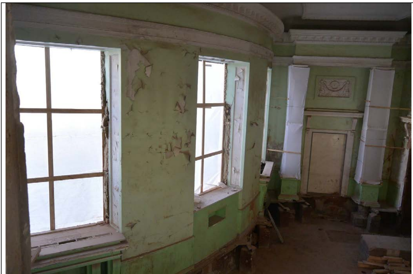
105. Общий вид пом. 38-Н (8). Центральная часть западного лицевого корпуса.
