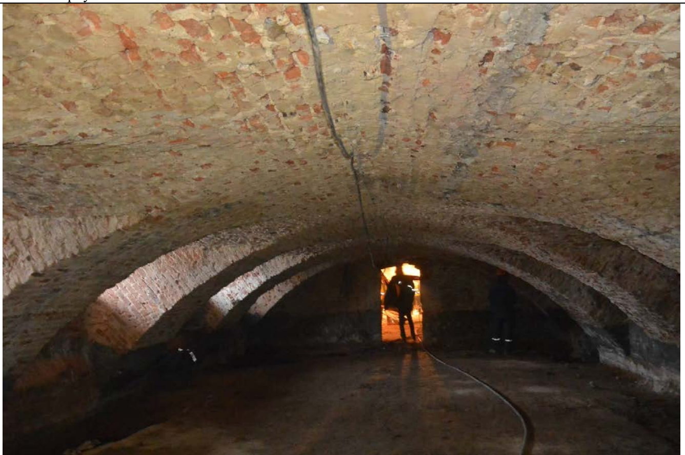
25. Общий вид пом. 7-Н (30, 31) в уровне подвального этажа. Центральная часть восточного лицевого корпуса.
