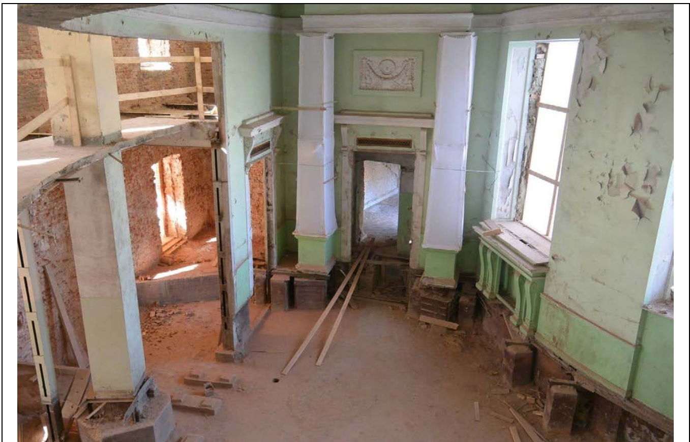
107. Общий вид пом. 38-Н (8) в уровне 2-го этажа. Центральная часть западного лицевого корпуса.
