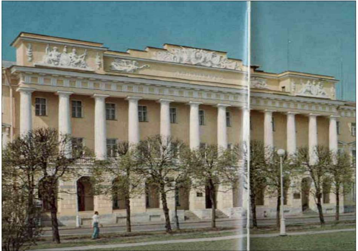
Илл. 86. Центральный портик восточного фасада. Лепной декор с гербом СССР. 1983 г. //Кедринский А.А., Колотов М.Г., Ометов Б.Н., Раскин А.Г. Восстановление памятников архитектуры Ленинграда.-Л., 1983.- С. 235-236.
