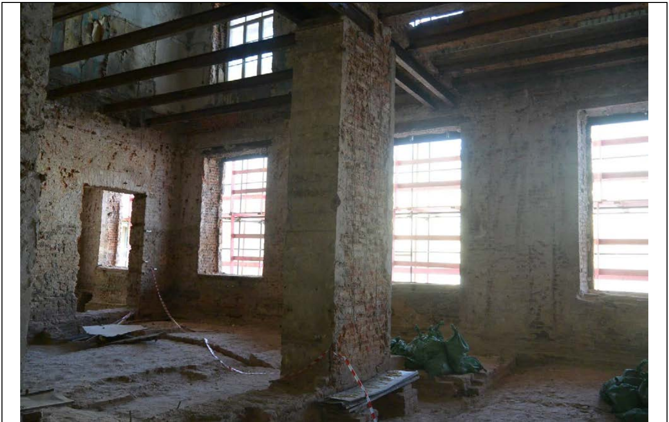
89. Общий вид пом. 40-Н (90) в уровне 2-го этажа. Первый поперечный корпус.
