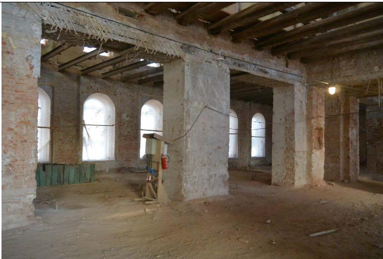
55. Общий вид пом. 33-Н (7, 8, 16) в уровне 1-го этажа. Северная часть восточного лицевого корпуса.
