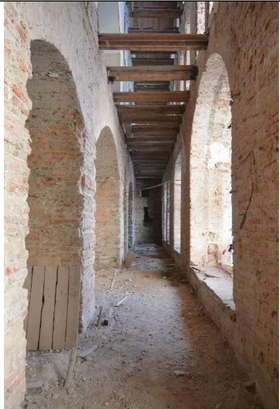
61. Общий вид пом. 33-Н (11, 12, 13, 14, 15) в уровне 1-го этажа. Северная часть восточного лицевого корпуса.
