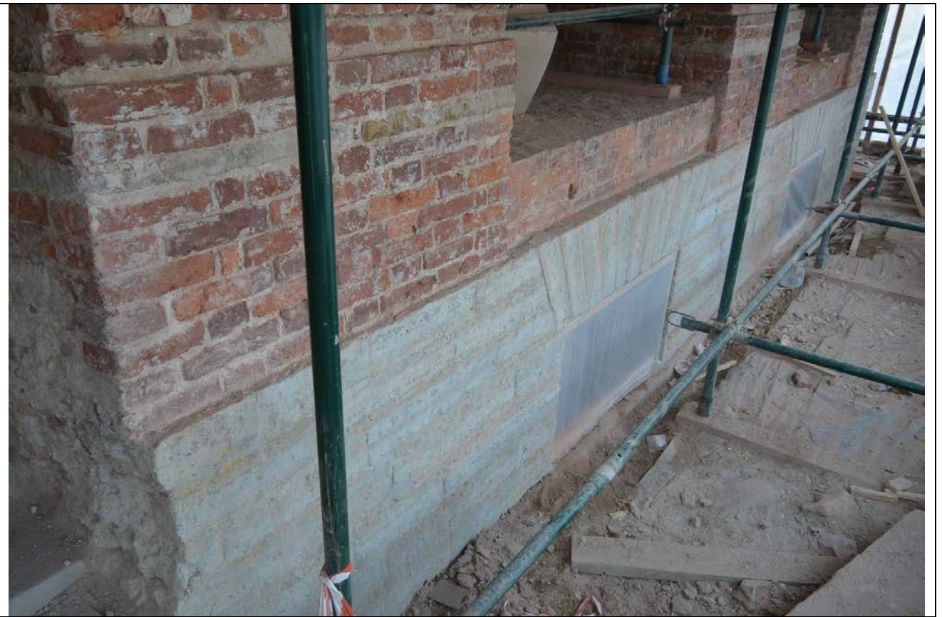
3. Фрагмент цоколя в северной части восточного лицевого фасада.
