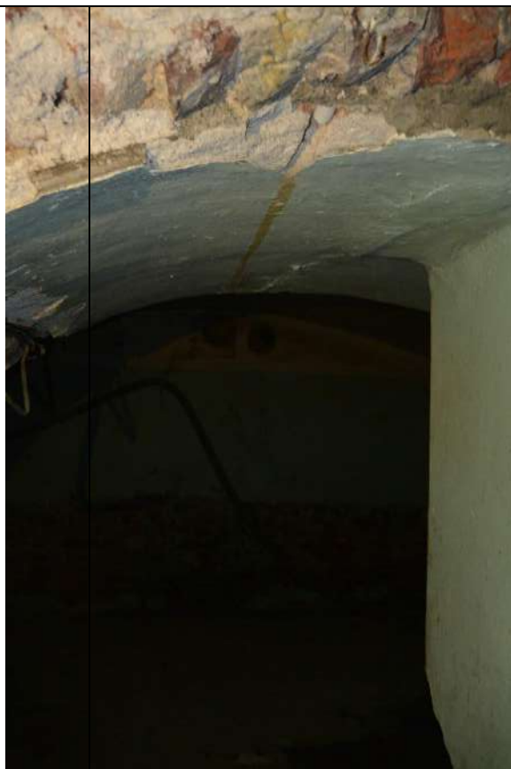
16. Фрагмент пом. 6-Н (3) в уровне подвального этажа. Северная часть восточного лицевого корпуса.
