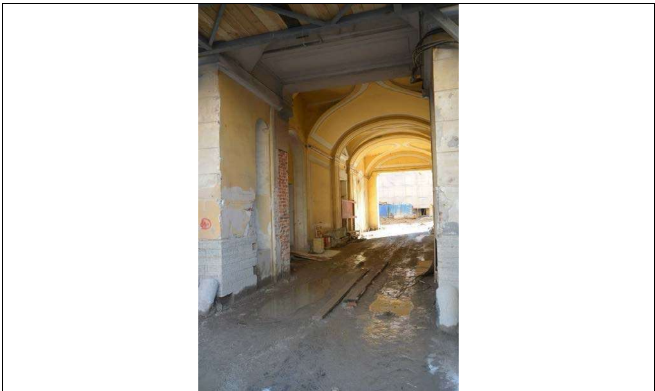
7. Общий вид проездной арки северного лицевого корпуса.
