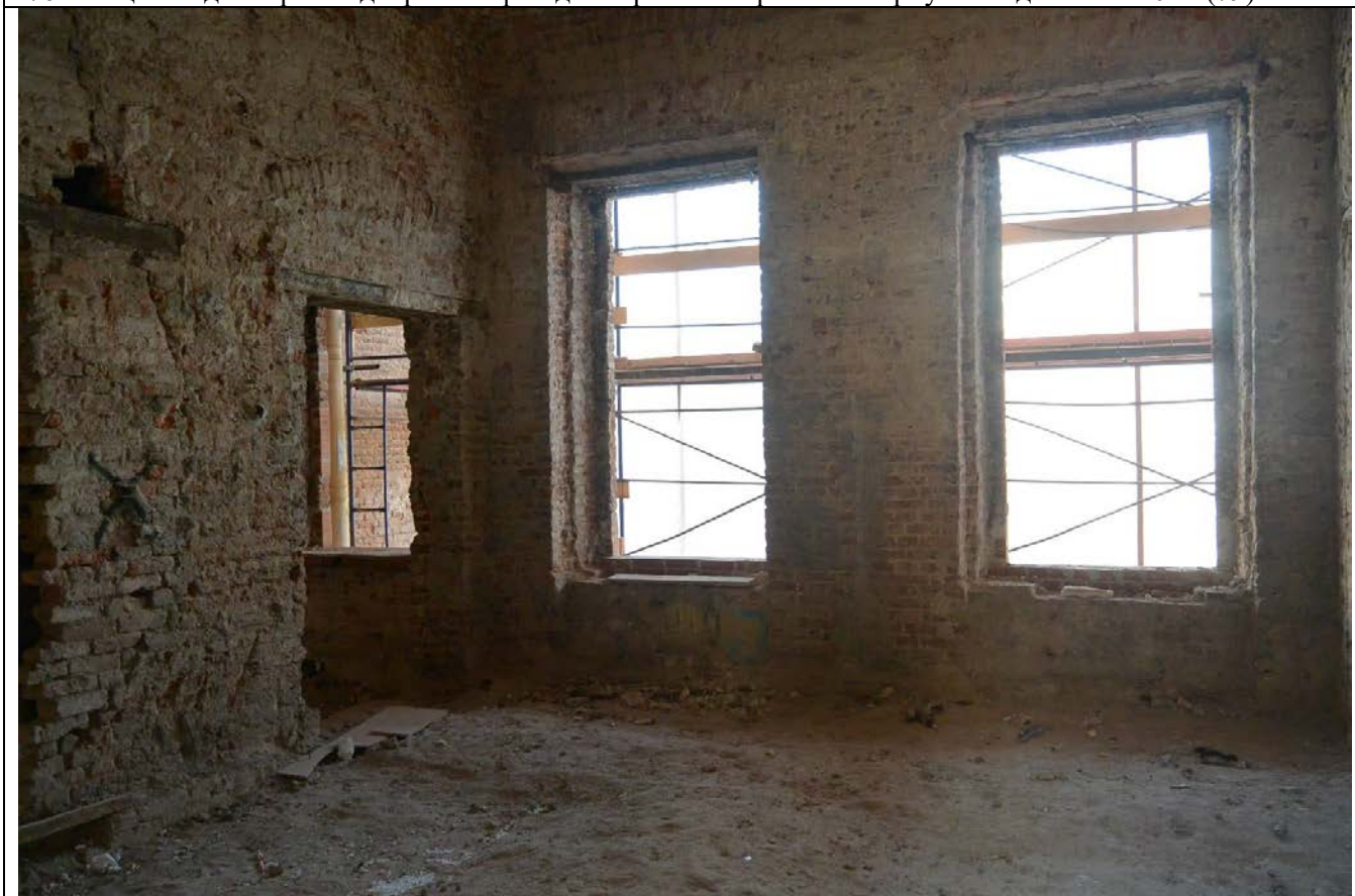
77. Общий вид пом. 40-Н (80, 81, 82) в уровне 2-го этажа. Первый поперечный корпус.
