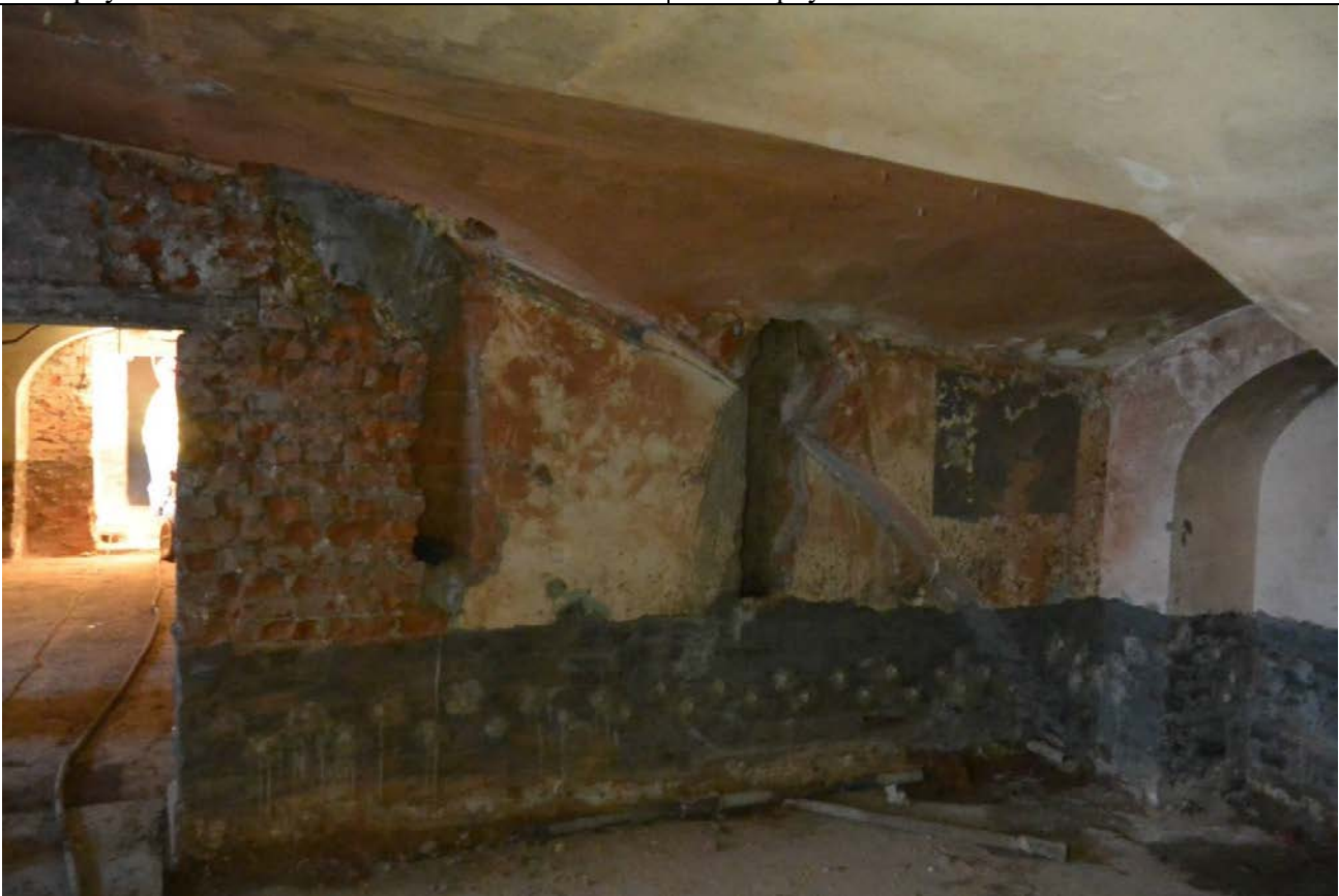
20. Фрагмент 19-Н (9) в уровне подвального этажа. Северная часть восточного лицевого корпуса.
