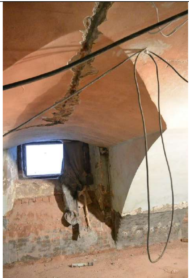
23. Фрагмент пом. 19-Н (10) в уровне подвального этажа. Северная часть восточного лицевого корпуса.
