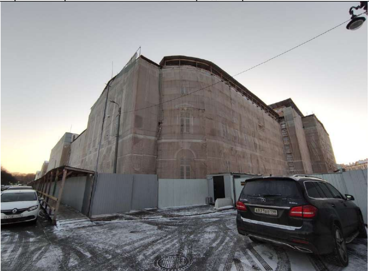
6. Вид на угловую часть восточного и северного лицевых фасадов со стороны Миллионной улицы.
