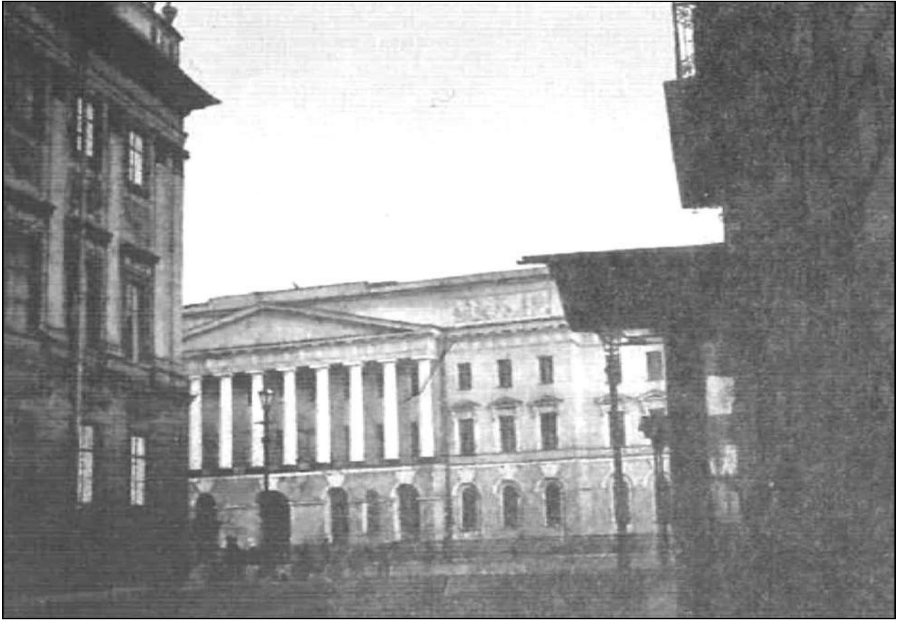
Илл. 64. Северный фасад. 1900-е гг. // Лукомский Г.К. Старый Петербург. Переиздание. СПб. 2003.
