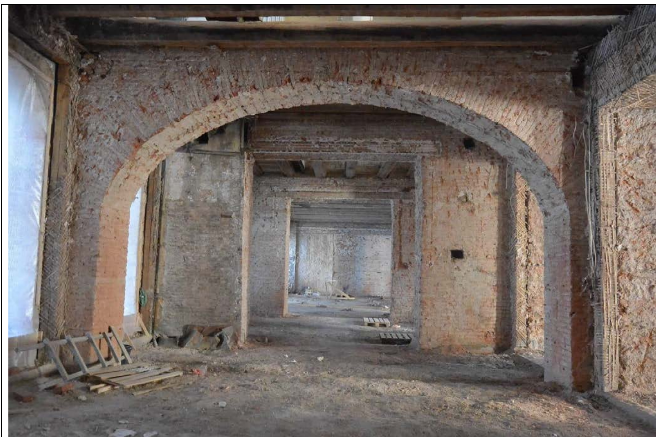
49. Общий вид пом. 37-Н (52, 55, 56, 57, 58) в уровне 1-го этажа. Вестибюль в центральной части восточного лицевого корпуса.
