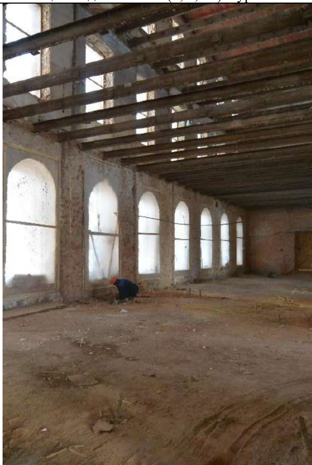
56. Общий вид пом. 33-Н (3, 4, 5, 6, 7) в уровне 1-го этажа. Северная часть восточного лицевого корпуса.
