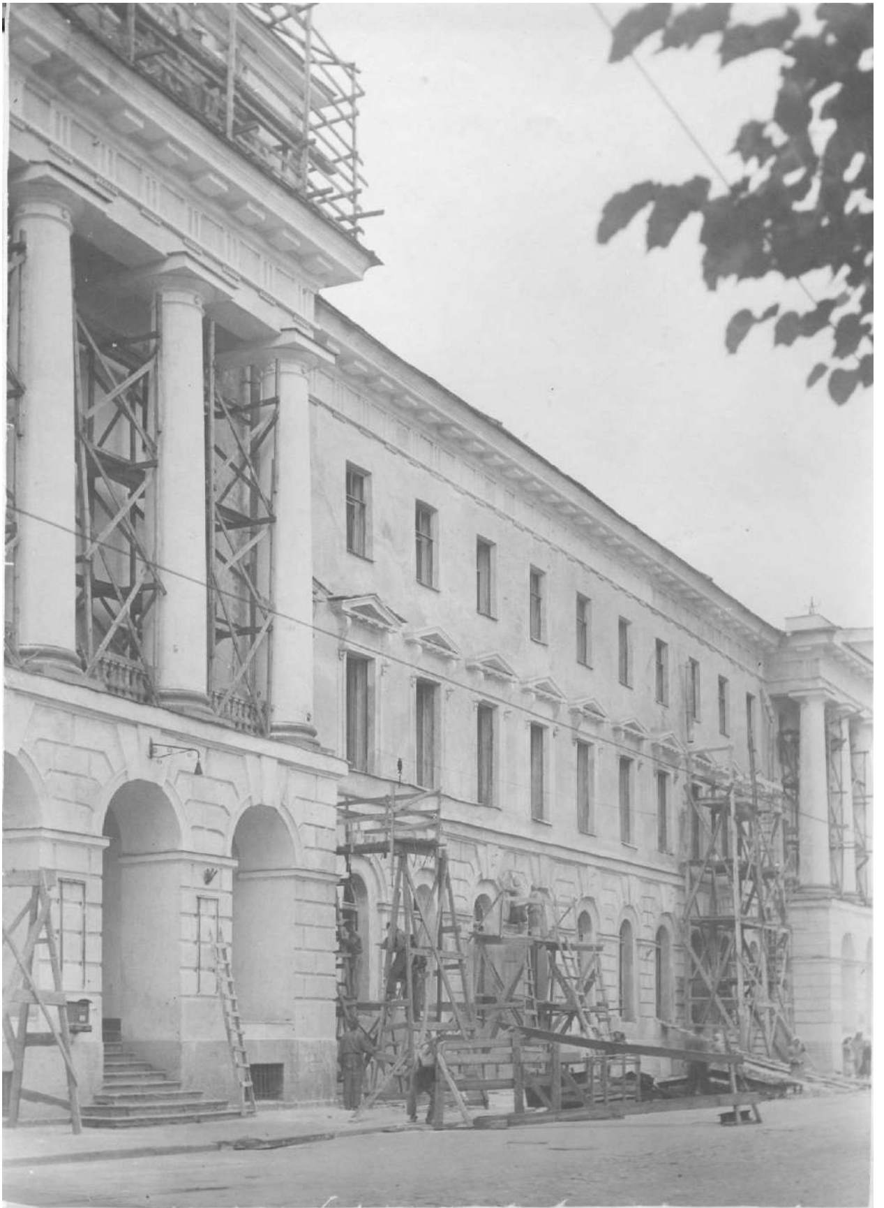
Илл. 83. Здание «Ленэнерго». Реставрация фасада со стороны Марсова поля. Научно-методический отдел КГИОП. Фототека отд. охраны памятников. № 17958/1. 12/VIII 1946 г.
