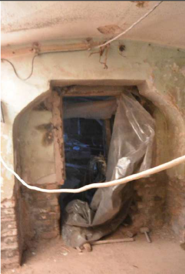
35. Фрагмент пом. 7-Н (45) в уровне подвального этажа. Центральная часть восточного лицевого корпуса.
