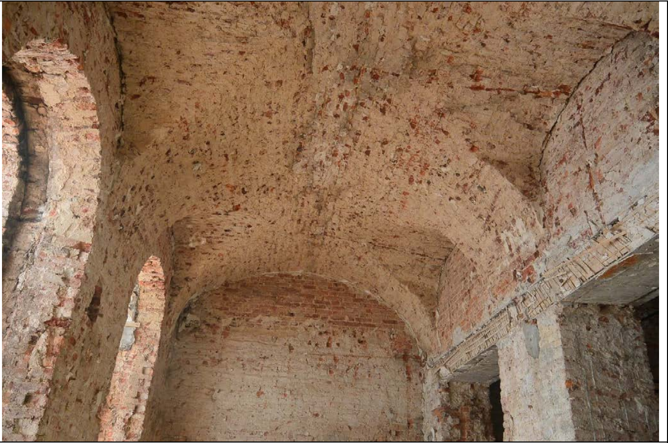
64. Фрагмент пом. 33-Н (50) в уровне 1-го этажа. Восточная часть лицевого корпуса по Миллионной улице.
