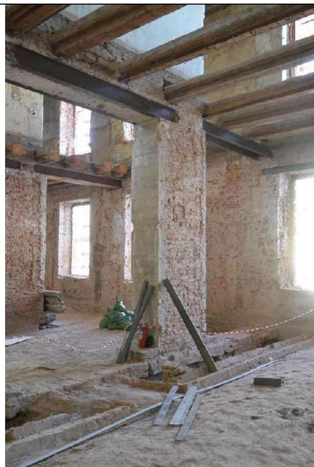
83. Общий вид пом. 40-Н (86) в уровне 2-го этажа. Первый поперечный корпус.
