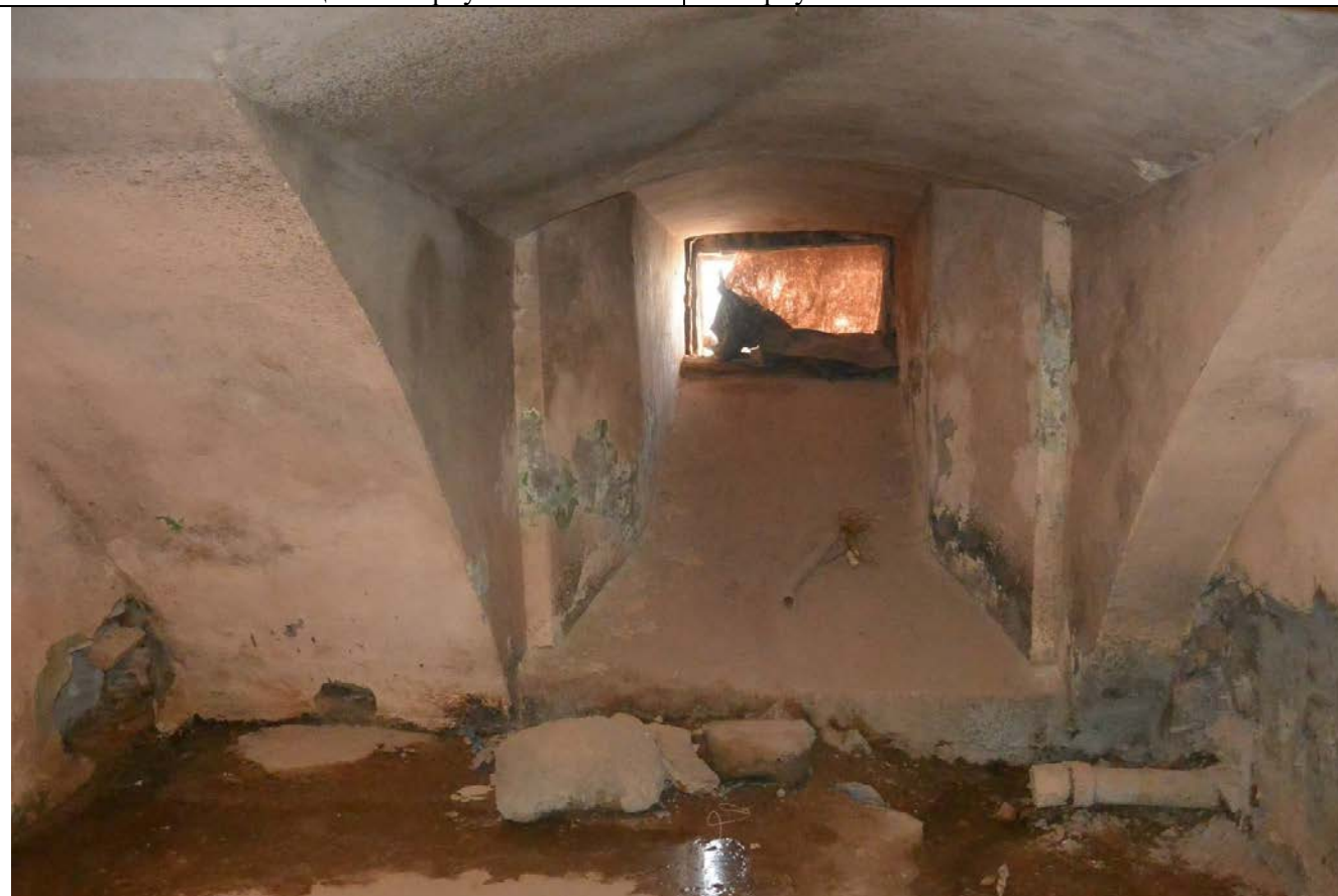
17. Фрагмент пом. 19-Н (7) в уровне подвального этажа. Коробовый свод с распалубкой. Северная часть восточного лицевого корпуса.
