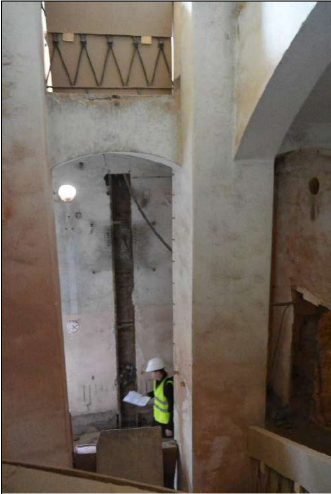
120. Фрагмент пом. Л-10 в уровне 2-го этажа. Южная часть восточного лицевого корпуса.
