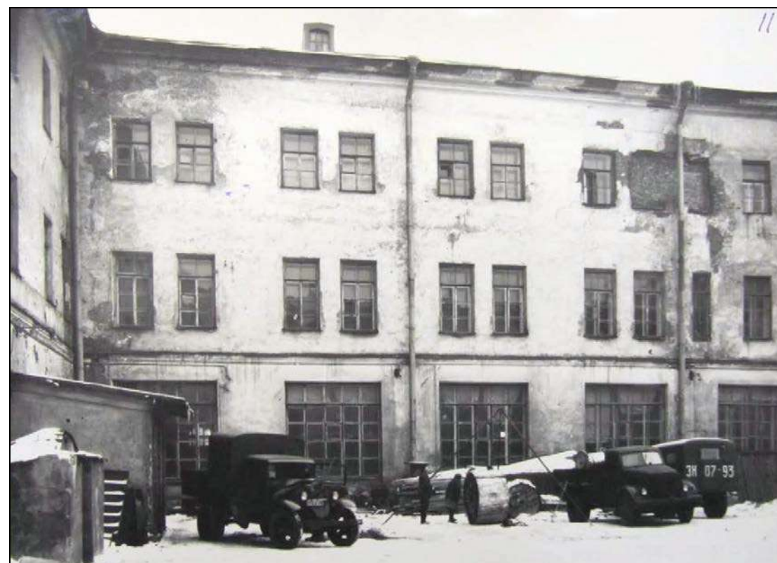
Илл. 81. 2-й двор. Восточный фасад. 1952 г. КГИОП
