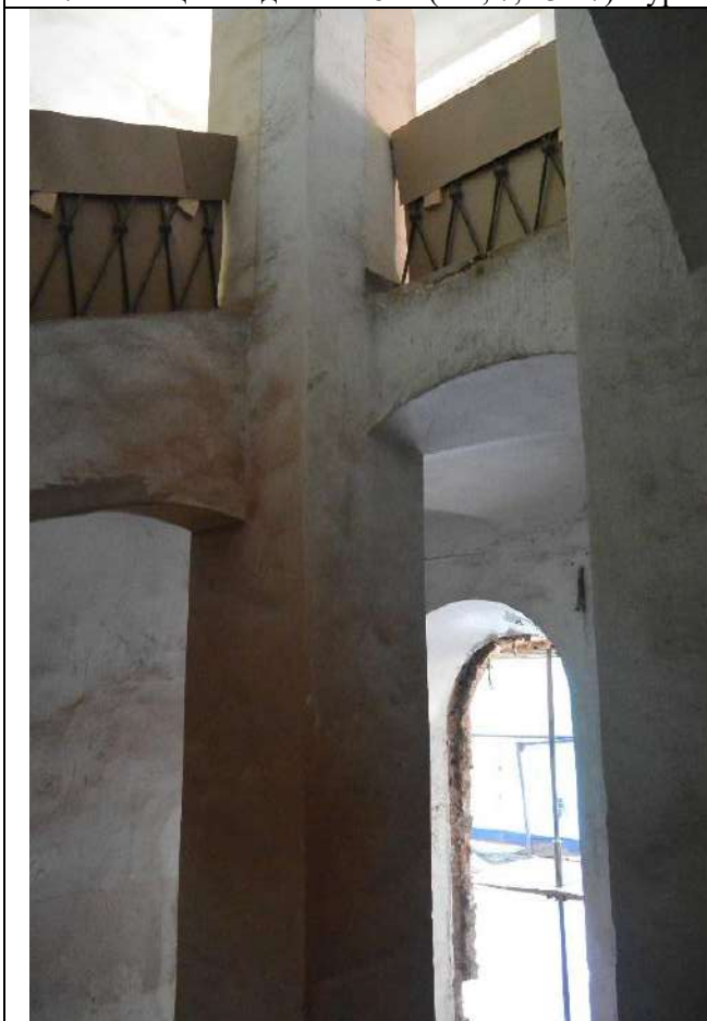
118. Фрагмент пом. Л-10 в уровне 2-го этажа. Южная часть восточного лицевого корпуса.
