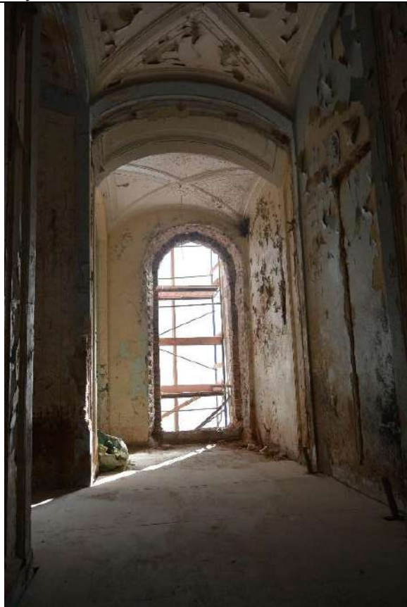
65. Общий вид интерьера тамбура лестницы Л-2 в уровне 1-го этажа. Восточная часть лицевого корпуса по Миллионной улице.
