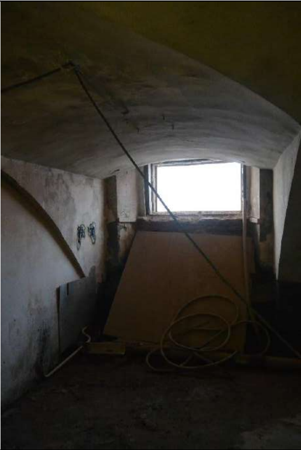
18. Фрагмент пом. 19-Н (9) в уровне подвального этажа. Северная часть восточного лицевого корпуса.
