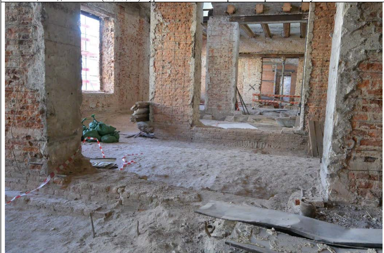
88. Общий вид пом. 40-Н (86, 88) в уровне 2-го этажа. Первый поперечный корпус.
