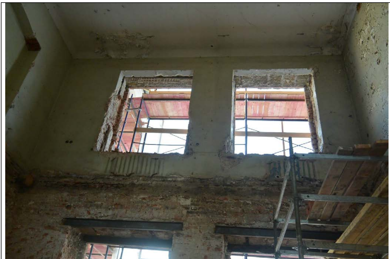
81. Фрагмент пом. 40-Н (85) в уровне 2-го этажа. Вид оконных проемов 3-го этажа. Перекрытие отсутствует. Первый поперечный корпус.
