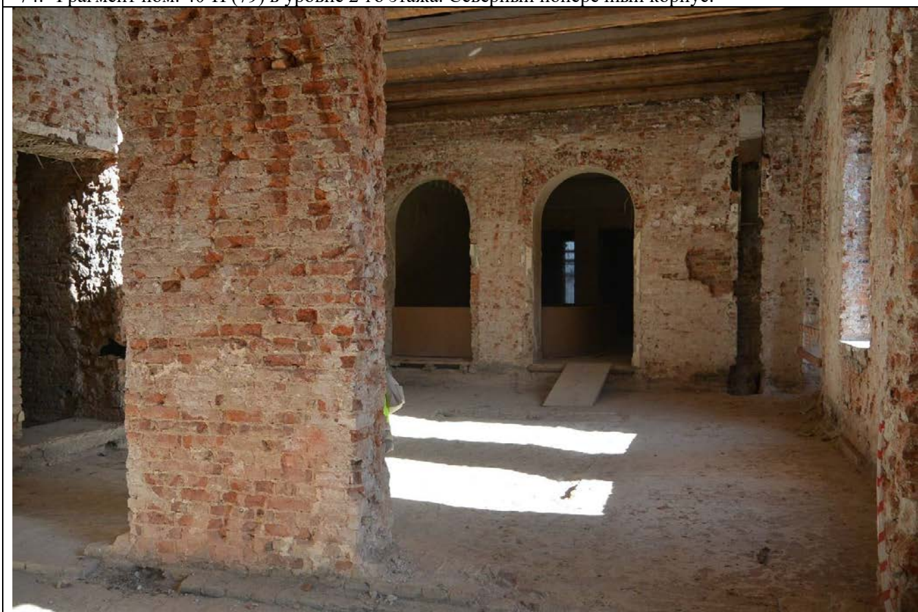
75. Общий вид пом. 40-Н (79) в уровне 2-го этажа. Северный поперечный корпус.
