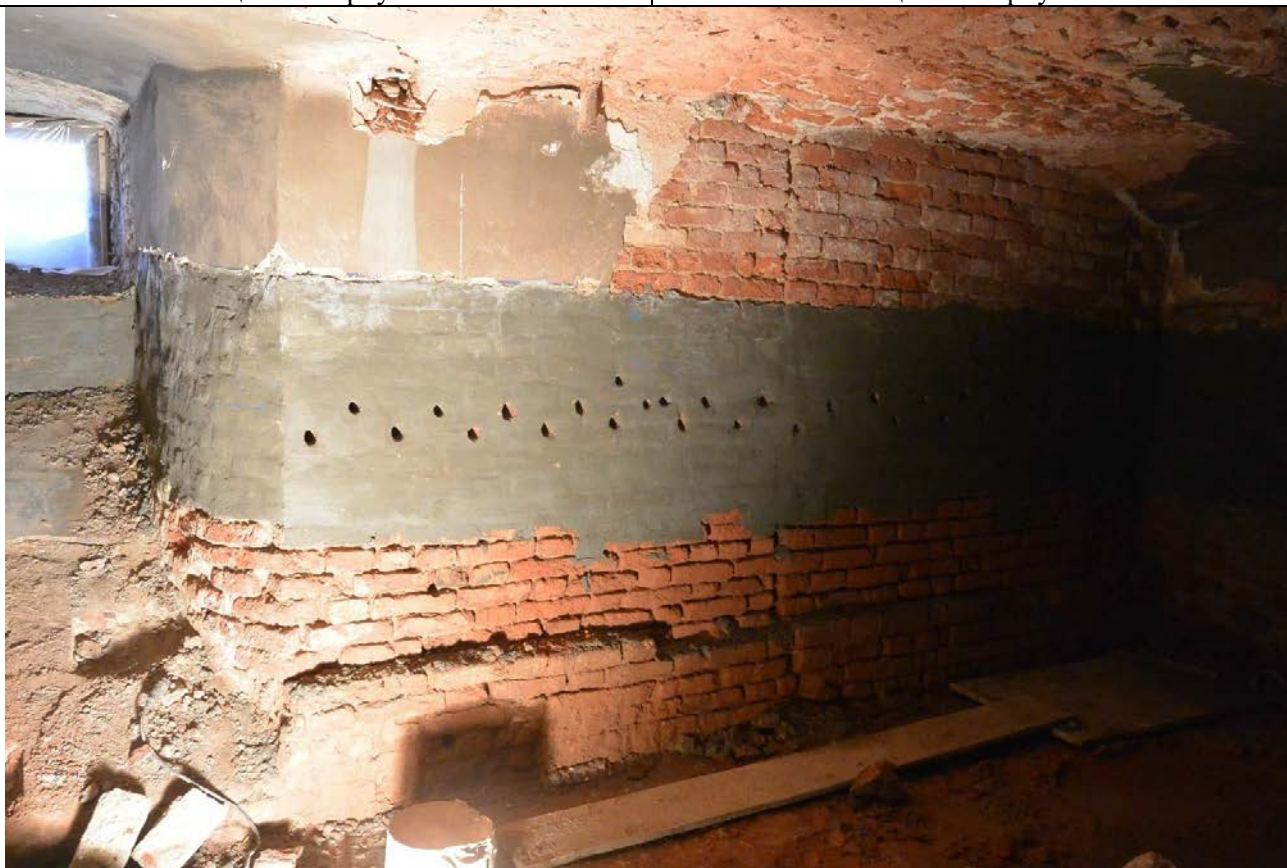
28. Фрагмент пом. 7-Н (29) в уровне подвального этажа. Центральная часть восточного лицевого корпуса.
