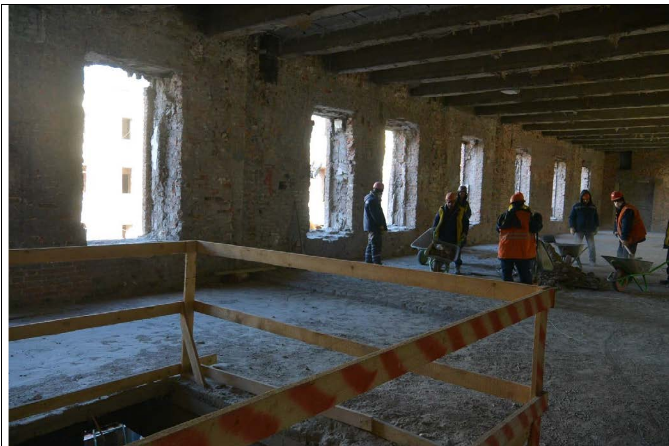
113. Общий вид пом. 48-Н (1, 2, 3, 4, 7, 13, 14, 15, 16, 17) в уровне 2-го этажа. Южный поперечный корпус.
