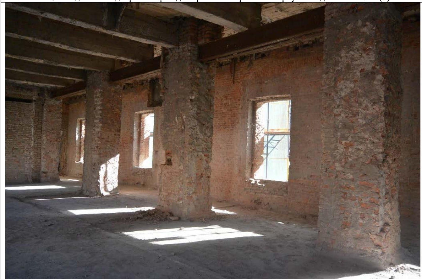
116. Общий вид пом. 48-Н (7, 10, 11, 12, 18) в уровне 2-го этажа. Второй поперечный корпус.
