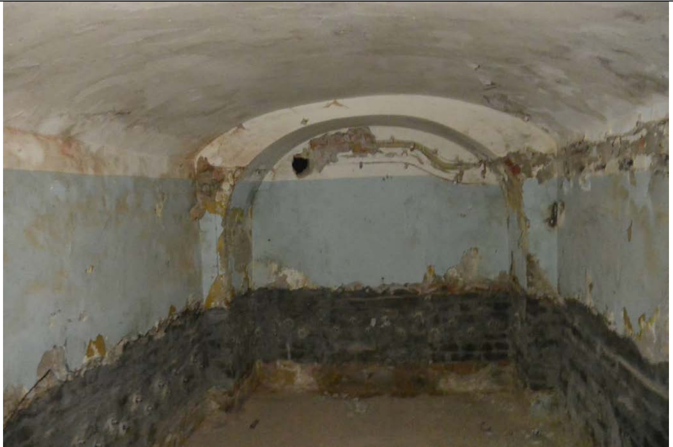
24. Фрагмент пом. 7-Н (32) в уровне подвального этажа. Северная часть восточного лицевого корпуса.
