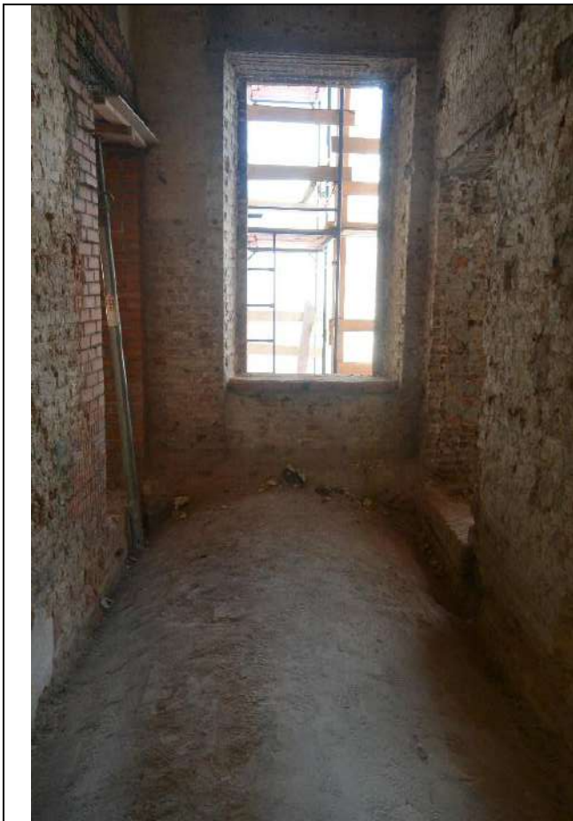
78. Общий вид пом. 40-Н (83) в уровне 2-го этажа. Первый поперечный корпус.
