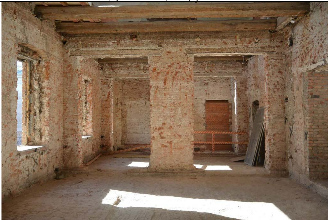
73. Общий вид пом. 40-Н (79) в уровне 2-го этажа. Северный поперечный корпус.
