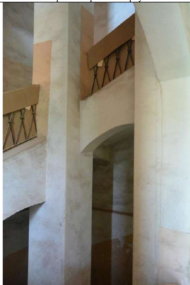
119. Фрагмент пом. Л-10 в уровне 2-го этажа. Южная часть восточного лицевого корпуса.
