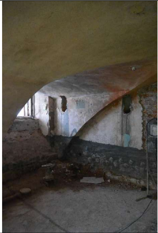
19. Фрагмент 19-Н (9) в уровне подвального этажа. Северная часть восточного лицевого корпуса.
