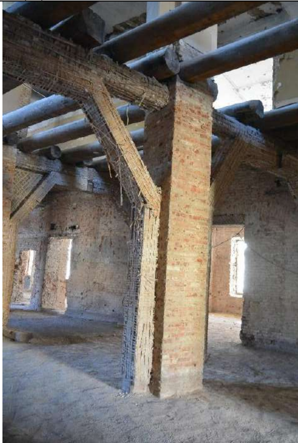
95. Общий вид пом. 40-Н (69) в уровне 2-го этажа. Центральная часть западного лицевого корпуса.
