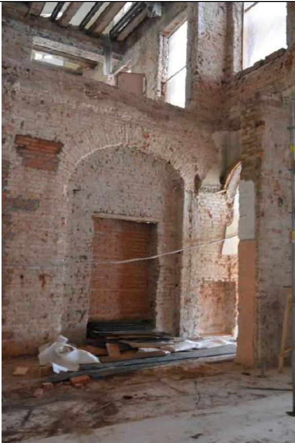
62. Фрагмент пом. 33-Н (21) в уровне 1-го этажа. Северная часть восточного лицевого корпуса.
