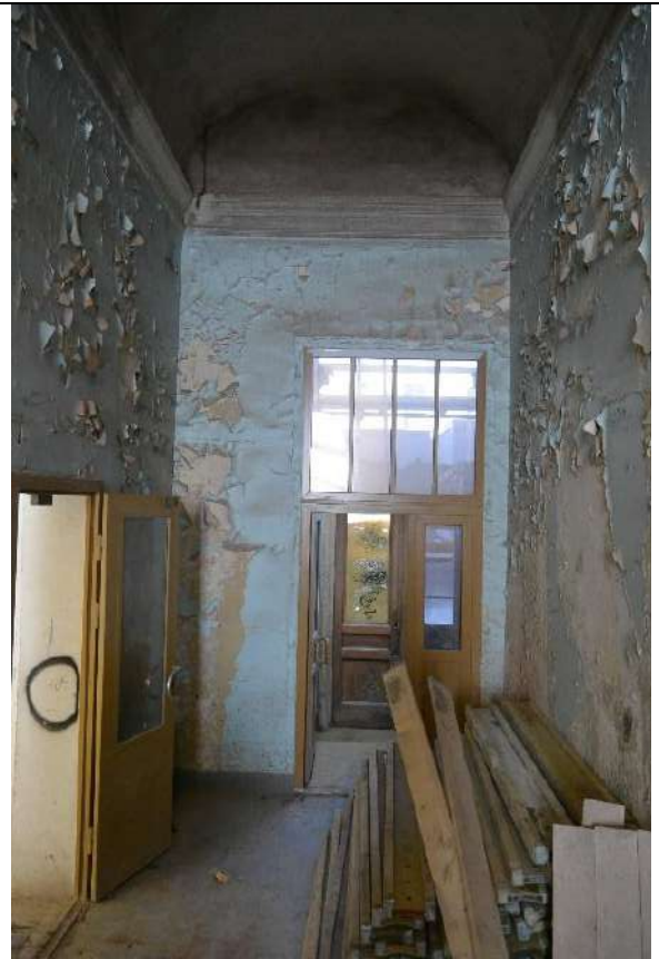
66. Общий вид интерьера тамбура лестницы Л-2 в уровне 1-го этажа. Восточная часть лицевого корпуса по Миллионной улице.
