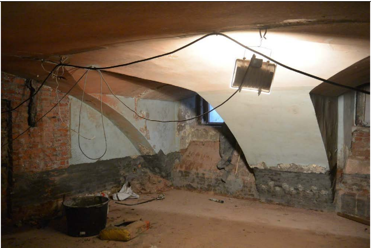
21. Фрагмент пом. 19-Н (10) в уровне подвального этажа. Северная часть восточного лицевого корпуса.
