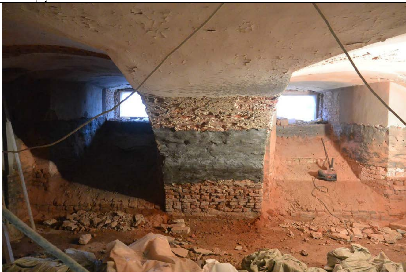
34. Фрагмент пом.7-Н (45) в уровне подвального этажа. Центральная часть восточного лицевого корпуса.
