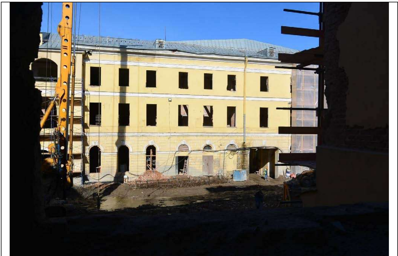
94. Общий вид южного фасада северного лицевого корпуса по Миллионной улице. Вид из пом. 40-Н (95).
