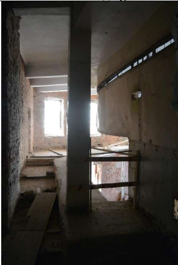
108. Фрагмент пом. 38-Н (8) в уровне 2-го этажа. Центральная часть западного лицевого корпуса.
