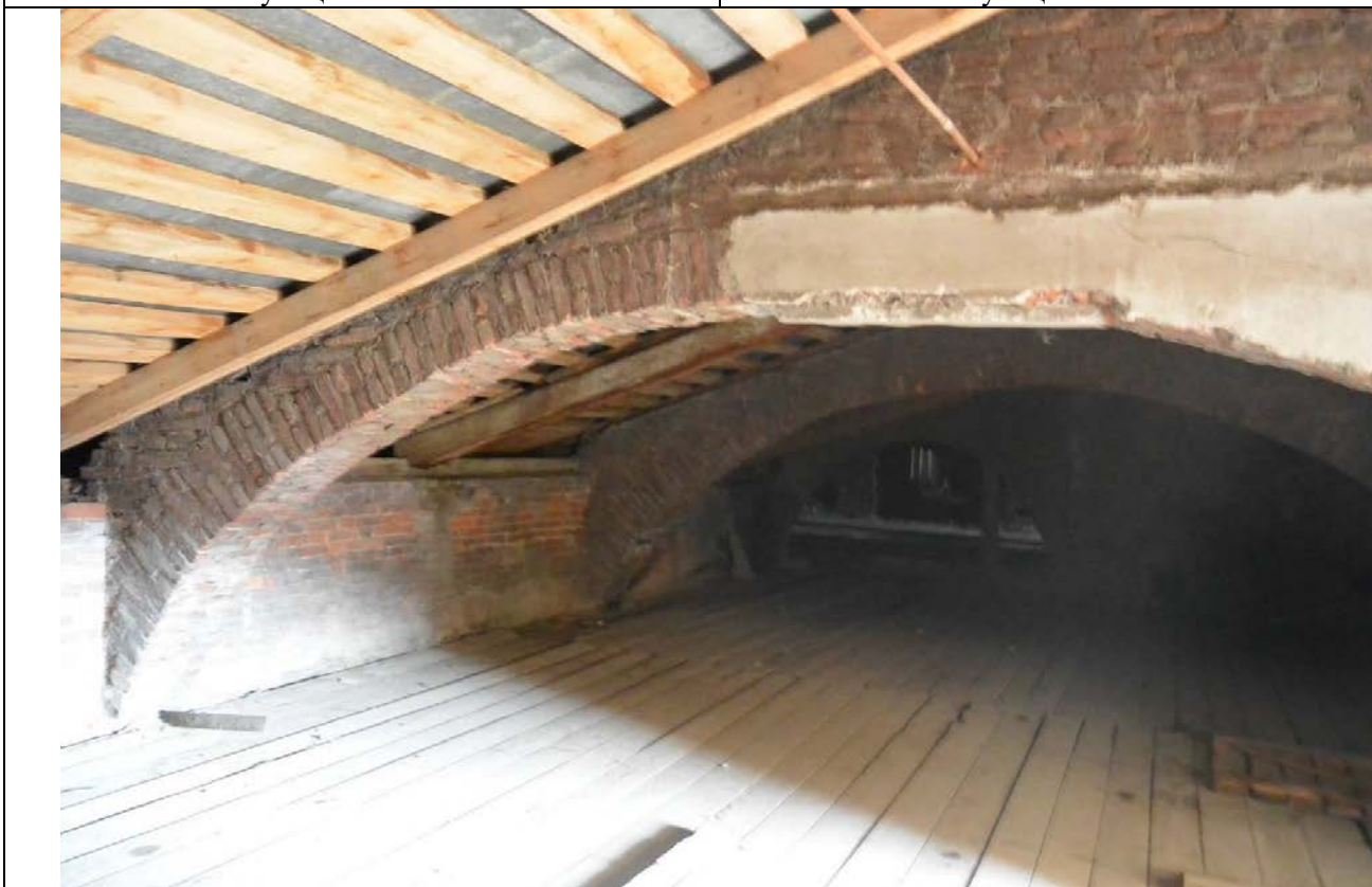
124. Фрагмент конструктивной системы кровли северного лицевого корпуса по Миллионной улице.
