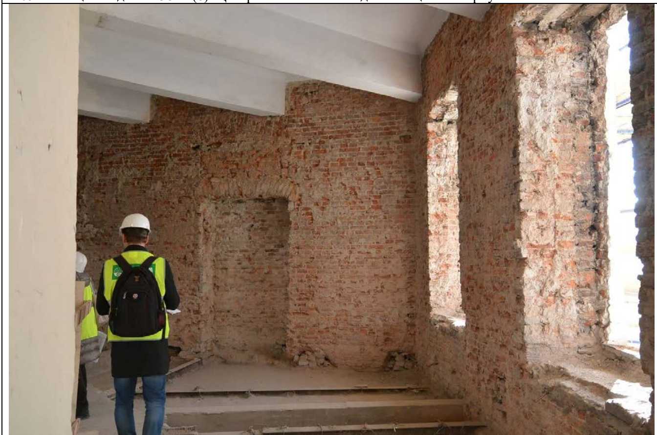
106. Фрагмент пом. 38-Н (8) в уровне 2-го этажа. Центральная часть западного лицевого корпуса.
