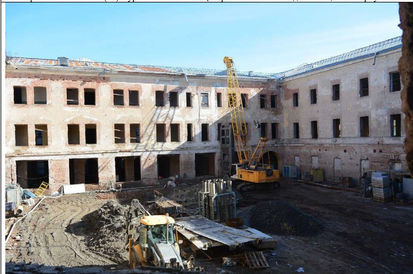
98. Общий вид западного дворового фасада центральной части восточного лицевого корпуса. Вид со стороны пом. 40-Н (68).
