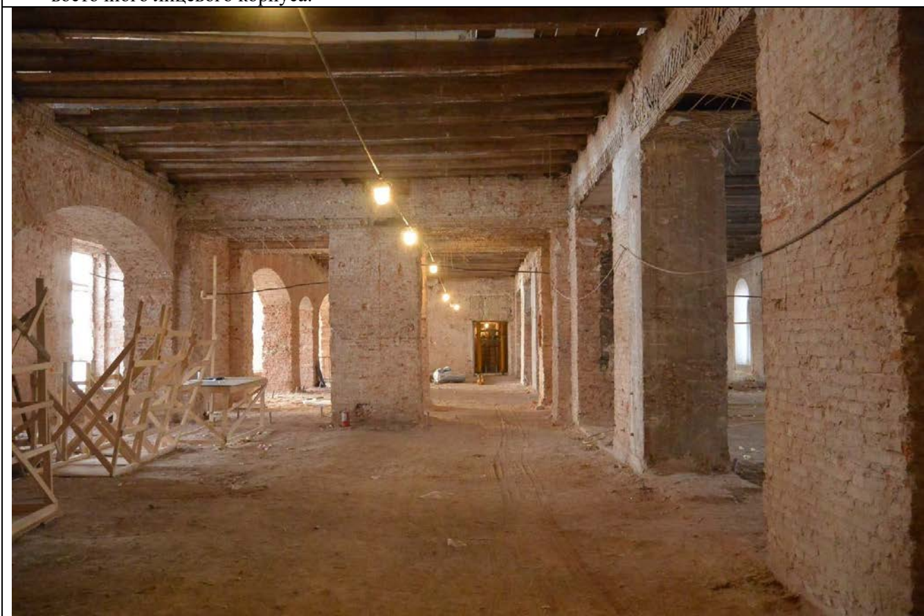
54. Общий вид пом. 33-Н (2, 11, 12, 13, 16) в уровне 1-го этажа. Северная часть восточного лицевого корпуса.
