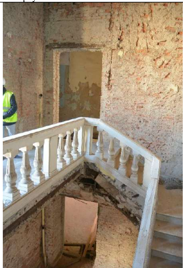
104. Фрагмент интерьера объема лестницы Л-12 в уровне 2-го этажа. Центральная часть западного лицевого корпуса.
