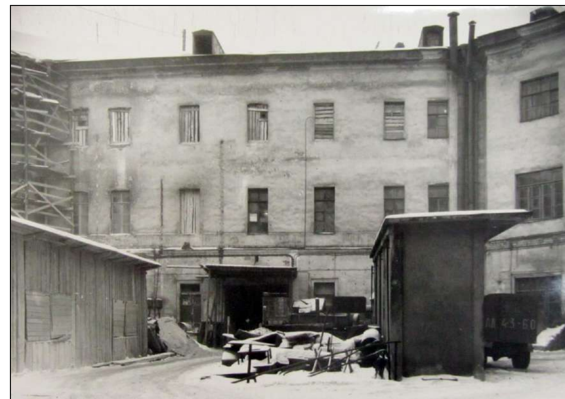
Илл. 82. 2-й двор. Западный фасад. 1952 г. КГИОП
