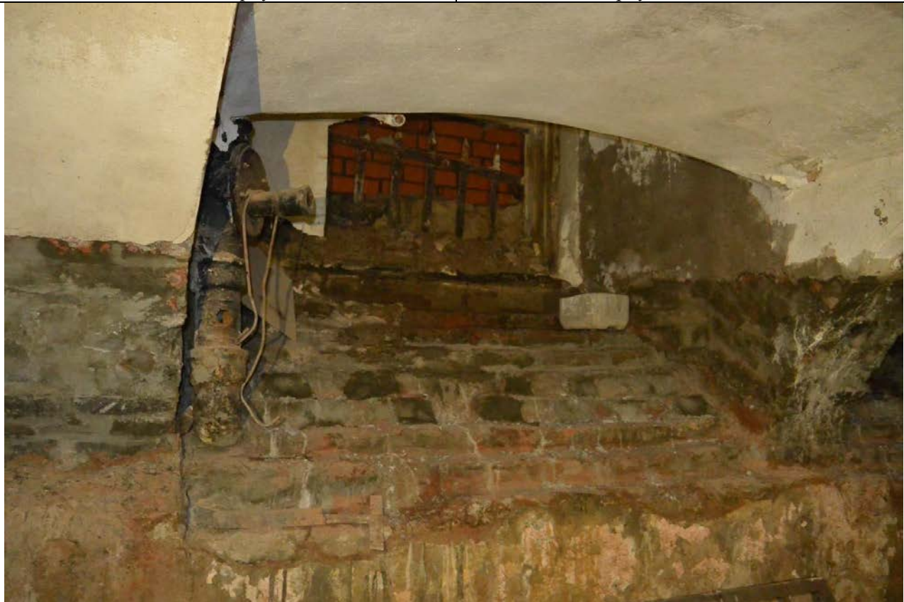
37. Фрагмент пом. 7-Н (47) в уровне подвального этажа. Центральная часть восточного лицевого корпуса.
