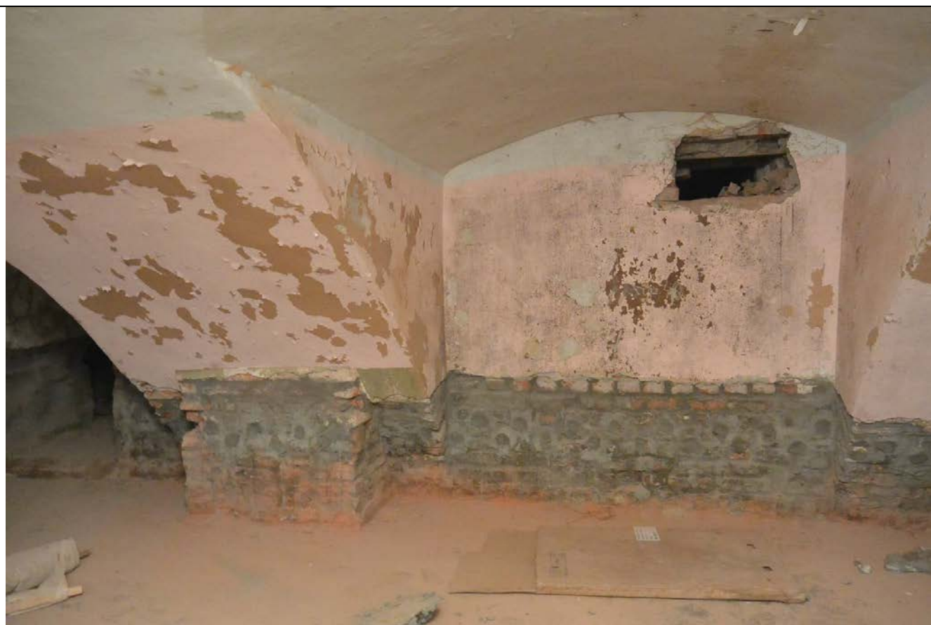
33. Фрагмент пом. 7-Н (39-42) в уровне подвального этажа. Центральная часть восточного лицевого корпуса.
