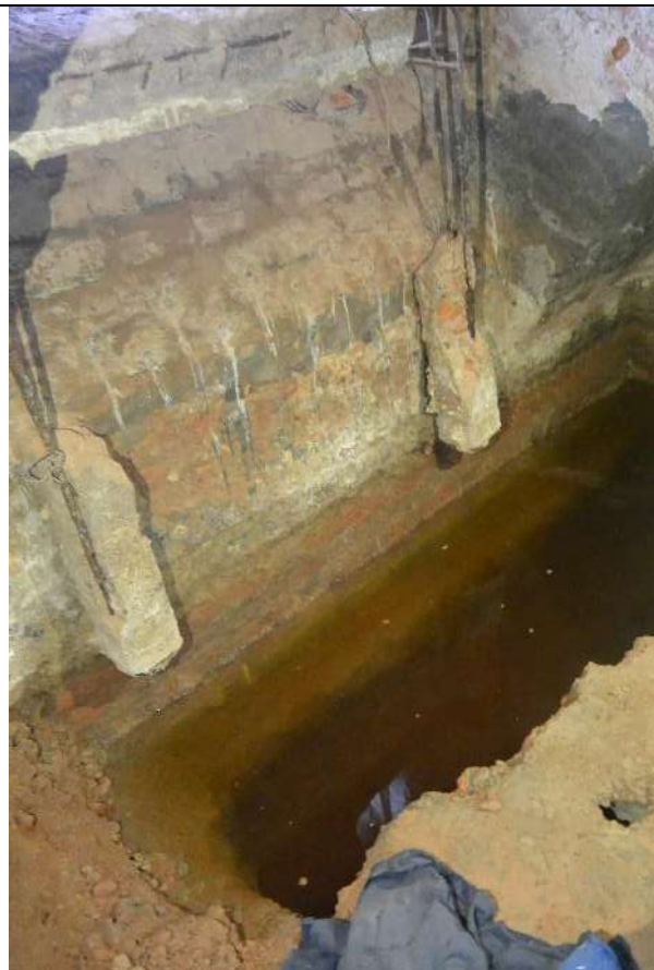
27. Фрагмент пом. 7-Н (30, 31) в уровне подвального этажа. Центральная часть восточного лицевого корпуса.
