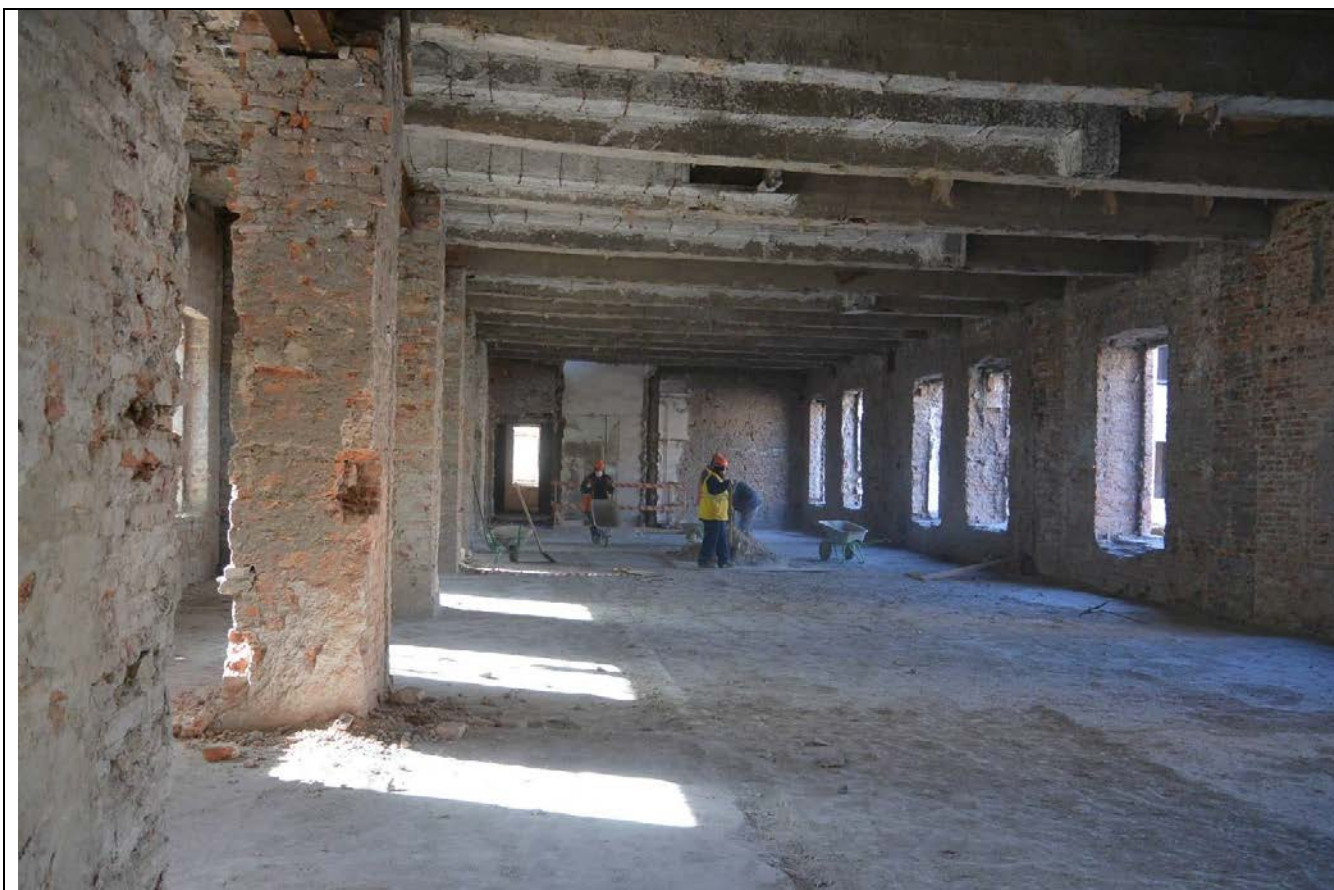
117. Общий вид пом. 48-Н (1-4, 7, 13-17) в уровне 2-го этажа. Второй поперечный корпус.
