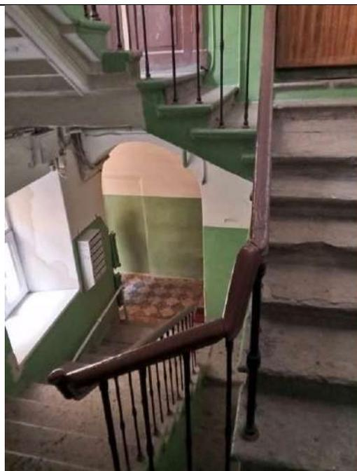
Л-2: служебная лестница, расположенная в юго-западной части здания (вход организован из центрального воротного проезда): двухмаршевая, марши по косоурам, в основании площадок – своды Монье; ступени из известняка с профилированным валиком (ступени утрачены до уровня второго этажа); полы междуэтажных площадок покрыты лещадными плитами;
