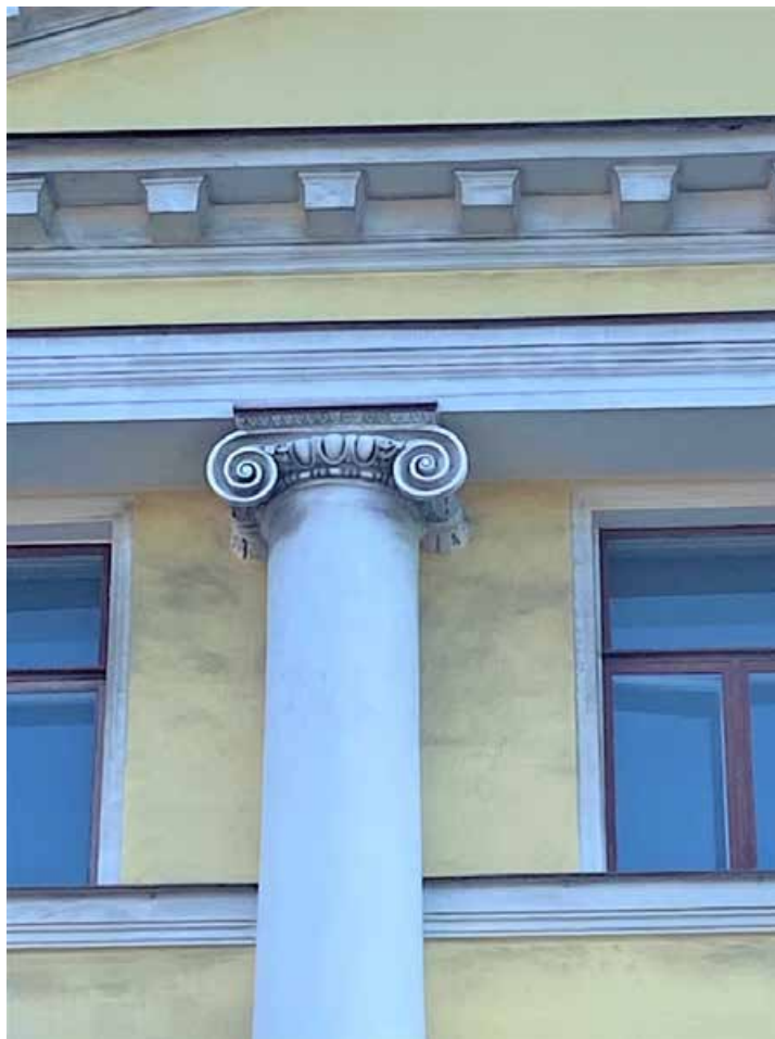
12. Объект культурного наследия федерального значения «Дом Неклюдова П.В. (дом Министерства Императорского Двора, «Дом Голицына»». Здесь жили: в 1812-1824 гг. - историк Тургенев А.И. и в 1816-1824 гг. - декабрист Тургенев Н.И.», расположенного по адресу: Санкт-Петербург, наб. реки Фонтанки, д. 20, литера А (р. Фонтанки наб., д. 20). Лицевой фасад. Фрагмент. Колонна ионического ордера. Дата съемки: 01.10.2021г.
