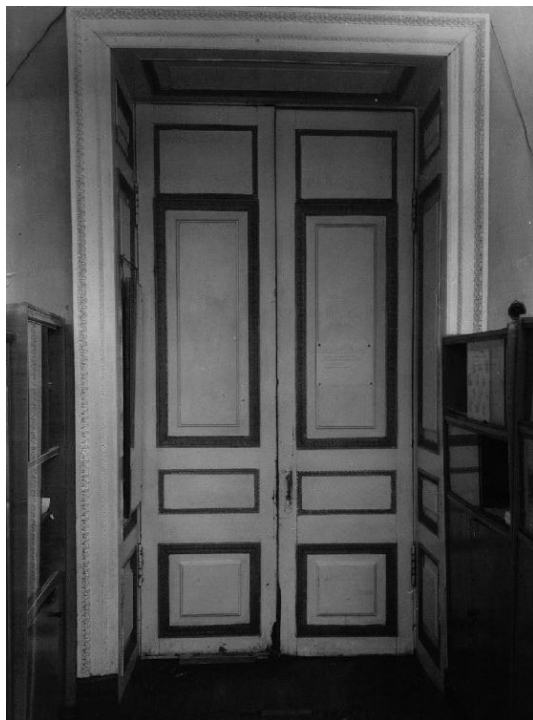
71. Дверь в золотую гостиную. Фото 1995. Архив КГИОП.
