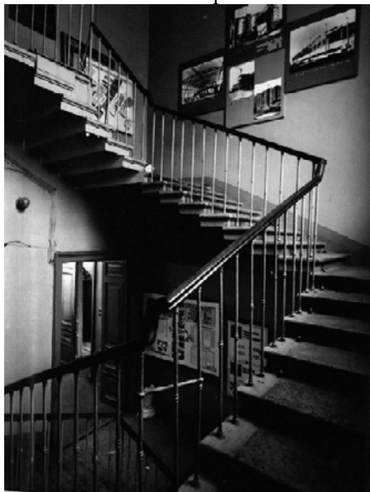
63. Главная лестница. Фото 1978 г. Архив КГИОП.
