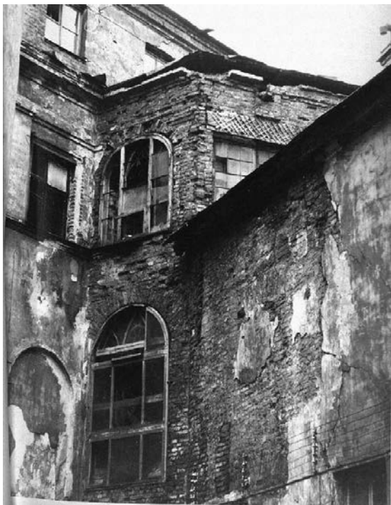
61. 2-й хоз. двор, западный фасад замыкающего восточного флигеля 1895. Фото 1995. Архив КГИОП.
