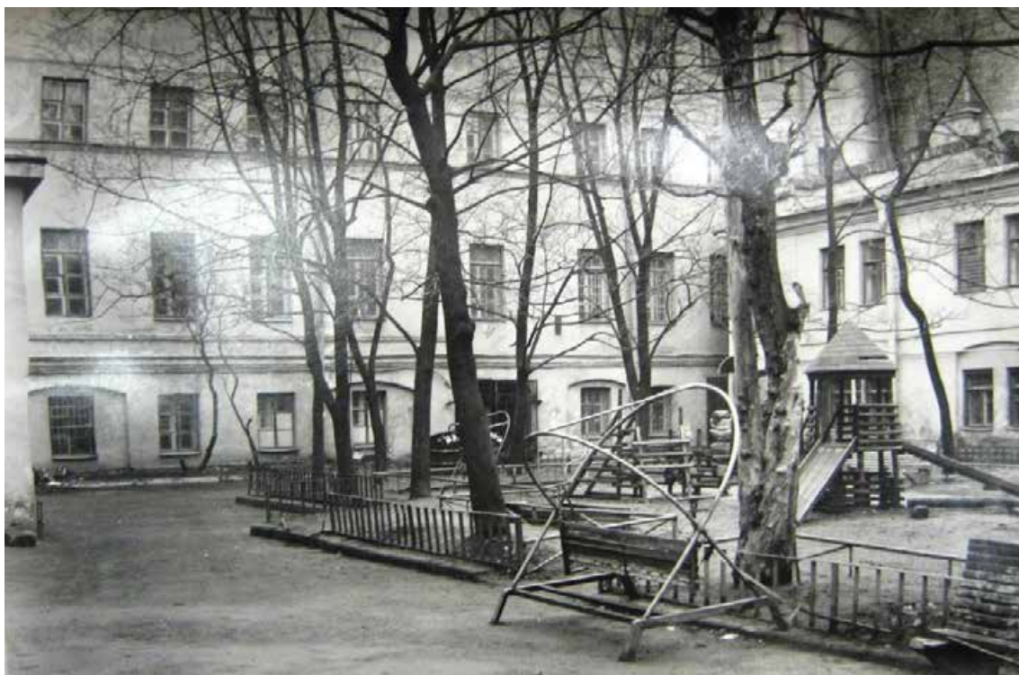
56. 2-й хозяйственный двор. Вид в направлении Ю-В – С-З. Фото 1990 г. Архив КГИОП.
