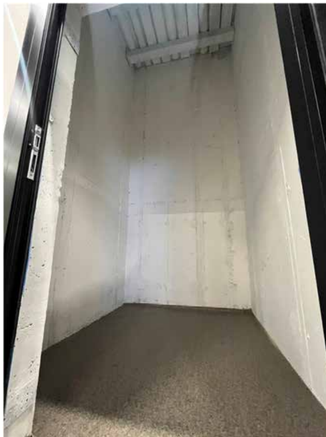
Фото №13. Помещение №45, третий этаж.
