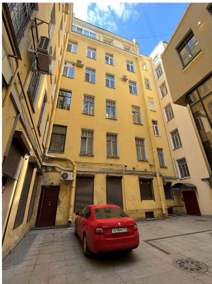
Фото №3. Восточный дворовый фасад поперечного западного корпуса.
