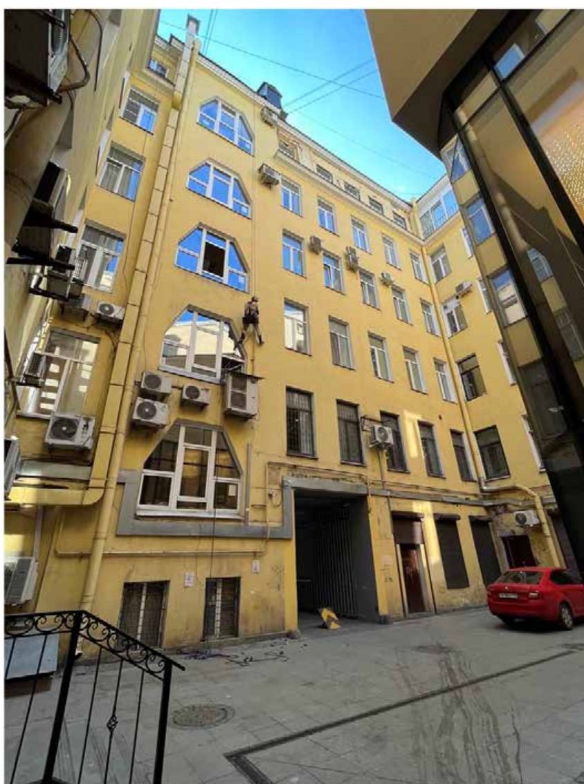
Фото №4. Северный дворовый фасад лицевого корпуса.
