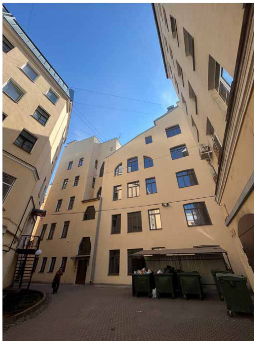
Фото №6. Северный фасад продольного дворового корпуса (лит. Б).
