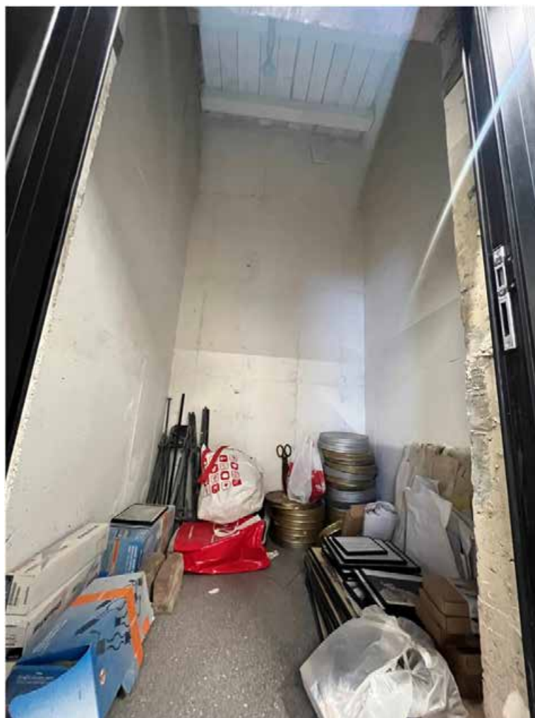
Фото №9. Помещение №29, второй этаж.
