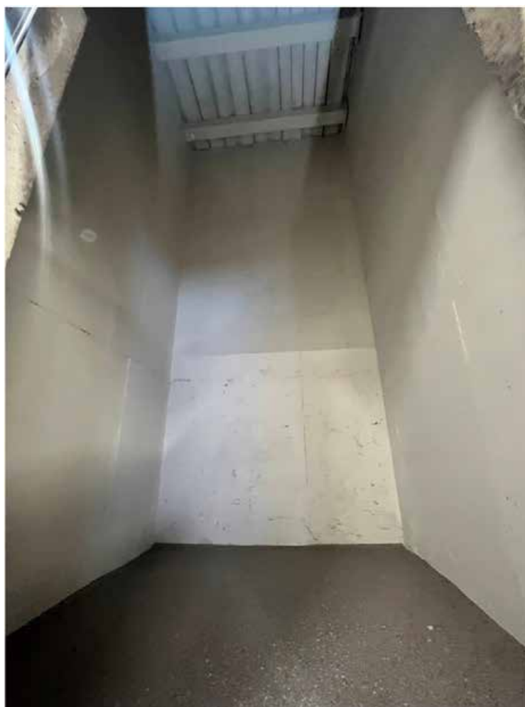
Фото №10. Помещение №31, второй этаж.
