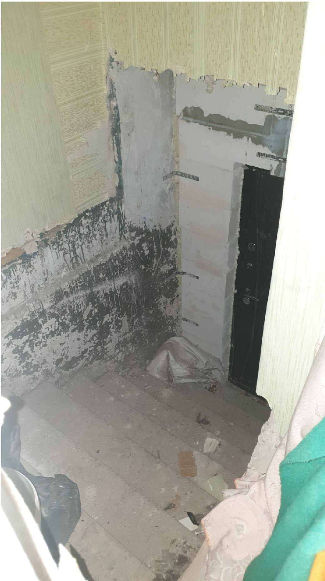
Фото 20 – Устроенный вход со стороны арки
