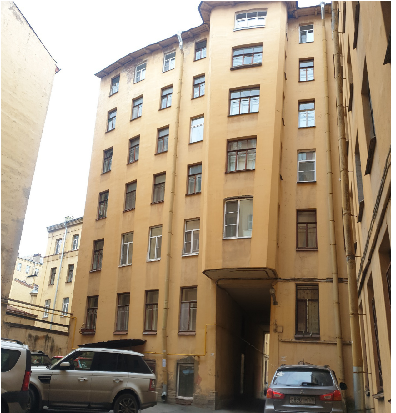
Фото 6 – Дворовой фасад. Вид на арку, окна квартиры с западной стороны и устроенную дверь в пространстве арки.
