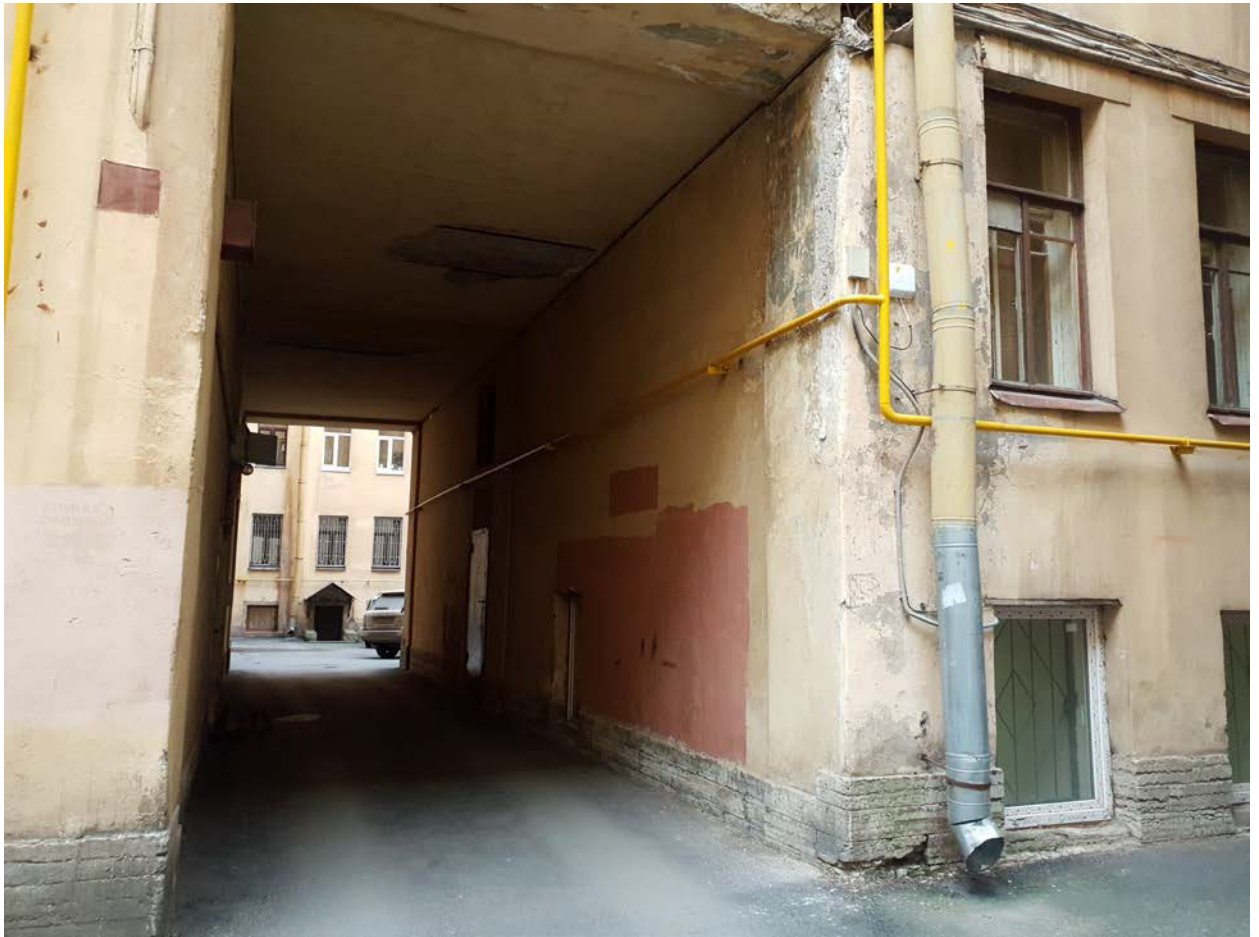
Фото 5 – Дворовой фасад. Арка. Вид на окна с восточной стороны квартиры и устроенную дверь в арке.
