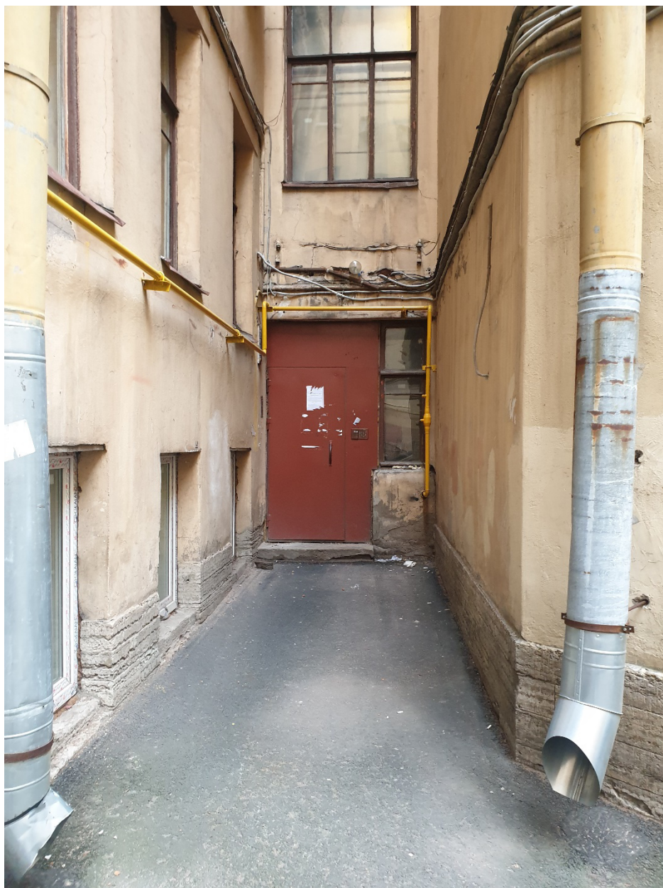
Фото 8 – Дворовой фасад. Вход в подъезд.
