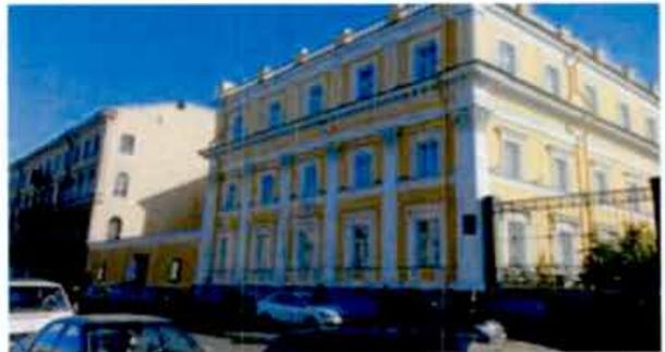
исторические воротные и дверные проемы – местоположение, габариты, конфигурация (прямоугольные), оформление проемов курдонера (профилированные наличники с линейными и треугольными сандриками на кронштейнах);
