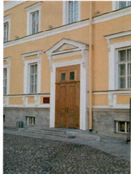
приборы дверные – ручка-скоба с фигурным деревянным стержнем, с латунными наконечниками с шариками, на латунных цапфах;
