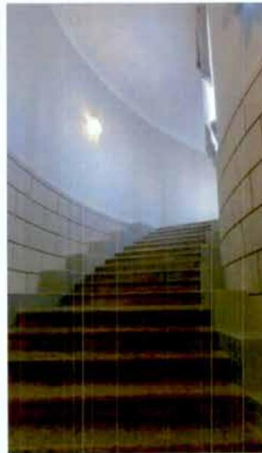
служебные лестницы (10-ЛК, 11-ЛК (восточного крыла) – двухмаршевые, на косоурах, с известняковыми ступенями и площадками, с металлическим ограждением, с профилированным деревянным поручнем;
