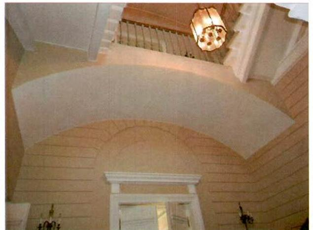
парадные лестницы 5-ЛК, 9-ЛК (восточного и западного крыльев) – трехмаршевые, на косоурах, с известняковыми ступенями и площадками, с металлическим ограждением в виде вертикальных стоек с розетками и листьями аканта, волотами сверху и снизу, с деревянным профилированным поручнем, с площадками по сводам;
