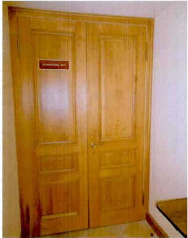
заполнение дверных проемов – материал (дерево), конструкция (двери двухстворчатые глухие), оформление (профилированные наличники);
