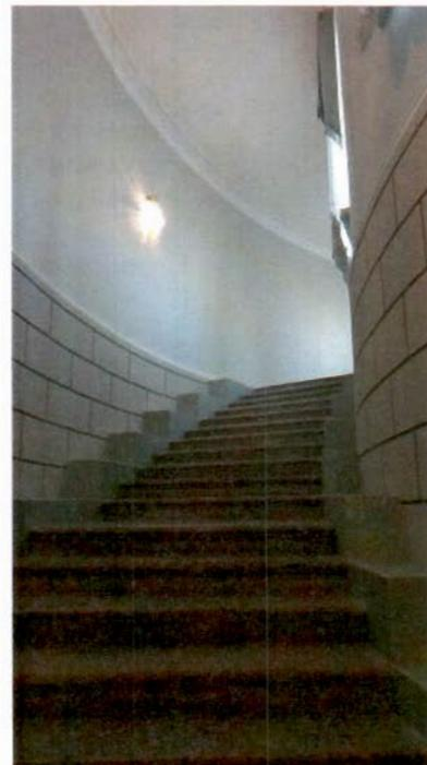
служебные лестницы (10-ЛК, 11-ЛК (восточного крыла) – двухмаршевые, на косоурах, с известняковыми ступенями и площадками, с металлическим ограждением, с профилированным деревянным поручнем;
