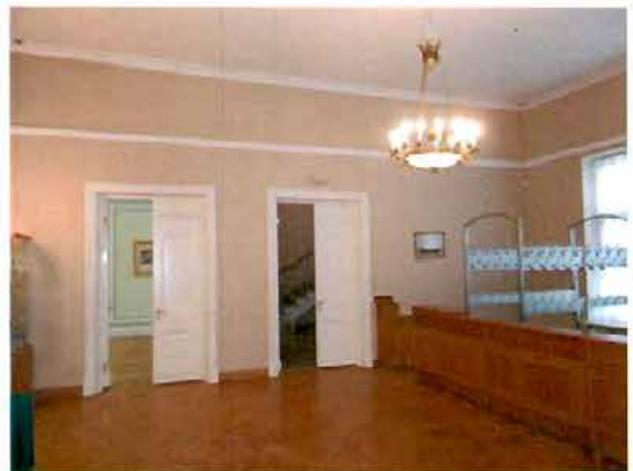
дверные проемы – местоположение, габариты, конфигурация (прямоугольные), оформление (профилированный наличник с навершием в виде профилированного карниза);
