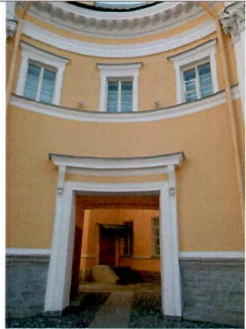
заполнение дверных проемов – материал (дерево), конструкция (двери двухстворчатые с прямоугольными фрамугами), оформление (профилированные филенки);
