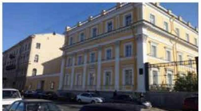
исторические воротные и дверные проемы – местоположение, габариты, конфигурация (прямоугольные), оформление проемов курдонера (профилированные наличники с линейными и треугольными сандриками на кронштейнах);
