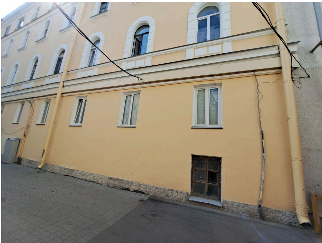
Фото № 4. Фрагмент дворового фасада. Оконные заполнения квартиры № 1.
