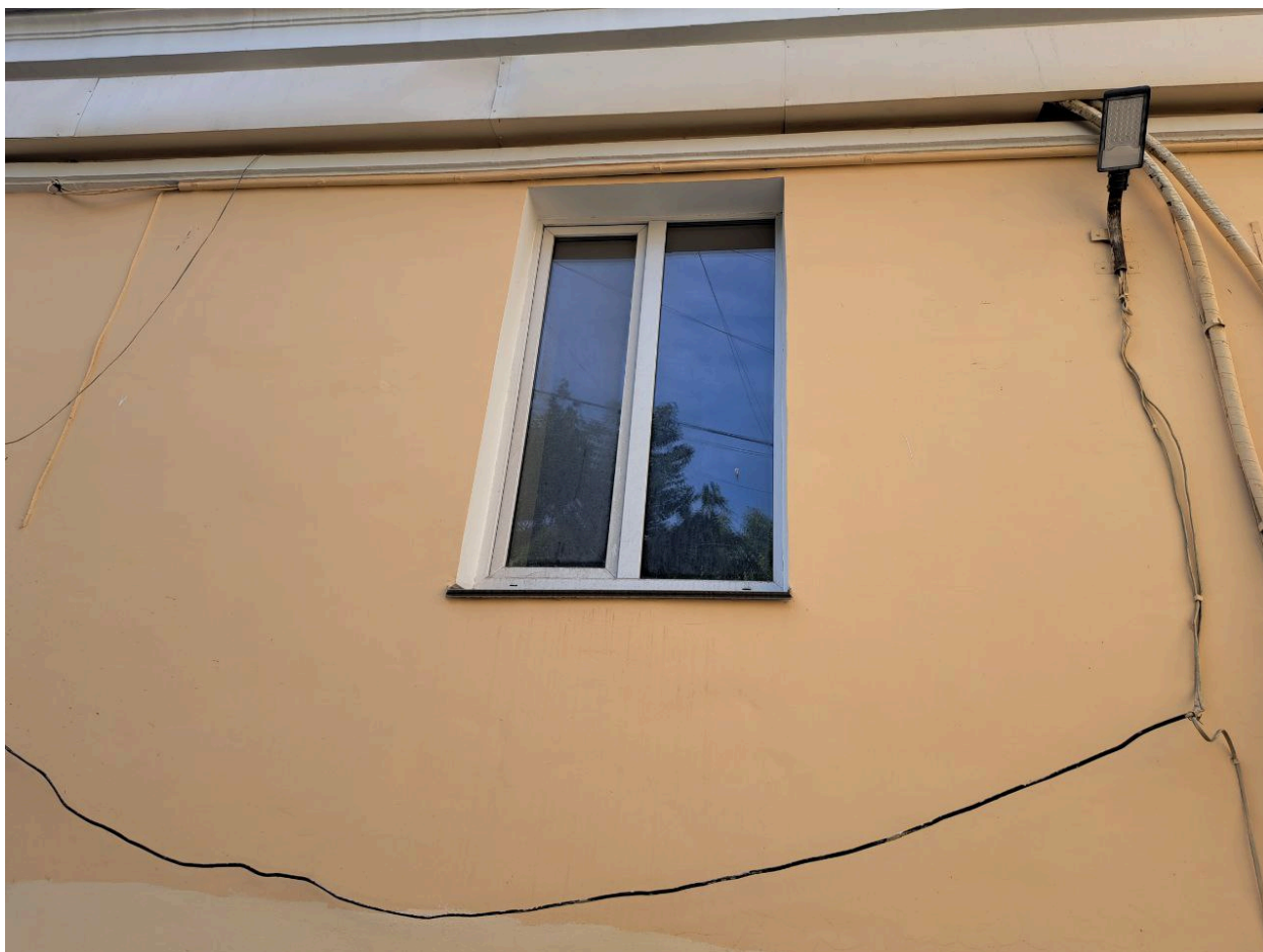
Фото № 10. Фрагмент дворового фасада. Оконное заполнение квартиры № 1.
