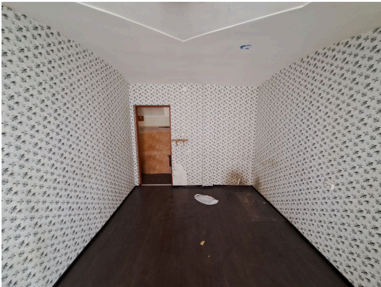
Фото № 37. Квартира №1. Помещение 6.
