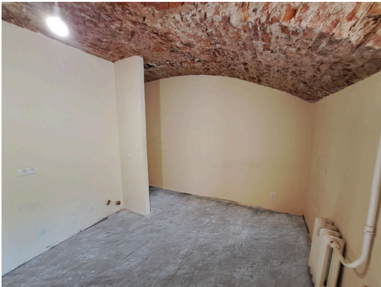
Фото № 24. Квартира №1. Помещение 3.
