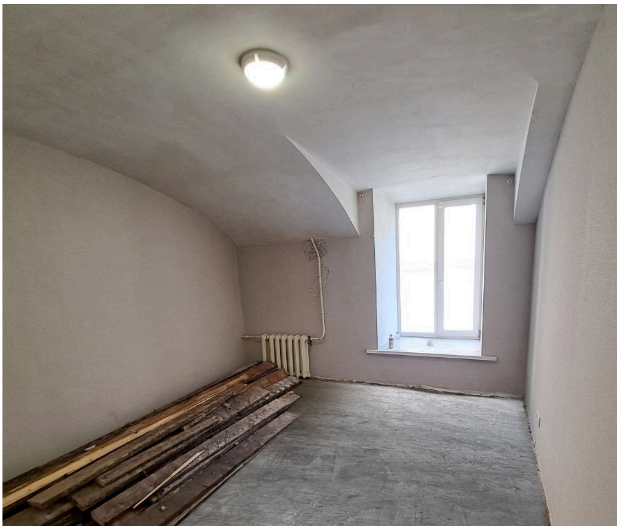
Фото № 26. Квартира №1. Помещение 4.
