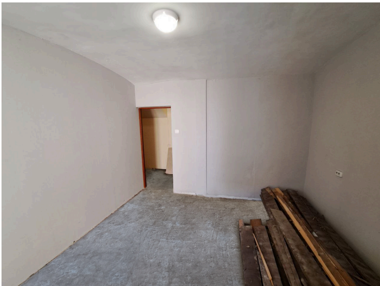
Фото № 28. Квартира №1. Помещение 4.
