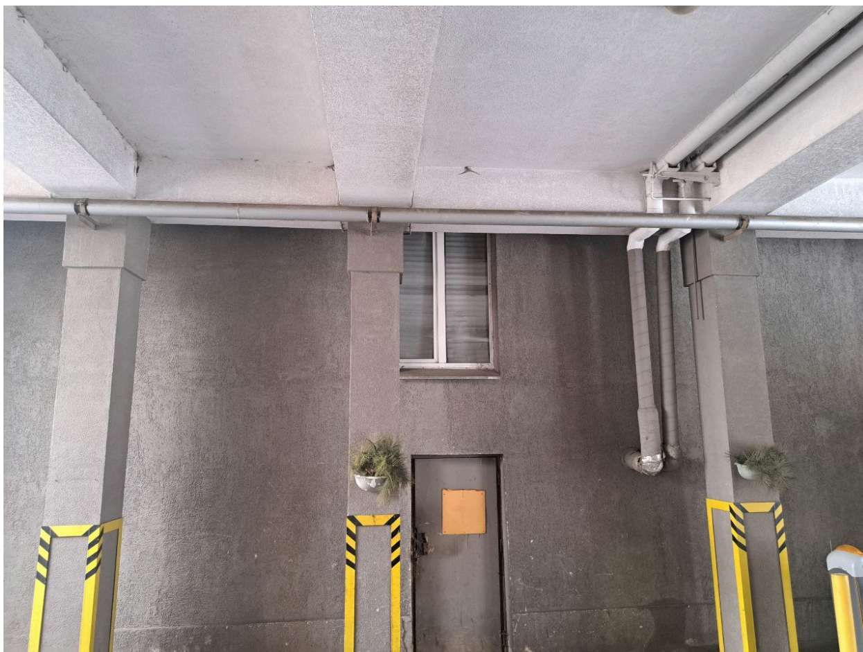
Фото № 5. Фрагмент фасада. Оконное заполнение квартиры № 1.
