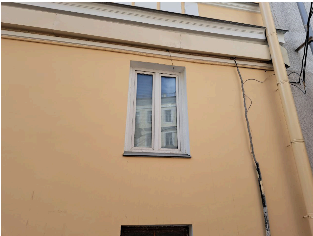
Фото № 6. Фрагмент дворового фасада. Оконное заполнение квартиры № 1.
