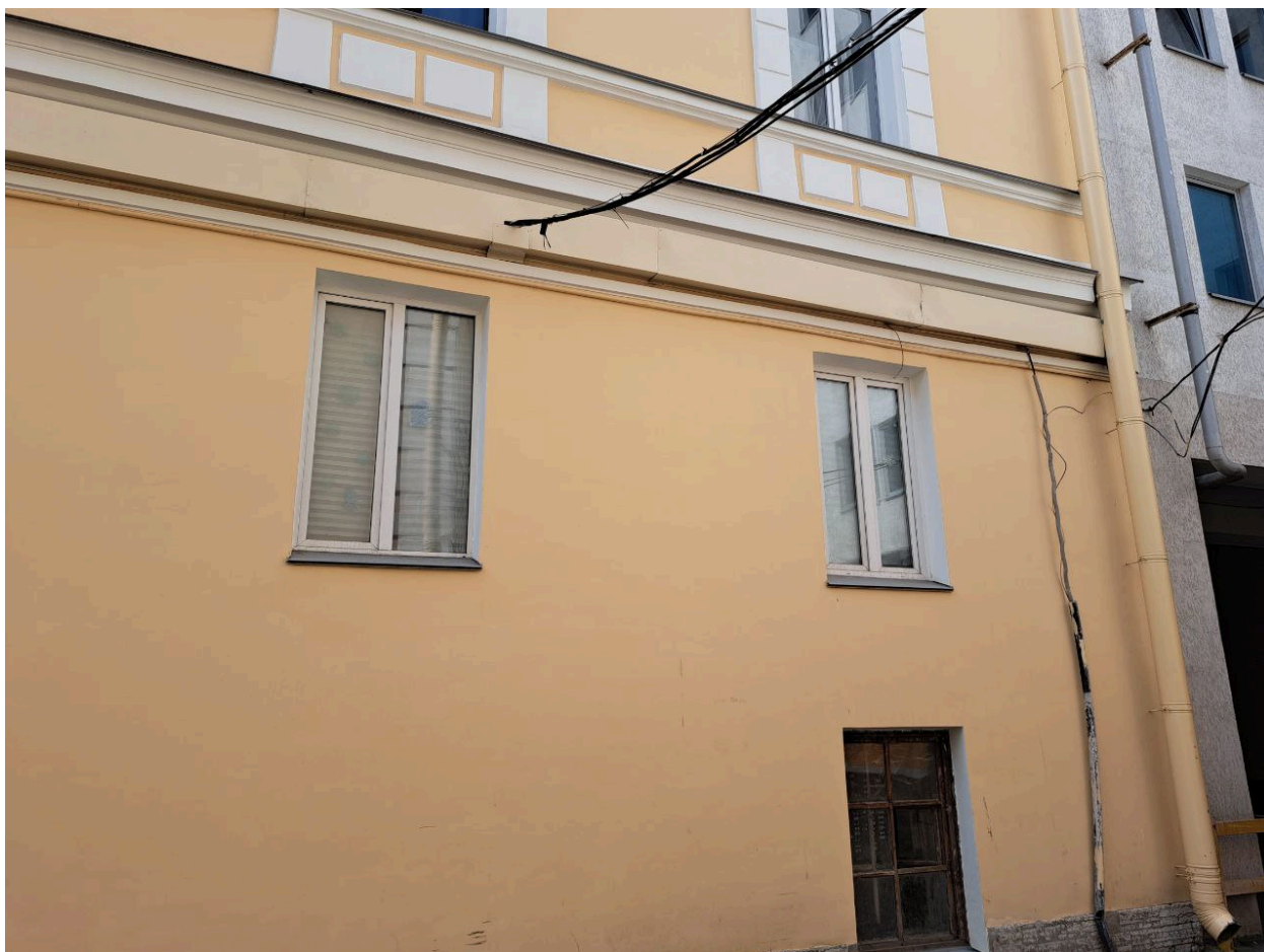
Фото № 3. Фрагмент дворового фасада. Оконные заполнения квартиры № 1.
