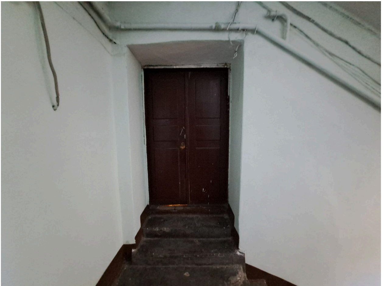
Фото № 14. Дверное заполнение квартиры №1 со стороны лестницы.
