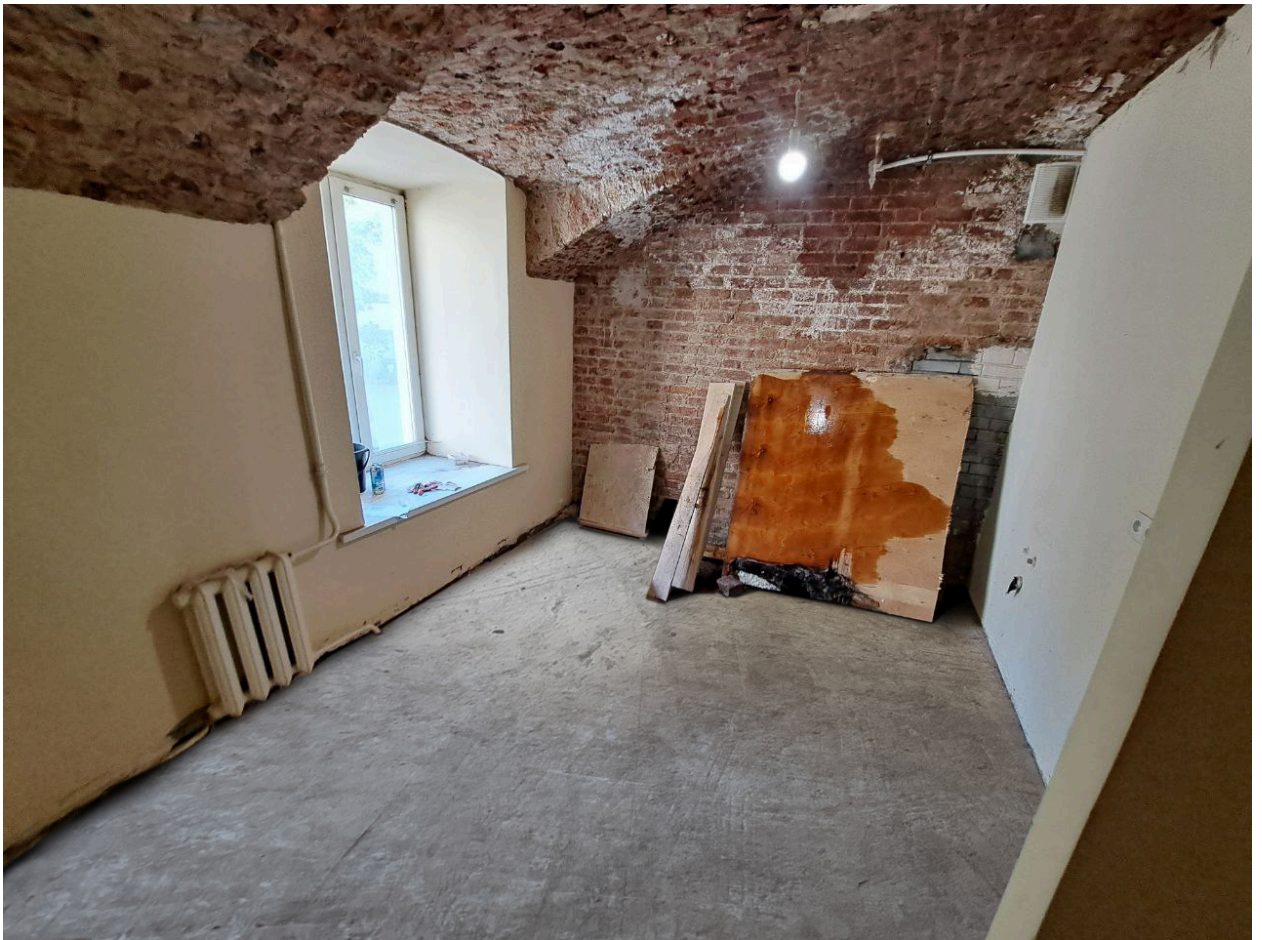
Фото № 22. Квартира №1. Помещение 3.
