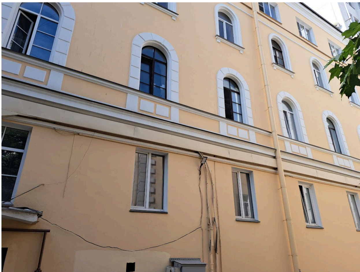
Фото № 2. Фрагмент дворового фасада здания.
