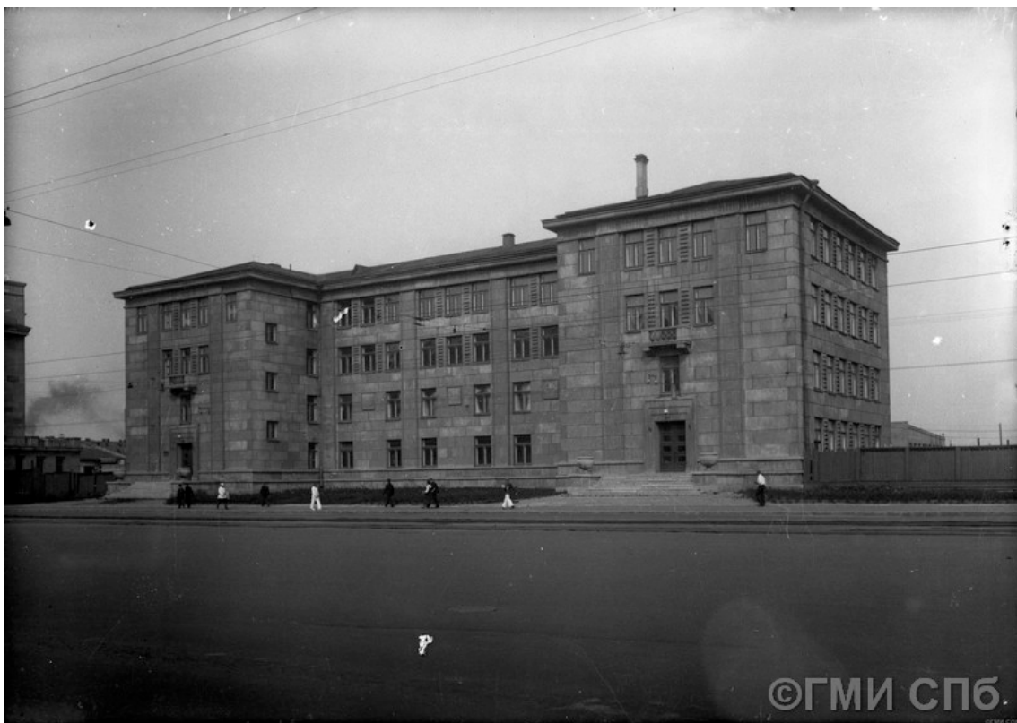
5. Здание школы из крупных блоков на Международном (Московском) проспекте. Период создания: 1930-е гг. СПб ГБУК «Государственный музей истории Санкт-Петербурга». Инв.№: ГМИ СПб Инв.№-II-A374н.
