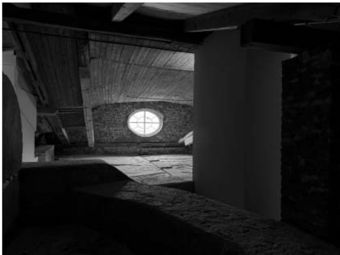
108. Объект культурного наследия регионального значения «Особняк Штифтер», расположенный по адресу: г. Санкт-Петербург, Моховая улица, дом 15, литера А. Фрагмент стропильной системы крыши лицевого корпуса в уровне чердака.
