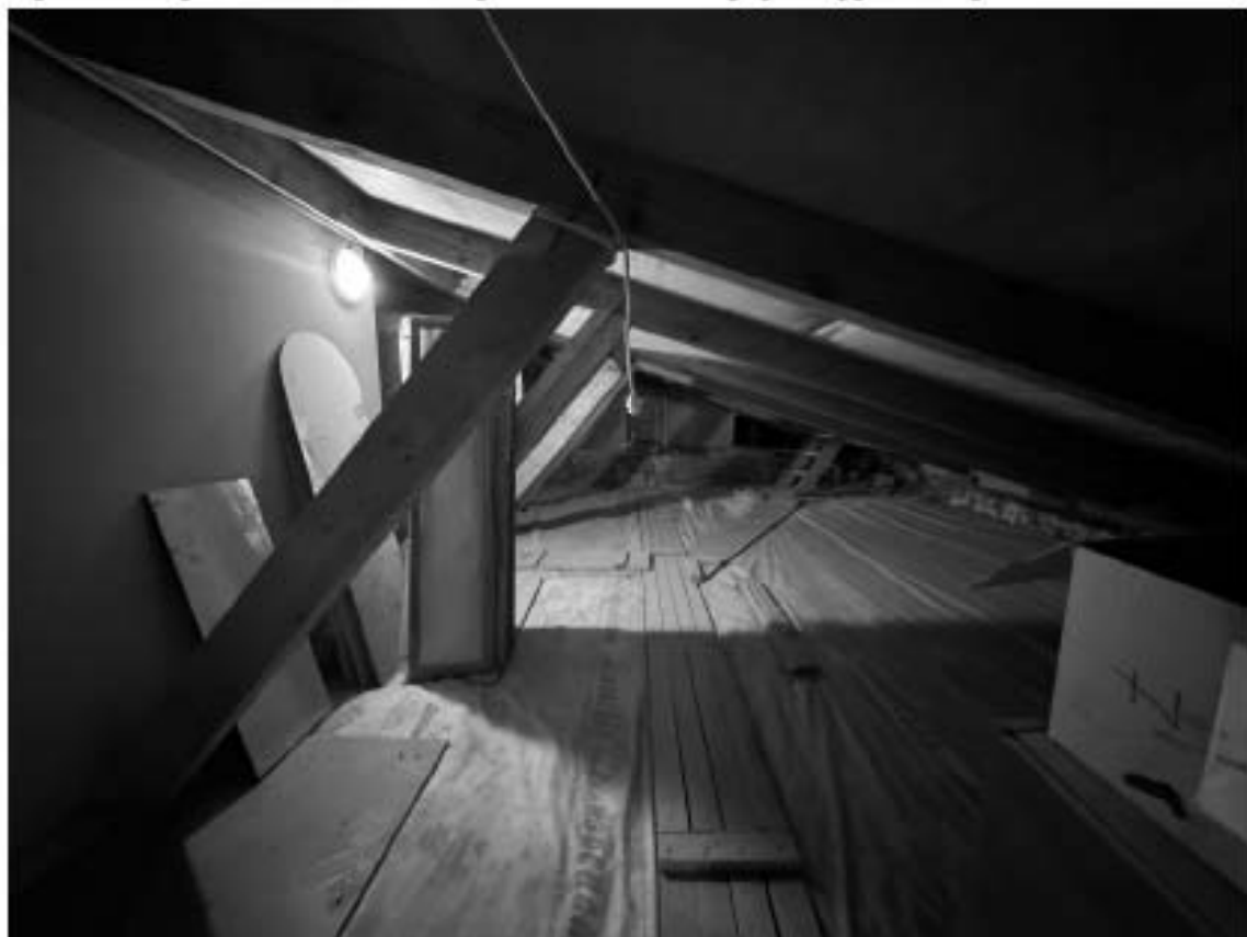
107. Объект культурного наследия регионального значения «Особняк Штифтер», расположенный по адресу: г. Санкт-Петербург, Моховая улица, дом 15, литера А. Фрагмент стропильной системы крыши лицевого корпуса в уровне чердака.
