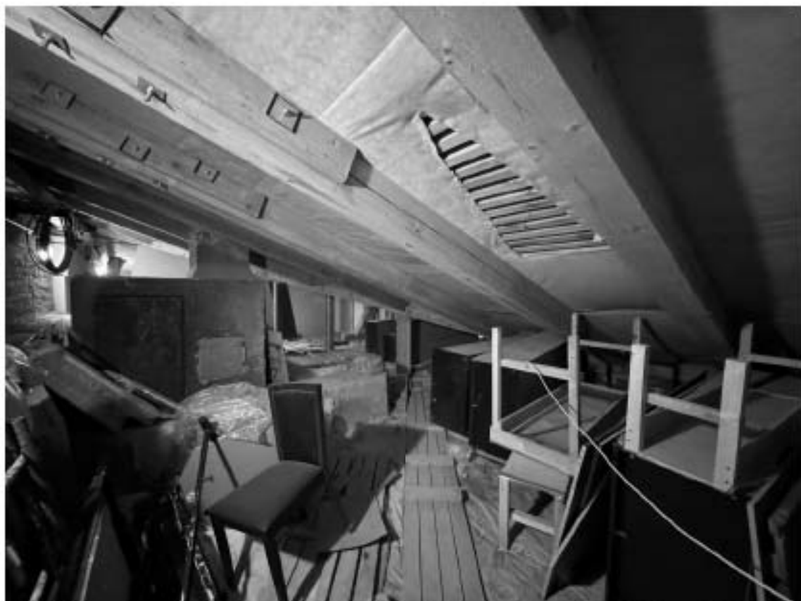
106. Объект культурного наследия регионального значения «Особняк Штифтер», расположенный по адресу: г. Санкт-Петербург, Моховая улица, дом 15, литера А. Фрагмент стропильной системы крыши лицевого корпуса в уровне чердака.
