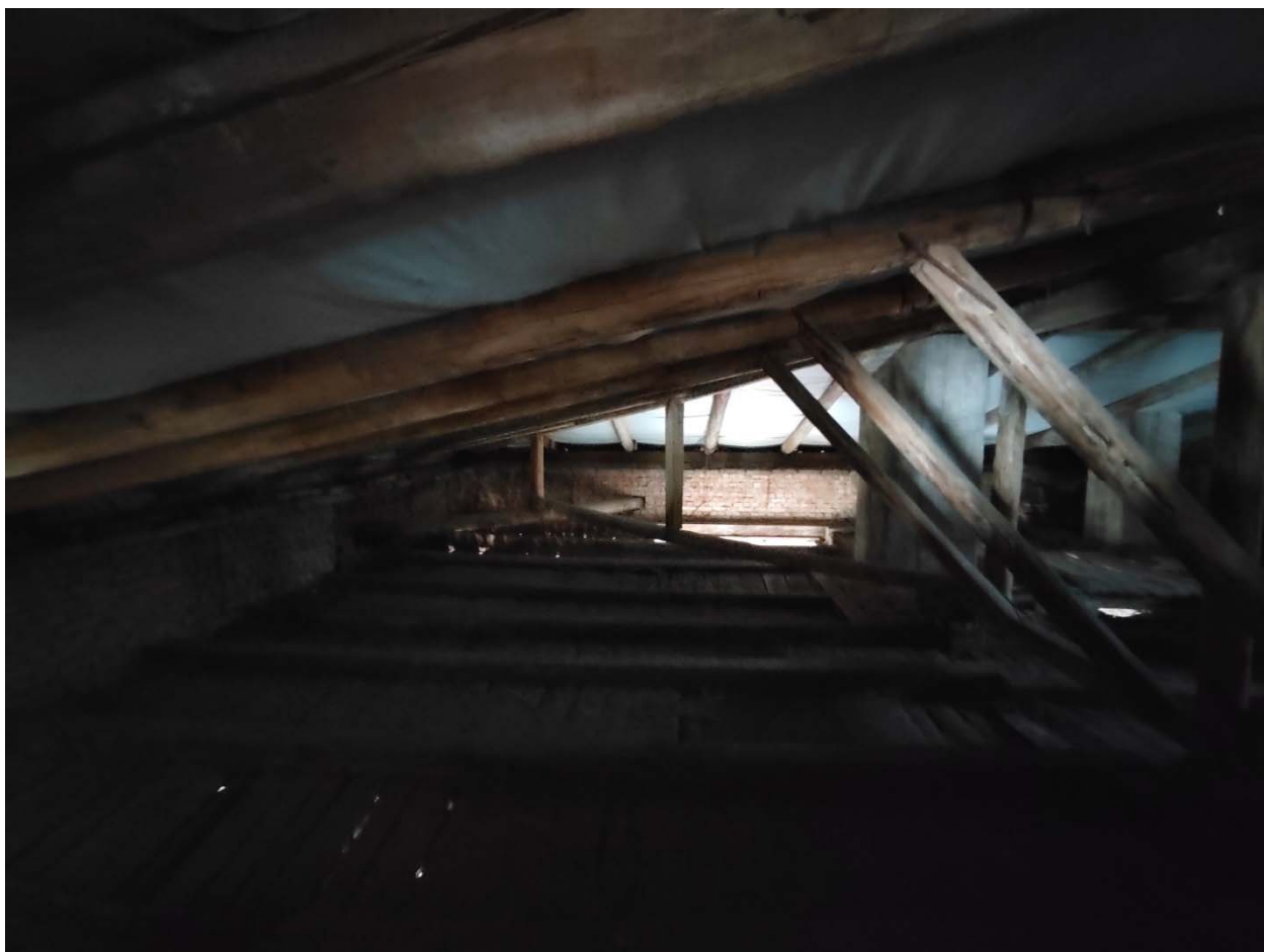
Фото 38. Чердак. Несущие конструкции крыши.
