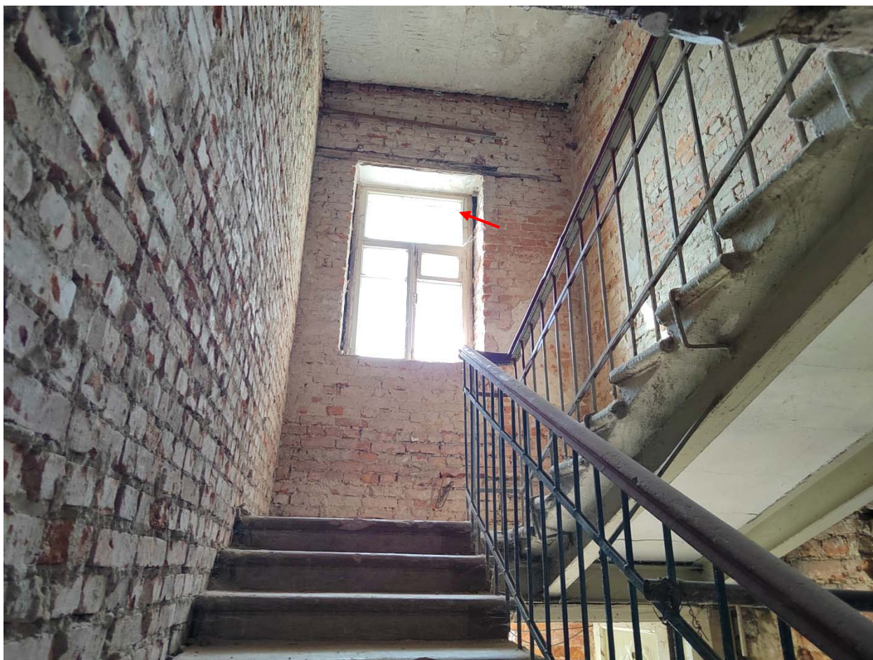
Фото 28. Площадка лестницы между этажами.
