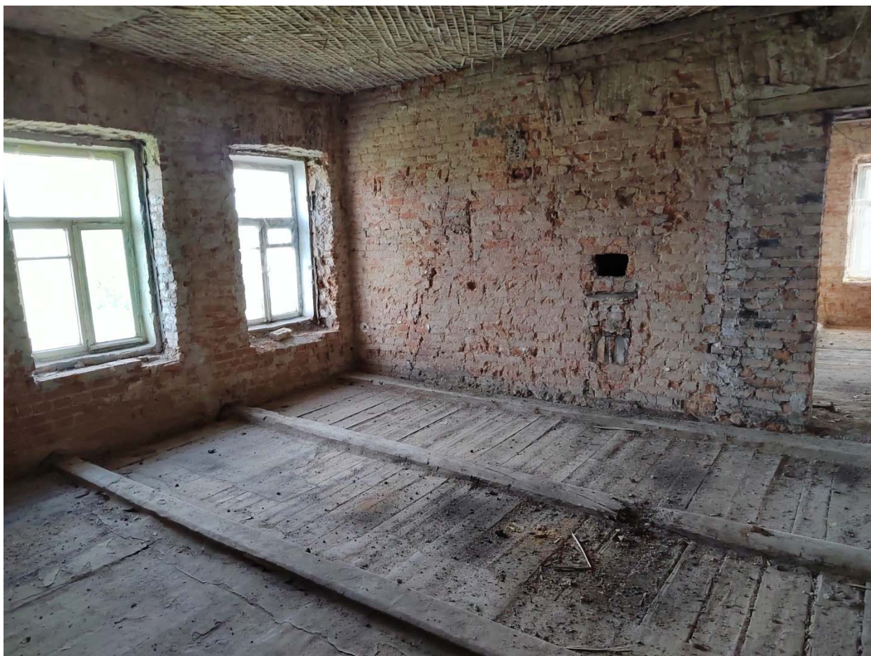
Фото 34. Помещения второго этажа.
