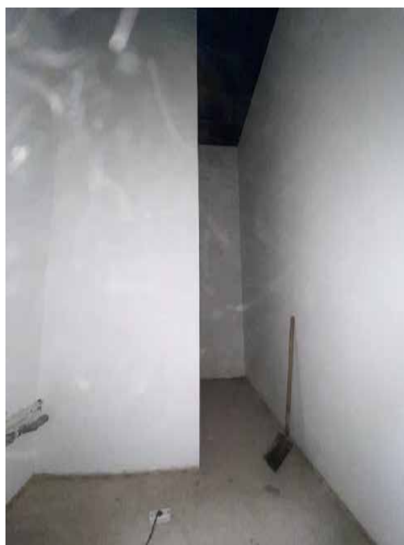
Фото 21. Вид на помещение 3-го этажа.
