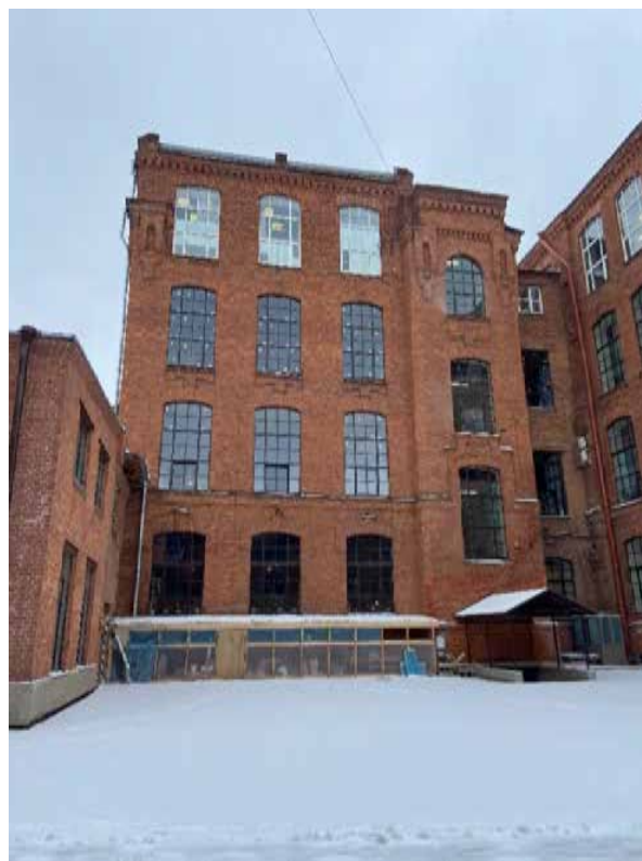
Фото 5. Вид на юго-восточный фасад.
