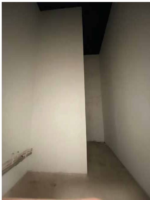
Фото 16. Вид на помещение 2-го этажа.
