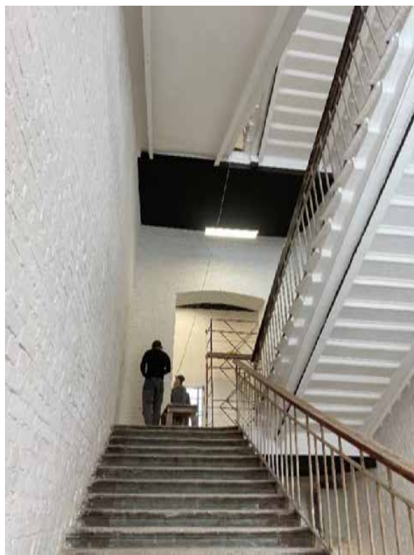
Фото 4. Вид на лестницу.
