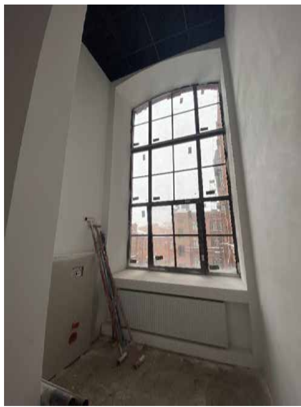
Фото 17. Вид на помещение 2-го этажа.
