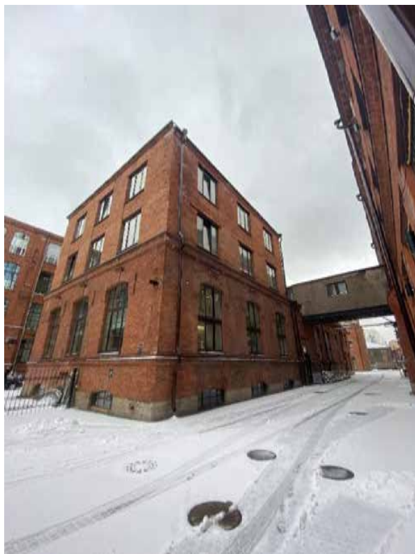
Фото 4. Вид на пристройку с юго-запада.
