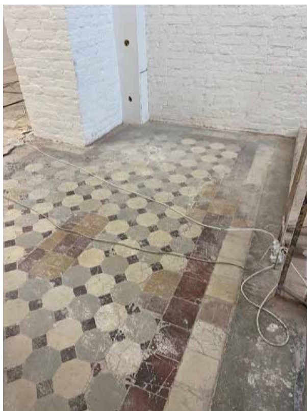
Фото 7. Лестничная площадка 3-го этажа.
