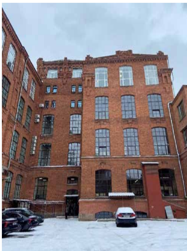
Фото 2. Вид на северо-западный фасад.
