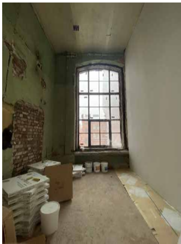
Фото 15. Вид на помещение 2-го этажа.
