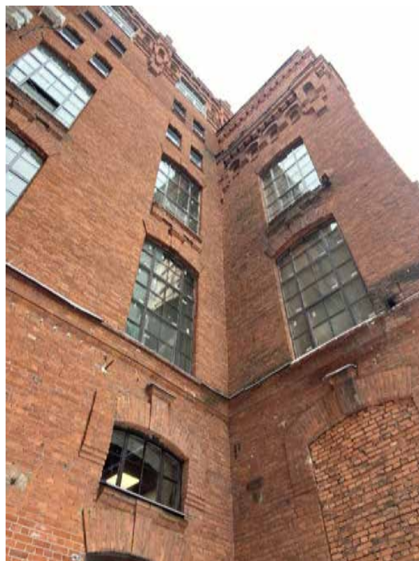
Фото 3. Фрагмент северо-западного фасада.
