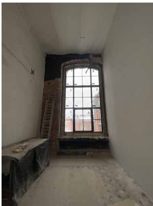
Фото 20. Вид на помещение 3-го этажа.
