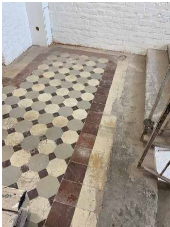
Фото 5. Лестничная площадка 2-го этажа.
