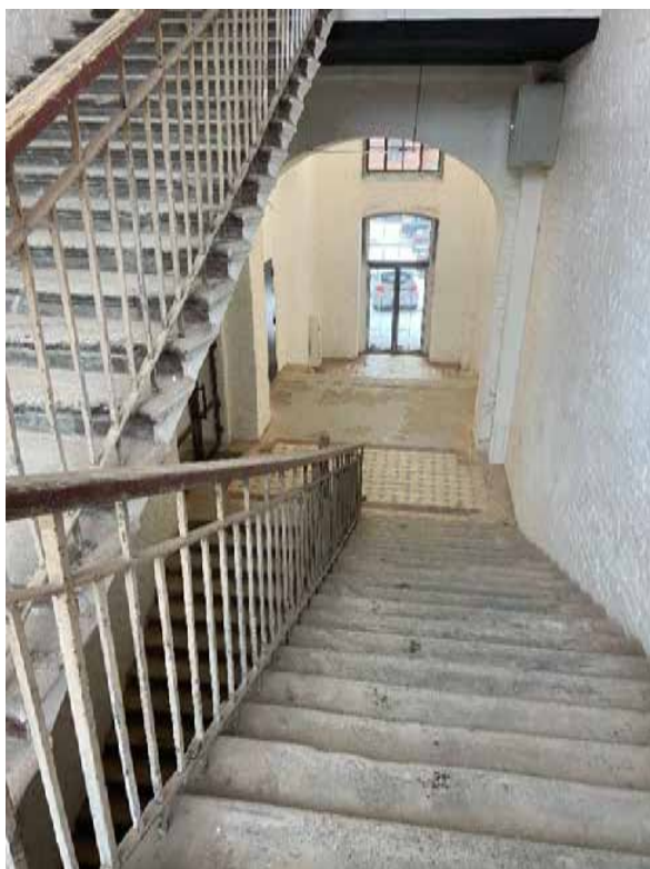
Фото 3. Вид на лестницу.
