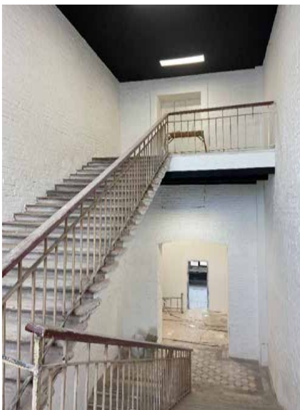
Фото 8. Вид на лестницу.
