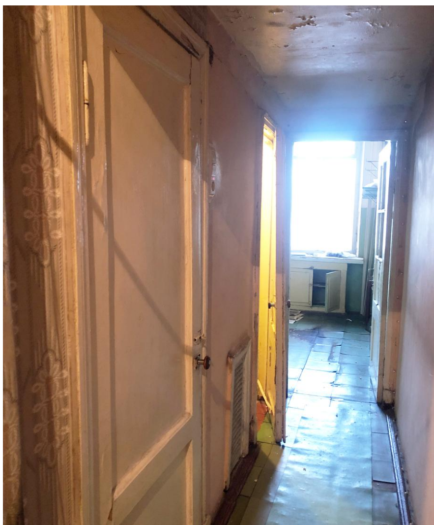
16. Коридор (помещение 1). Вид в сторону кухни (помещение 5).
