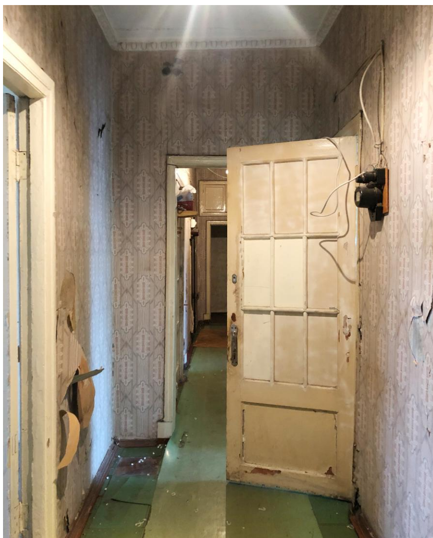
12. Холл квартиры №22. Помещение 16. Вид от входной двери.
