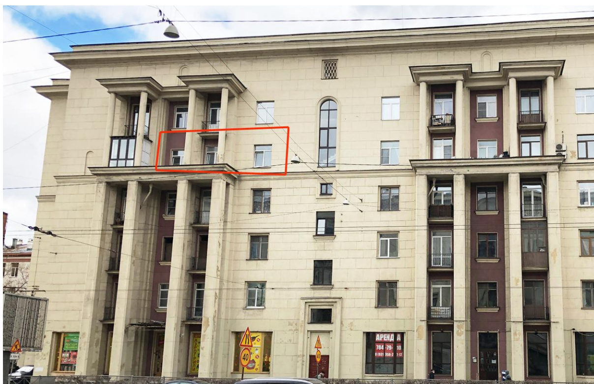
2. Фрагмент лицевого фасада дома №20 по Ивановской улице. Отмечены окна квартиры №22.
