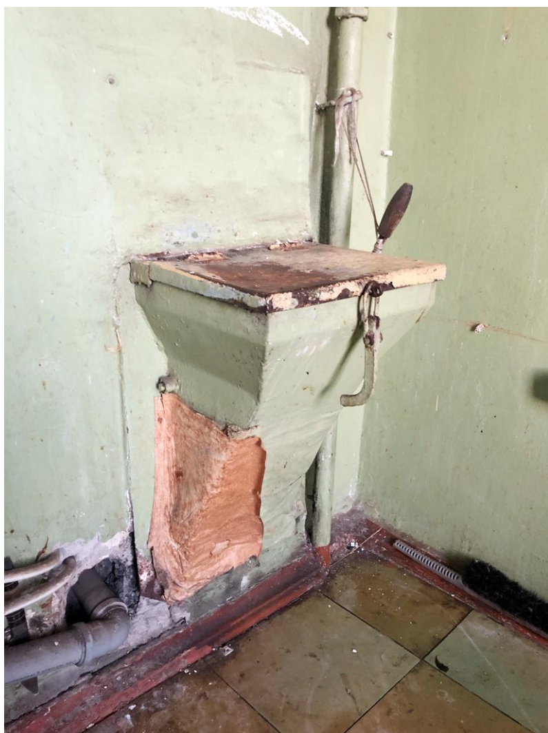
22. Кухня (помещение 5). Мусоропровод.
