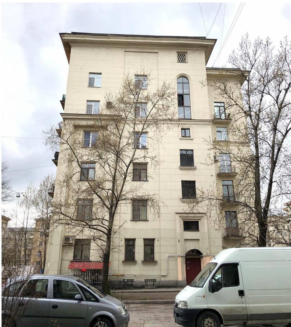
5. Торцевой фасад (северо-восточный) дома №20 по Ивановской улице.
