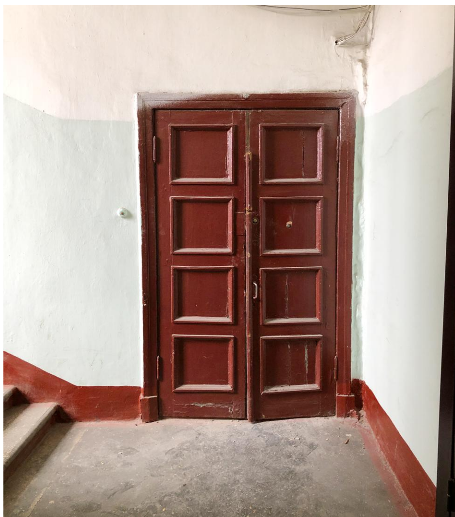
10. Дверь в квартиру
