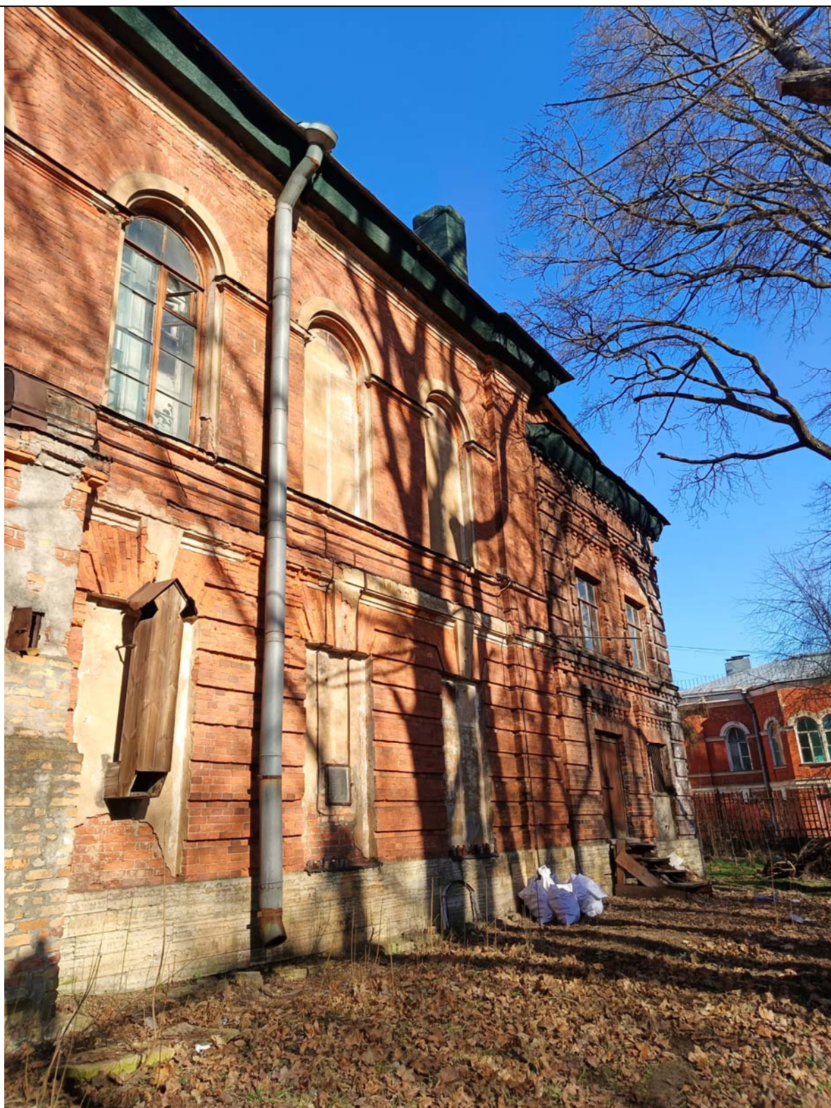
6. «Анатомический театр». Восточный (дворовый) фасад. Двухэтажная пристройка.
