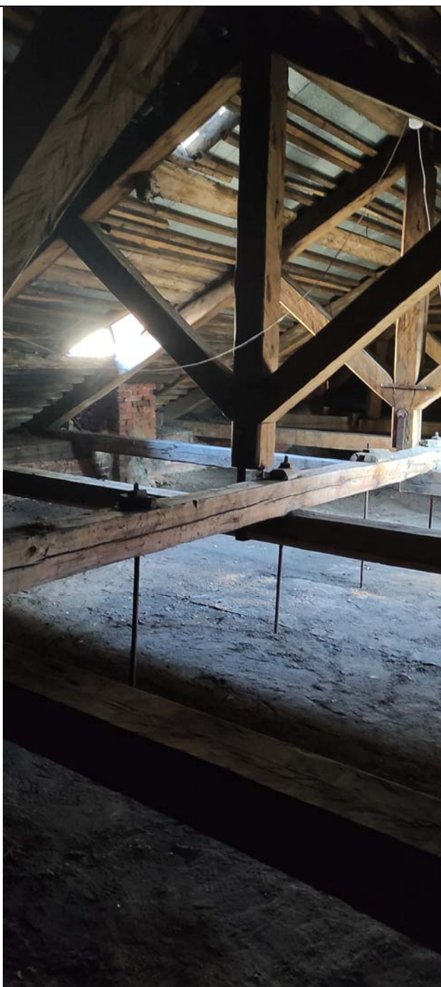
13.Анатомический театр». Стропильная система. Фрагмент.
