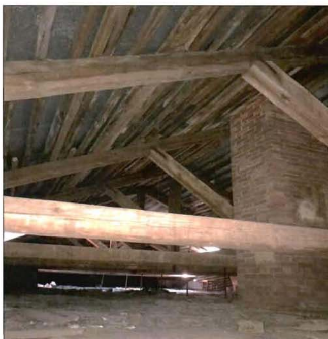
8. Фрагмент стропильной системы.
