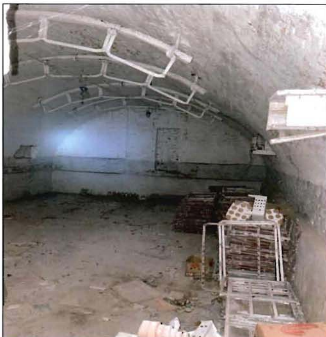
7. Фрагмент подвального помещения.
