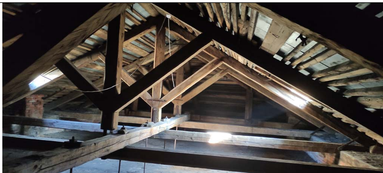
11. «Анатомический театр». Стропильная система. Общий вид.
