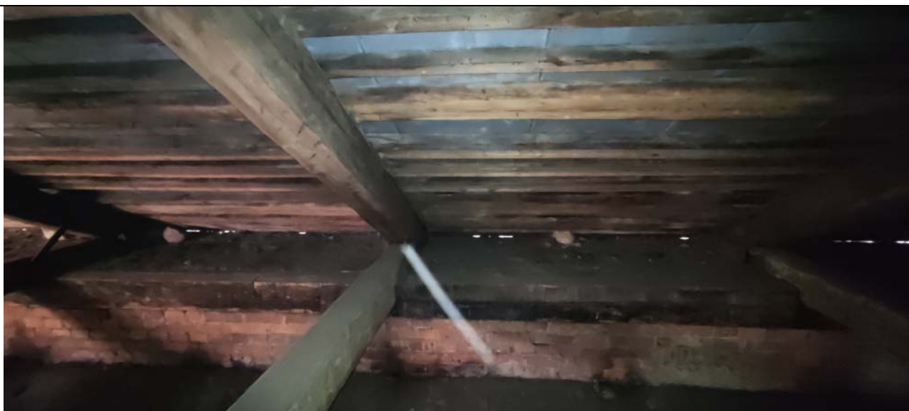
12. «Анатомический театр». Стропильная система. Фрагмент.
