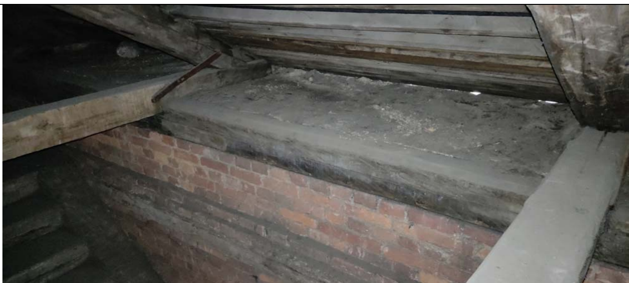
14.Анатомический театр». Стропильная система. Мауэрлат. Фрагмент.
