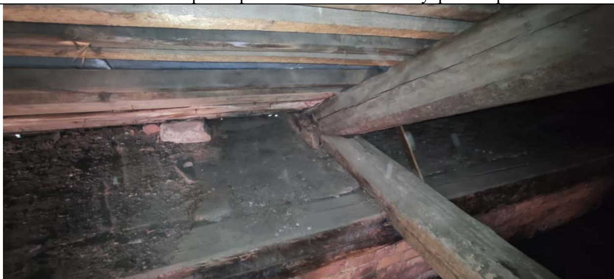
15.Анатомический театр». Стропильная система. Мауэрлат. Фрагмент.
