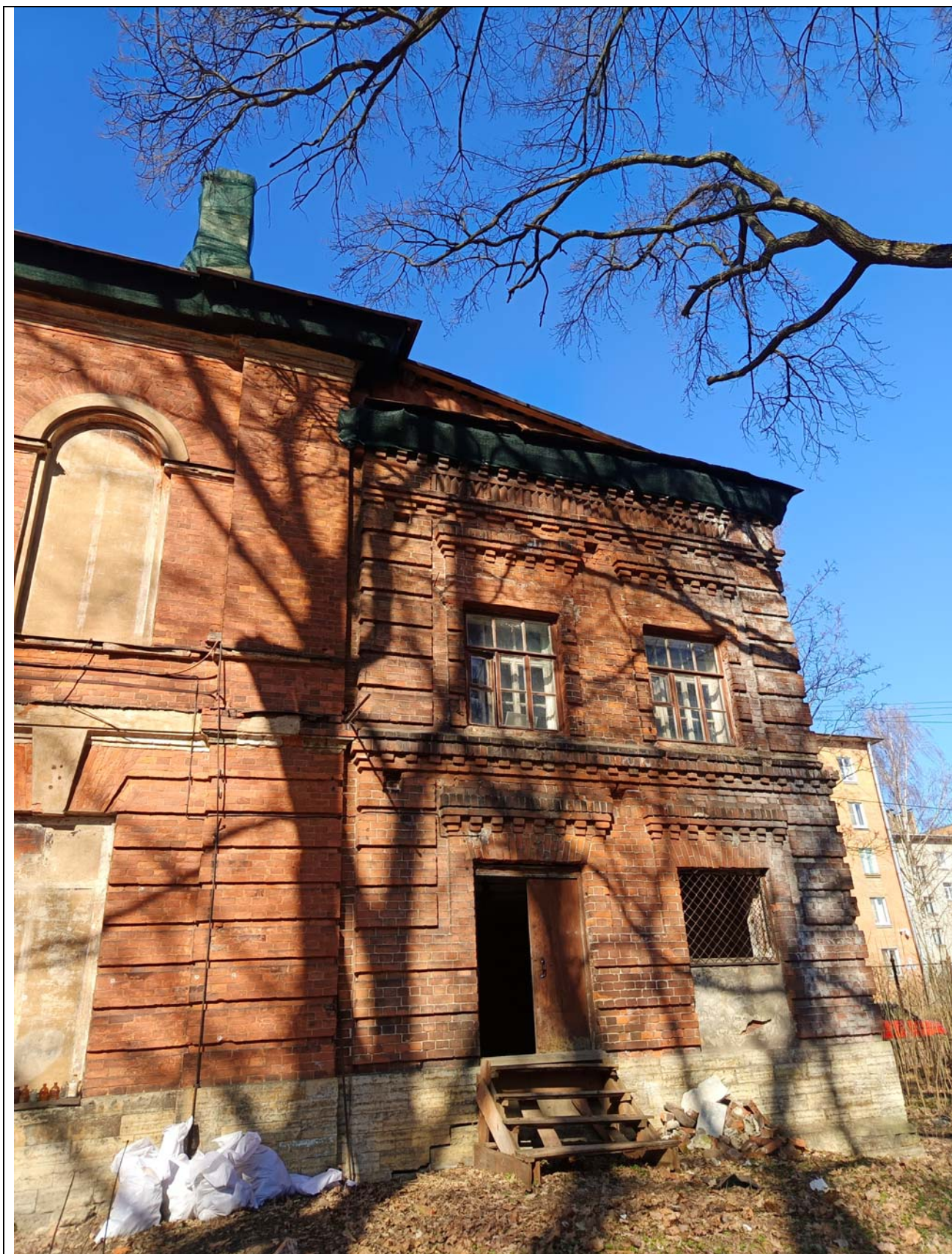
8. «Анатомический театр». Восточный (дворовый) фасад. Двухэтажная пристройка.
