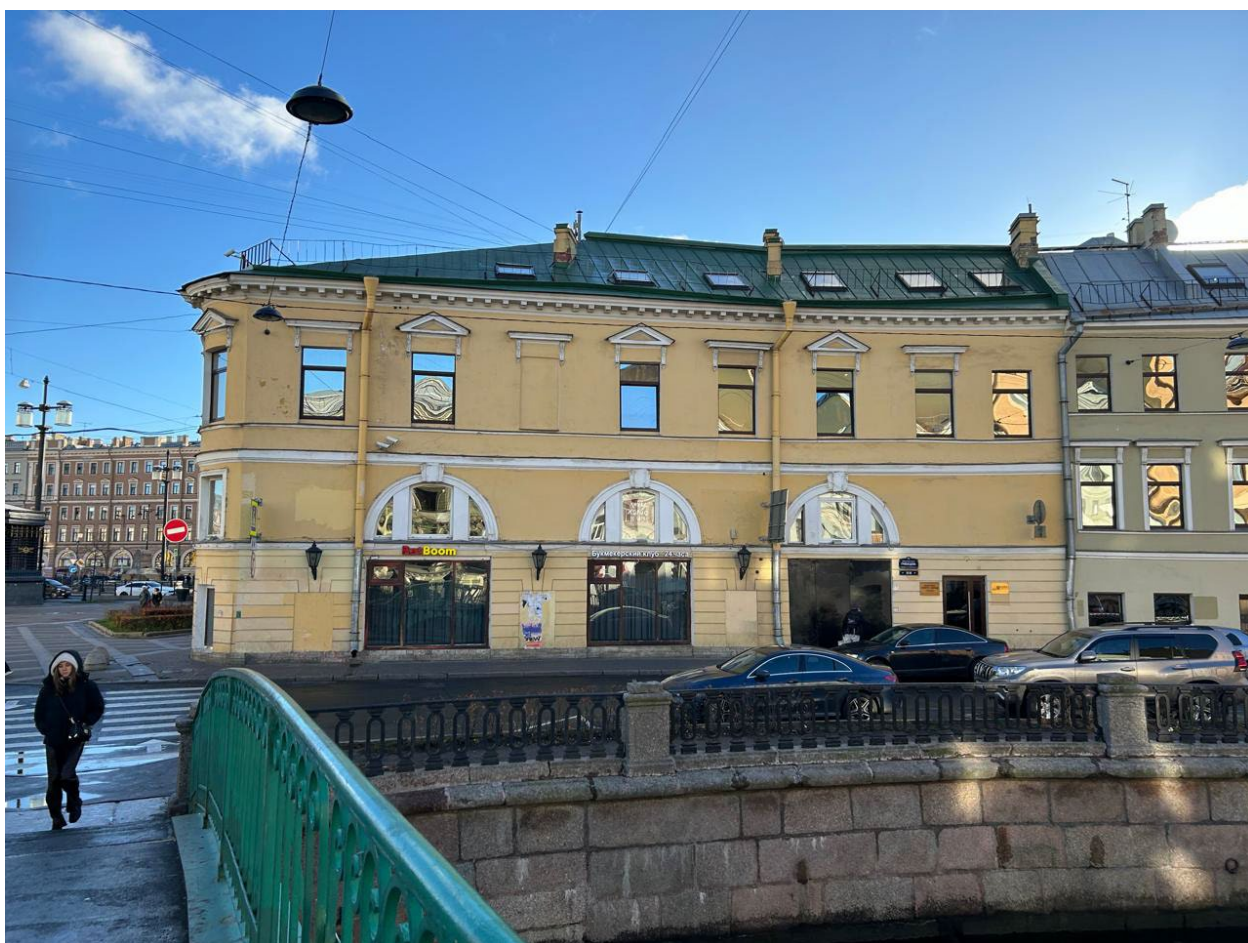
5. Вид на северо-западный фасад выявленного объекта культурного наследия «Дом Терешиных», расположенного по адресу: г. Санкт-Петербург, наб. кан. Грибоедова, д. 56-58, литера А. 01.10.2024
