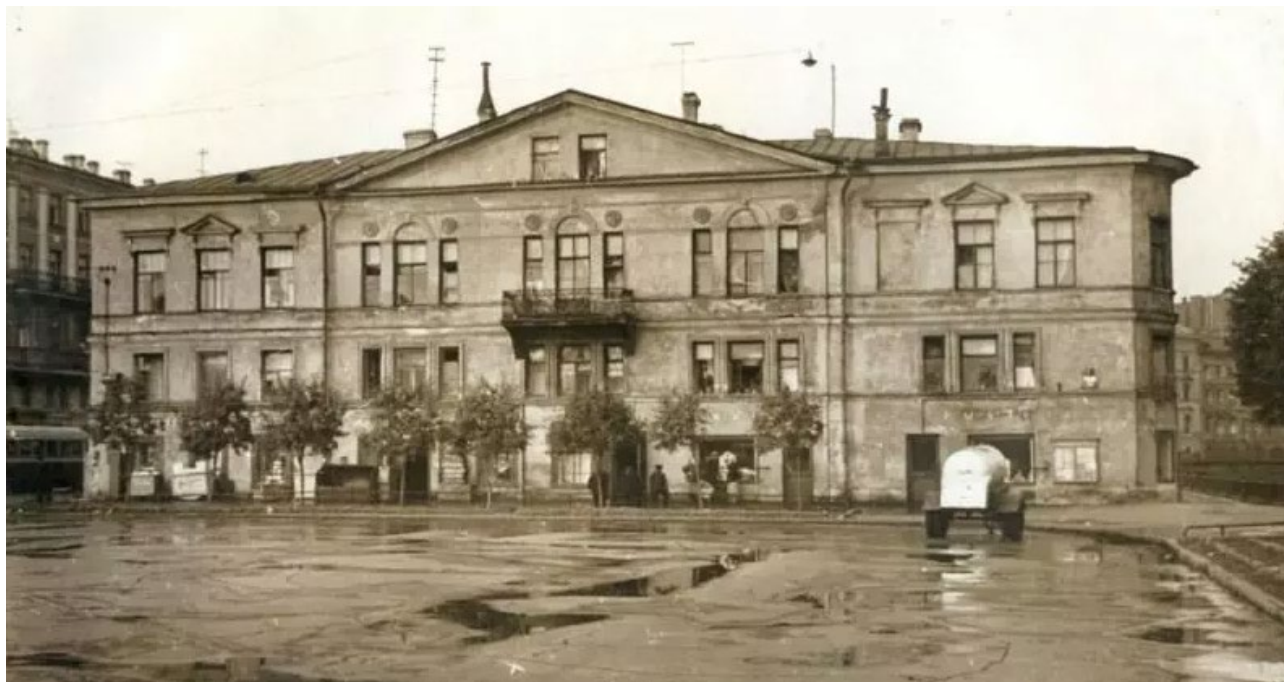
5. Сенная площадь, 1х. Садовая ул. 39. 1955. // ЛМФД ГИК-20960. Инвентарный номер:Ф-2006
