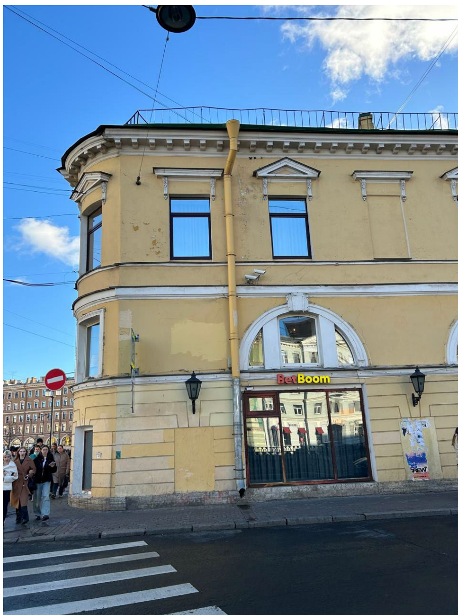
6. Вид на северо-западный фасад выявленного объекта культурного наследия «Дом Терешиных», расположенного по адресу: г. Санкт-Петербург, наб. кан. Грибоедова, д. 56-58, литера А. Фрагмент. 01.10.2024
