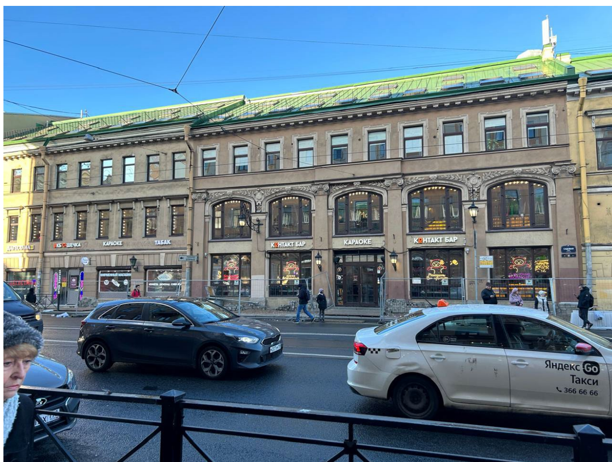
11. Вид на юго-восточный фасад выявленного объекта культурного наследия «Дом Фалевых», расположенного по адресу: г. Санкт-Петербург, наб. кан. Грибоедова, д. 56-58, литера А. 01.10.2024
