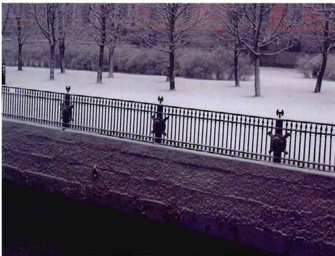
3. Ограждение набережной со стороны Михайловского (Инженерного) замка
