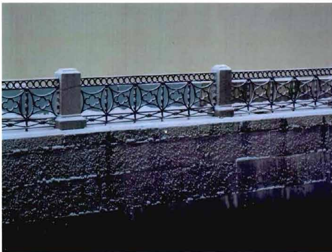
6. Ограждение набережной. Левобережная стенка
