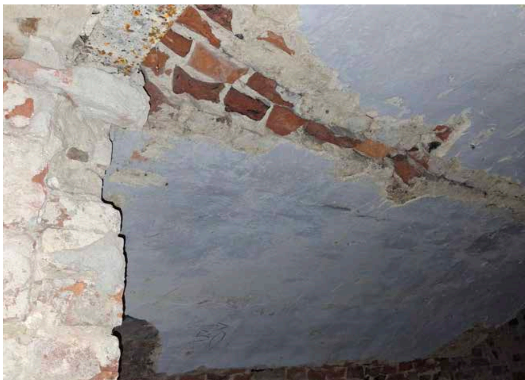
Илл. 19. Цокольный этаж. Пом. 35/9,4. Цилиндрический кирпичный свод. Съемка 06.03.2025 г. Полетайкин В.В.
