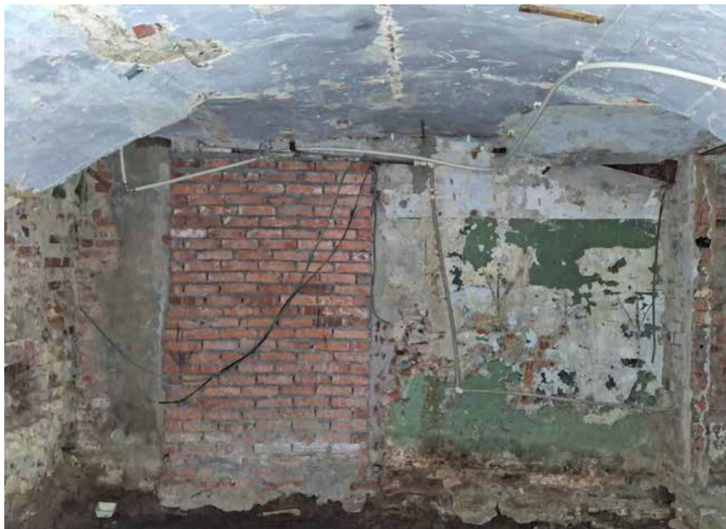
Илл. 18. Цокольный этаж. Пом. 35/9,4. Съемка 06.03.2025 г. Полетайкин В.В.
