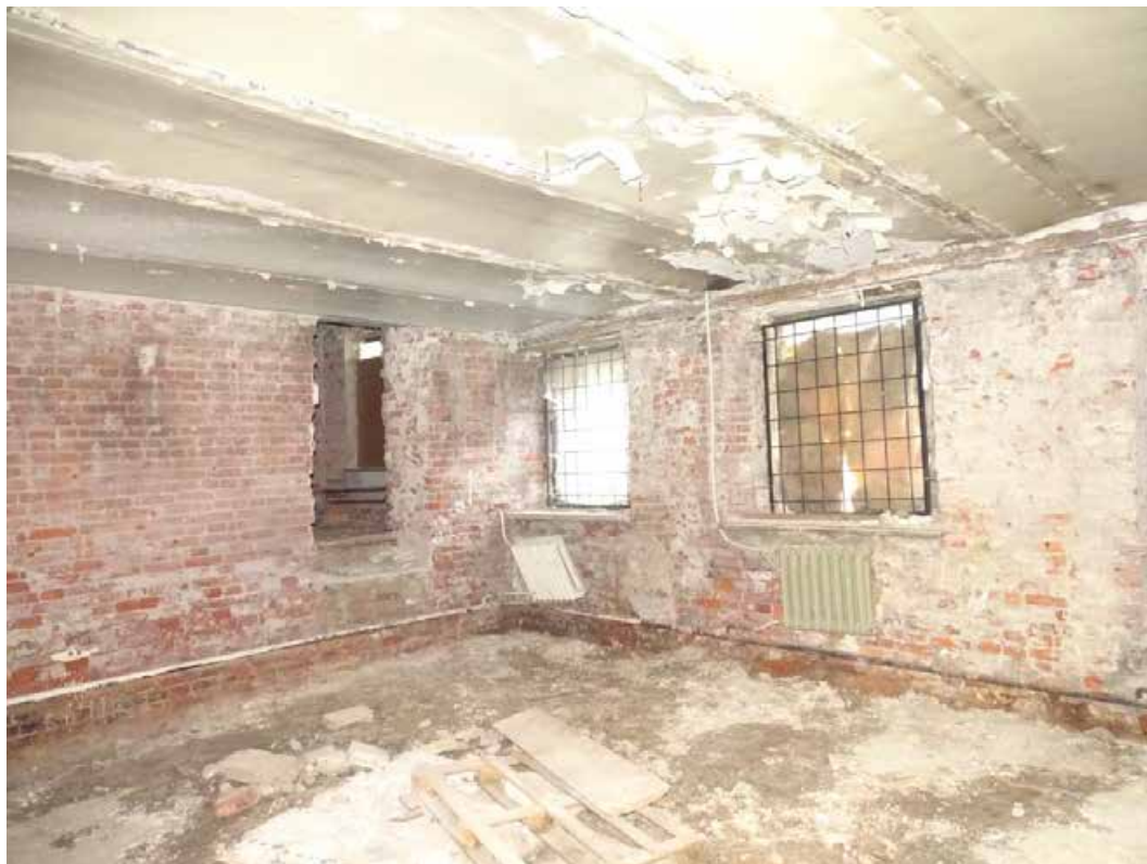
Илл. 11. Цокольный этаж. Пом. 9/11,0; 13/12,0; 14/20,2. Съемка 06.03.2025 г. Полетайкин В.В.
