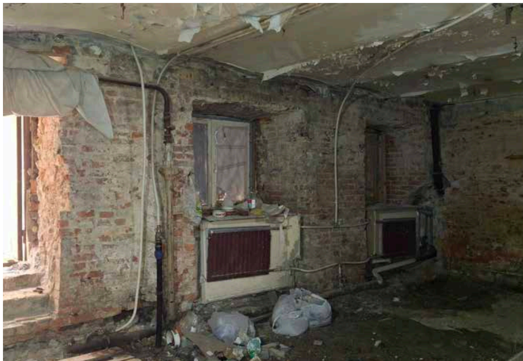
Илл. 3. Цокольный этаж. Пом. 1/14,5; 2/18,0. Съемка 06.03.2025 г. Полетайкин В.В.
