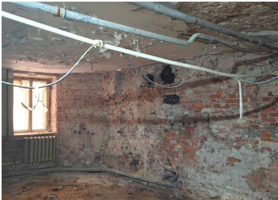
Илл. 1. Цокольный этаж. Пом. 39/17,9. Съемка 06.03.2025 г. Полетайкин В.В.
