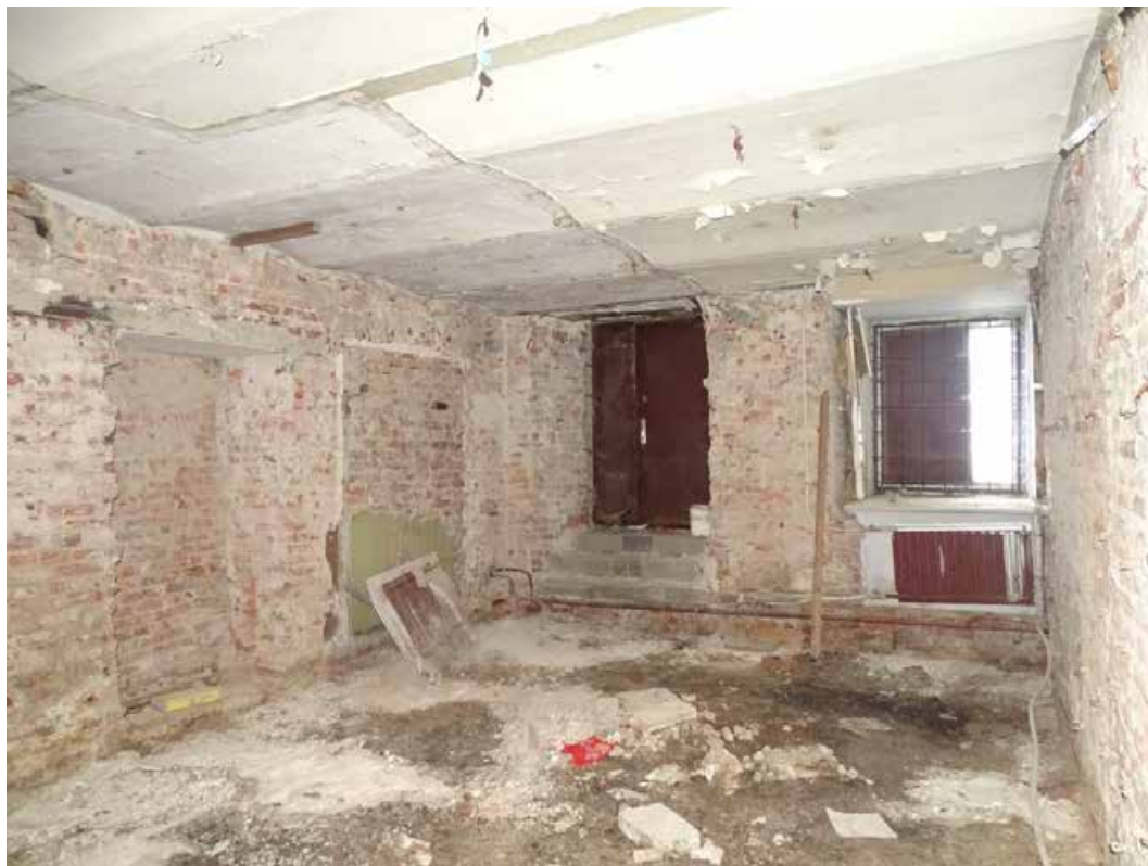
Илл. 7. Цокольный этаж. Пом. 3/5,2; 4/2,9; 5/1,4; 6/13,9; 17/19,0; 18/8,8; 19/5,2. Съемка 06.03.2025 г. Полетайкин В.В.
