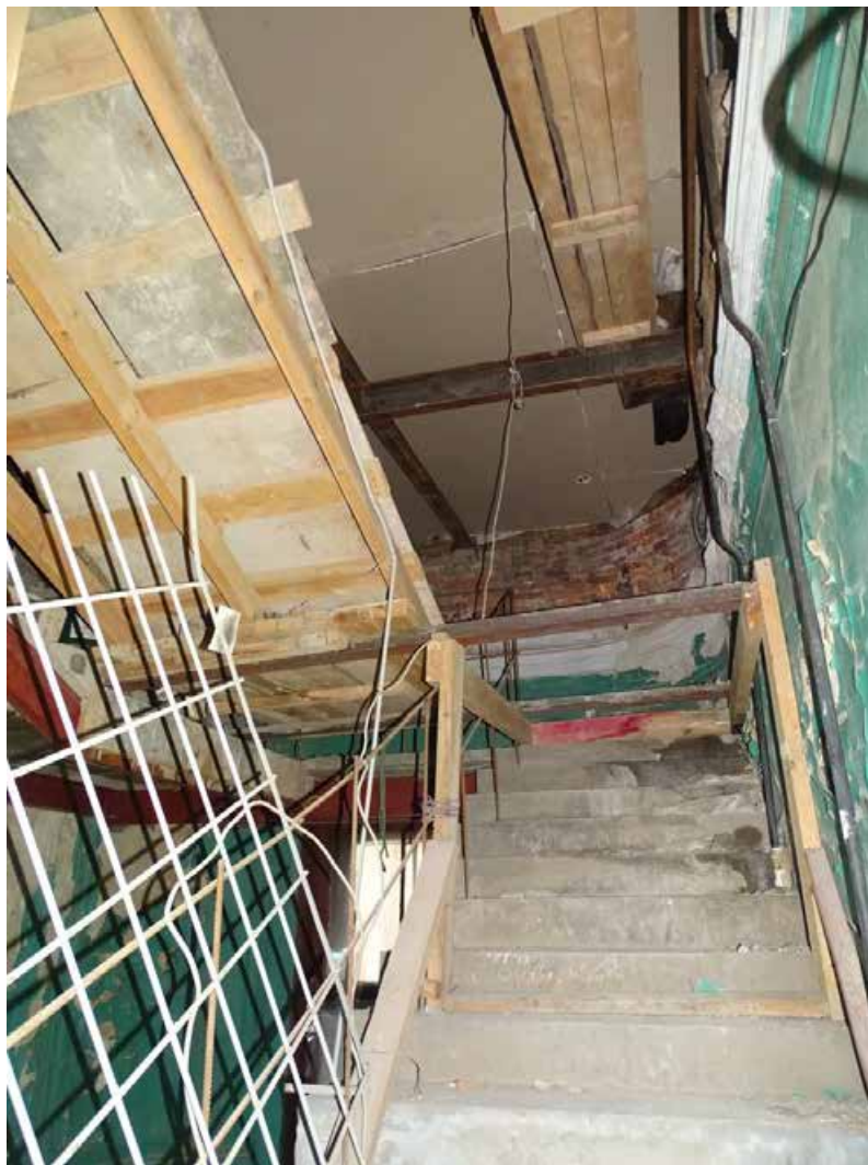
Илл. 1. 4-й этаж. Лестница 1ЛК. Съемка 06.03.2025 г. Полетайкин В.В.
