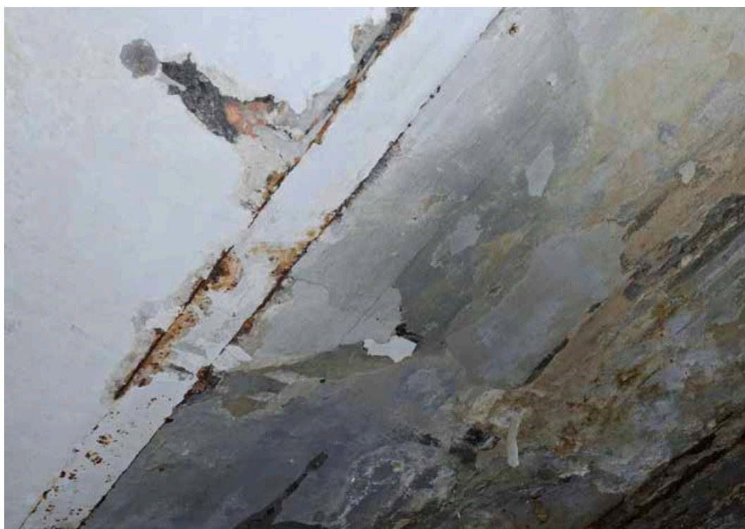
Илл. 8. Цокольный этаж. Пом. 3/5,2; 4/2,9; 5/1,4; 6/13,9; 17/19,0; 18/8,8; 19/5,2. Сводики бетонные. Съемка 06.03.2025 г. Полетайкин В.В.
