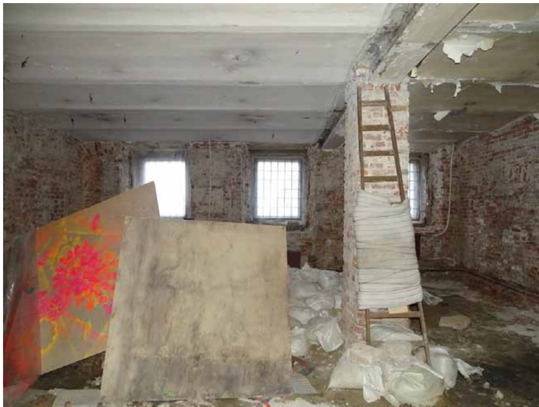
Илл. 5. Цокольный этаж. Пом. 20/26,7; 28/13,4. Съемка 06.03.2025 г. Полетайкин В.В.
