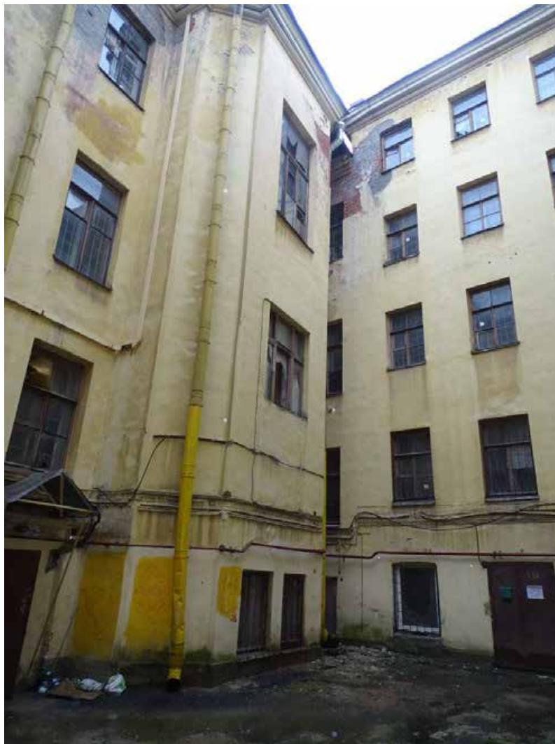
Илл. 05. Внутренний двор. Дворовые фасады лицевого корпуса лит. Б. Дворовой корпус лит. А. Съемка 06.03.2025 г. Полетайкин В.В.
