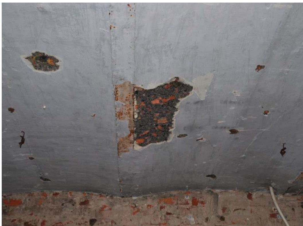
Илл. 17. Цокольный этаж. Пом. 31/50,9. Бетонные сводики. Съемка 06.03.2025 г. Полетайкин В.В.
