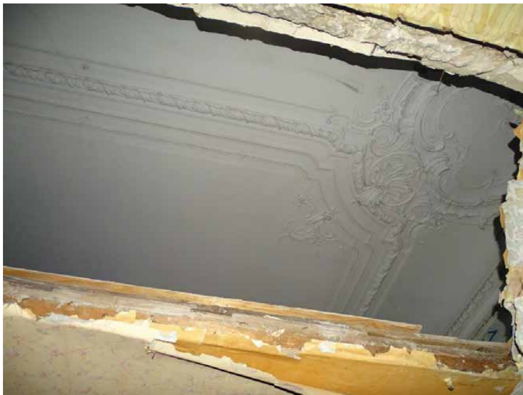
Илл. 7. 2-й этаж. Пом. 24/10,3. Фрагмент плафона. Съемка 06.03.2025 г. Полетайкин В.В.
