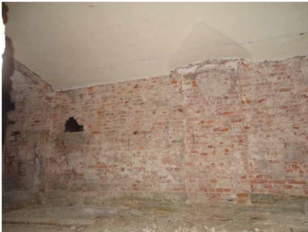
Илл. 13. Цокольный этаж. Пом. 4/17,3. Бетонный свод с кирпичными распалубками. Съемка 06.03.2025 г. Полетайкин В.В.
