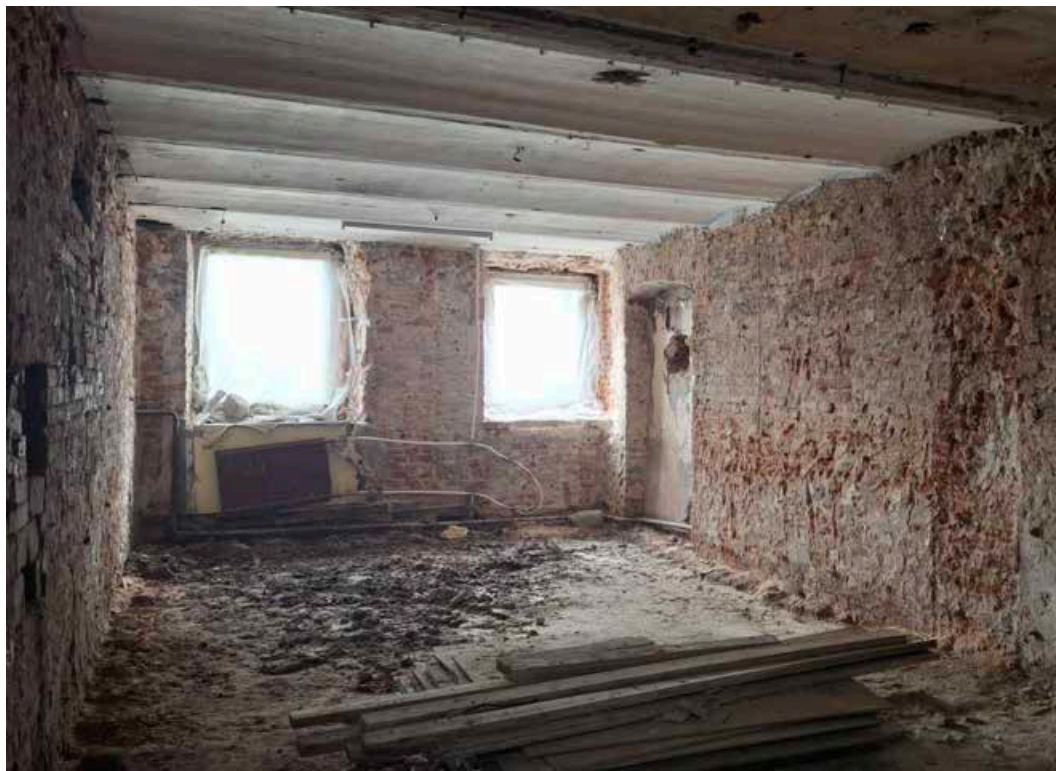
Илл. 14. Цокольный этаж. Пом. 29/24,9; 32/9,4; 33/9,7. Съемка 06.03.2025 г. Полетайкин В.В.
