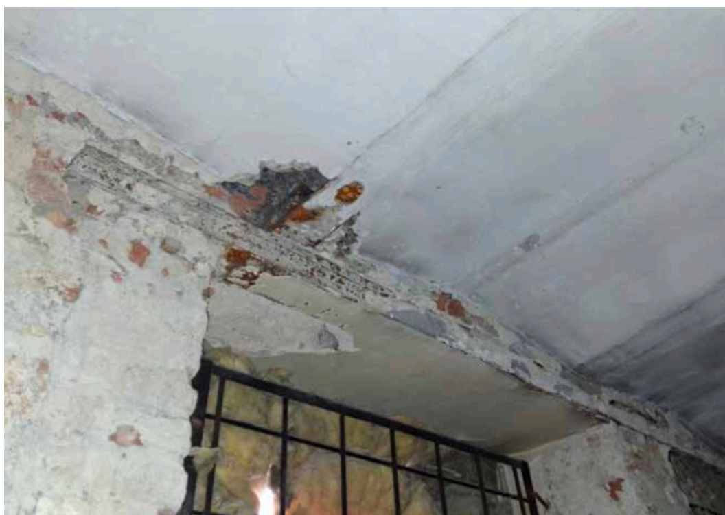
Илл. 12. Цокольный этаж. Пом. 9/11,0; 13/12,0; 14/20,2. Сводики бетонные. Съемка 06.03.2025 г. Полетайкин В.В.
