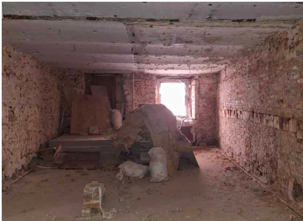
Илл. 16. Цокольный этаж. Пом. 31/50,9. Съемка 06.03.2025 г. Полетайкин В.В.
