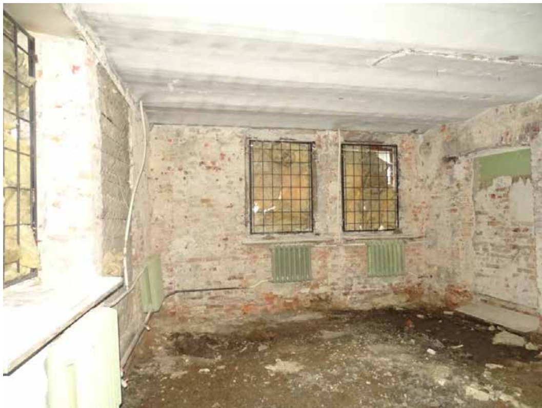
Илл. 09. Цокольный этаж. Пом. 15/21,5. Съемка 06.03.2025 г. Полетайкин В.В.
