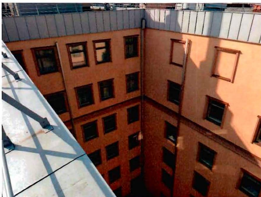
3. Вид на дворовые фасады объекта культурного наследия
