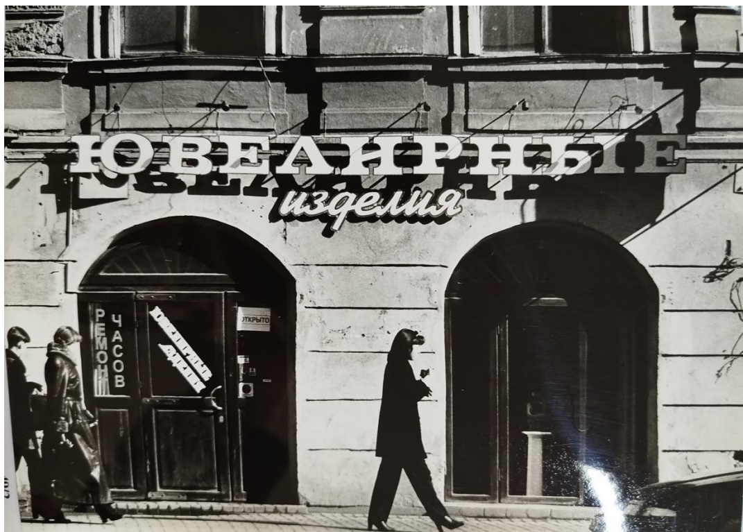
47. Фрагмент фасада дома А.М. Ушакова. КГИОП. П. 886. Пр. 15. Фотофиксация фасада дома купца А.М. Ушакова (до реставрации). 1999.
