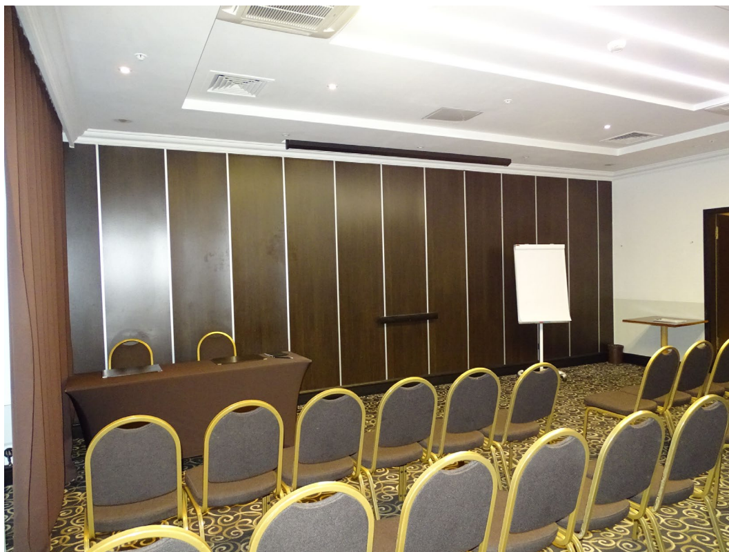
03. Помещение 1-Н (21). Вид на перегородку (по оси С). Съемка 09.04.2025 г. Полетайкин В.В.
