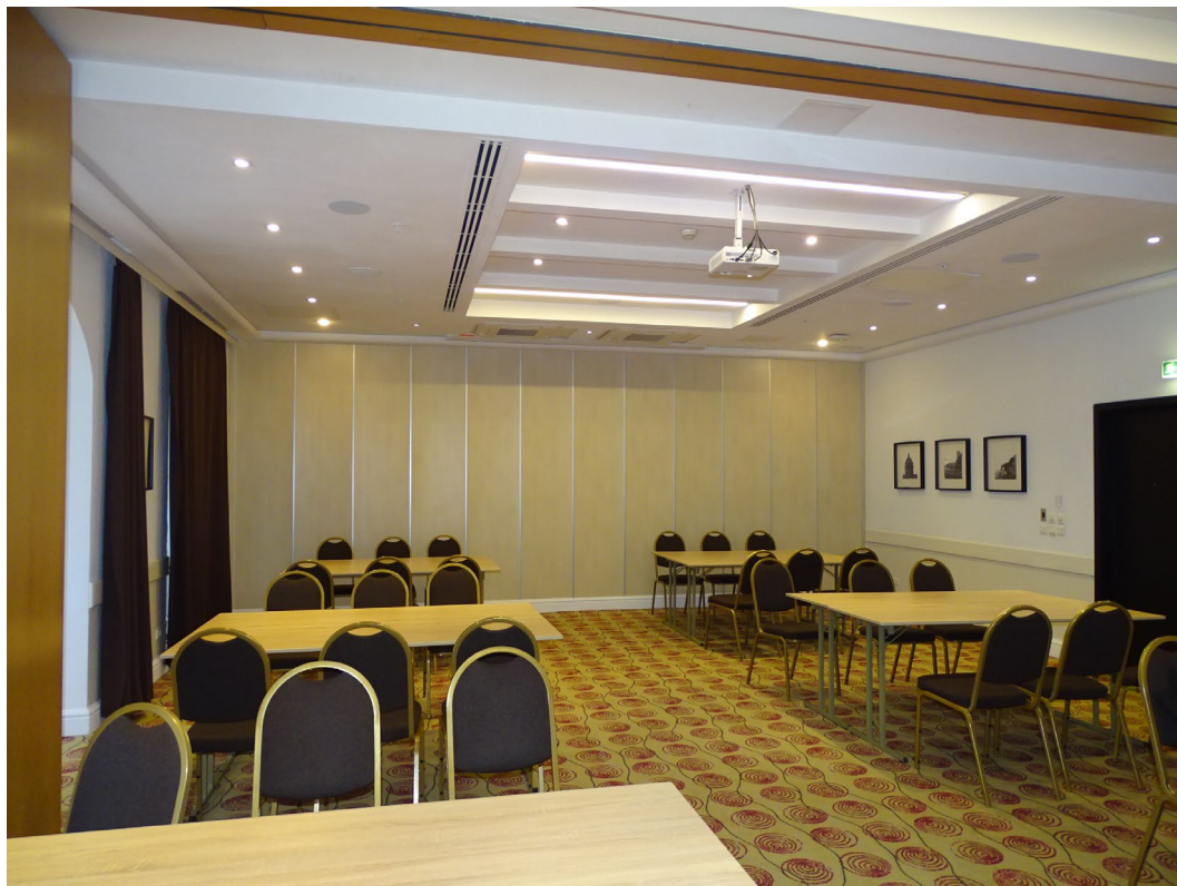
01. Помещение 1-Н (22). Вид на перегородку (по оси Д), в которой предполагается устройство проемов. Съемка 09.04.2025 г. Полетайкин В.В.
