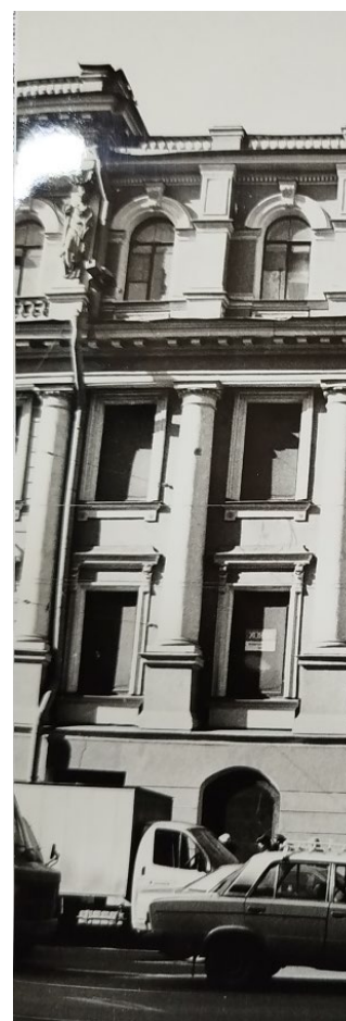
46. Фрагмент фасада по Владимирскому проспекту с левым портиком. КГИОП. П. 886. Пр. 15. Фотофиксация фасада Дома купца А. М. Ушакова. 1999.
