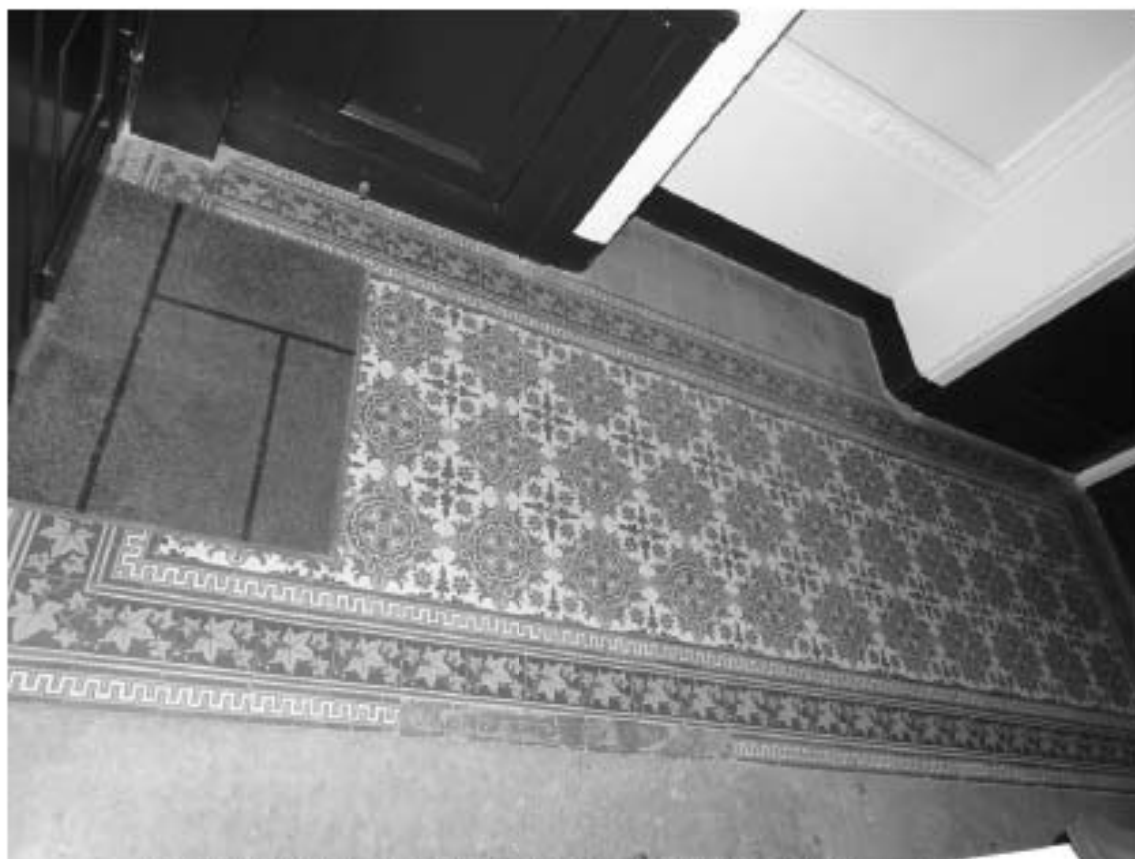
Фото 42. Лестница № 1. Площадка 3-го этажа. Покрытие пола. Съемка 26.04.2021 г. Михайловская Г. В.
