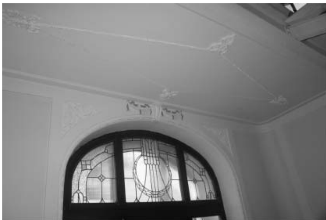
Фото 60. Лестница № 1. Площадка между 4-м и 5-м этажом. Заполнение оконных проемов.
