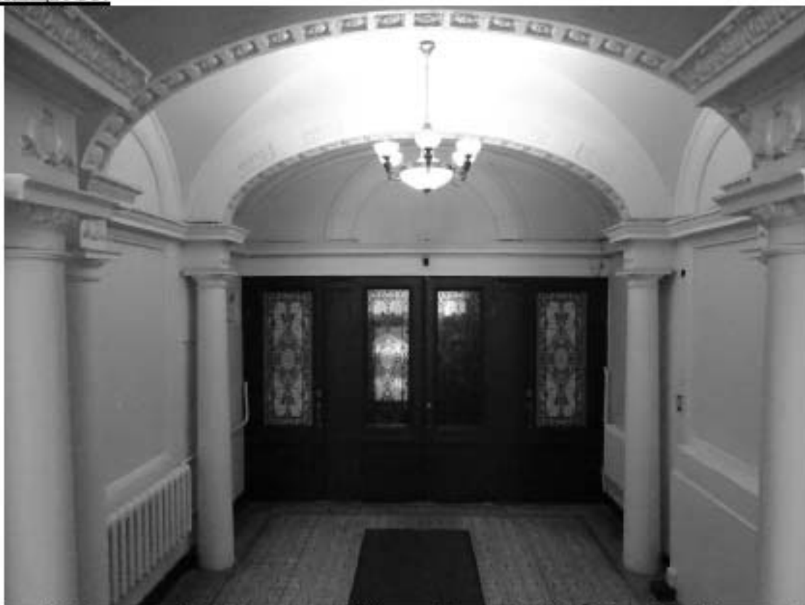
Фото 110. Лестница № 3. Вестибюль. 1-й этаж. Съемка 26.04.2021 г. Михайловская Г. В.
