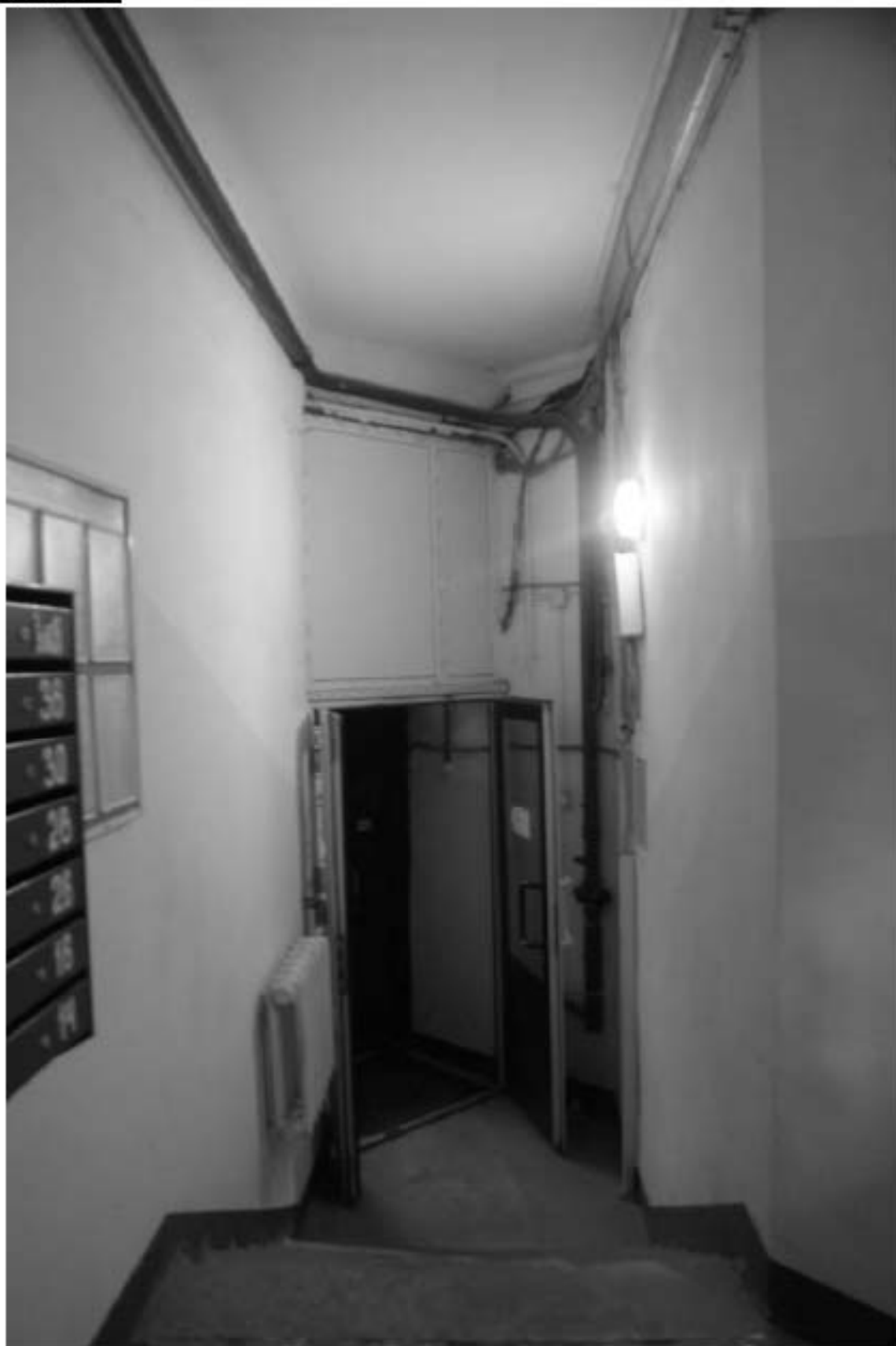
Фото 79. Лестница № 2. 1-й этаж. Входная дверь. Съемка 26.04.2021 г. Михайловская Г. В.
