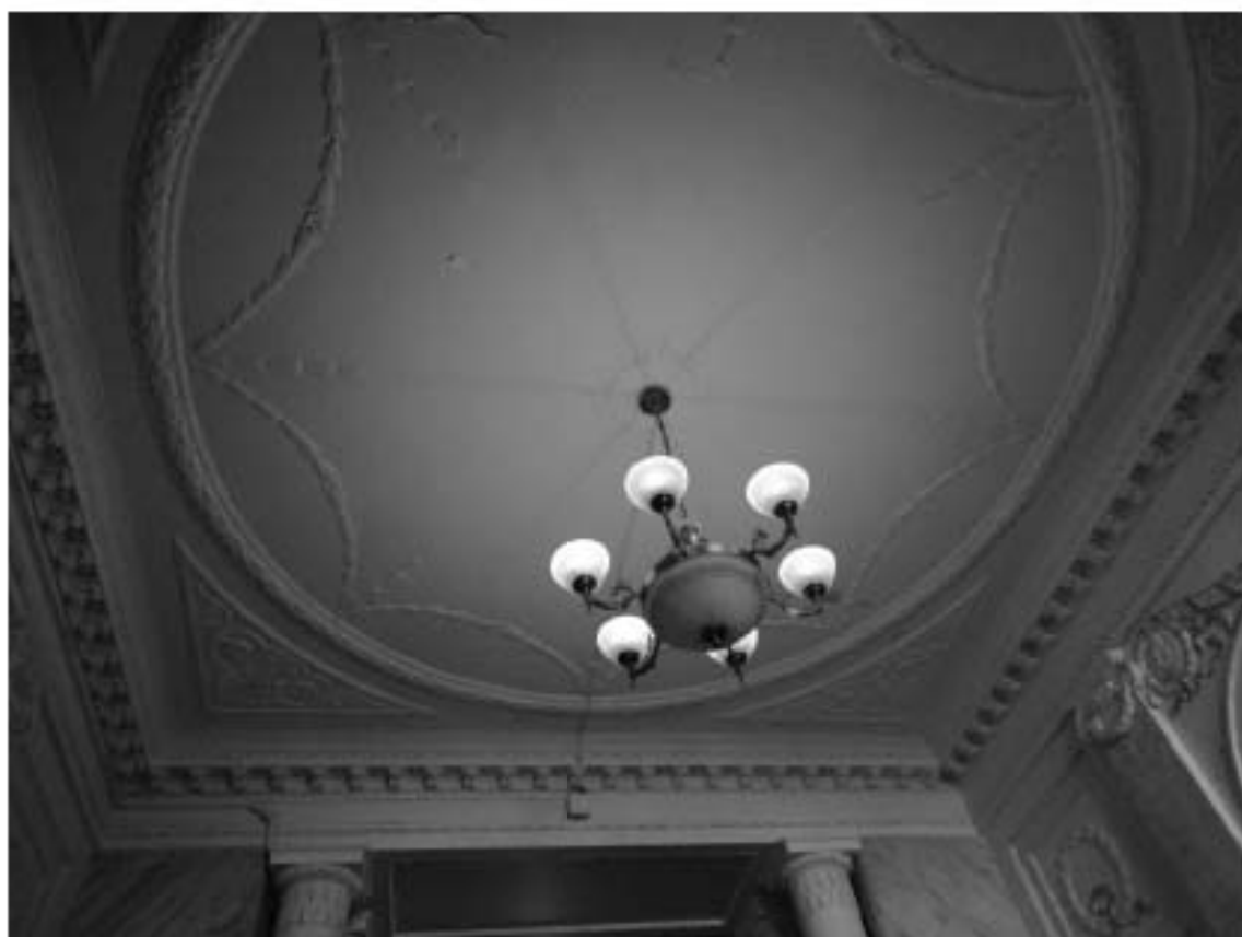
Фото 16. Лестница № 1. Вестибюль. 1-го этажа. Оформление плафона. Съемка 26.04.2021 г. Михайловская Г. В.
