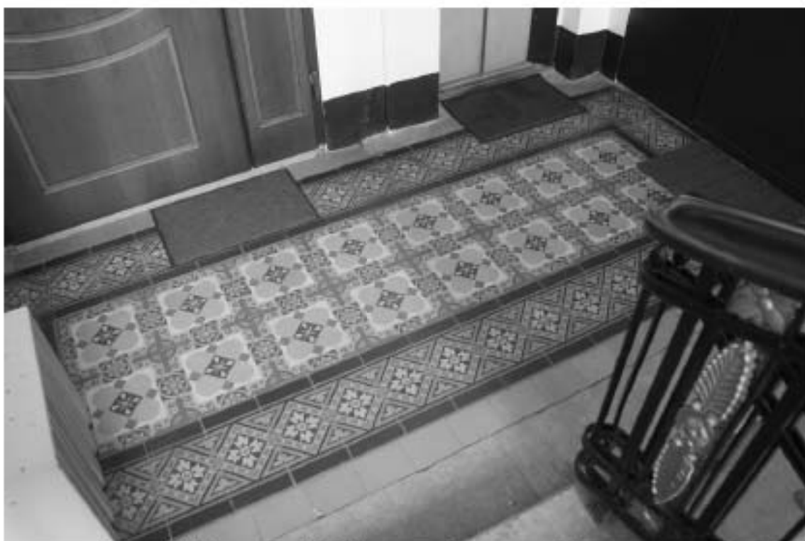
Фото 154. Лестница № 3. Площадка 4-го этажа. Покрытие пола. Съемка 26.04.2021 г. Михайловская Г. В.
