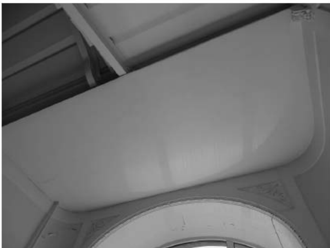
Фото 136. Лестница № 3. Площадка между 1-м и 2-м этажом. Оформление оконного проема.
