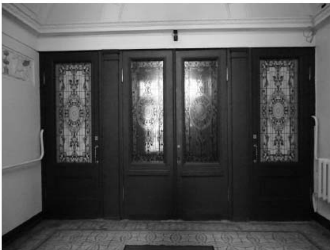
Фото 111. Лестница № 3. Вестибюль. 1-й этаж. Входная дверь. Съемка 26.04.2021 г. Михайловская Г. В.
