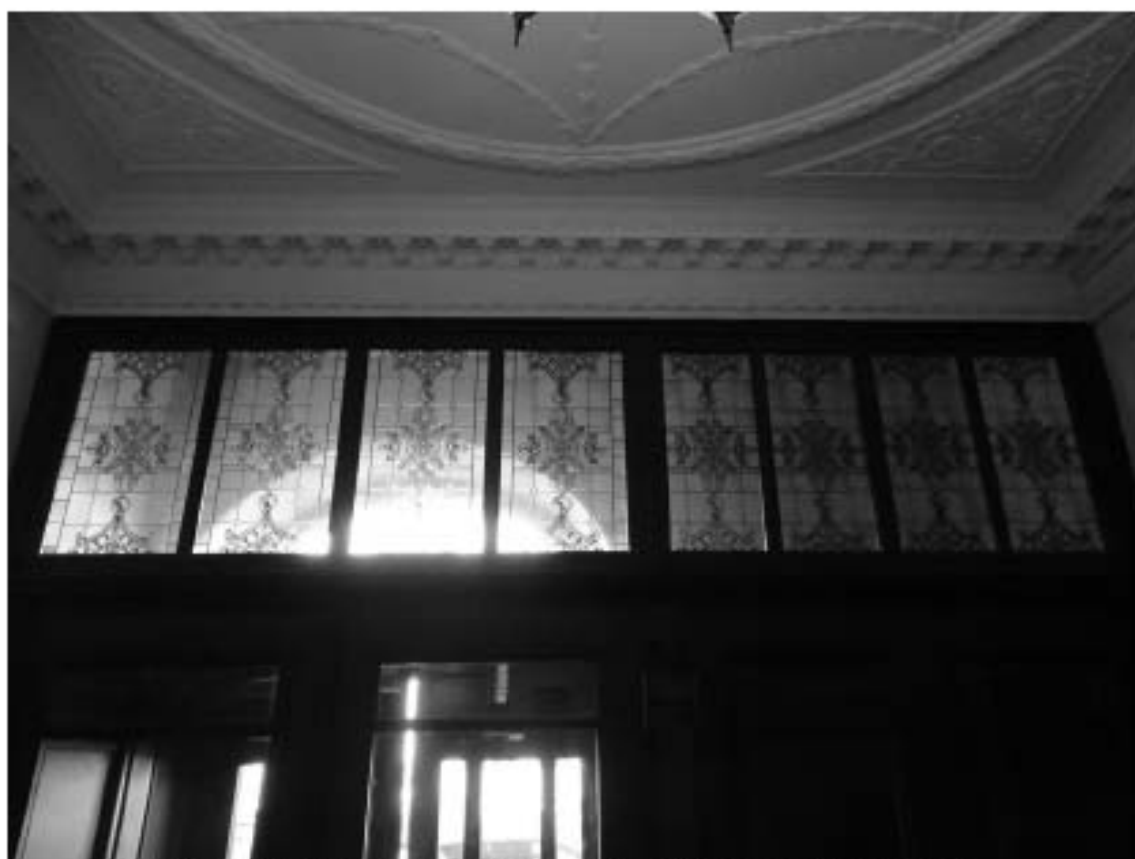
Фото 2. Лестница № 1. Вестибюль. 1-й этаж. Входная дверь. Съемка 26.04.2021 г. Михайловская Г. В.
