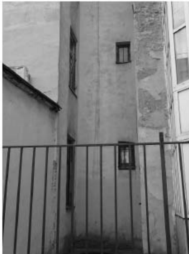
Фото 55. Фрагмент восточного фасада. Съемка 26.04.2021 г. Михайловская Г. В.
