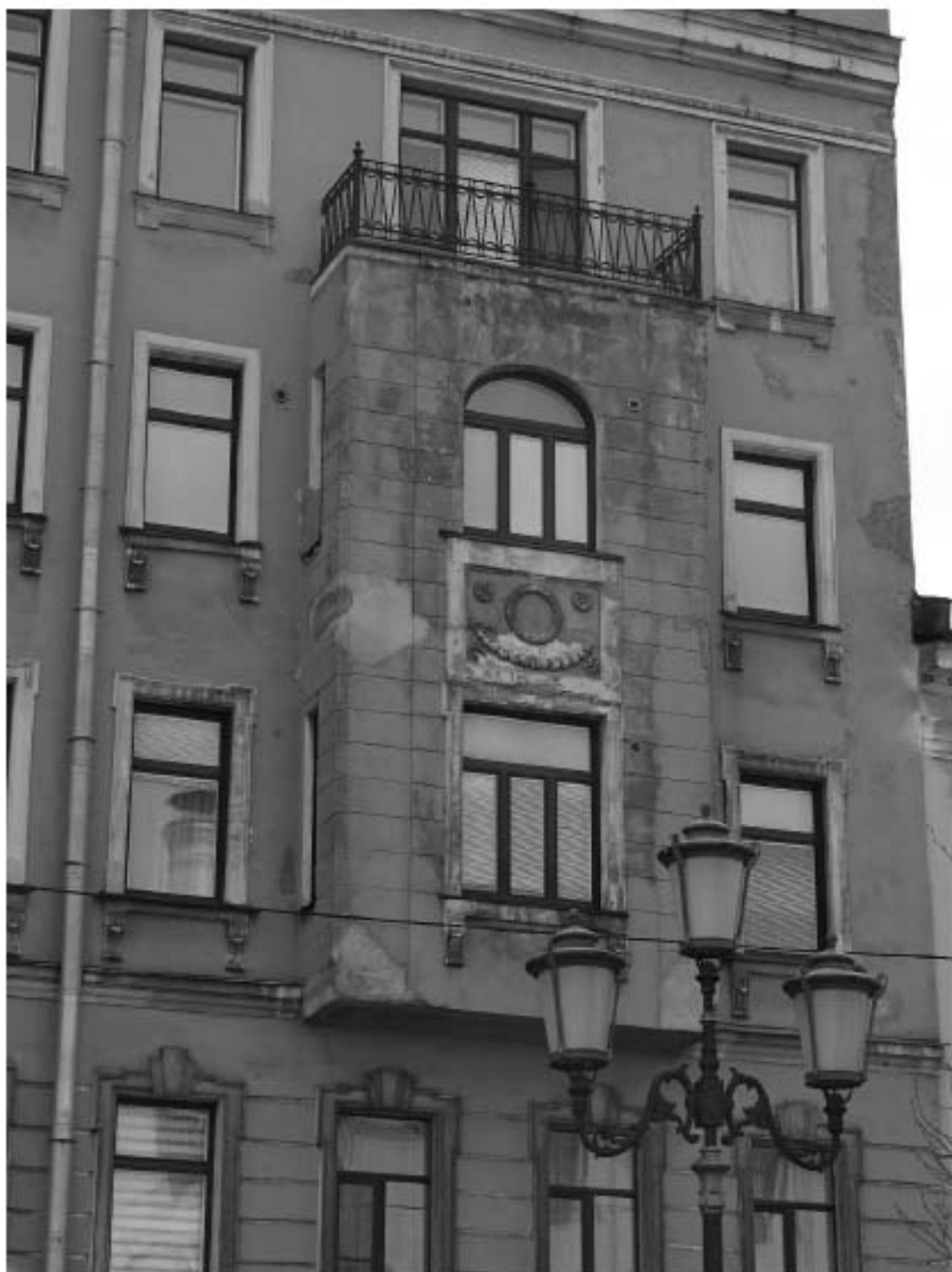
Фото 7. Фрагмент лицевого фасада. Эркер. 3-й, 4-й, 5-й этажи. Съемка 26.04.2021 г. Михайловская Г. В.
