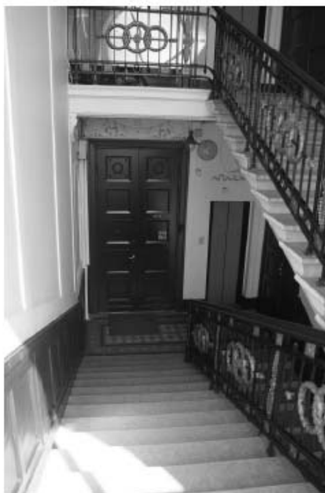
Фото 159. Лестница № 3. Площадка 5-го этажа. Съемка 26.04.2021 г. Михайловская Г. В.
