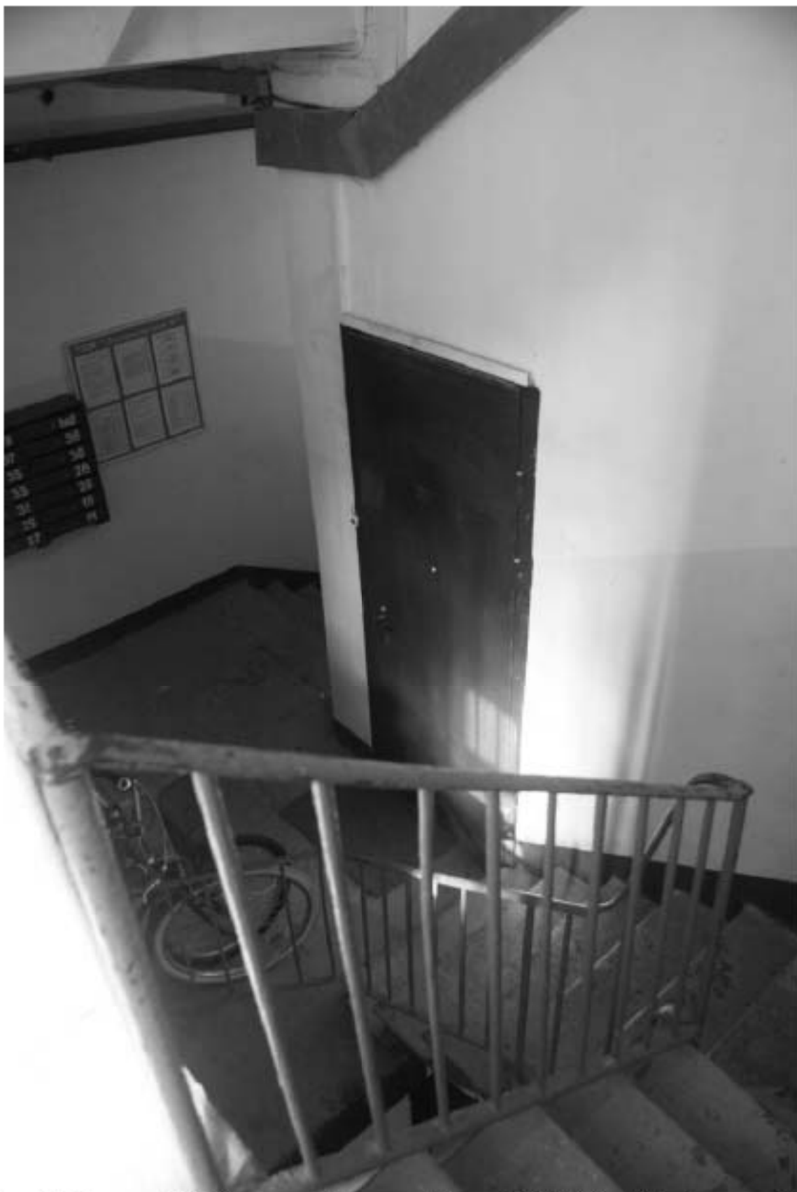
Фото 90. Лестница № 2. Площадка 1-го этажа. Съемка 26.04.2021 г. Михайловская Г. В.
