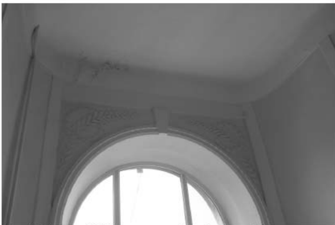
Фото 166. Лестница № 3. Площадка между 5-м и 6-м этажом. Оформление стены. Съемка 26.04.2021 г. Михайловская Г. В.
