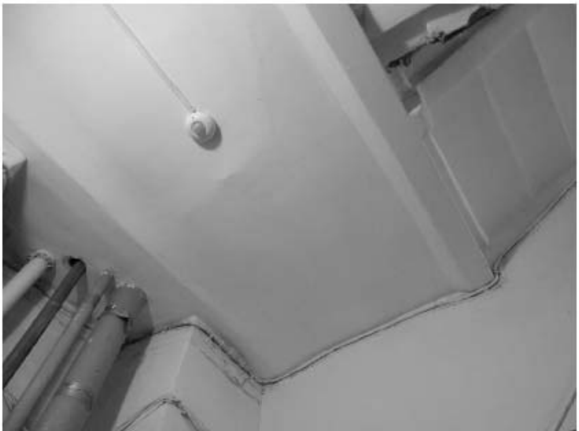
Фото 177. Лестница № 4. Площадка 1-го этажа. Лестничное перекрытие. Съемка 26.04.2021 г. Михайловская Г. В.
