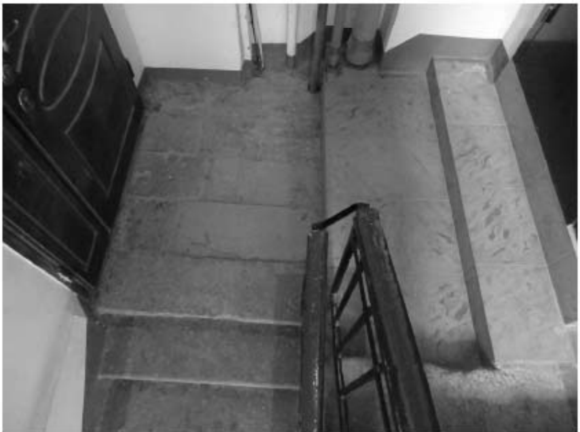
Фото 186. Лестница № 4. Площадка 4-го этажа. Съемка 26.04.2021 г. Михайловская Г. В.
