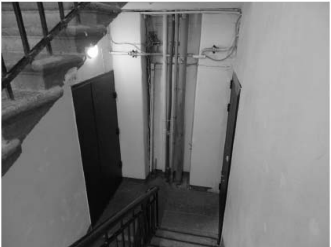
Фото 180. Лестница № 4. Площадка 2-го этажа. Съемка 26.04.2021 г. Михайловская Г. В.
