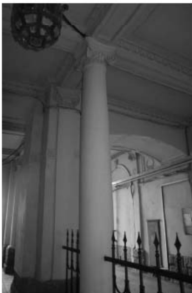
Фото 25. Колонна внутри проезда. Съемка 26.04.2021 г. Михайловская Г. В.
