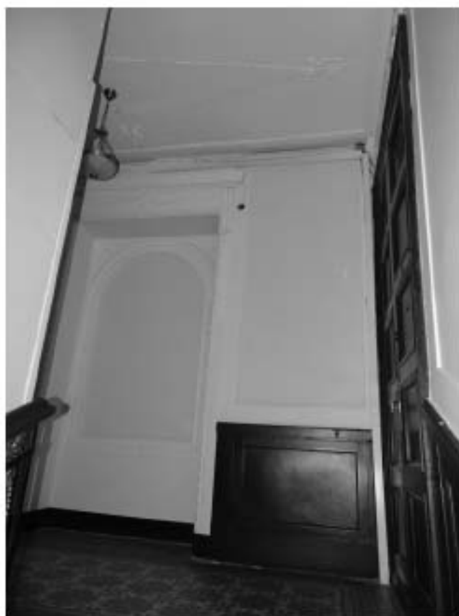
Фото 41. Лестница № 1. Площадка 3-го этажа. Съемка 26.04.2021 г. Михайловская Г. В.
