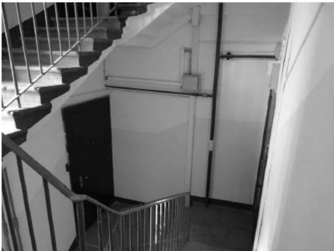
Фото 102. Лестница № 2. Площадка 5-го этажа. Съемка 26.04.2021 г. Михайловская Г. В.
