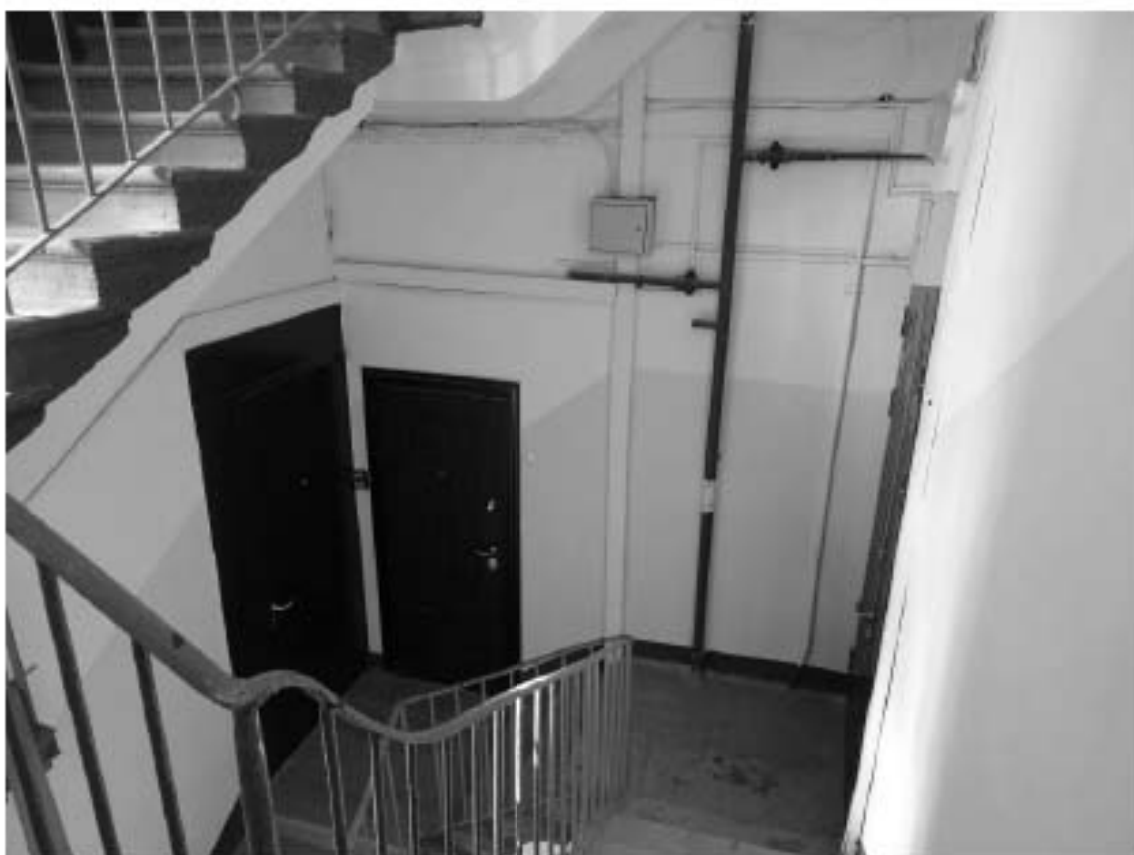
Фото 101. Лестница № 2. Площадка 4-го этажа. Съемка 26.04.2021 г. Михайловская Г. В.
