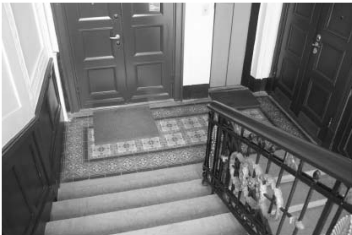
Фото 160. Лестница № 3. Площадка 5-го этажа. Покрытие пола. Съемка 26.04.2021 г. Михайловская Г. В.
