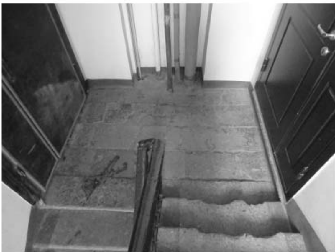
Фото 189. Лестница № 4. Площадка 5-го этажа. Съемка 26.04.2021 г. Михайловская Г. В.
