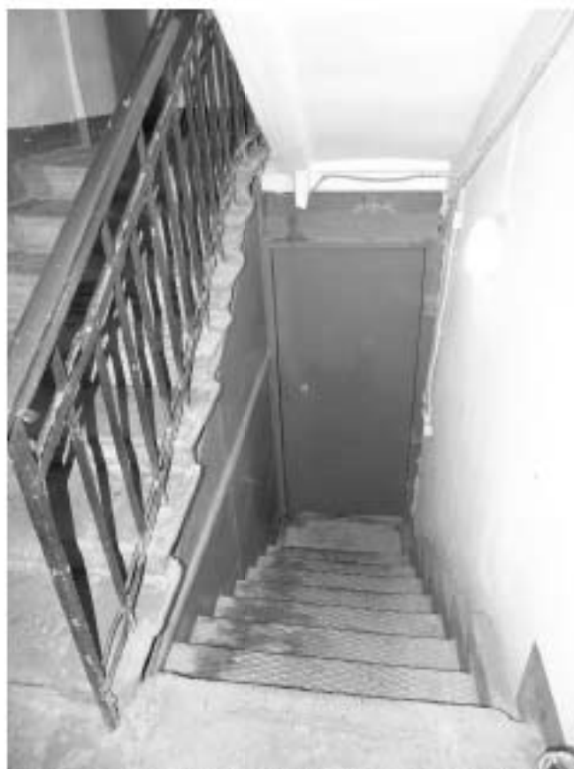
Фото 173. Лестница № 4. Дверь в подвал. Съемка 26.04.2021 г. Михайловская Г. В.
