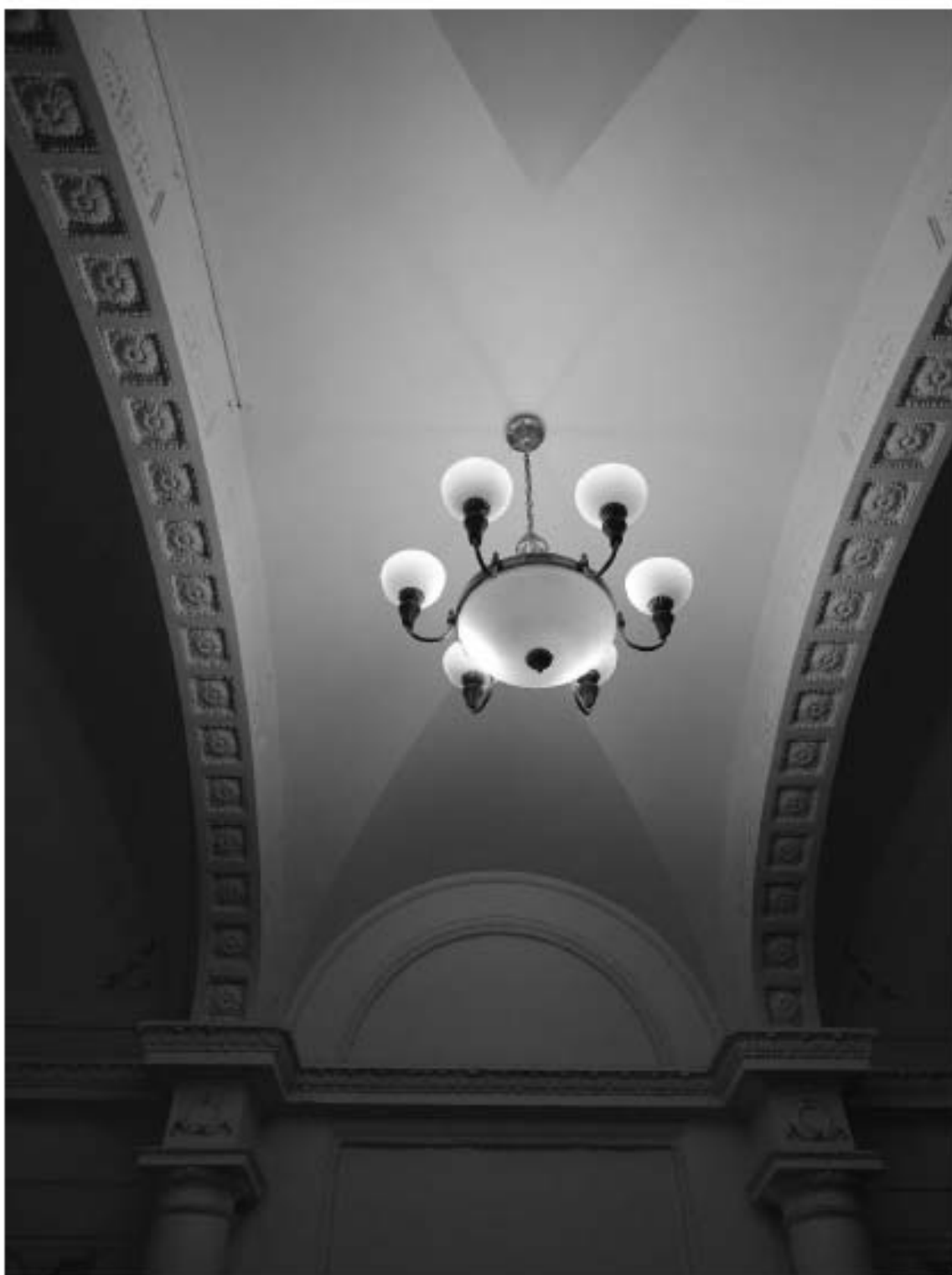
Фото 119. Лестница № 3. Вестибюль 1-й этаж. Крестовый свод. Съемка 26.04.2021 г. Михайловская Г. В.
