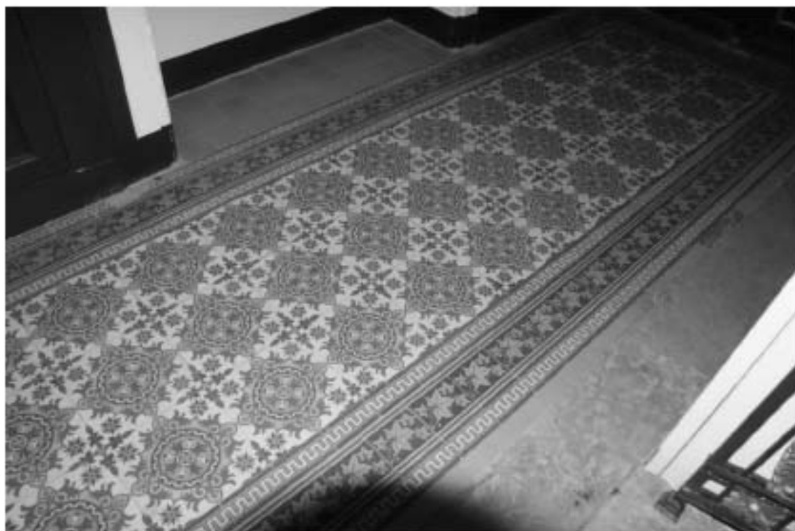
Фото 54. Лестница № 1. Площадка 4-го этажа. Покрытие пола. Съемка 26.04.2021 г. Михайловская Г. В.
