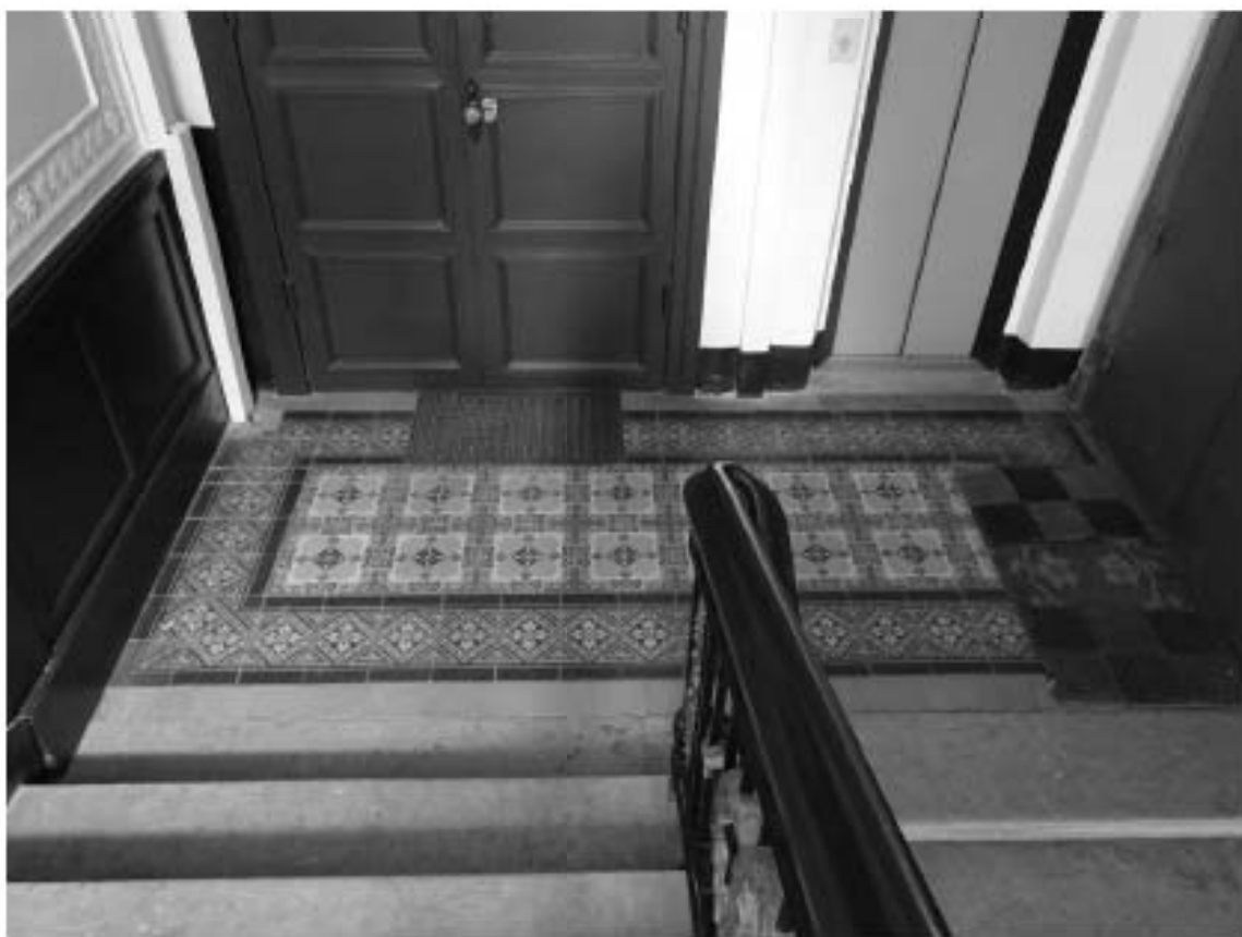
Фото 131. Лестница № 3. Площадка 2-го этажа. Покрытие пола. Съемка 26.04.2021 г. Михайловская Г. В.
