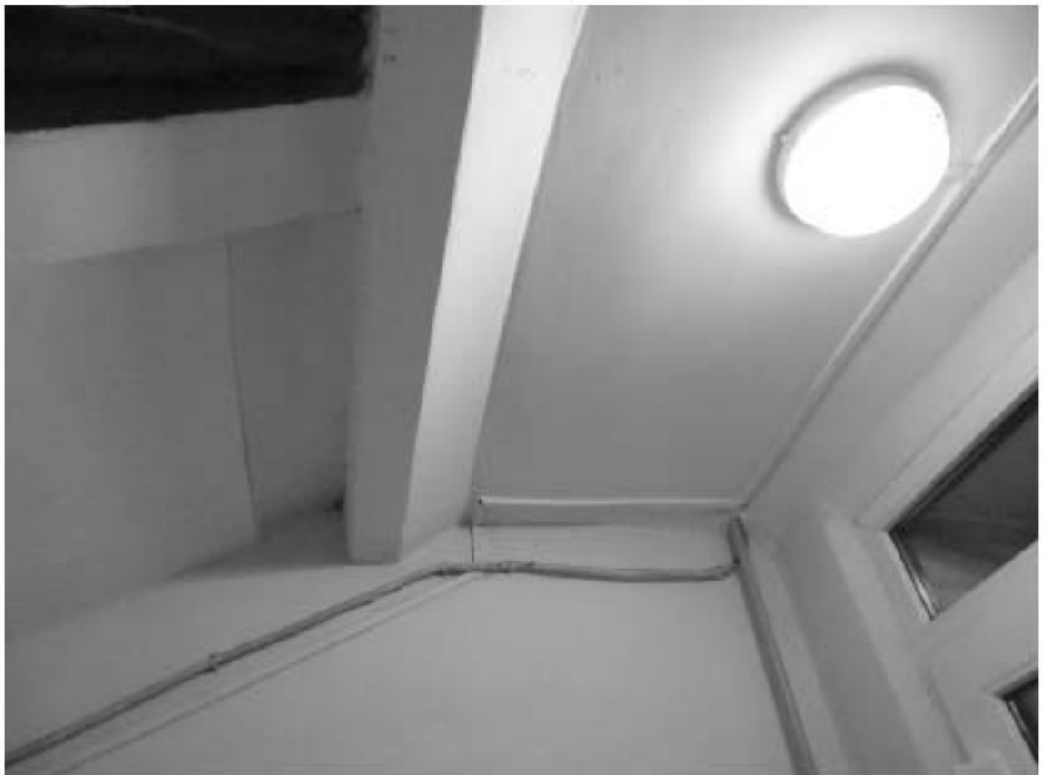
Фото 175. Лестница № 4. 1-й этаж. Перекрытие. Съемка 26.04.2021 г. Михайловская Г. В.
