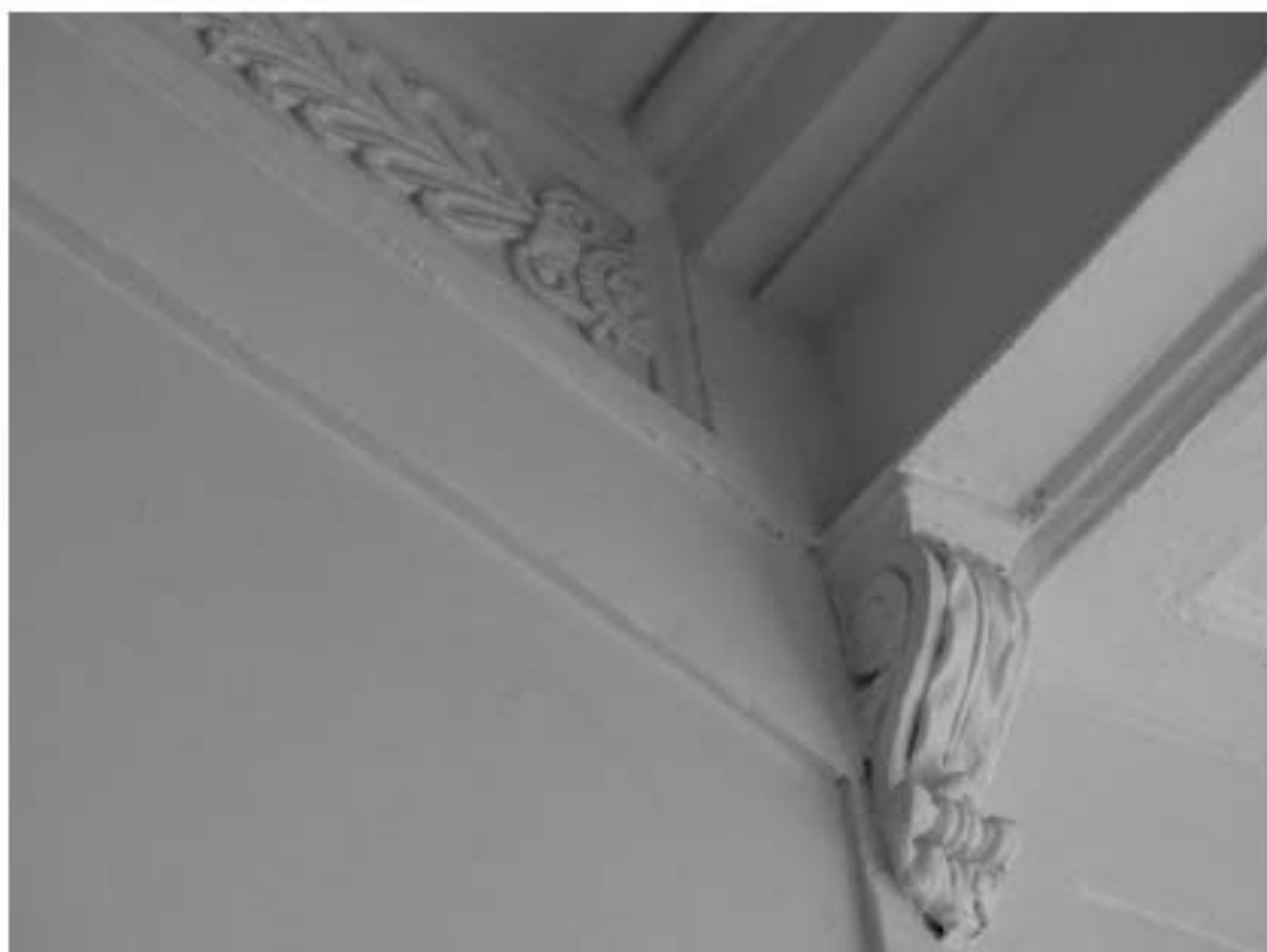
Фото 135. Лестница № 3. Площадка между 2-м и 3-м этажом. Кронштейн. Съемка 26.04.2021 г. Михайловская Г. В.
