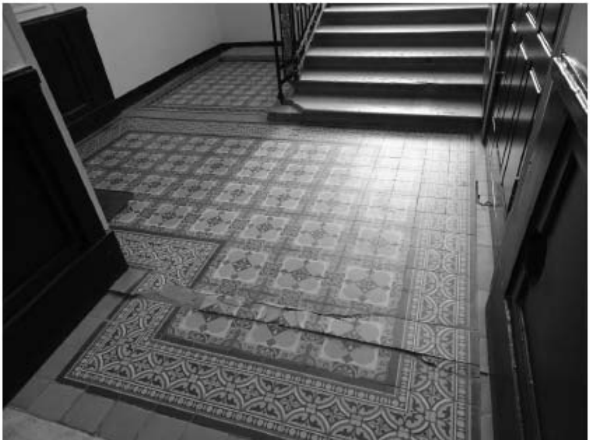
Фото 116. Лестница № 3. Площадка 1-го этажа. Покрытие пола. Съемка 26.04.2021 г. Михайловская Г. В.
