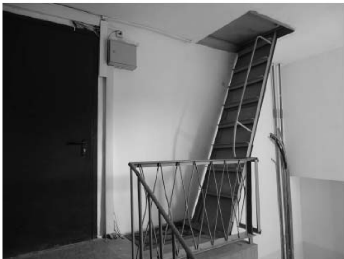
Фото 109. Лестница № 2. Площадка 7-го этажа. Съемка 26.04.2021 г. Михайловская Г. В.
