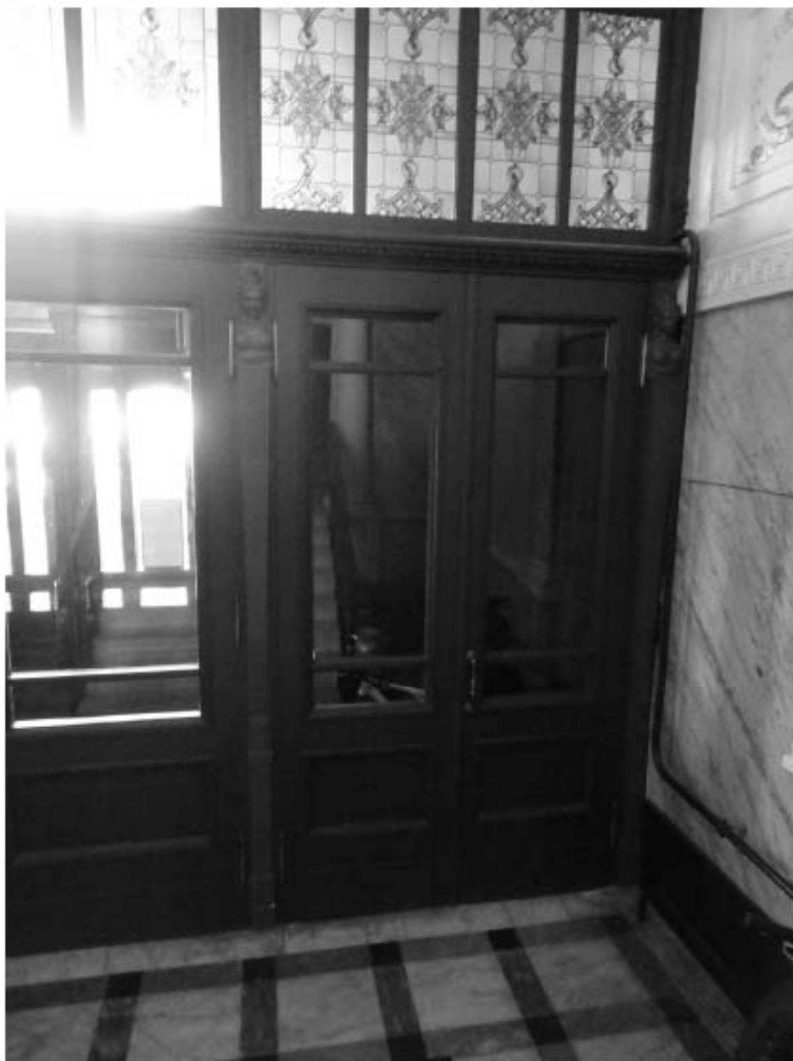
Фото 7. Лестница № 1. Вестибюль. 1-й этаж. Входная дверь. Съемка 26.04.2021 г. Михайловская Г. В.
