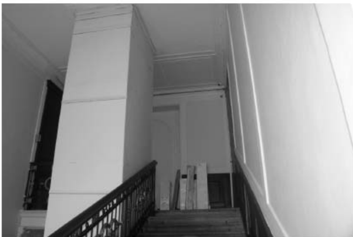
Фото 75. Лестница № 1. Площадка 6-го этажа. Съемка 26.04.2021 г. Михайловская Г. В.
