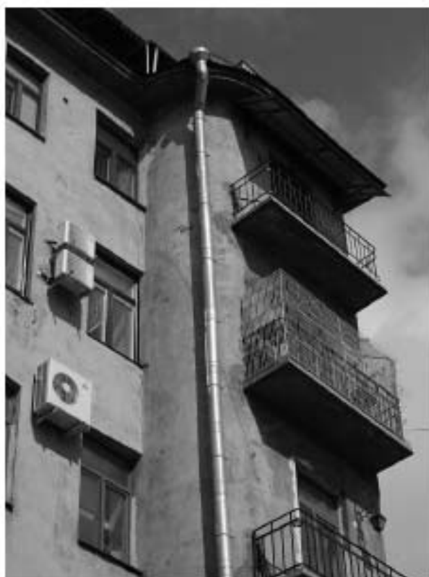
Фото 50. Фрагмент южного фасада. 5-й и 6-й этажи. Съемка 26.04.2021 г. Михайловская Г. В.
