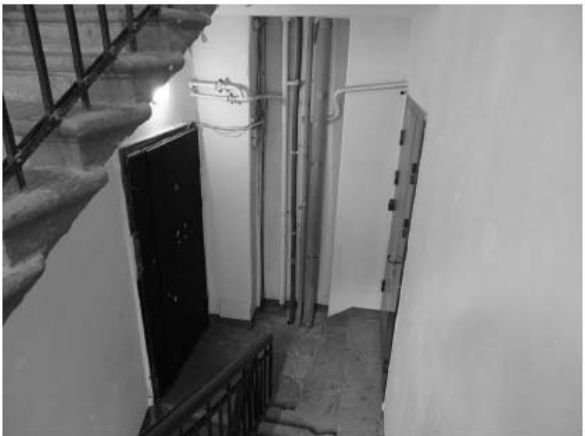
Фото 182. Лестница № 4. Площадка 3-го этажа. Съемка 26.04.2021 г. Михайловская Г. В.
