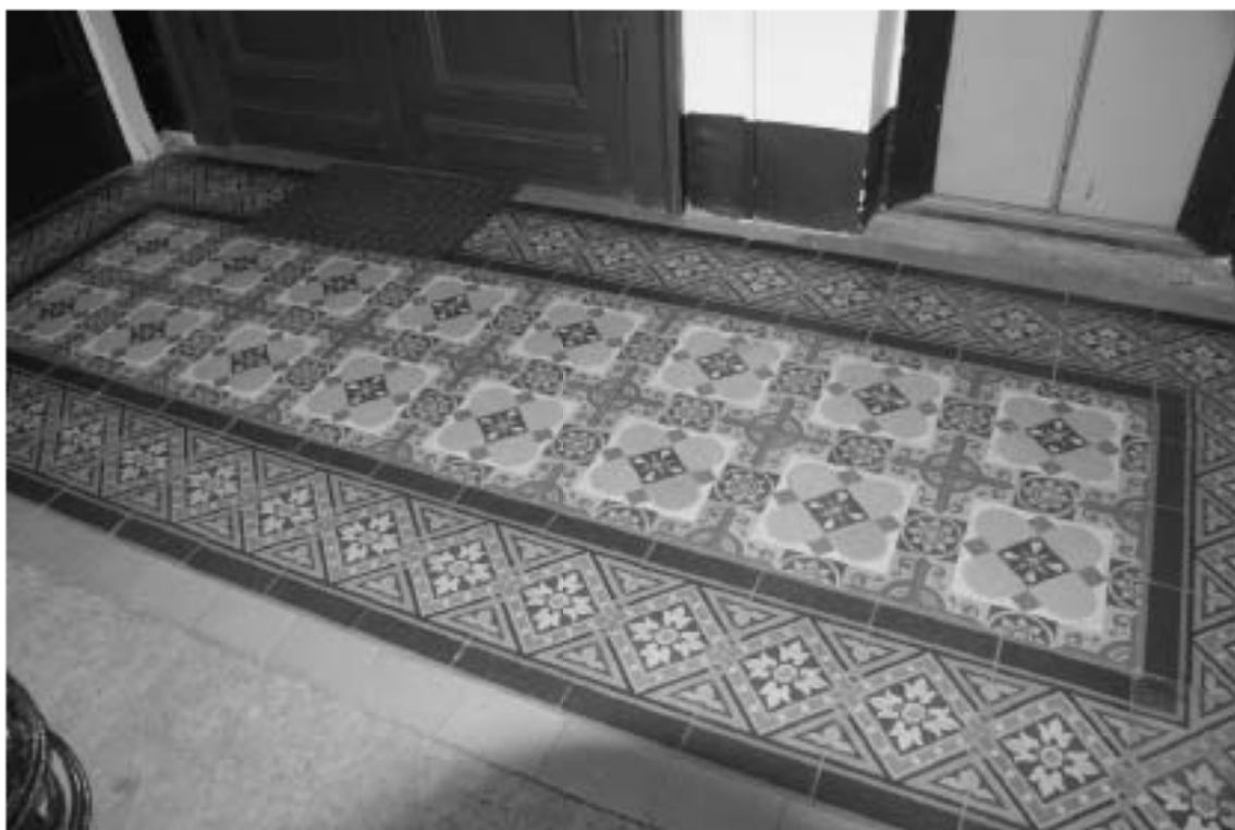
Фото 171. Лестница № 3. Площадка 6-го этажа. Покрытие пола. Съемка 26.04.2021 г. Михайловская Г. В.
