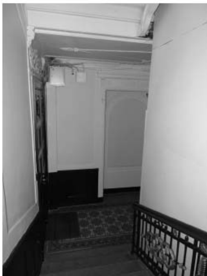
Фото 39. Лестница № 1. Площадка 3-го этажа. Съемка 26.04.2021 г. Михайловская Г. В.
