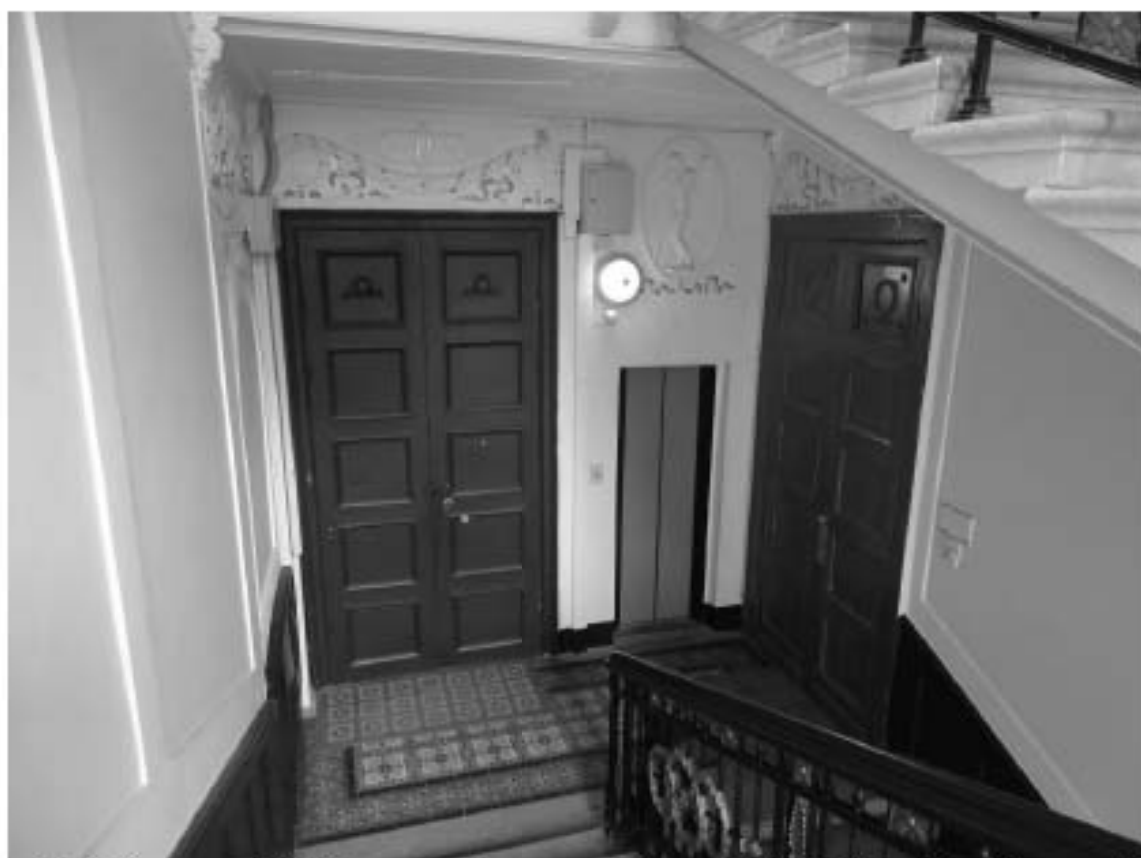
Фото 136. Лестница № 3. Площадка 3-го этажа. Съемка 26.04.2021 г. Михайловская Г. В.
