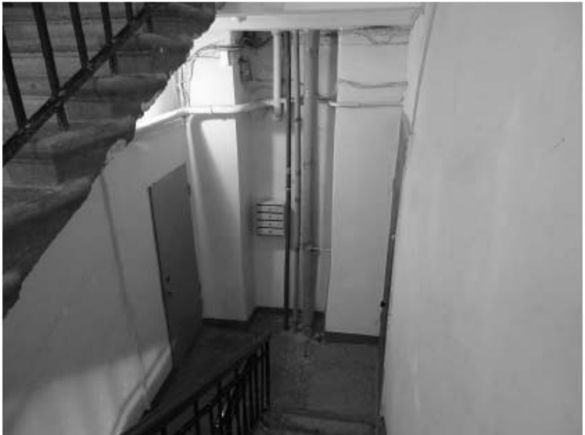
Фото 176. Лестница № 4. Площадка 1-го этажа. Съемка 26.04.2021 г. Михайловская Г. В.
