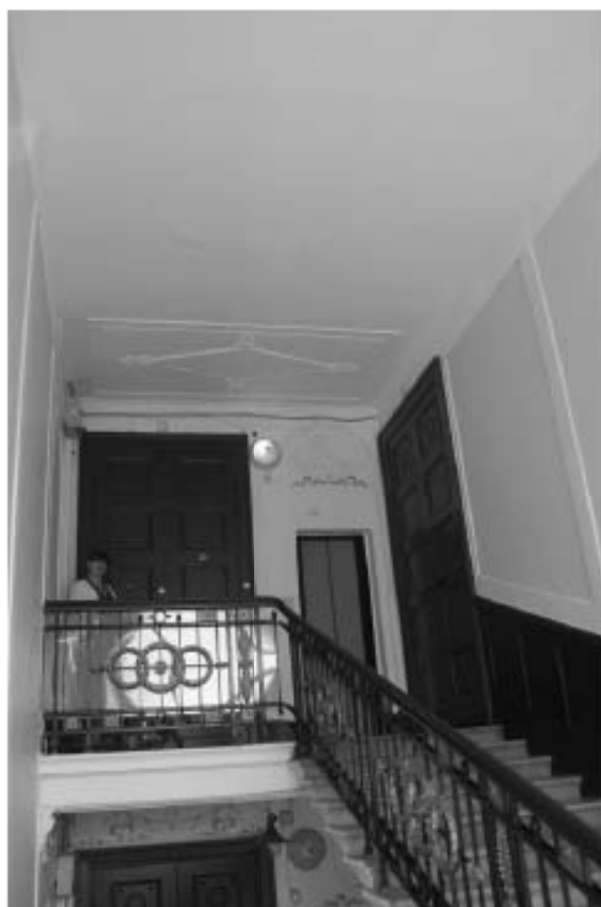
Фото 167. Лестница № 3. Площадка 6-го этажа. Съемка 26.04.2021 г. Михайловская Г. В.
