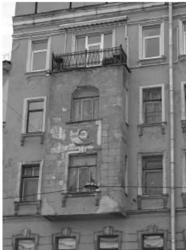
Фото 2. Фрагмент лицевого фасада. Эркер. 3-й, 4-й, 5-й этажи. Съемка 26.04.2021 г. Михайловская Г. В.
