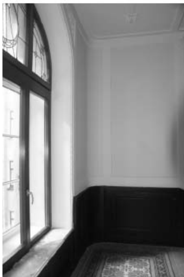
Фото 62. Лестница № 1. Площадка между 4-м и 5-м этажом. Оформление стен лестничных маршей. Съемка 26.04.2021 г. Михайловская Г. В.
