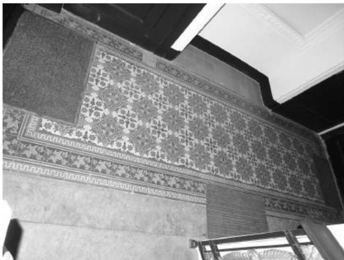
Фото 29. Лестница № 1. Площадка 2-го этажа. Оформление пола. Съемка 26.04.2021 г. Михайловская Г. В.
