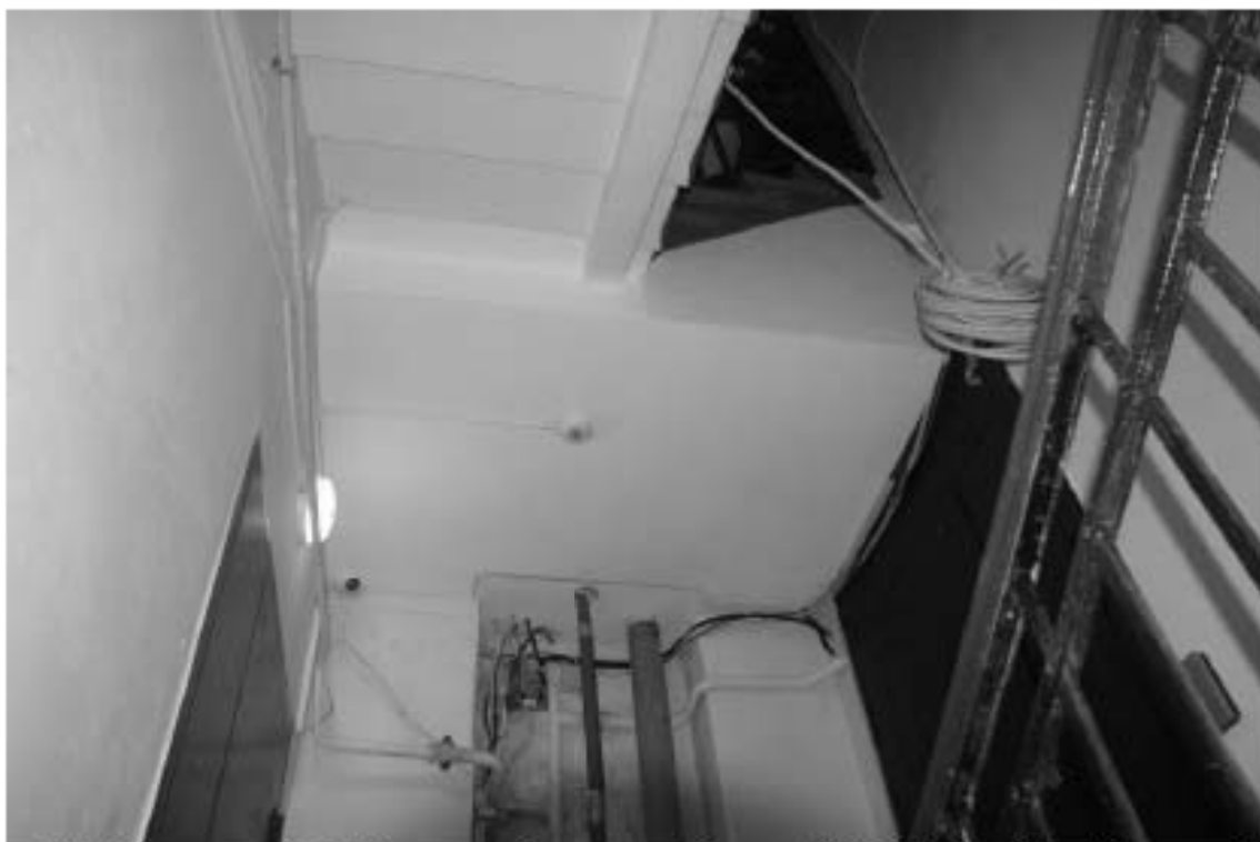
Фото 193. Лестница № 4. Площадка 6-го этажа. Съемка 26.04.2021 г. Михайловская Г. В.
