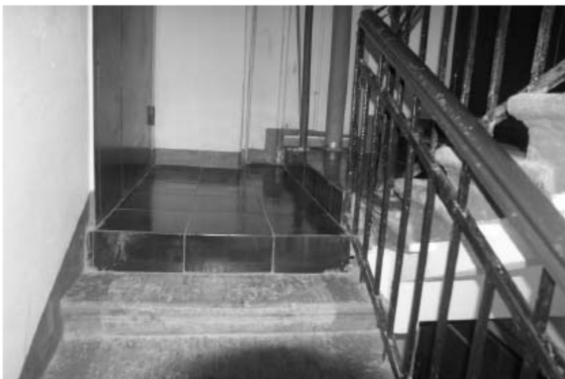
Фото 194. Лестница № 4. Площадка 6-го этажа. Съемка 26.04.2021 г. Михайловская Г. В.
