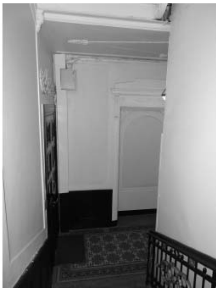
Фото 28. Лестница № 1. Площадка 2-го этажа. Съемка 26.04.2021 г. Михайловская Г. В.
