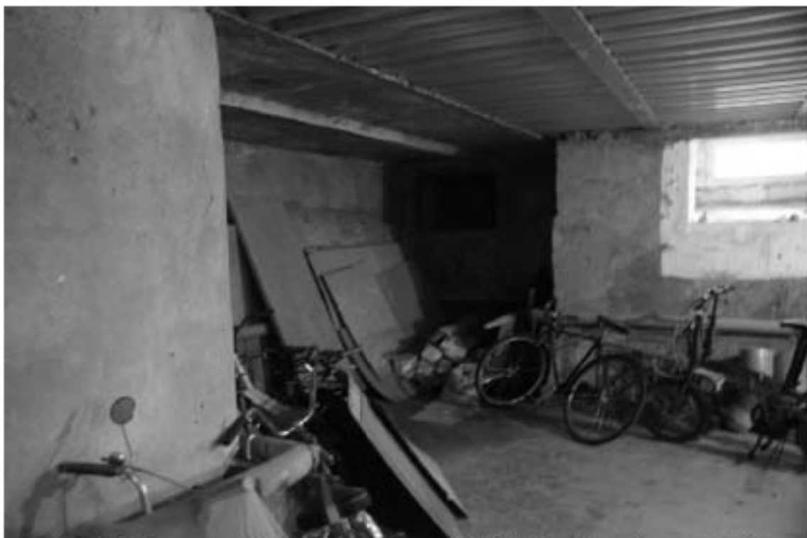
Фото 84. Лестница № 2. Подвал. Съемка 26.04.2021 г. Михайловская Г. В.
