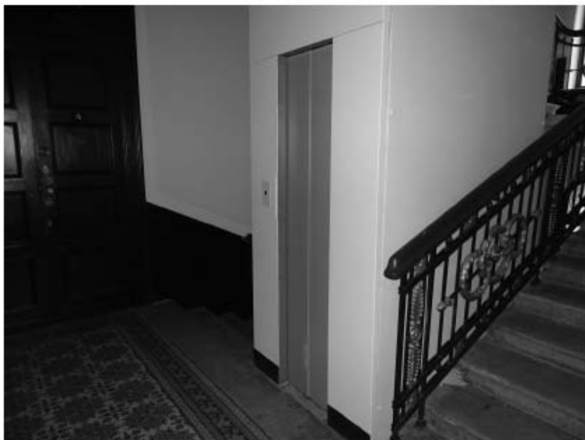
Фото 40. Лестница № 1. Площадка 3-го этажа. Съемка 26.04.2021 г. Михайловская Г. В.
