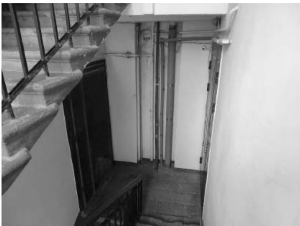
Фото 188. Лестница № 4. Площадка 5-го этажа. Съемка 26.04.2021 г. Михайловская Г. В.
