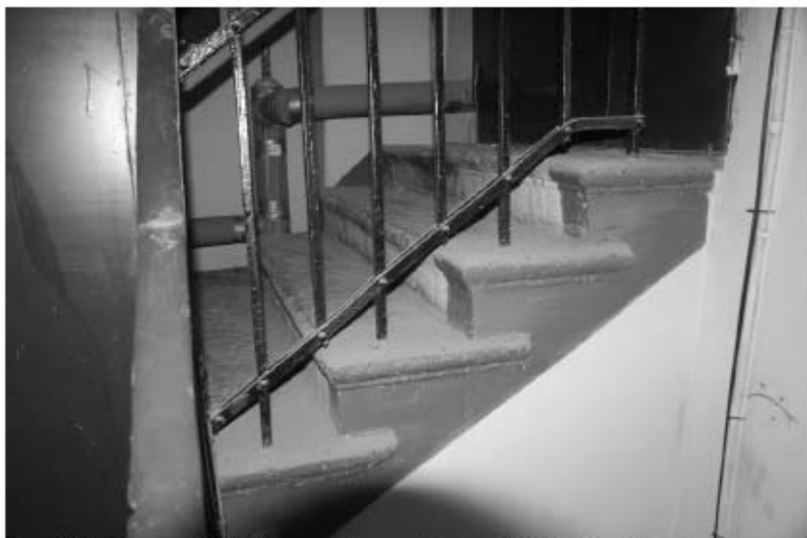
Фото 198. Лестница № 4. Чердачный этаж. Съемка 26.04.2021 г. Михайловская Г. В.
