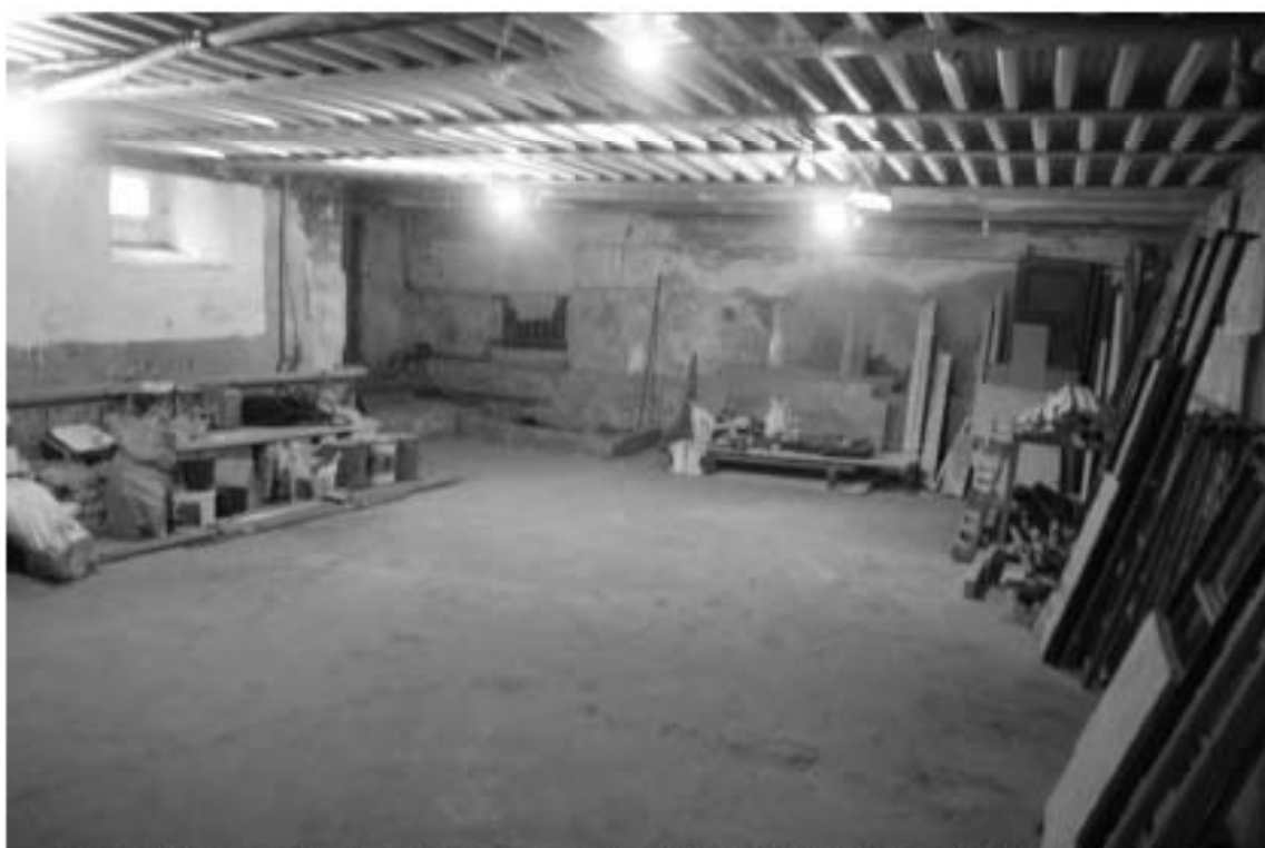
Фото 85. Лестница № 2. Подвал. Съемка 26.04.2021 г. Михайловская Г. В.
