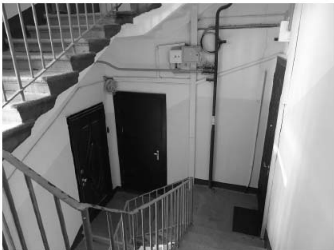
Фото 104. Лестница № 2. Площадка 6-го этажа. Съемка 26.04.2021 г. Михайловская Г. В.
