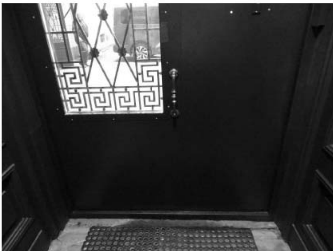
Фото 112. Лестница № 3. Тамбур. Съемка 26.04.2021 г. Михайловская Г. В.
