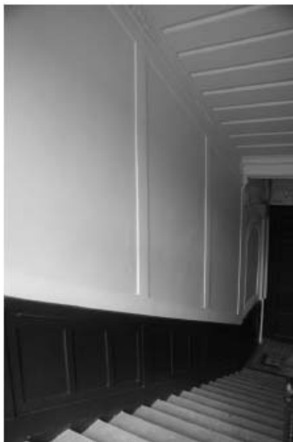
Фото 147. Лестница № 3. Площадка между 3-м и 4-м этажом. Оформление стен лестничных маршей. Съемка 26.04.2021 г. Михайловская Г. В.
