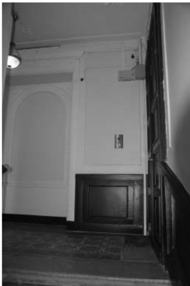
Фото 63. Лестница № 1. Площадка 5-го этажа. Съемка 26.04.2021 г. Михайловская Г. В.
