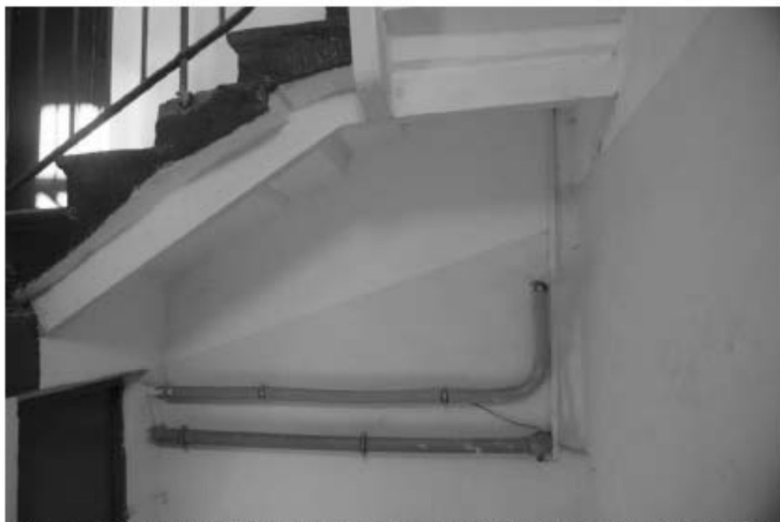
Фото 83. Лестница № 2. Спуск в подвал. Съемка 26.04.2021 г. Михайловская Г. В.
