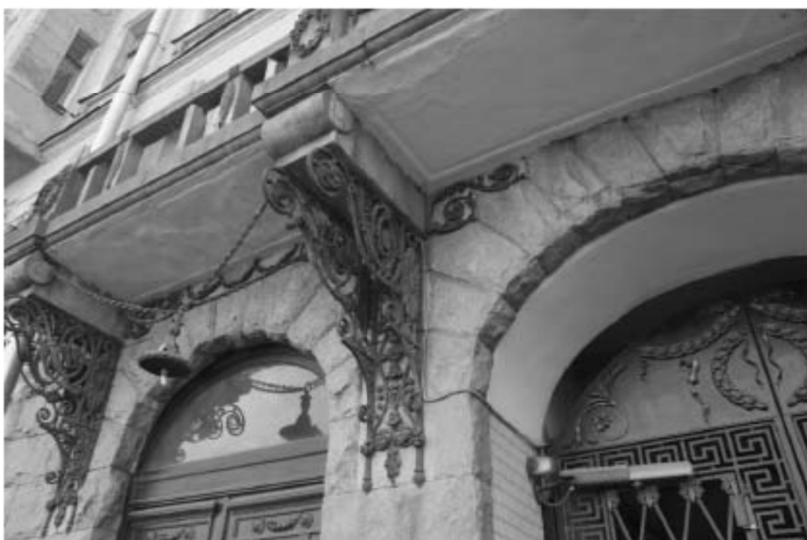
Фото 14. Фрагмент лицевого фасада.
