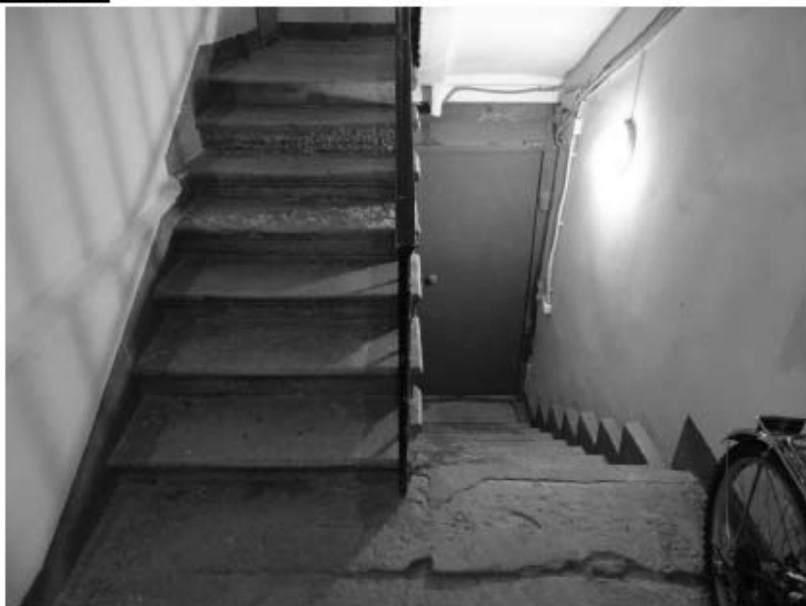
Фото 172. Лестница № 4. Площадка между подвалом и 1-м этажом. Съемка 26.04.2021 г. Михайловская Г. В.
