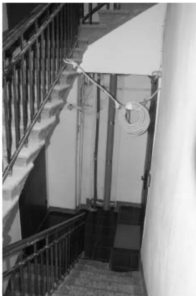
Фото 192. Лестница № 4. Площадка 6-го этажа. Съемка 26.04.2021 г. Михайловская Г. В.
