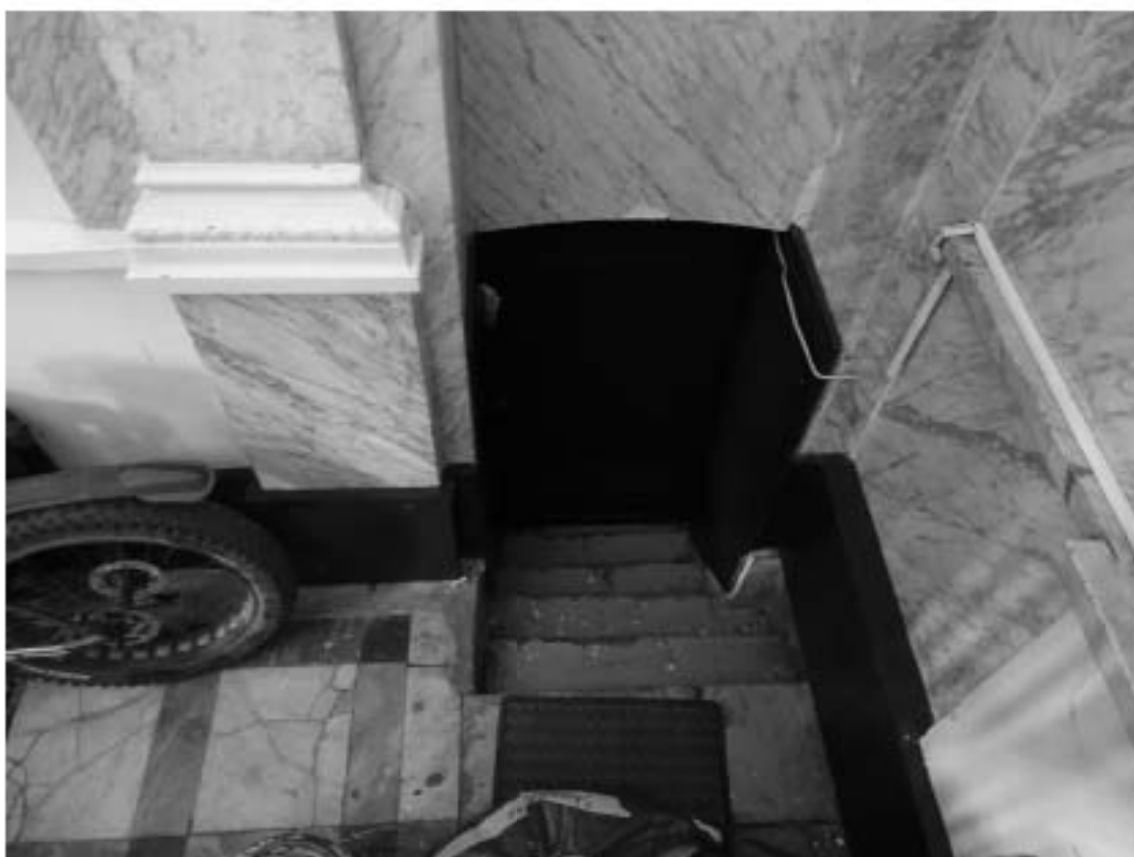
Фото 18. Лестница № 1. Вестибюль. 1-го этажа. Вход в подвал. Съемка 26.04.2021 г. Михайловская Г. В.
