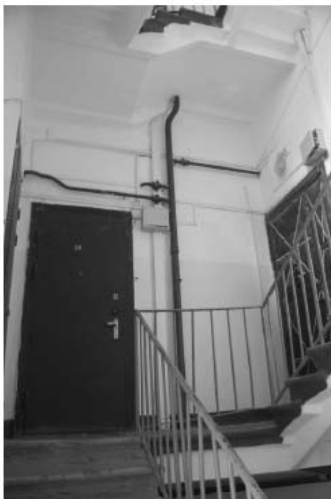
Фото 94. Лестница № 2. Площадка 2-го этажа. Съемка 26.04.2021 г. Михайловская Г. В.
