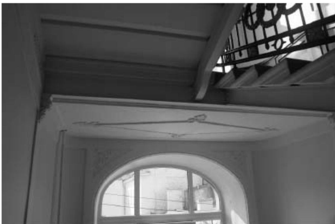
Фото 158. Лестница № 3. Площадка между 4-м и 5-м этажом. Оформление плафонов лестничных площадок. Съемка 26.04.2021 г. Михайловская Г. В.
