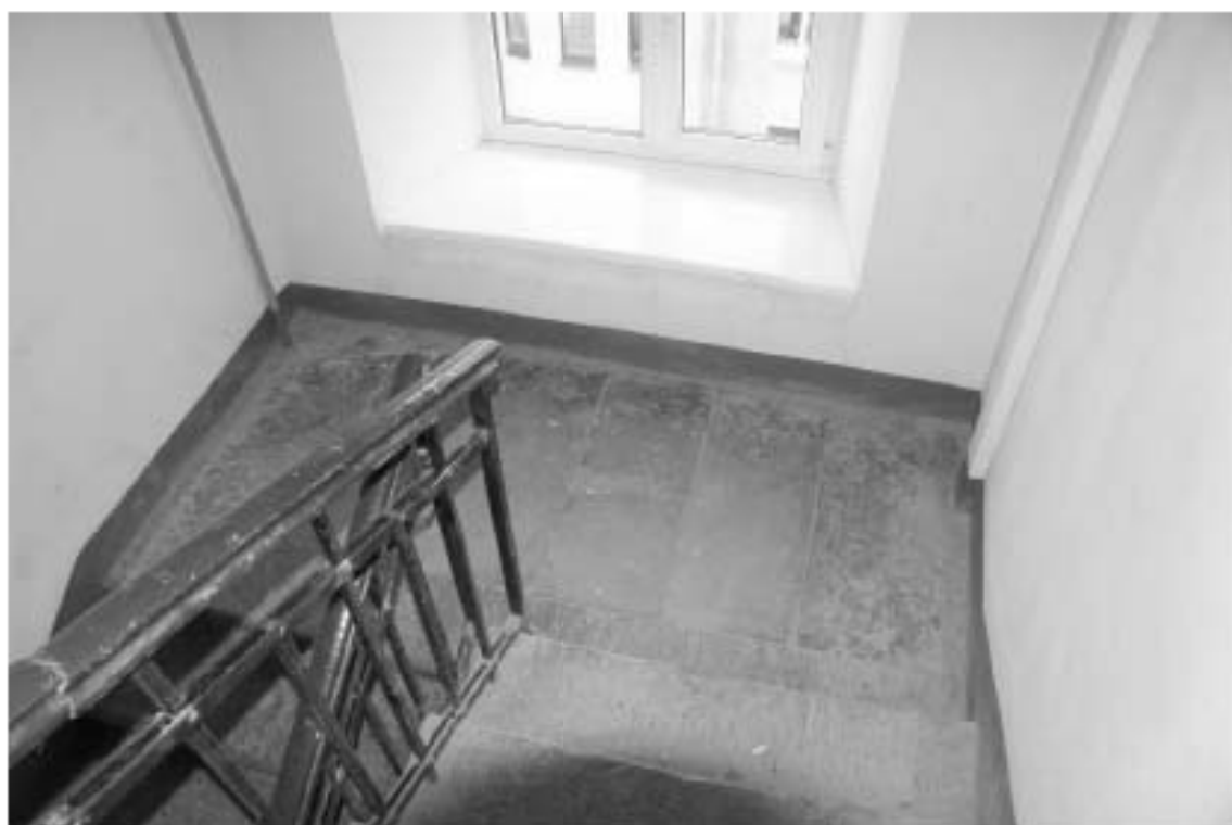
Фото 196. Лестница № 4. Площадка между 6-м чердачным этажом. Покрытие пола. Съемка 26.04.2021 г. Михайловская Г. В.
