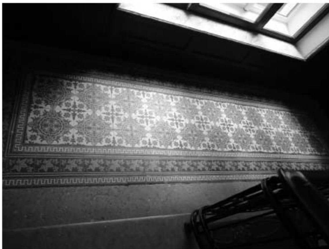
Фото 25. Лестница № 1. Площадка между 1-м и 2-м этажом. Съемка 26.04.2021 г. Михайловская Г. В.
