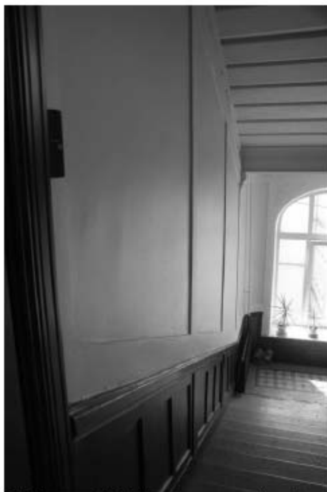
Фото 157. Лестница № 3. Площадка между 4-м и 5-м этажом. Оформление стен лестничных маршей. Съемка 26.04.2021 г. Михайловская Г. В.
