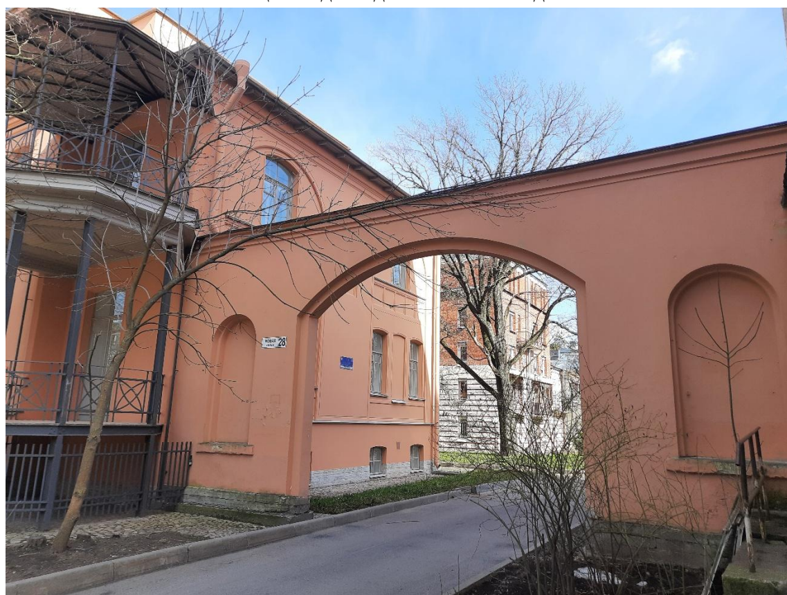
10. Вид на арку и междомовой проезд с Леонтьевской ул.
