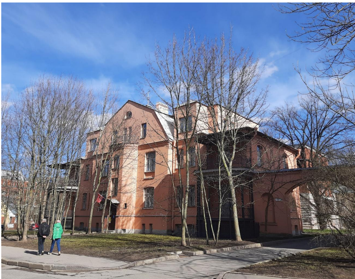
9. Общий вид на здание с юго-запада.
