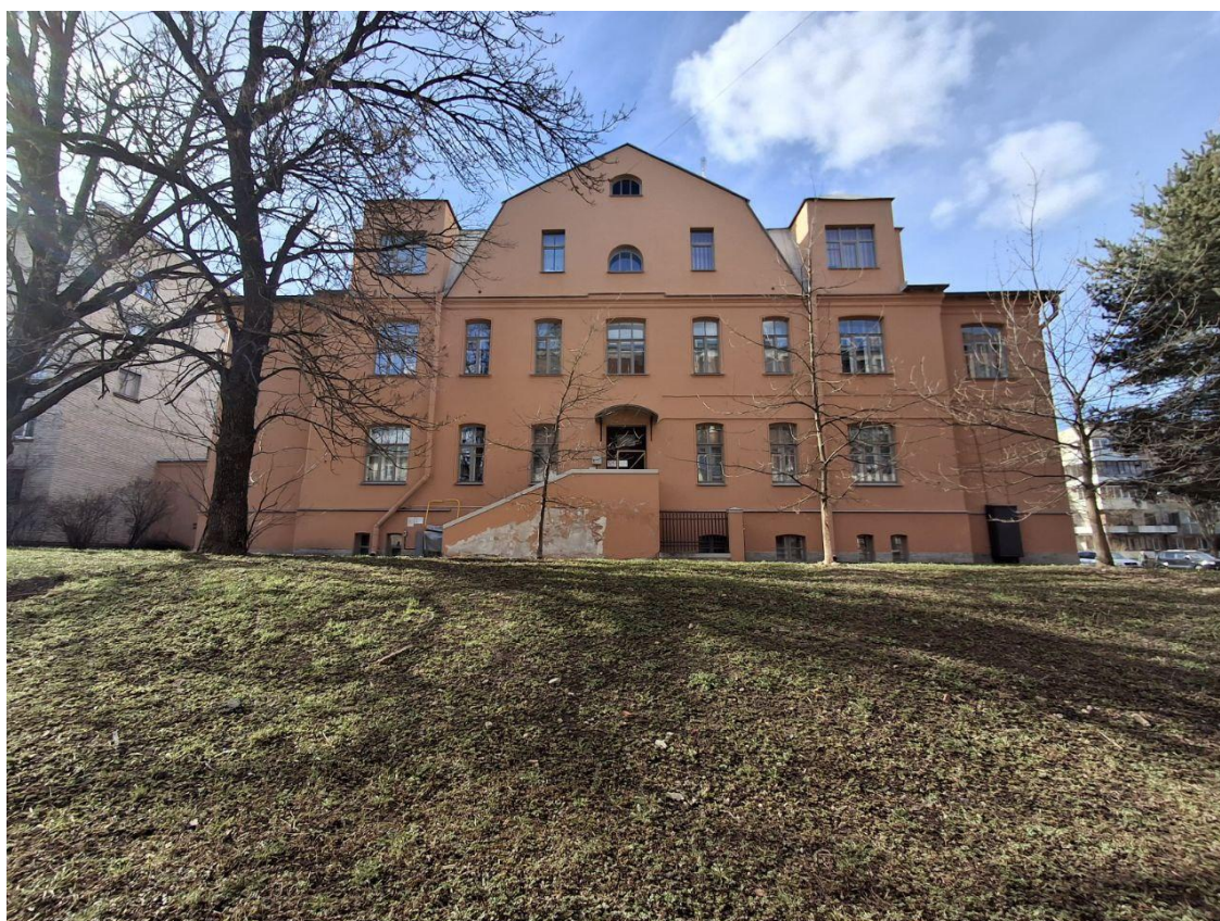
18. Общий вид на юго-восточный фасад.
