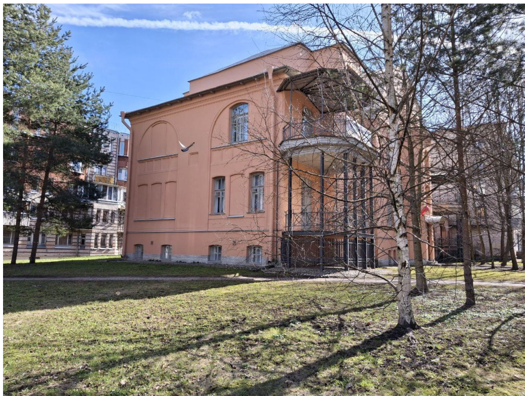
3. Вид на северо-восточный фасад и веранду.
