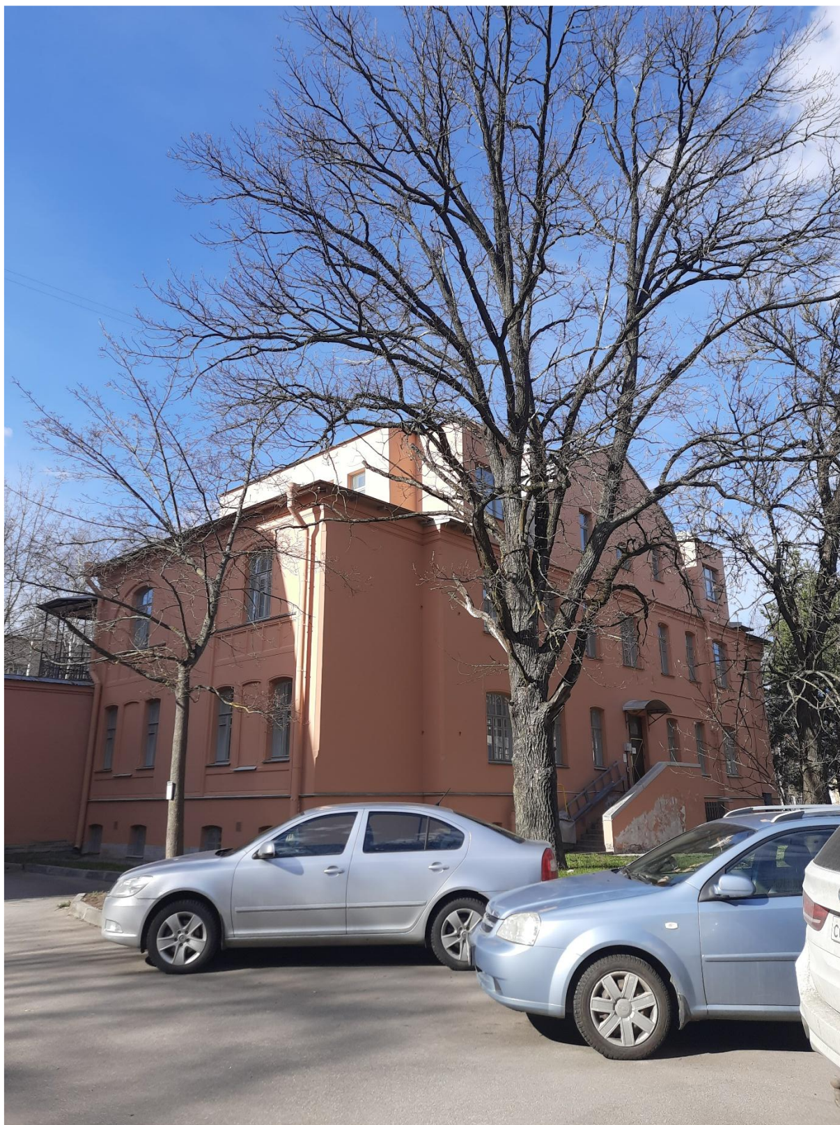
12. Общий вид на здание с юго-запада.
