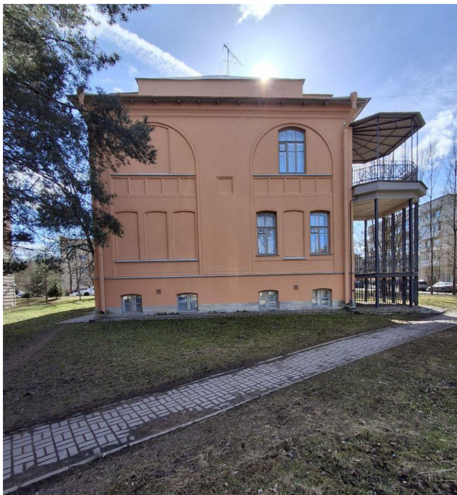
2. Вид на северо-восточный фасад.
