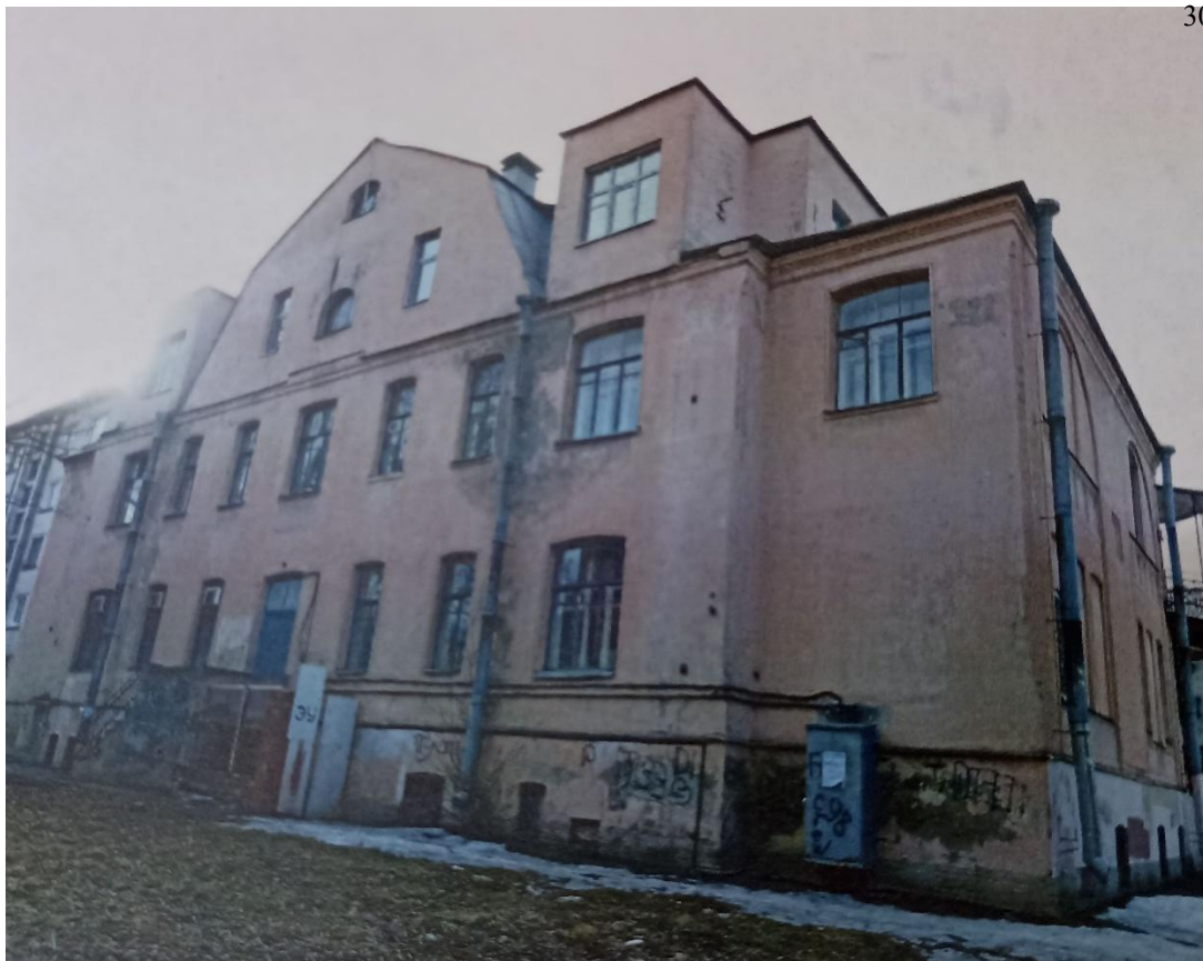
19. Общий вид здания с обследованными конструкциями крыши, фасад вдоль оси «И». Архив КГИОП. Заключение по результатам технического обследования конструкций крыши здания. Разработано ЗАО «Стройком». 2012 г.
