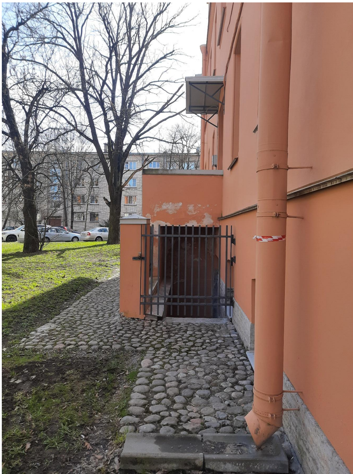
15. Фрагмент юго-восточного фасада, вид с северо-востока.
