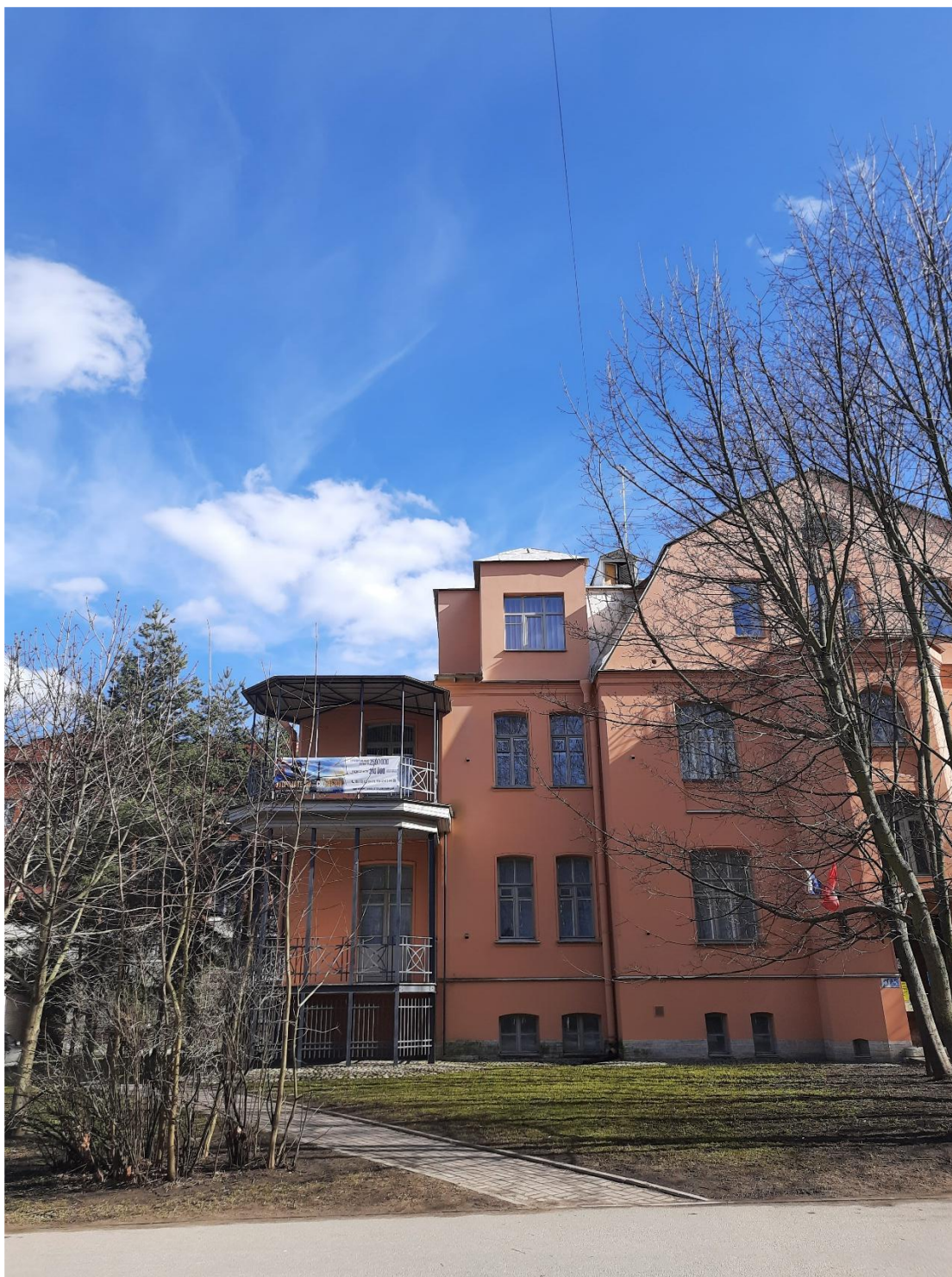
8. Вид на фрагмент лицевого фасада и левую веранду с Леонтьевской ул.
