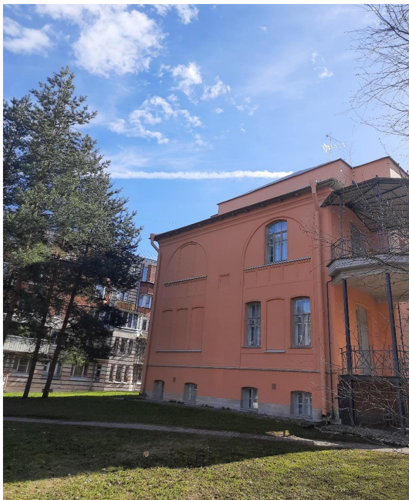
4. Вид на северо-восточный фасад с Леонтьевской ул.
