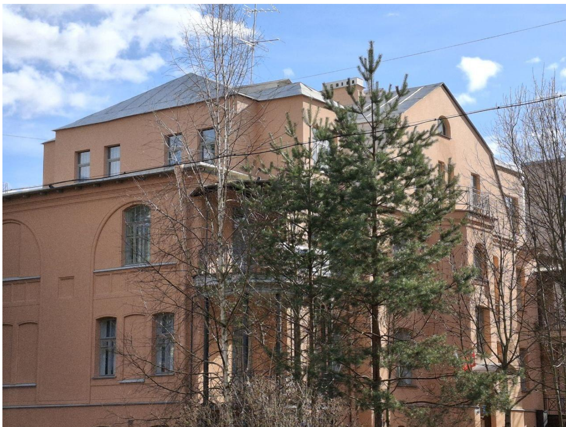
20. Вид на крышу здания с северо-западного угла.
