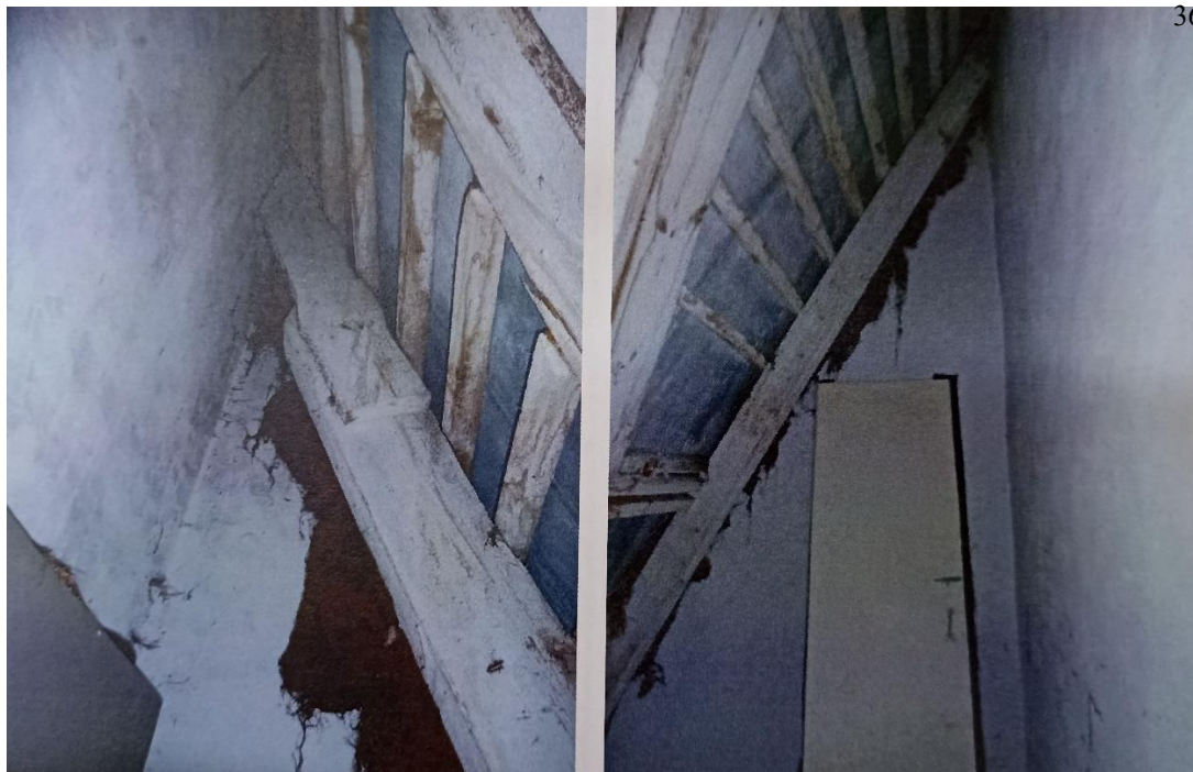
31. Вид типового исполнения не утепленных строительных конструкций участков крыши, расположенных в осях «Е/1...И», между осями «2/2...2/3», «4/2...4/3», и в осях «В...Г/1», между осями «2/2...2/3», «4/2...4/3». Архив КГИОП. Заключение по результатам технического обследования конструкций крыши здания. Разработано ЗАО «Стройком». 2012 г.
