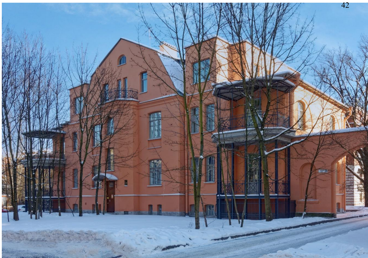
43. Вид на северо-западный фасад. 2021 г. Фото И. Гордеева. https://upload.wikimedia.org/wikipedia/commons/a/a8/Пушкин%2C_Новая_ул.%2C_28_-_Жилой_дом_Е.Д._Максимова_2.jpg
