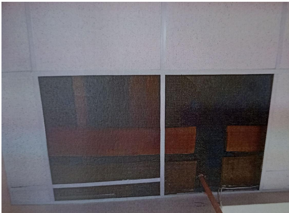
41. Вид конструкции перекрытия второго этажа и металлической рандбалки, уложенной под наружную стену мансарды по оси «2».
