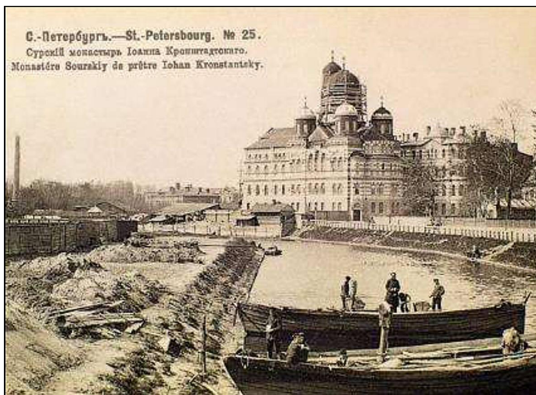
Илл. 15. Устройство керамических куполов храма Двенадцати апостолов. 1903 г. Почтовая открытка.
